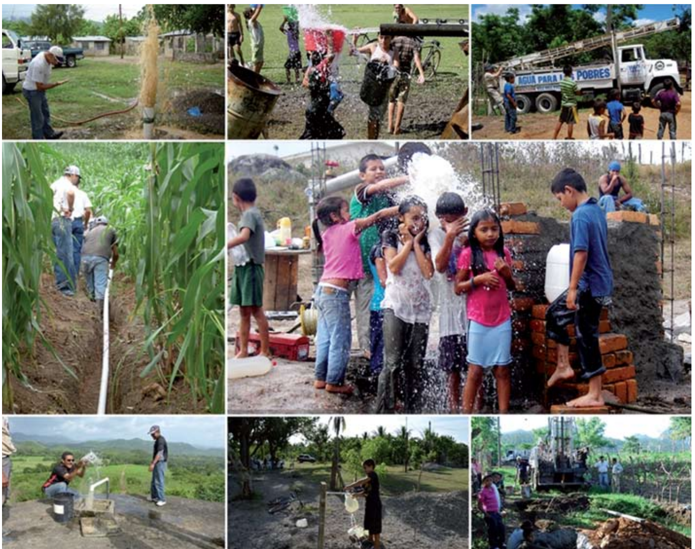
Figura 10. Ejemplos de la instalación de tuberías y ejecución de pozos y fuentes.
