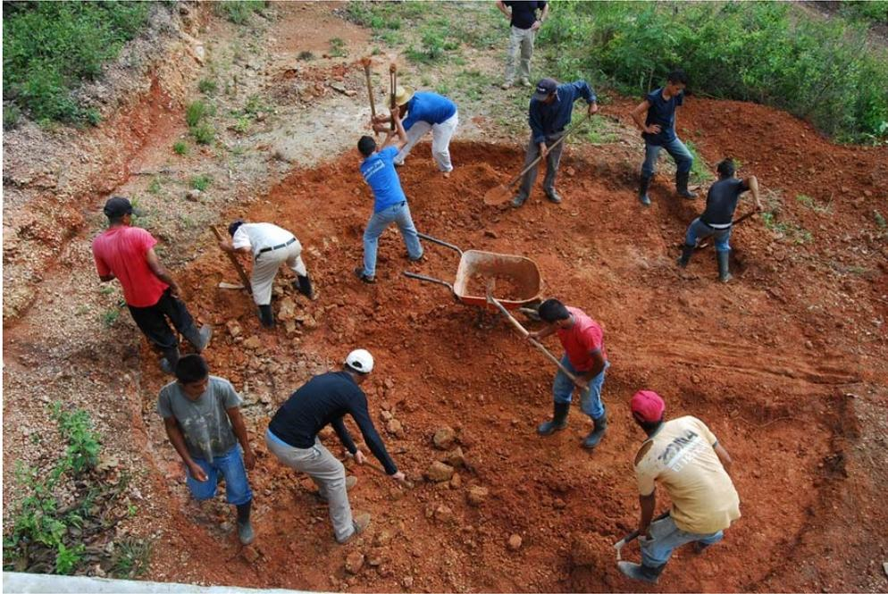
*Figura 34.- Proceso de la excavación de vaciado para cimentación del tanque.*
