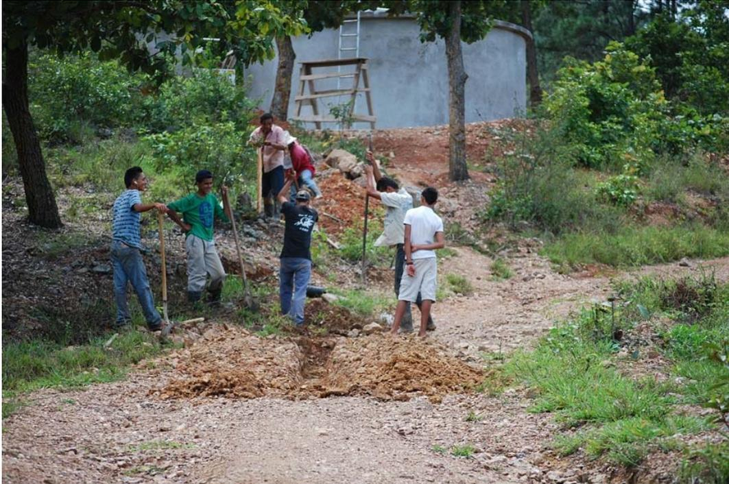
**Figura 67.- Zanjeo para la línea de conducción.**
