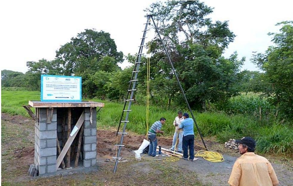
**Figura 105.- Preparativos para instalación de bomba sumergible.**
