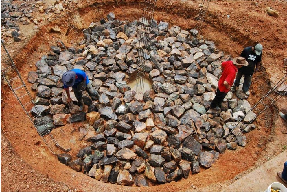
**Figura 42.- Construcción de solera de reparto. Se realiza utilizando hormigón ciclópeo.**
