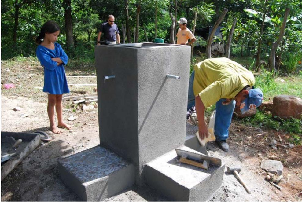
**Figura 76.- Fase de remate mediante el enlucido y colocación de piezas cerámicas en los poyos.**
