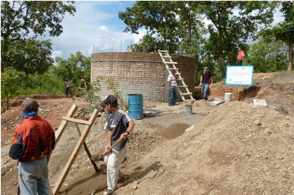
**Figura 55.- Tanque con las paredes levantadas y pilares fundidos preparado para el enlucido exterior.**
