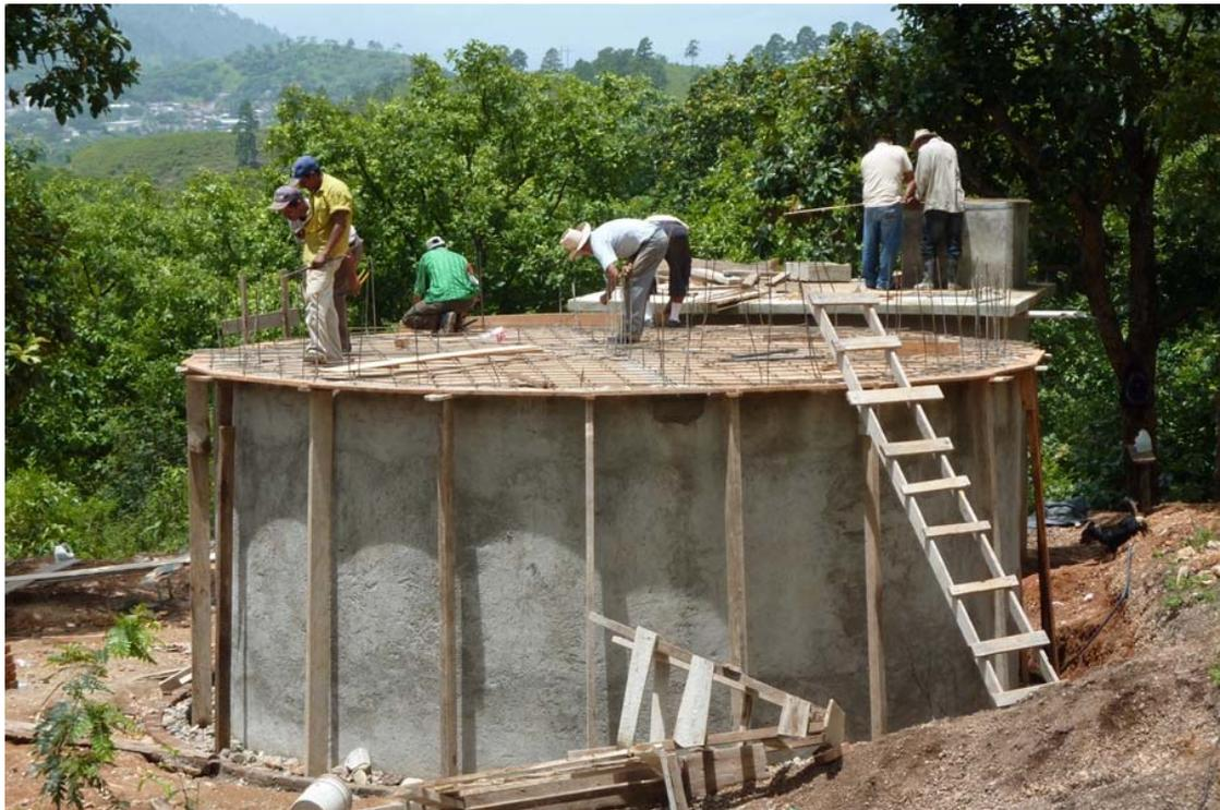
*Figura 61.- Colocación del emparrillado de hierro de la losa de cierre.*
