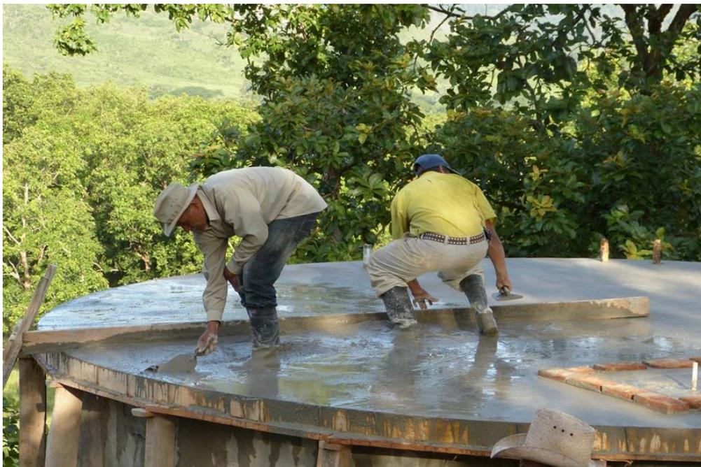
*Figura 63.- Última fase de nivelación y alisado de la losa.*
