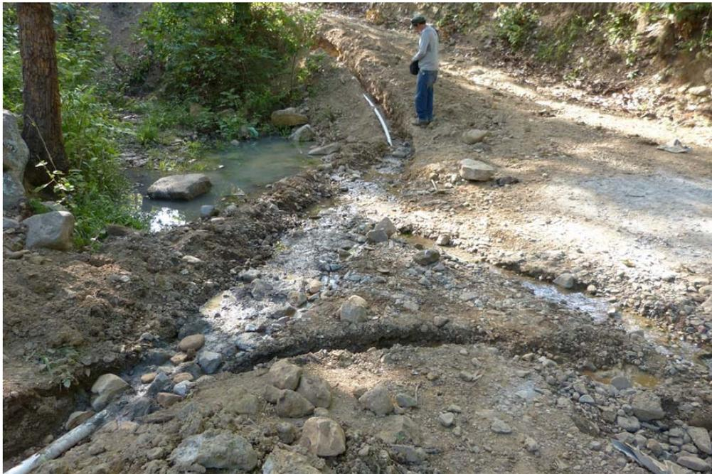
**Figura 72.- Paso de la quebrada. Se realizó mediante una tubería PVC SDR-26 de 3" embebida en hormigón por el interior de la cual se introdujo la tubería de conducción.**
