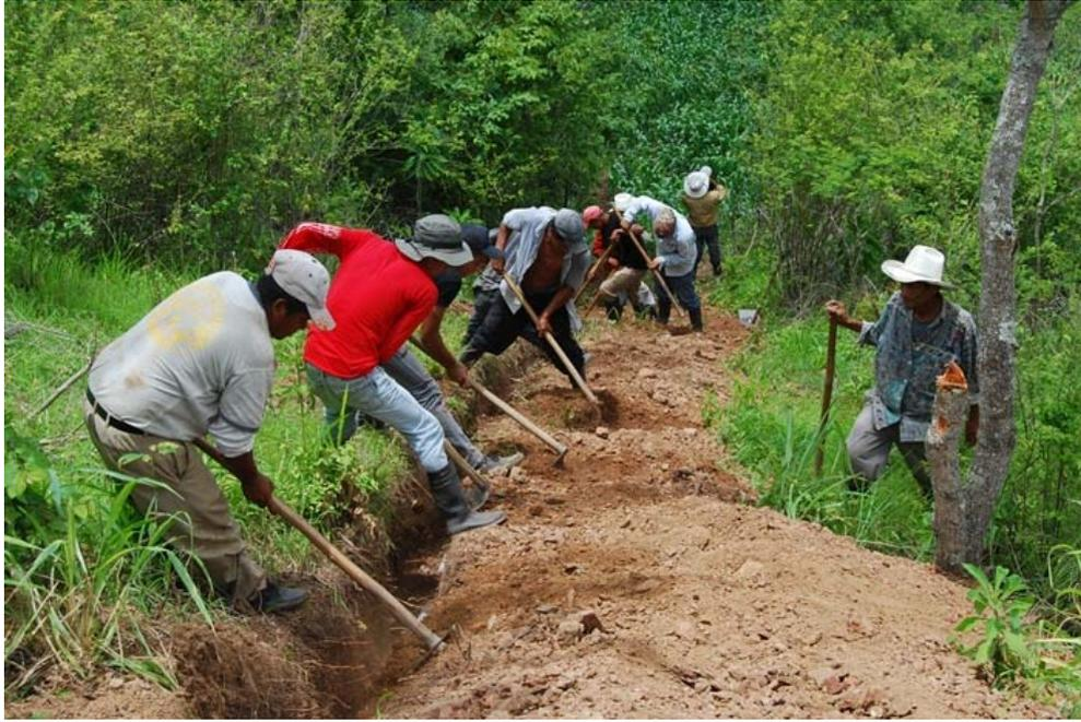
**Figura 178.- Labores de aterrado de la tubería**
