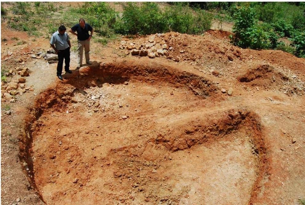
**Figura 37.- Vaciado en fase final a falta de eliminación de la rampa para la extracción del material.**
