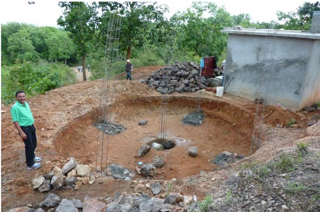
**Figura 41.- Etapa de fundido de las zapatas. Con las armaduras de los pilares.**
