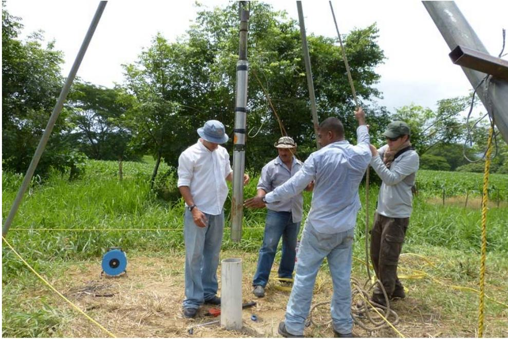
**Figura 92.- Bomba sumergible utilizada para el ensayo.**
