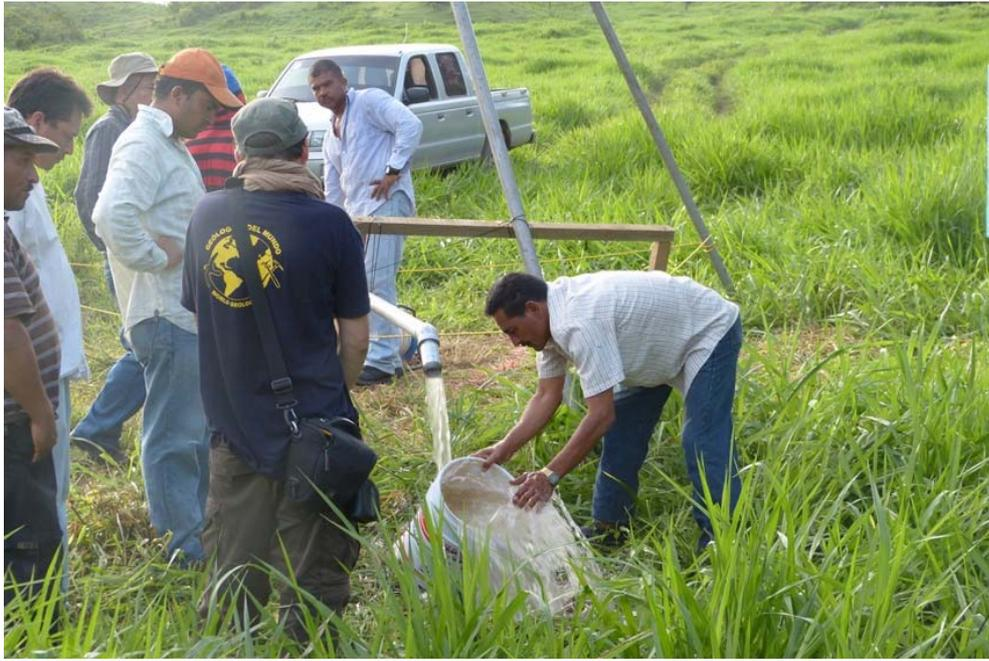
**Figura 94.-Regulación de caudal mediante aforo volumétrico.**
