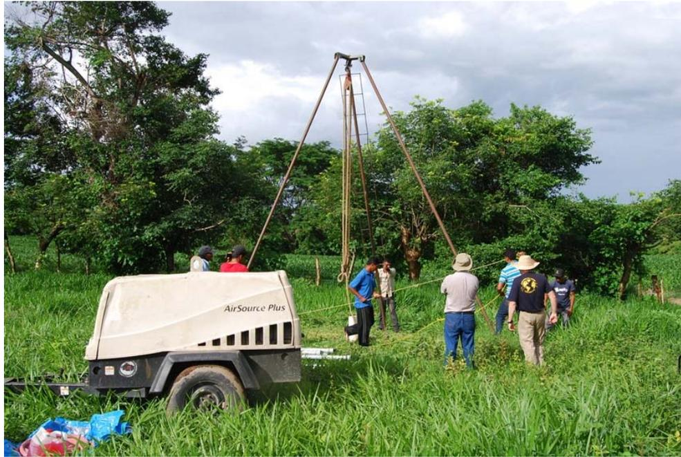
**Figura 87.- En primer plano, el compresor utilizado para la limpieza.**
