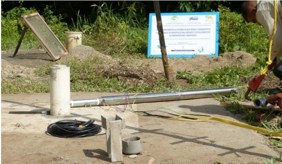
**Figura 171.- Bomba sumergible dispuesta para ser instalada.**
