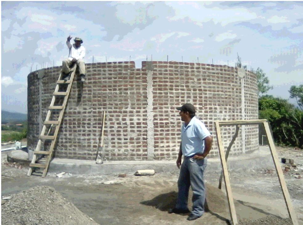
**Figura 140.- Fase final del alzado con los pilares-refuerzo ya fundidos**
