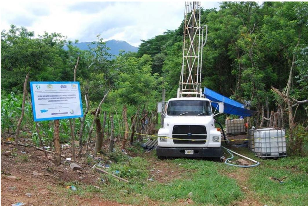
*Figura 27.- Máquina de perforación en su emplazamiento definitivo*
