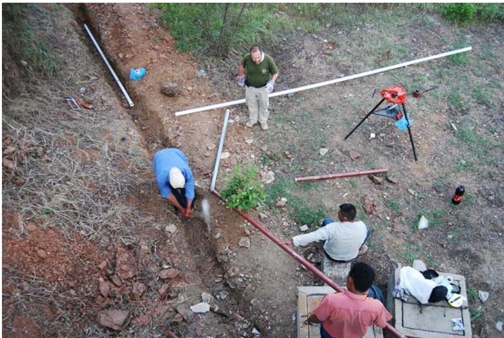
*Figura 185.- Preparando conexión de la parte enterrada de PVC a la aérea de HG en el tanque.*
