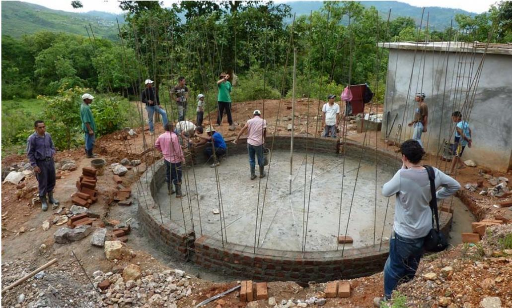
**Figura 52.- Alzado de paredes del tanque.**
