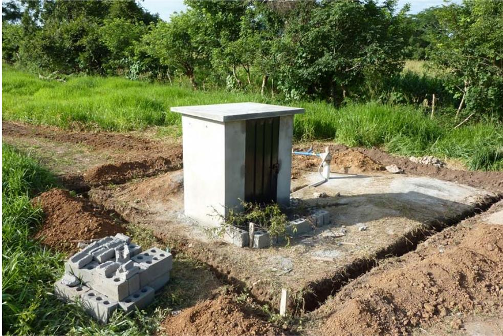
**Figura 102.- Caseta terminada y albergando los controles de la bomba. Le falta pintar.**
