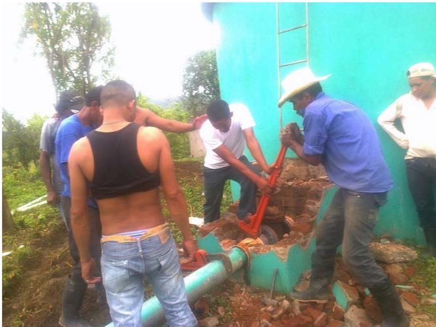
**Figura 127.- Recuperando la válvula de distribución de 6” previa a la demolición.**
