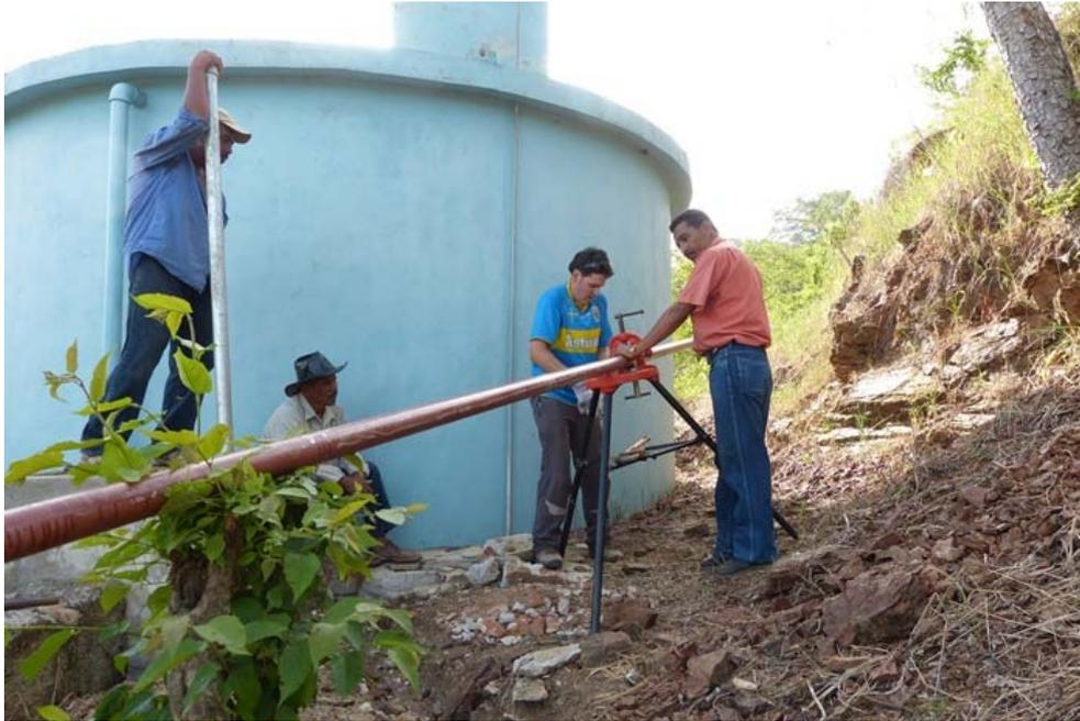
*Figura 184.- Preparando las conexiones al tanque con tubería HG*
