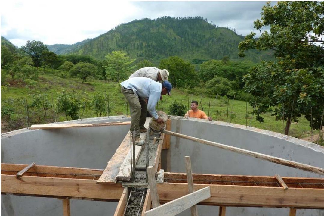
**Figura 59.- Fundiendo las vigas del techo del tanque.**
