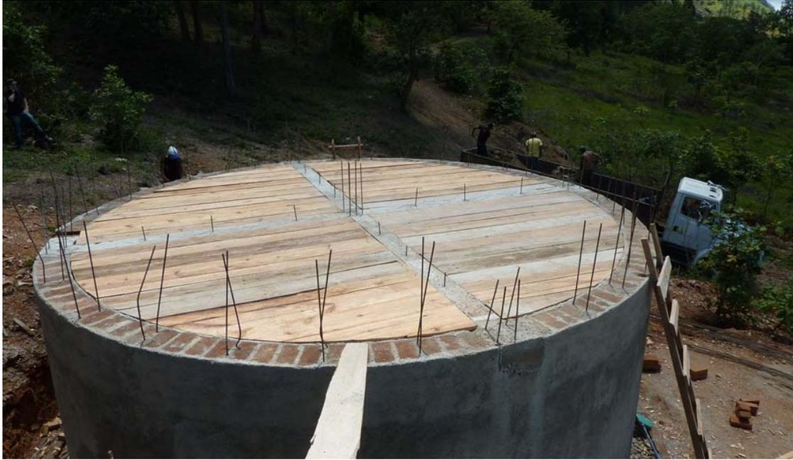
*Figura 60.- Encofrado para la losa de cierre del tanque.*
