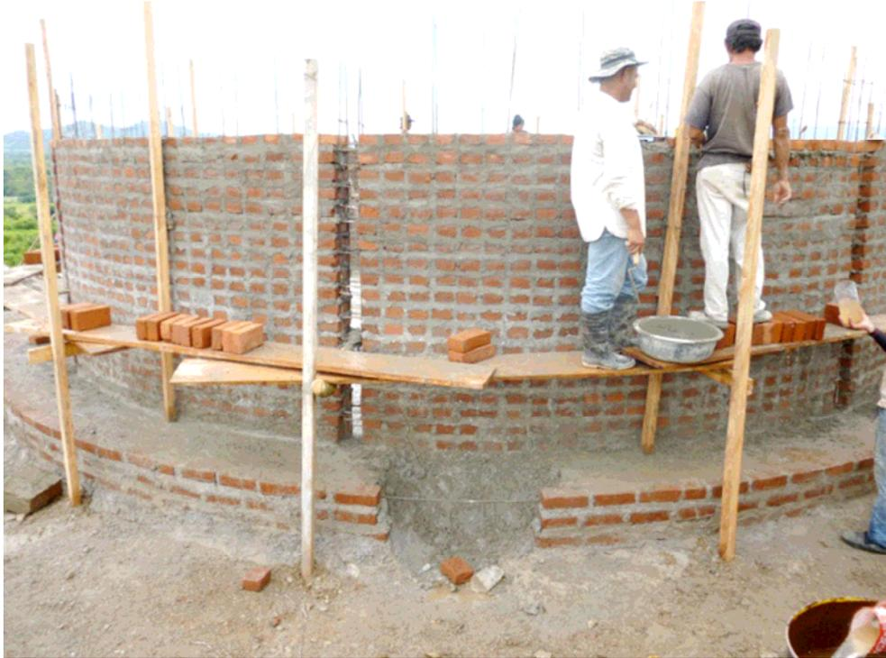
**Figura 139.- Fase avanzada de alzado de pared**
