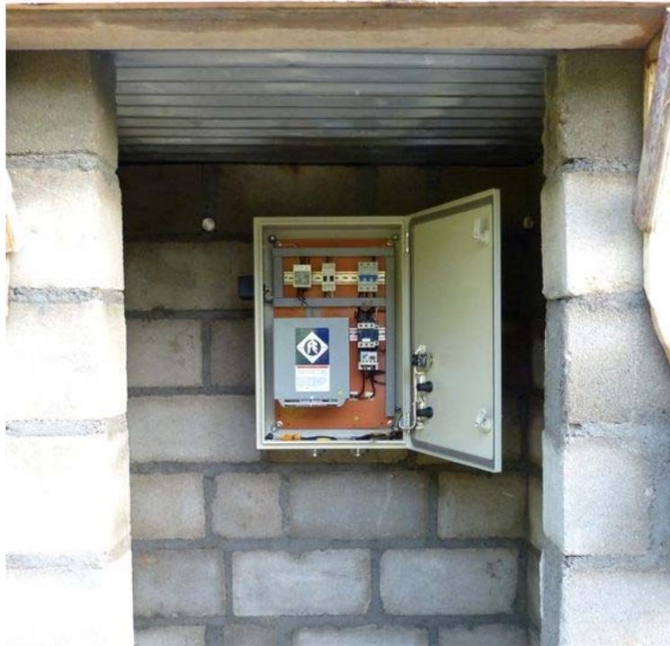
**Figura 111.- Panel de control en Gavieto para 5 Hp ya colocado en la caseta.**
