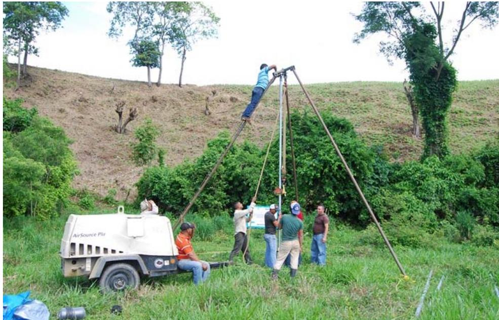
**Figura 159.- Preparativos para la limpieza de pozo con el compresor utilizado**
