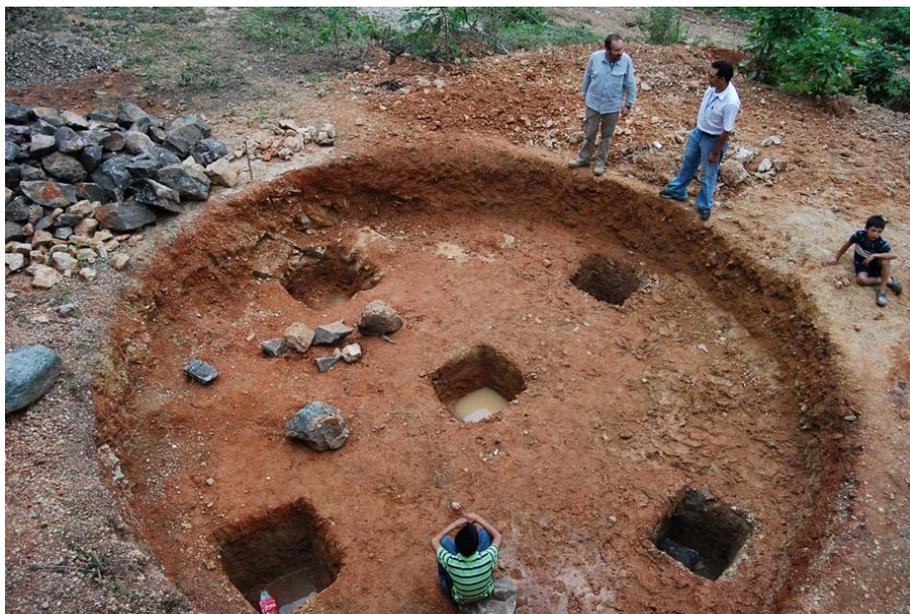
**Figura 39.- Zapatas ya excavadas**
