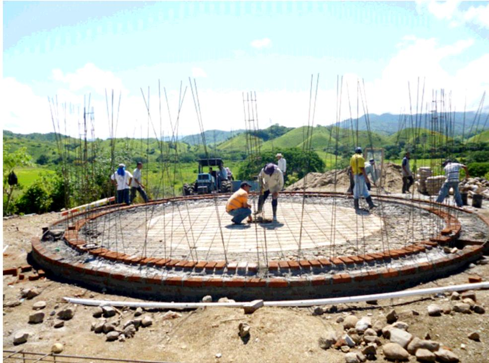
*Figura 136.- Emparrillado preparado para la fundición de la nueva solera.*
