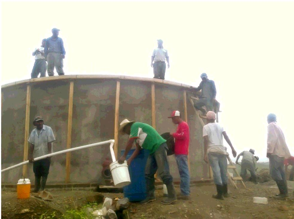
**Figura 145.- Etapa de fundido de la losa superior**
