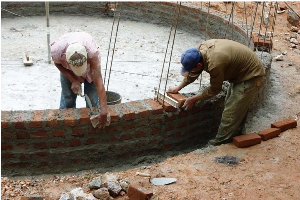
*Figura 51.- Alzado de paredes del tanque.*
