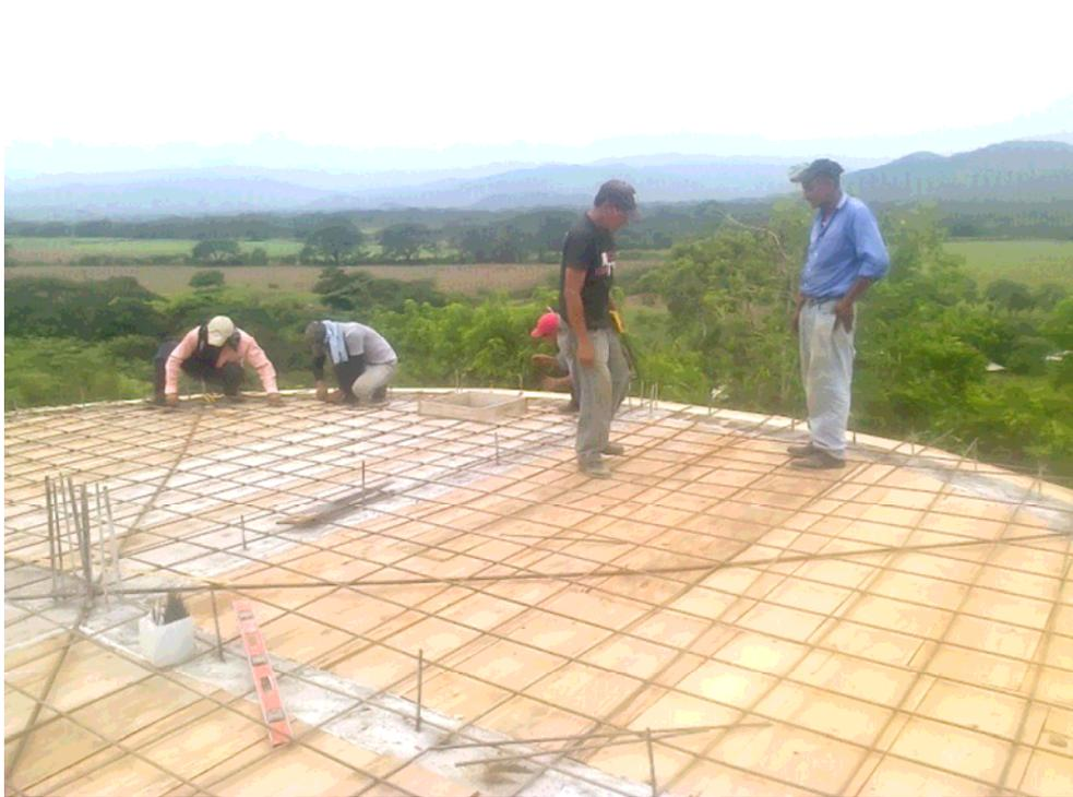
**Figura 144.- Emparrillado de hierro sobre el encofrado para la losa superior de cierre.**
