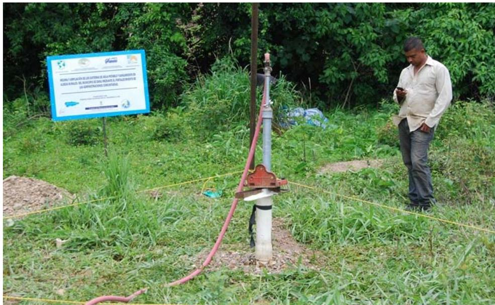
**Figura 160.- Cabeza de inyección de aire ya instalada y dispuesta para la limpieza.**
