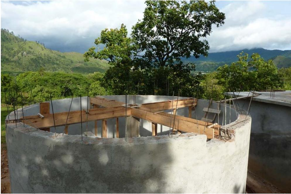
**Figura 58.- Encofrado para las vigas armadas superiores.**
