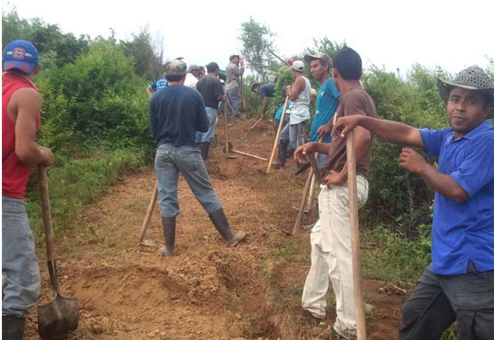
**Figura 112.- Trabajo comunitario durante el zanjeo y enterramiento de tubería**
