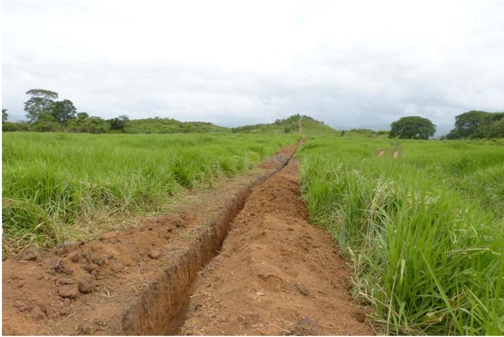
**Figura 114.- Zanja para la instalación de tubería de impulsión. En el montículo del fondo, el tanque de almacenamiento.**
