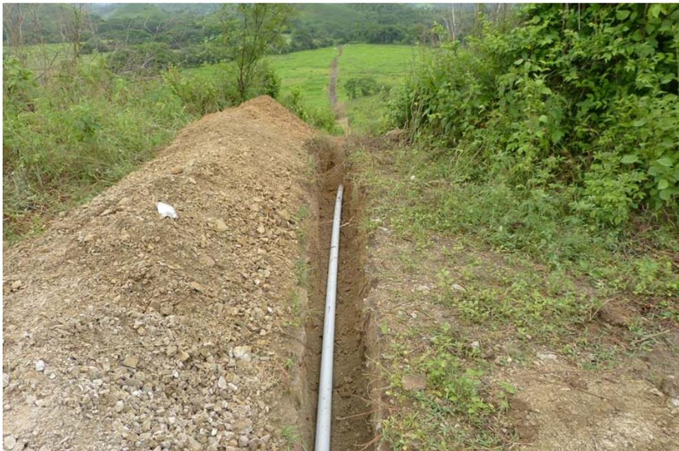
**Figura 115.- Zanja con la tubería instalada. Vista desde el tanque de almacenamiento.**
