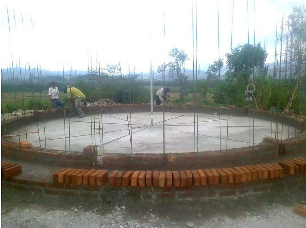
*Figura 137.- Arranque del alzado de pared.*
