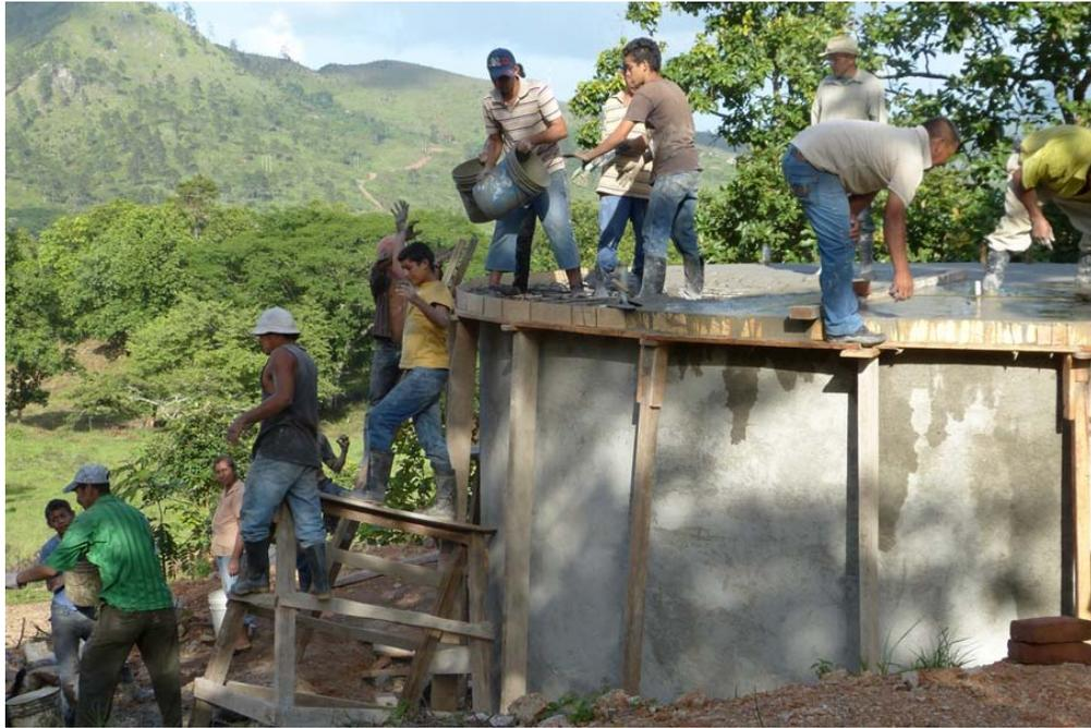
*Figura 62.- Proceso de fundido de la losa superior de cierre.*
