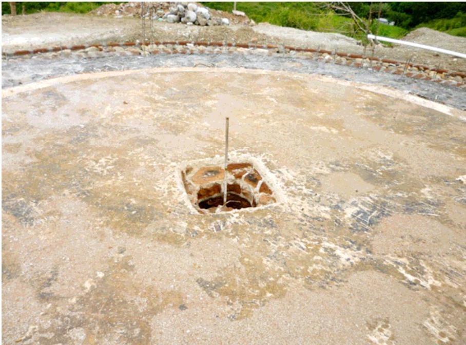
**Figura 135.- Pozo central excavado en la antigua solera para albergar el pilar central . Se puede ver igualmente el anillo perimetral ya relleno de hormigón ciclópeo.**
