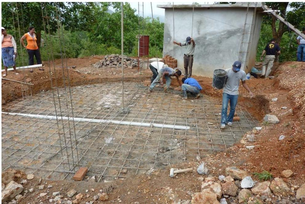
**Figura 47.- Colocación de la hilada de ladrillos “perdida” que hace de encofrado de la última fase de construcción de la solera y de base para el comienzo del alzado de las paredes.**
