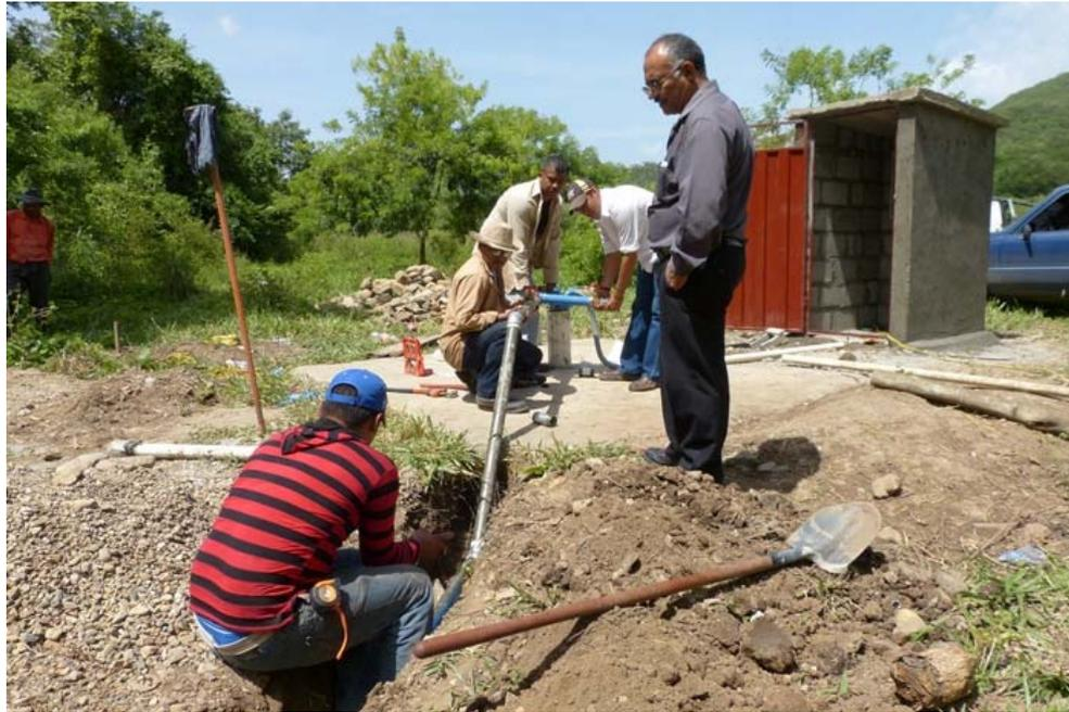
**Figura 186.- Conexión del tren de descarga del pozo a la línea de bombeo.**
