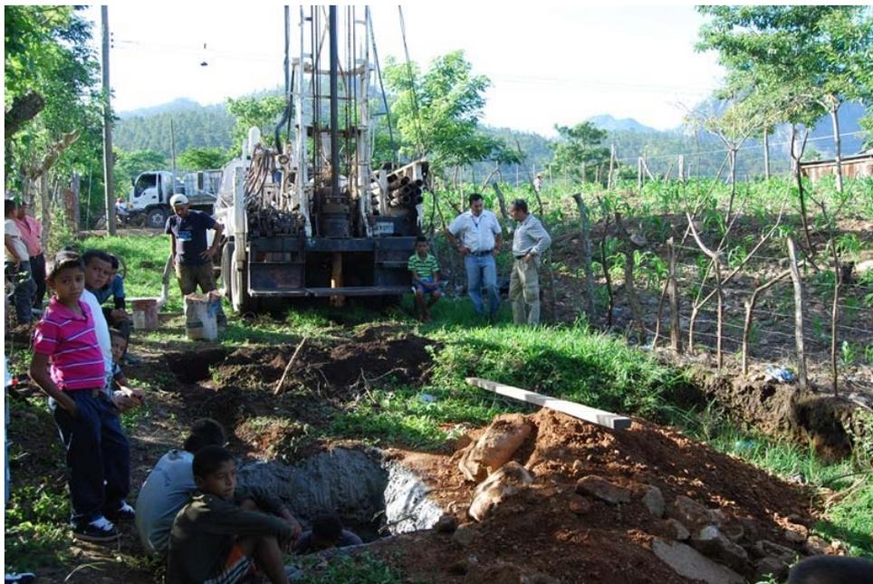
**Figura 29.- Operación de perforación con la balsa de recuperación de lodos.**
