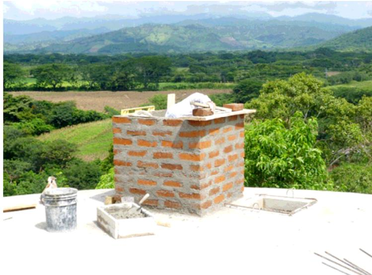
*Figura 148.- Hipoclorador en construcción*
