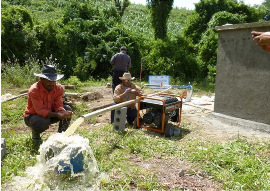
*Figura 188.- Aforo en boca de pozo con la bomba definitiva*
