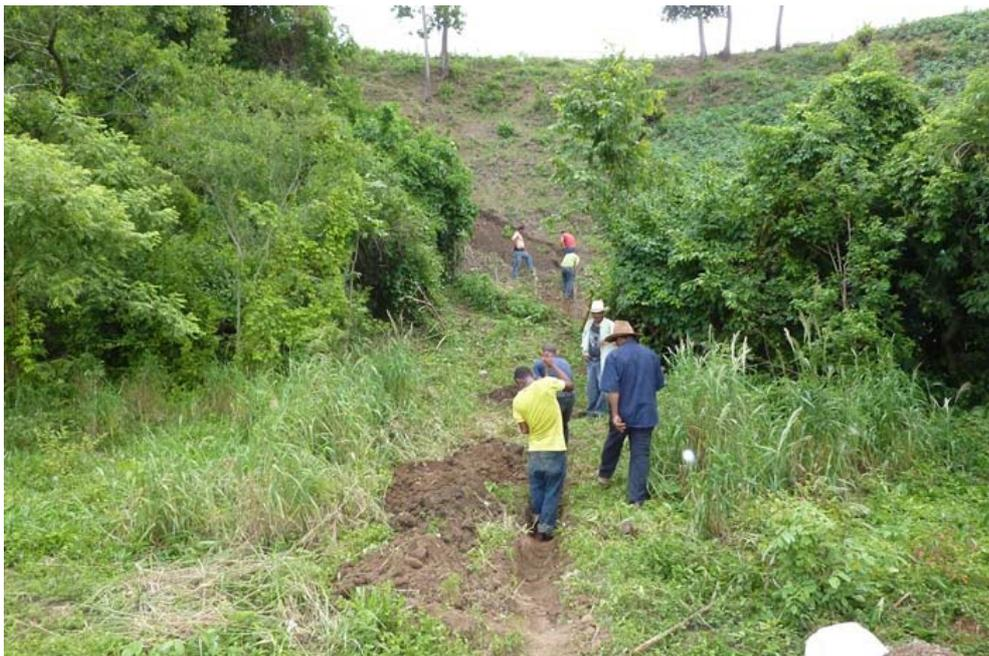
*Figura 177.- El zanjeo y colocación de tubería incluía tramos de fuerte pendiente*
