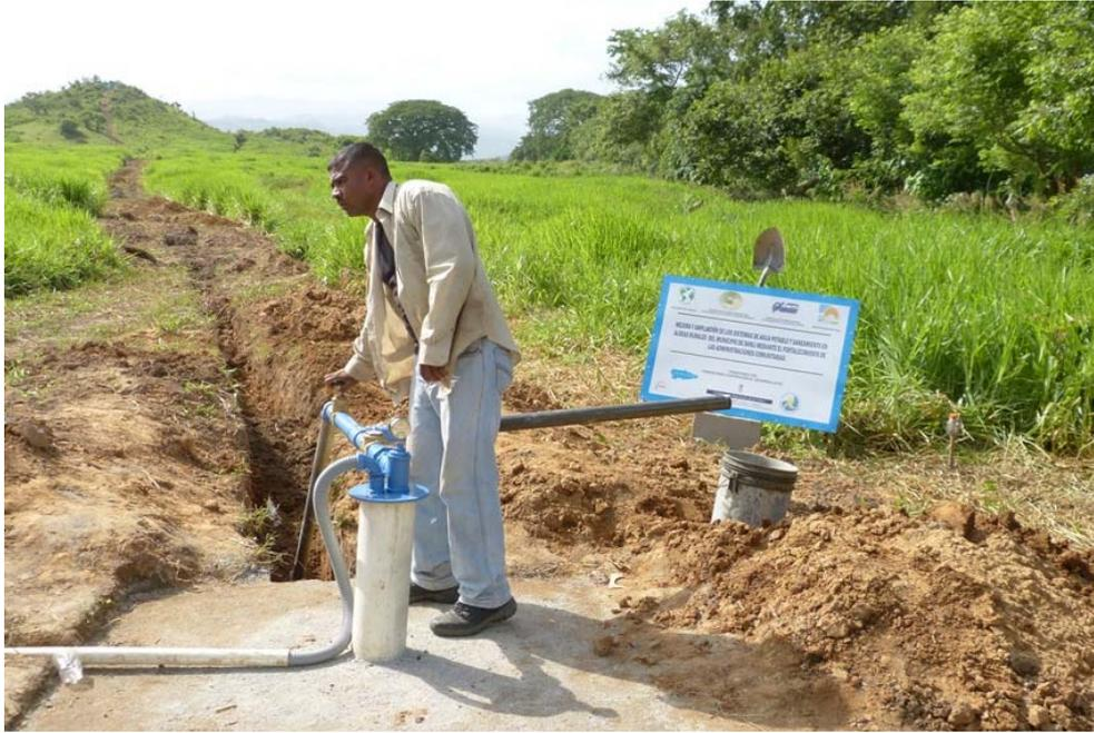
**Figura 116.- Tren de descarga de la bomba conectado a la tubería de impulsión.**
