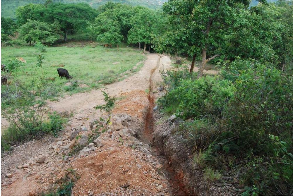
*Figura 69.- Zanja para la línea de conducción. La longitud final de la línea es de 342 m.*
