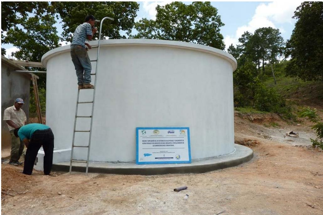
**Figura 65.- Tanque ya pintado y provisto de escalera de acceso a la parte superior e hipoclorador.**
