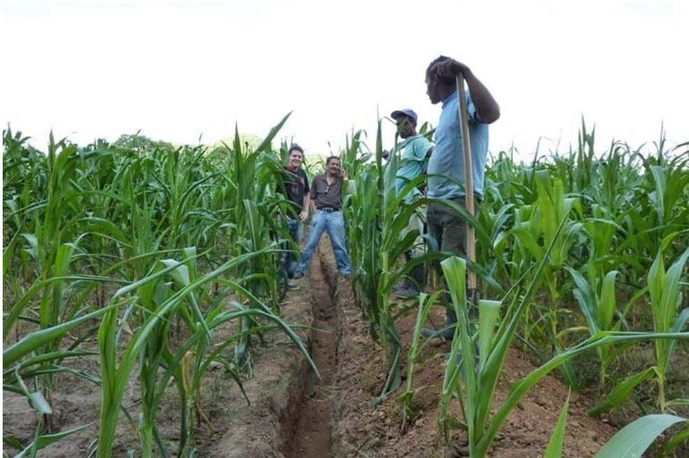
*Figura 175.- El trazado de la tubería atraviesa dos extensas “milpas” (tierra cultivada con maíz) en esos pasos la zanja se ajustó a los riegos entre plantas con el fin de minimizar el daño. Aún así, hubo que pagar algunas plantas dañadas.*
