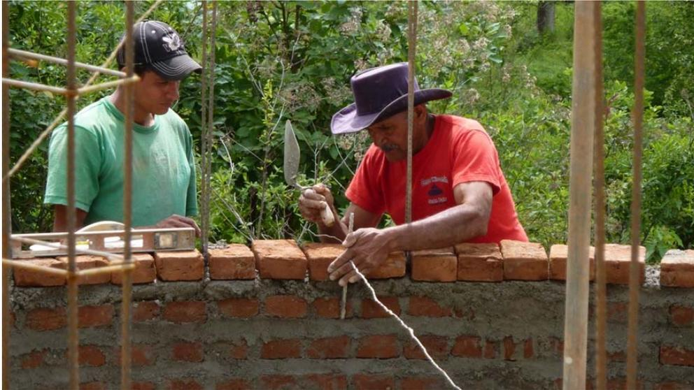
**Figura 54.- Operación de alineado de los ladrillos.**
