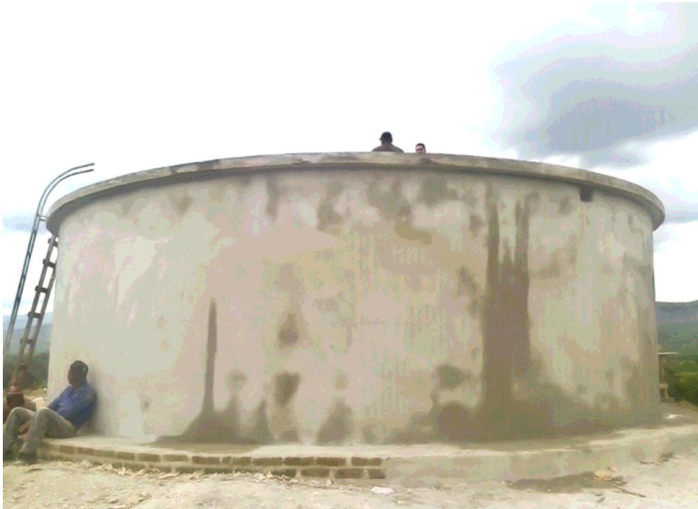
**Figura 147.- Tanque una vez finalizada la losa de cierre.**
