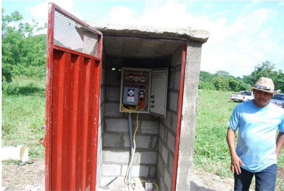
**Figura 173.- Controles eléctricos de la bomba instalados ya en la caseta de protección**
