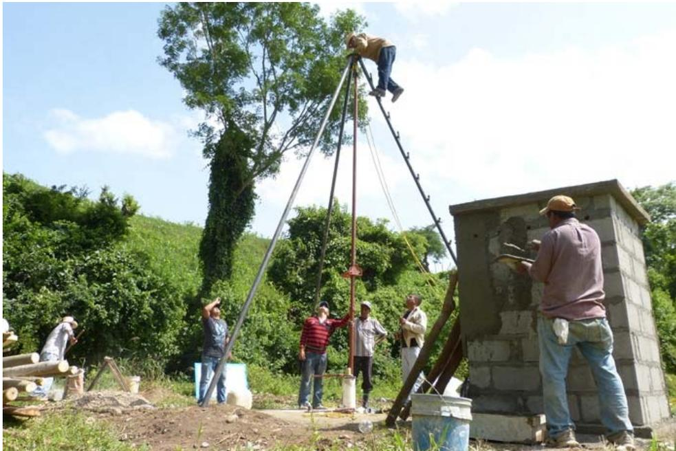
**Figura 170.- Preparativos para instalación de bomba definitiva, Se observa que paralelamente se procedía a la construcción de la caseta de protección para ls controles eléctricos.**
