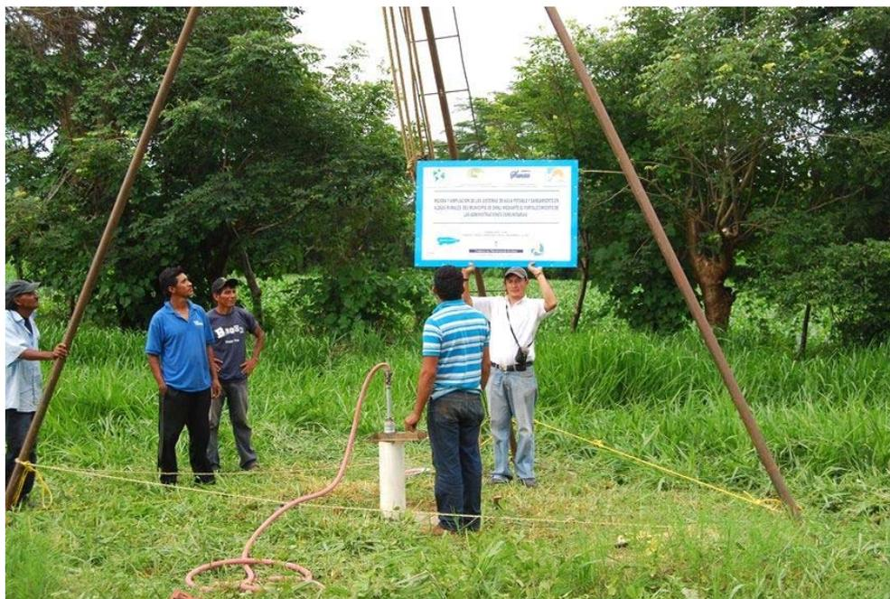
**Figura 88.- Preparados para la limpieza con la cabeza de inyección ya conectada a la manguera de aire comprimido.**
