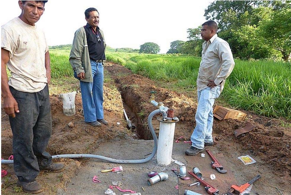
**Figura 109.- Instalando el tren de descarga.**
