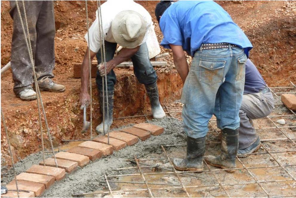
**Figura 48.- Colocación de la hilada “perdida” de ladrillo.**
