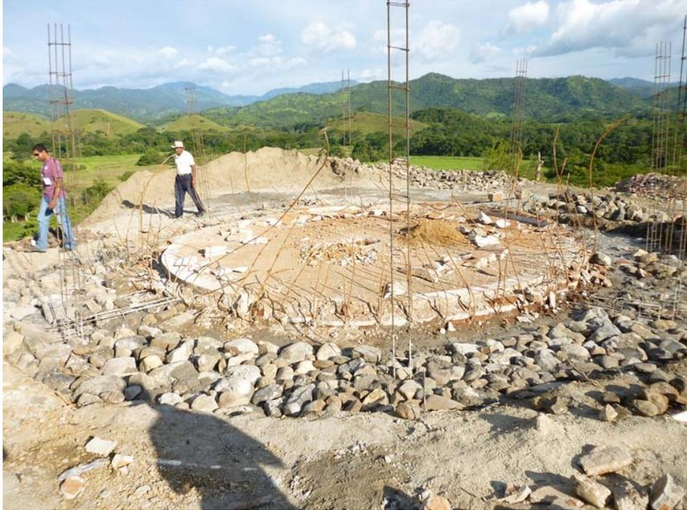
**Figura 134.- Relleno de zanja perimetral mediante piedra y cemento**
