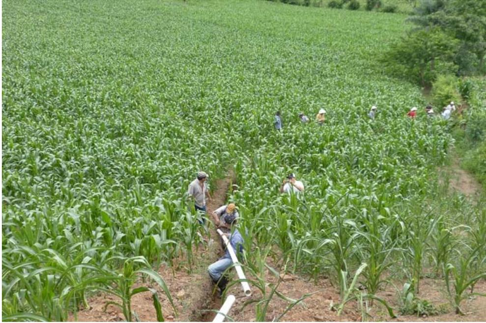
*Figura 180.- La colocación de tubería y el aterrado de la misma fueron labores simultáneas. Por delante colocan y por detrás aterran.*
