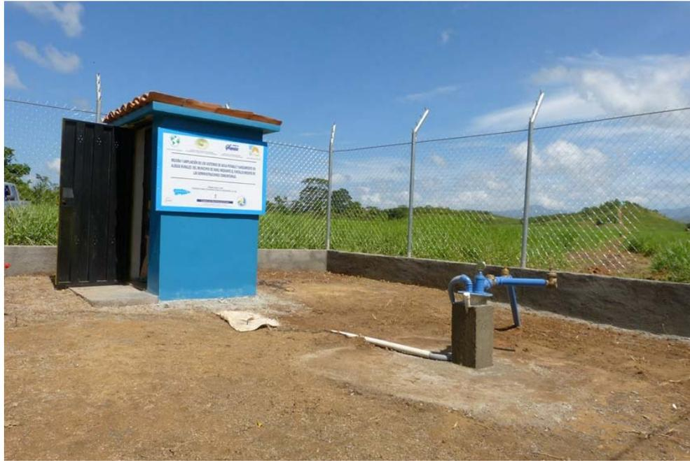
**Figura 123.- Cierre ya terminado. Se observa en la caseta un sobretejado de teja y la plataforma interna del cierre rellena con grava dren.**
