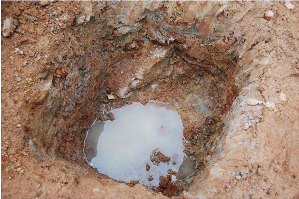
**Figura 40.- Fondo de zapata excavado.**
