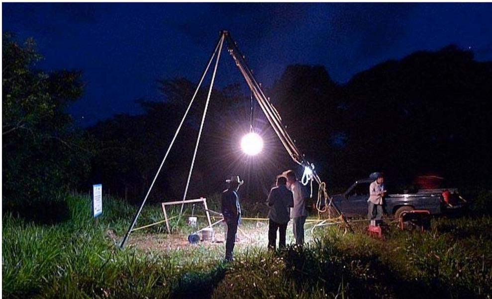
**Figura 95.- El ensayo se prolonga por un periodo de 24 horas o hasta que se alcance el nivel estable para el caudal ensayado.**
