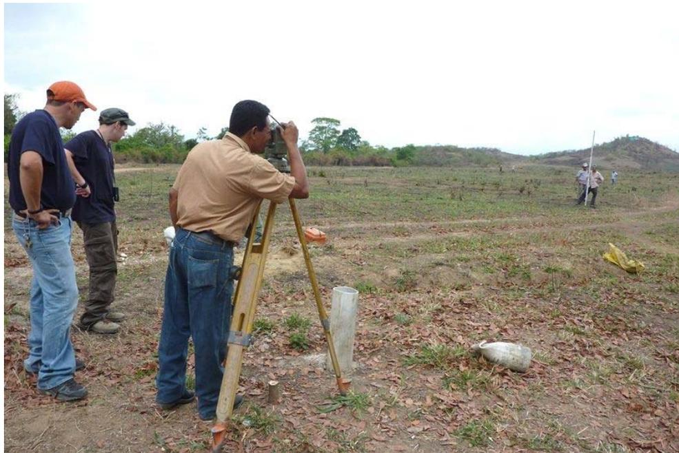
**Figura 83.- D. Ernesto Flores, técnico del SANAA, realizando la topografía de la línea de impulsión.**
