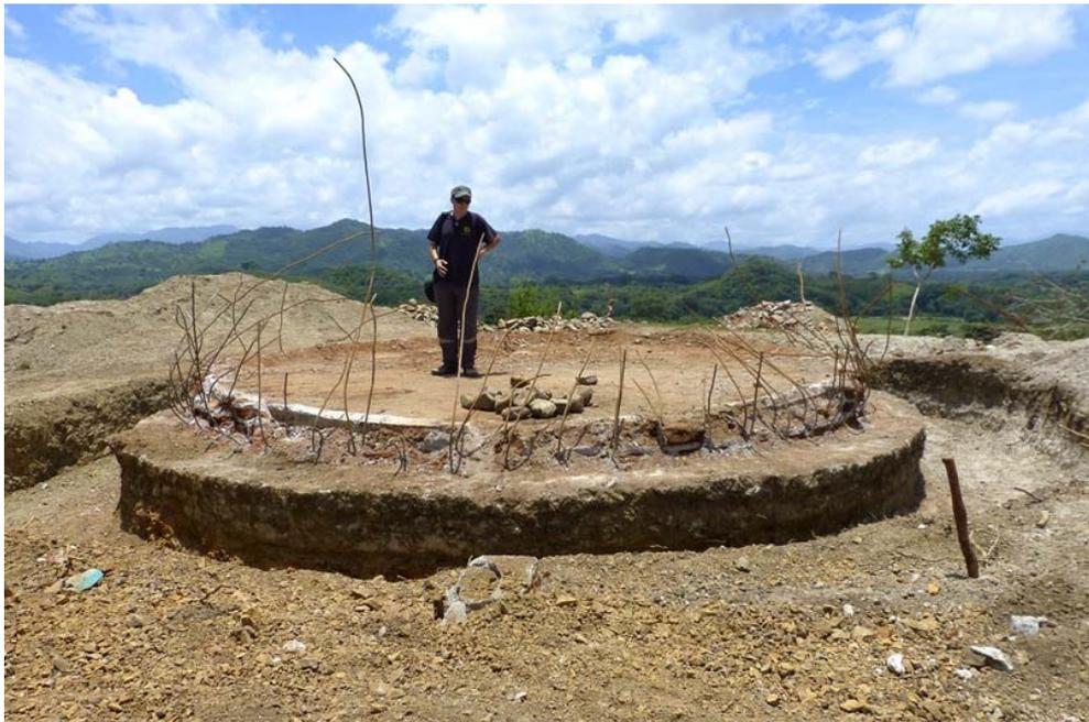
**Figura 133.- Preparación para la nueva cimentación mediante recrecido con anillo perimetral.**
