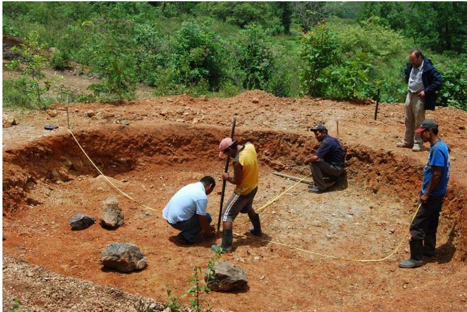
**Figura 38.- Replanteo de la posición de las zapatas de cimentación.**
