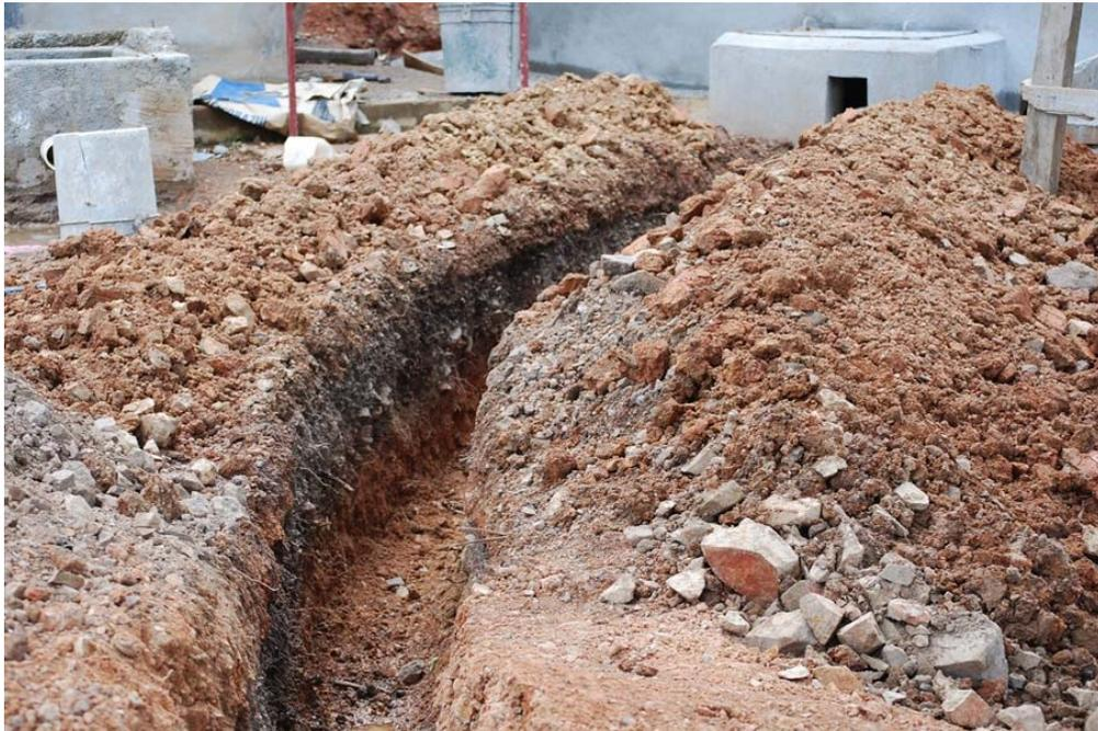
**Figura 68.- Zanja a la salida del tanque. Mediante esta línea de conducción también se conectó el pequeño tanque cuadrado que ya existía.**
