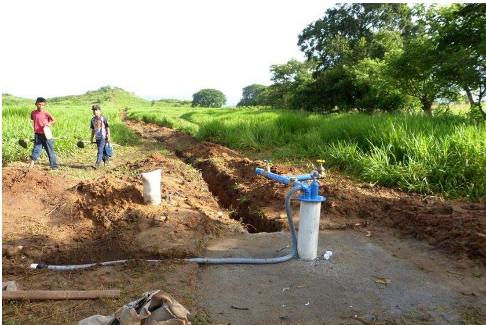
**Figura 110.- Bomba y tren de descarga ya instalados al igual que las conexiones eléctricas. Se puede ver en el montículo del fondo la posición del tanque de almacenamiento. También se aprecia ya realizado el zanjeo necesario para la tubería de impulsión.**
