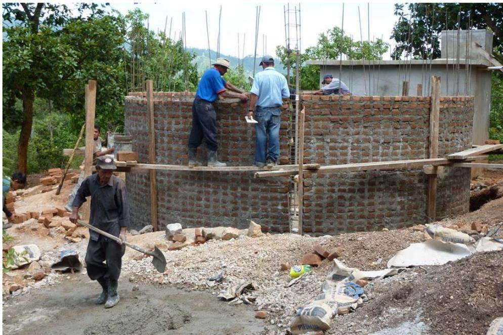
**Figura 53.- Las paredes van ganando altura. Se observan los pilares perimetrales aún no fundidos.**
