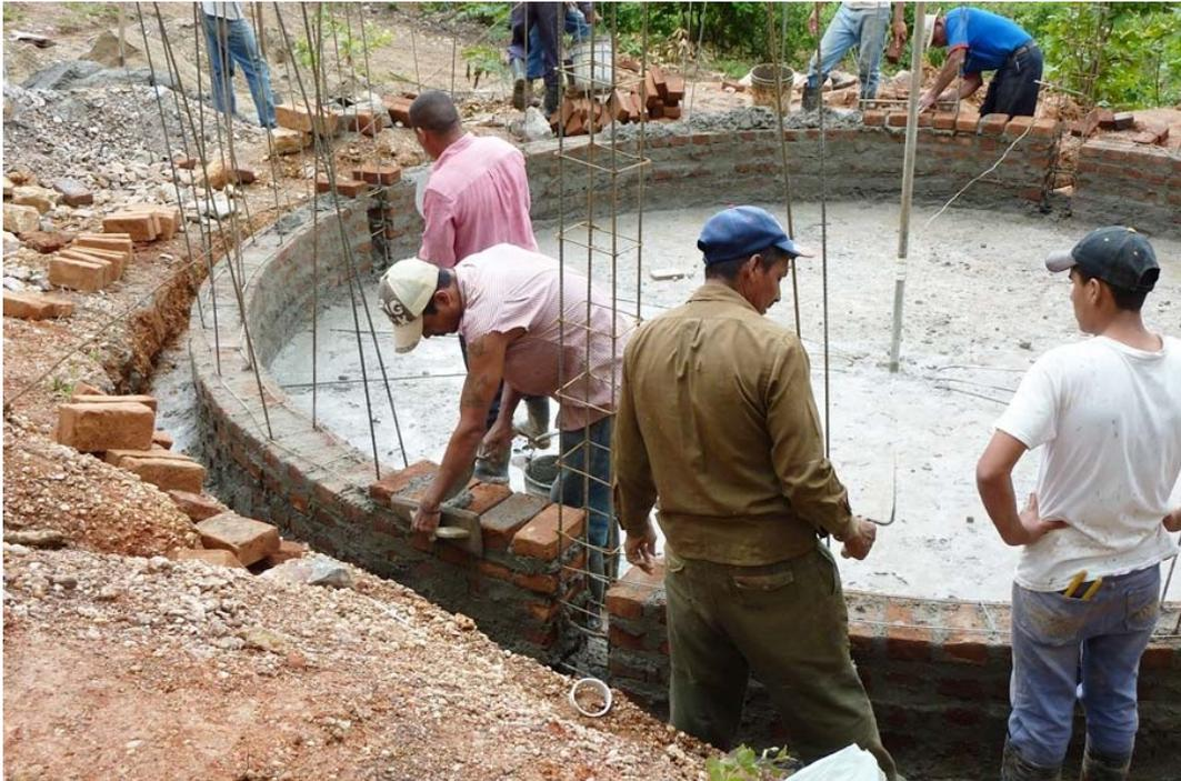
*Figura 50.- Alzado de paredes. Se pueden observar los refuerzos verticales de hierro y los anillos entre hiladas de ladrillo.*
