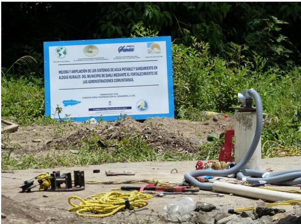
**Figura 172.- Instalación de la bomba ya finalizada a falta del tren de descarga.**
