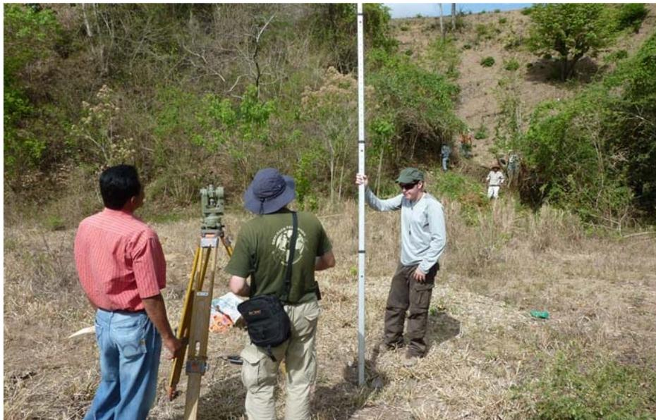
**Figura 156.- D. Ernesto Flores, técnico del SANAA, realizando la topografía de la línea de impulsión.**
