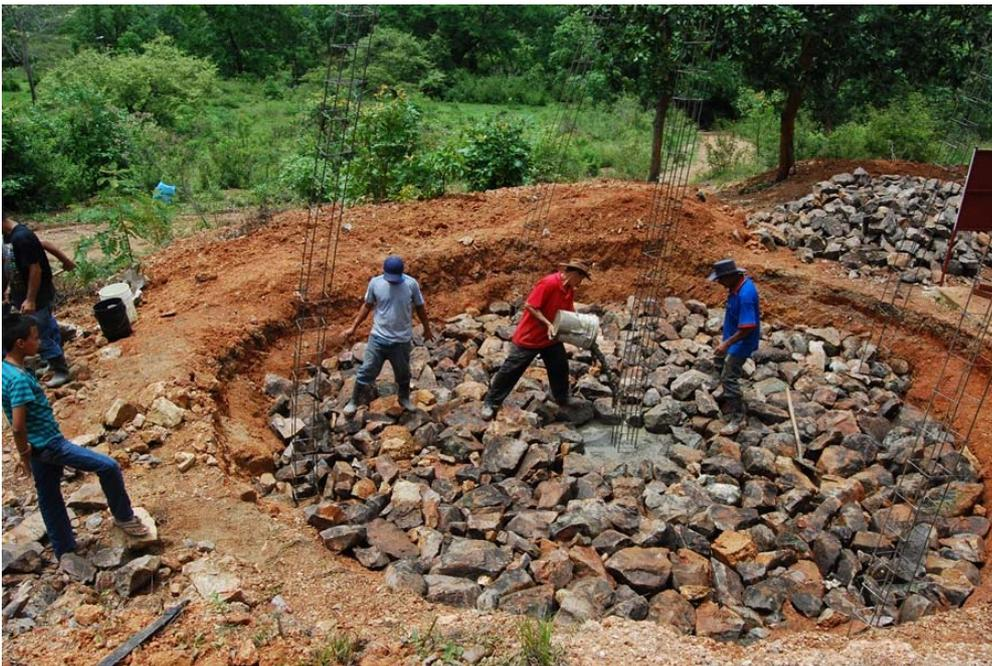
**Figura 43.- Solera de reparto en construcción.**
