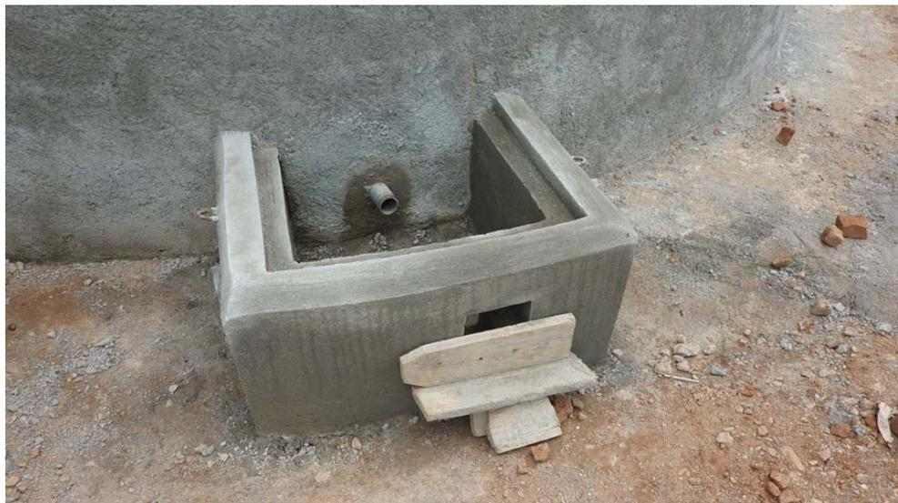
**Figura 57.- Caja protectora de válvula de salida.**
