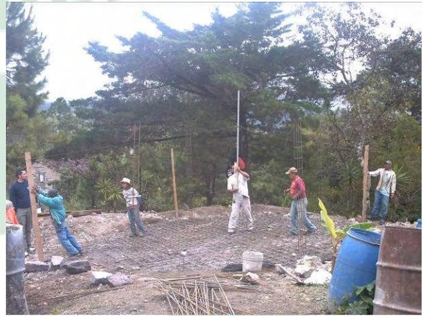
**Izquierda: Ejecución de solera; Derecha: colocación de varillas y mástil para el comienzo de ejecución de las obras del tanque.**
