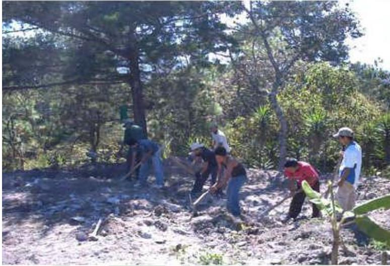
**Comienzo de las obras del tanque con los trabajos de profundización y nivelación del terreno previos a la cimentación.**
