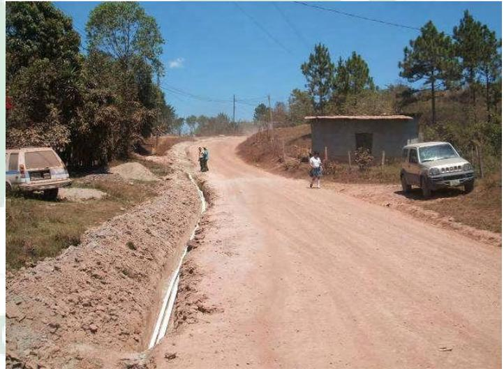
**Izquierda: tubería de hierro galvanizado procedente del tanque; Derecha: tubería de pvc a lo largo de la zanja.**
