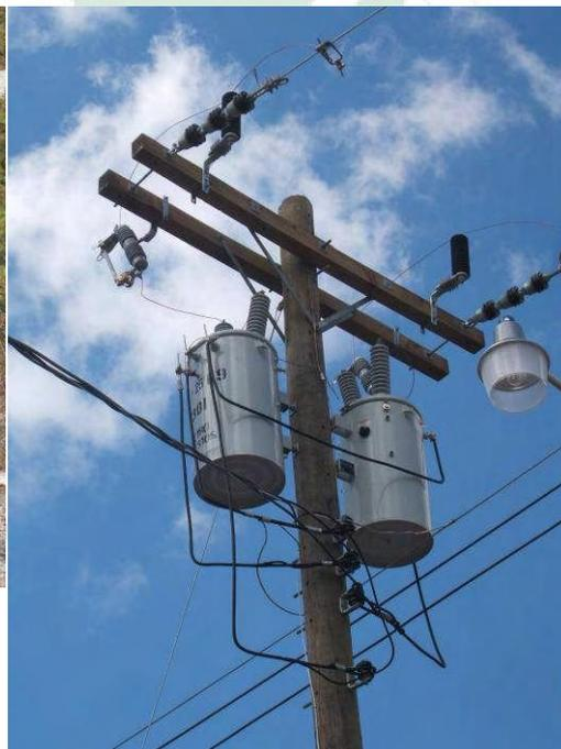
Los materiales consistieron en 2 transformadores Franklin de 25 kilovoltios cada uno, 3 postes eléctricos, 120 metros de cable de acometida número 1, 6 crucetas de madera y diversos
