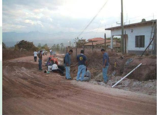
**Izquierda: Excavación de la zanja por parte del Batallón de Ingenieros. Arriba: Profundización de la zanja por parte de la comunidad.**
