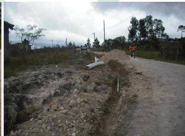
Diversas imágenes de la colocación de las tuberías. Izquierda arriba: Excavación de la zanja. Derecha arriba: Llegada del material. Abajo izquierda y derecha: Colocación en diversos tramos de la zanja.
