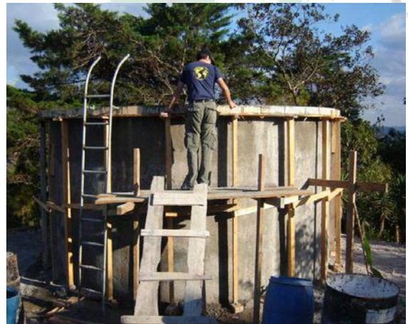
**Izquierda: Levantamiento de las hileras de ladrillos que compondrán el tanque; Derecha: Finalización de la construcción del tanque.**
