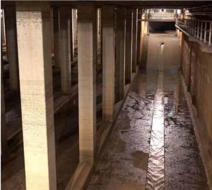
*Foto 7.7. Ejemplo de construcción de depósito para retención de aguas pluviales. Depósito de Zona Universitaria. Barcelona. Foto Clavas. (<http://www.clabsa.es>, consultado en línea febrero 2010)*
