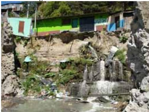
Foto 5.3. Erosión lateral y colapso.
