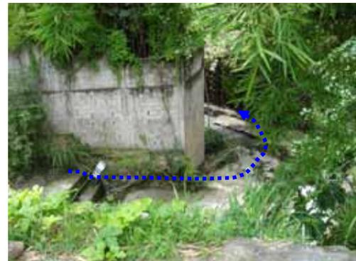
Foto 5.26. Encauzamiento y meandro en qda. sin nombre, afluente del arenal de Mejicanos. Programa IPGARAMSS, Geólogos del Mundo.
