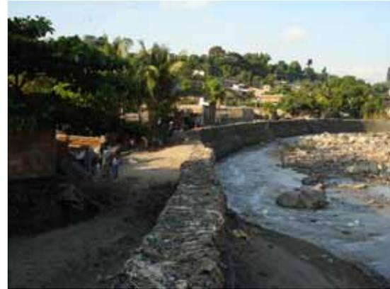
Foto 5.13. Muro en la comunidad Nueva Esperanza. Obsérvese el depósito en la calle. Programa IPGARAMSS, Geólogos del Mundo.
