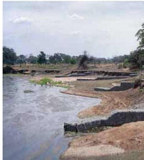
Figura 7.6. Esquema espigones como disipadores de energía y reductores de velocidad. Imagen de <http://es.wikipedia.org/wiki/Espigón> (consultado en línea febrero 2010)
