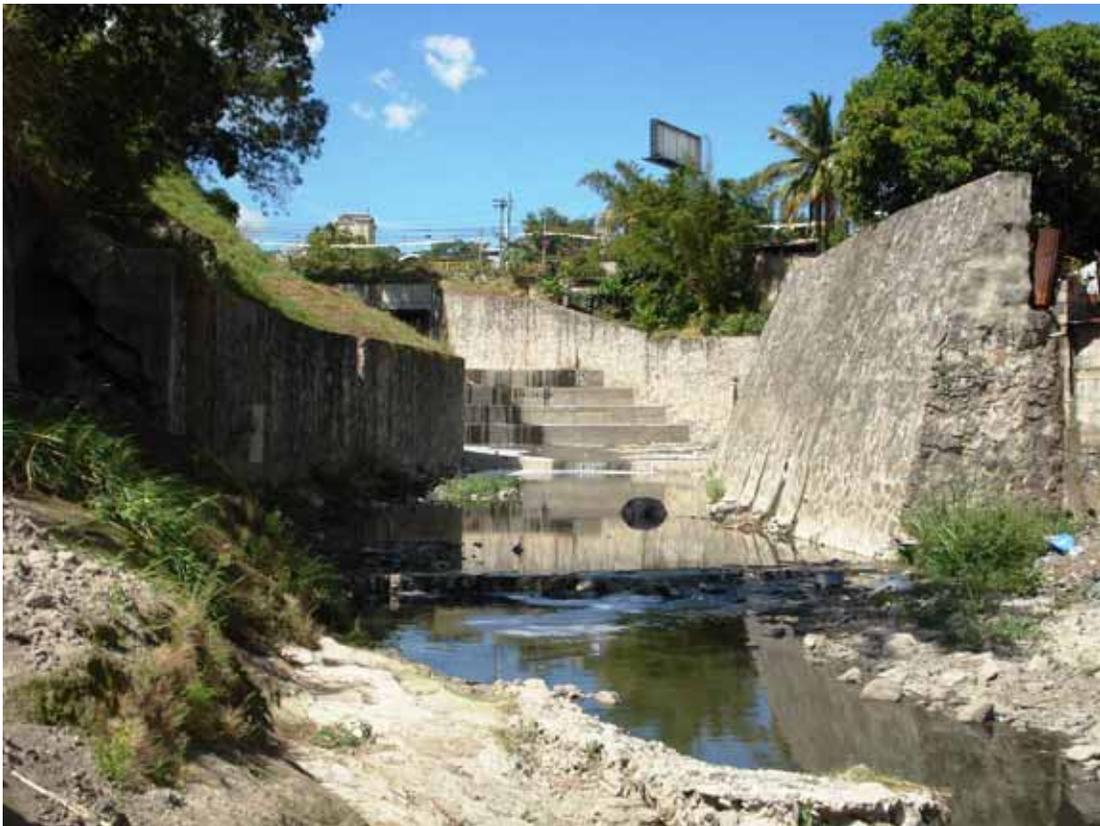
*Foto 7.4. Imagen de la comunidad Nueva Israel donde se observa las obras de canalización del arroyo de Montserrat. Se diferencia la parte con disipadores y el lecho en buen estado a la zona con la morfología original.*
