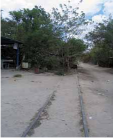
Vista General y Línea Férrea
