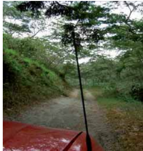
Camino rústico sin intervención
