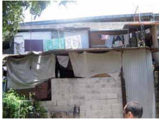
Vista General de Vivienda
