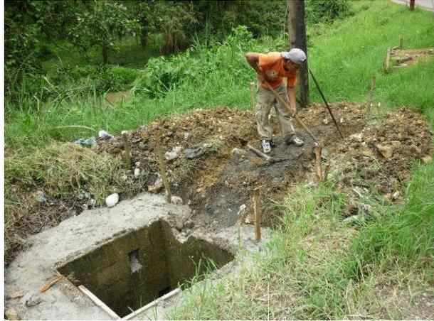
**Excavación de la zanja para la cimentación de la pila**
