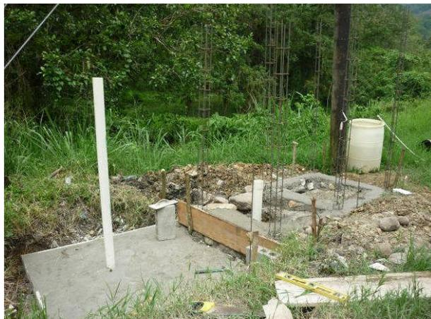
**Colocación de las columnas y de las tuberías**
