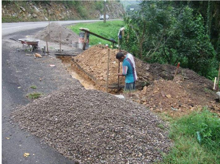
**Excavación del terreno para la cimentación de la caseta**
