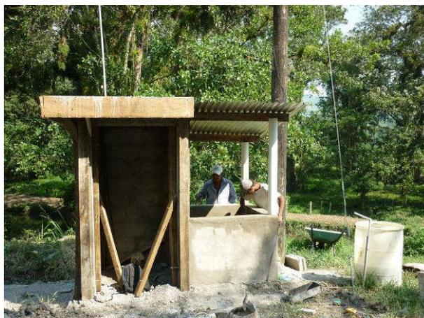
**Instalación del techo de zinc en la pila**
