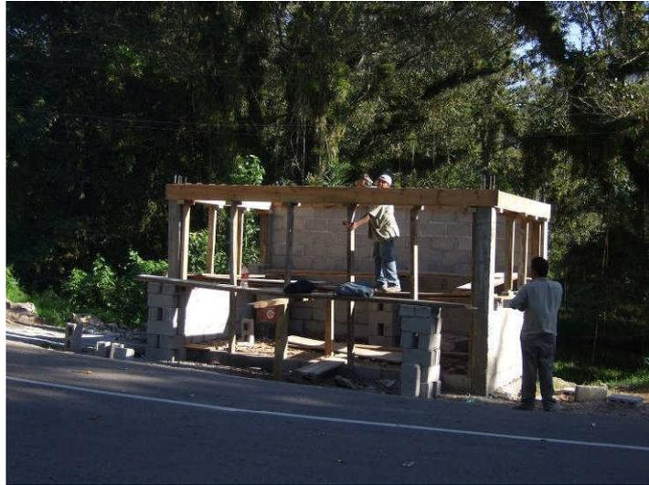
**Pegado del bloque y levantamiento de la estructura.**
