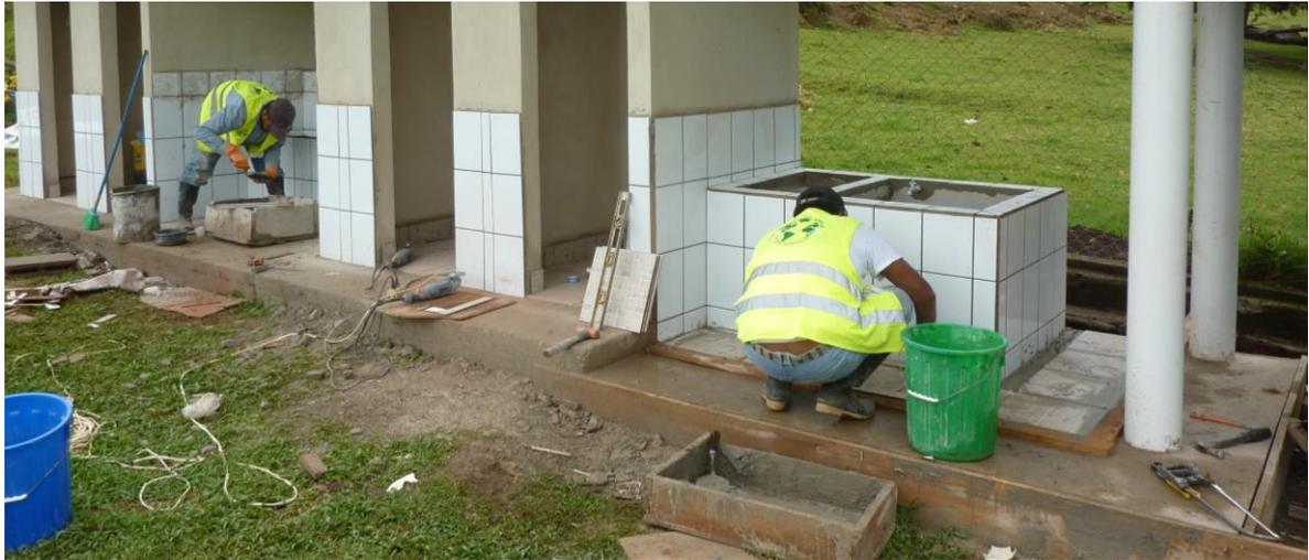
Para facilitar la limpieza e higiene se colocó cerámica en las paredes y suelo de los módulos sanitarios.
