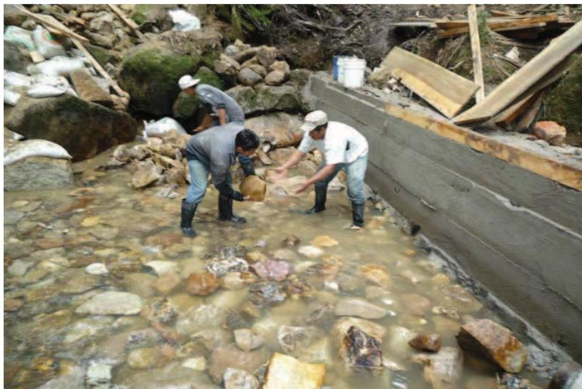
Foto 37: Inicio de la construcción de la solera, colocando el enchado de piedra
