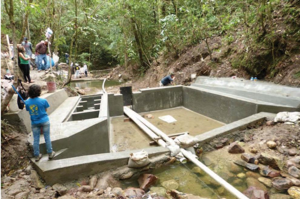
Foto 80: Presa ya prácticamente finalizada a falta de construcción de acera y tapas de filtros.
