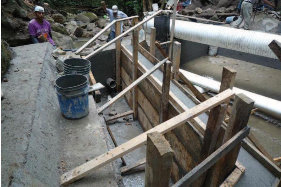
Foto 42: Levantamiento de las paredes de la caja de filtros
