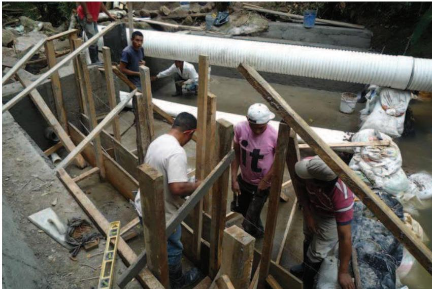
Foto 41: Inicio del encofrado de la caja de filtros
