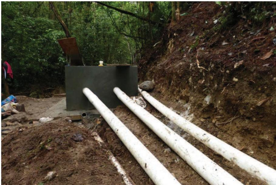
Foto 92: Tuberías de conducción a la salida de la cámara una vez rectificada su posición.
