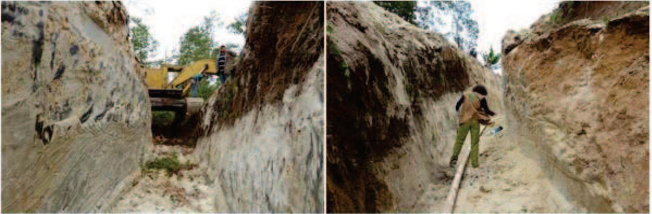
Foto 96: Zanjeo del punto crítico con una máquina
