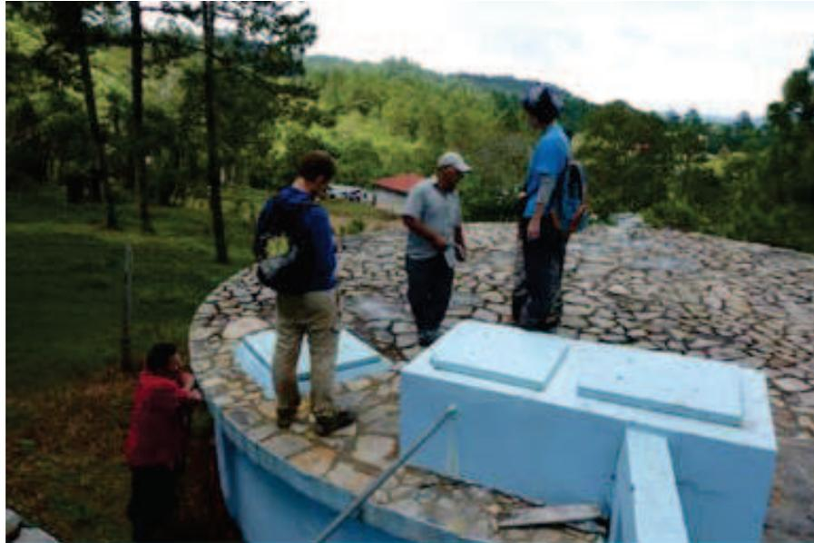
**Foto 16: Comprobación de estado de los tanques y de los hipocloradores**
