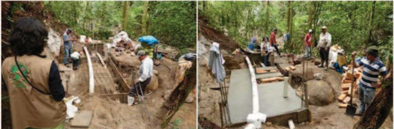
Foto 88: Cimentación de la cámara distribuidora
