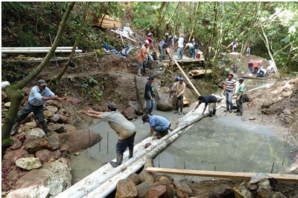
Foto 64: Ejecución de la solera del vaso principal. Se observan los bastones de enlace con el muro trasero.
