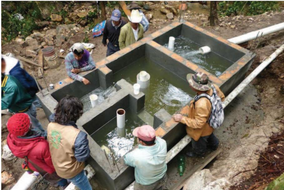
Foto 90: Cámara finalizada y prueba de funcionamiento. Tan solo resta el cierre superior.
