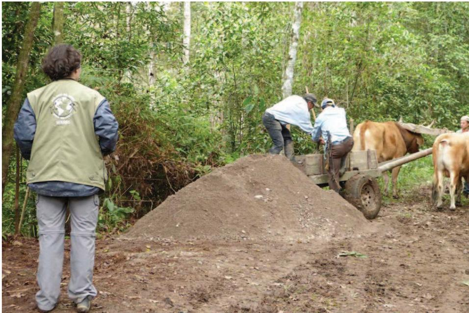
Foto 53: Segundo punto de acopio de material. Desde ahí el transporte a pié de obra se realiza a por sendas a hombros de personal.
