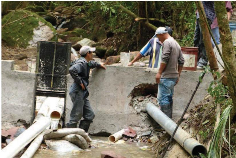
Foto 77: Sustitución del tubo de salida de los filtros.
