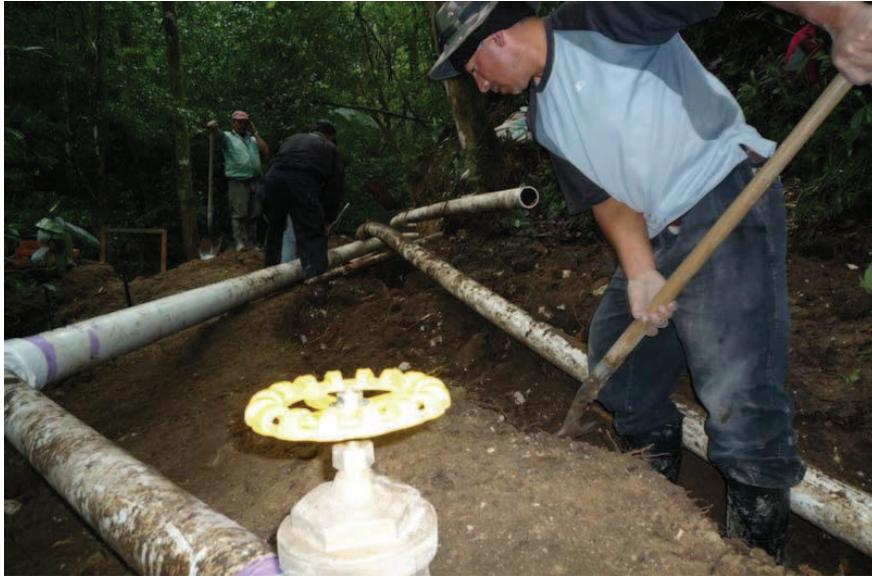
Foto 91: Instalación de las tuberías de conducción por parte de las comunidades.
