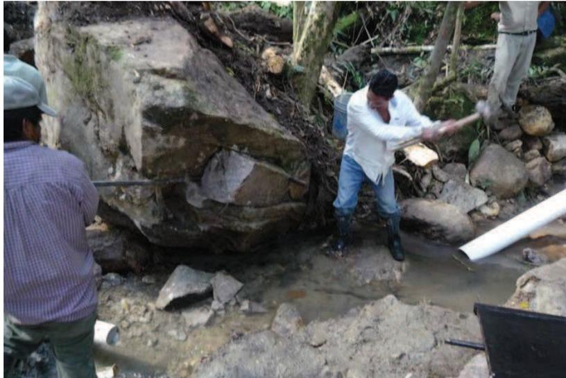
Foto 36: Retirada de la piedra entorno a la zona donde va colocado el tubo de salida para asegurar su protección
