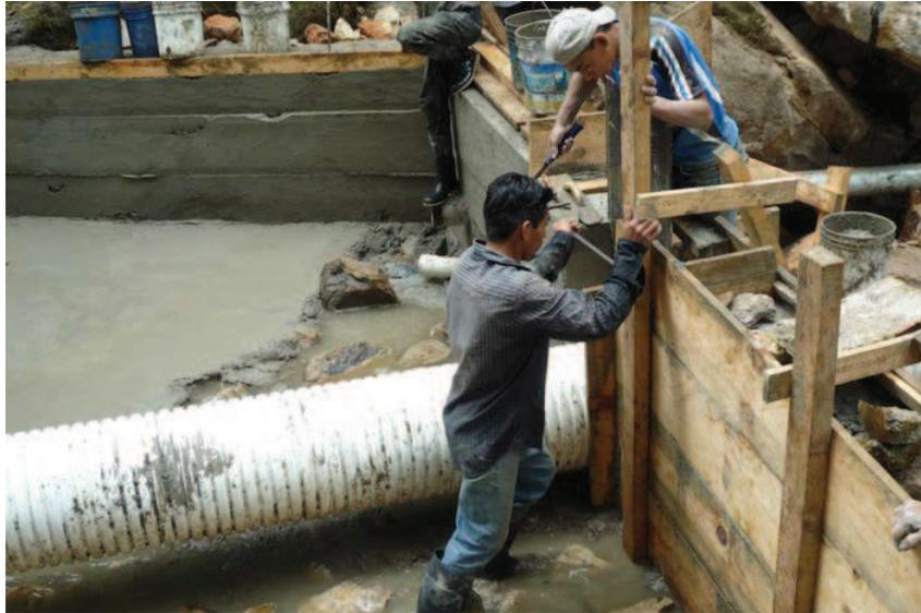
Foto 40: Desencofrado de la cortina y de la aleta lateral izquierda
