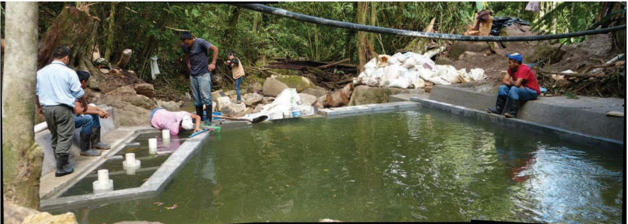
Foto 47: Primera prueba de llenado de la presa. A la izquierda la caja de filtros comenzando a funcionar.
