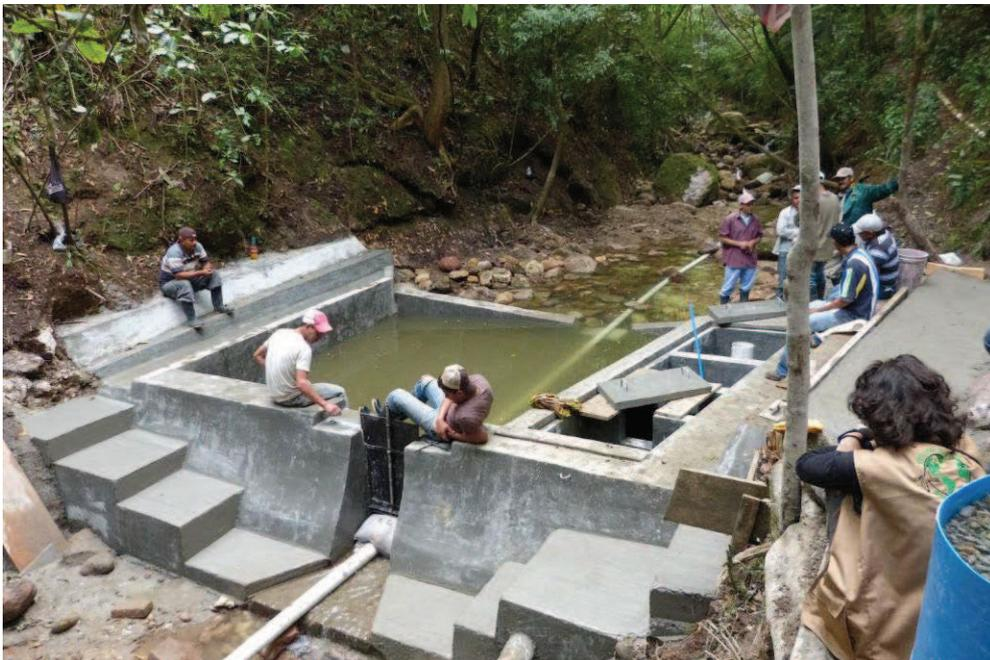
Foto 81: Prueba de llenado. Se observa ya la acera construida y las tapas de los filtros.
