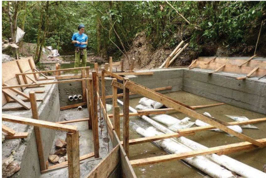
Foto 72: Inicio de la construcción de la caja de los filtros.
