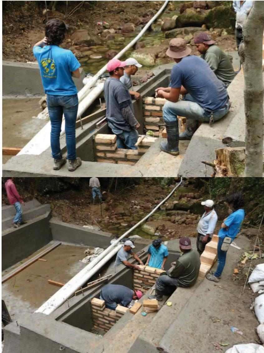
Foto 74: Construcción de las celdas interiores de los filtros.
