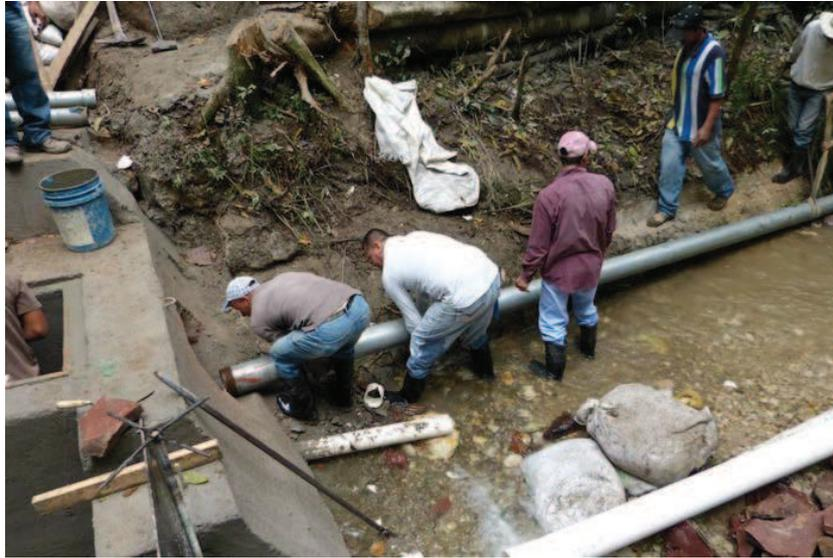
Foto 76: Sustitución de los tres tubos de salida por un único tubo de 6"
