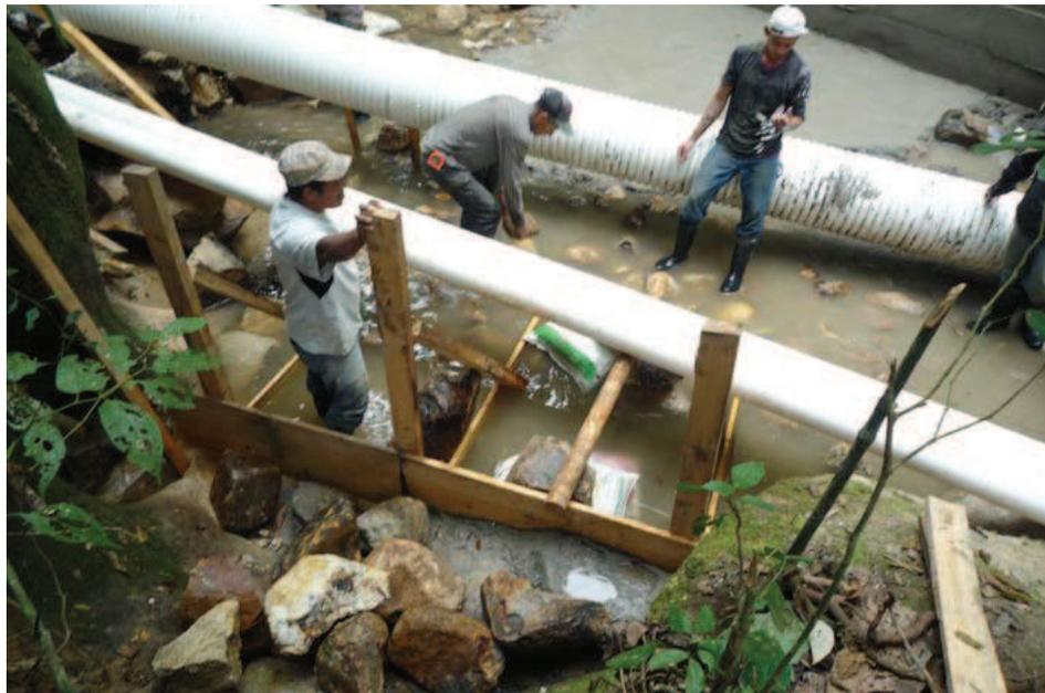
Foto 39: Inicio del levantamiento de la aleta derecha
