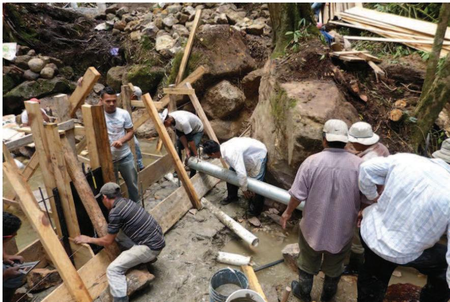
Foto 33: Colocación del tubo de salida en el encofrado de la cortina.
