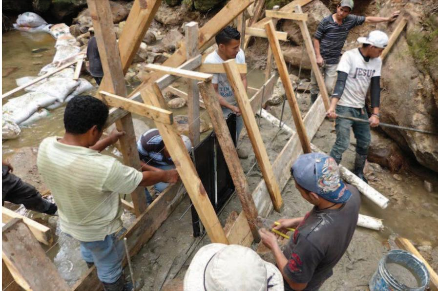
Foto 32: Encofrado de la cortina y colocación de la compuerta.
