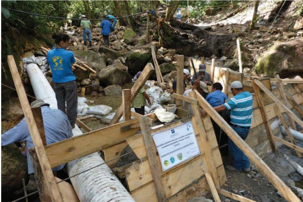
Foto 34: Levantamiento del encofrado de la cortina y de la aleta lateral izquierda.
