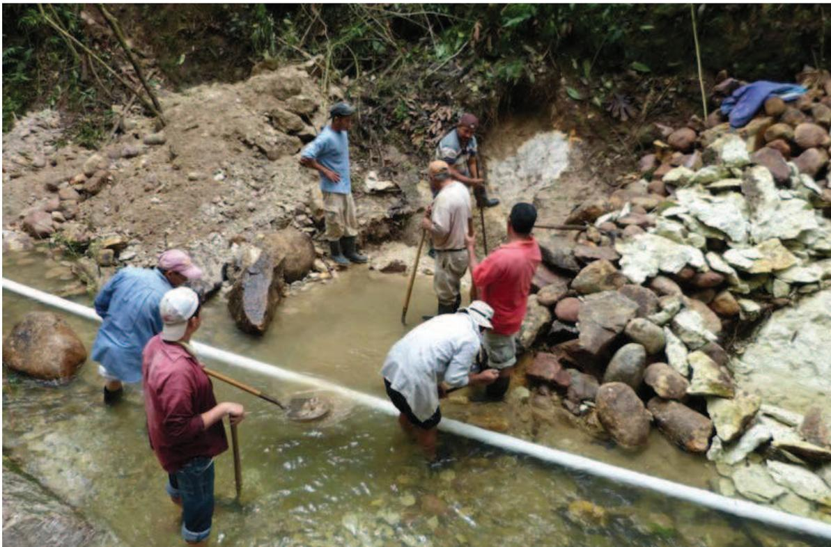
Foto 60: Excavación de los huecos para la cimentación de la cortina.
