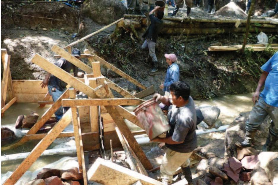
Foto 68: Levantamiento de la cortina. Vertido del hormigón en el encofrado.
