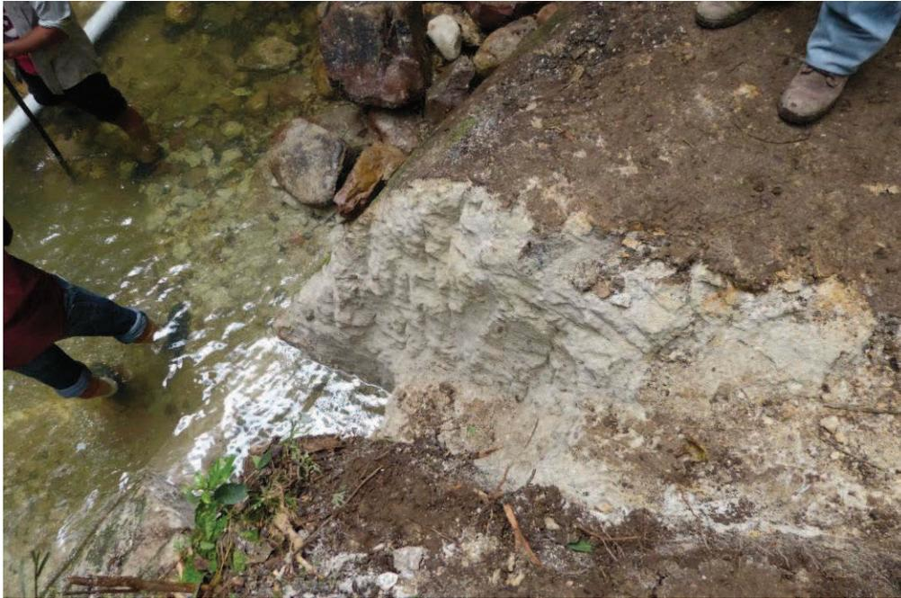
Foto 61: Empotramiento de la cimentación y cortina en el sustrato rocoso formado por tobas volcánicas.
