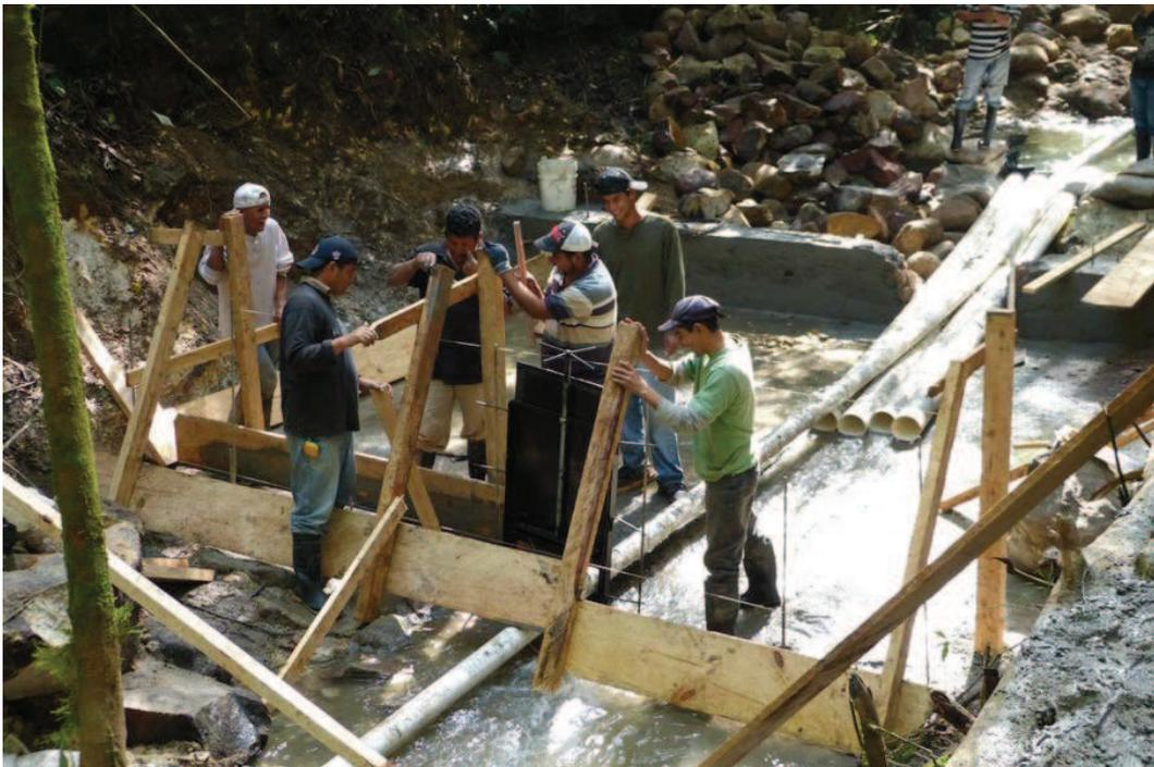
Foto 67: Levantamiento de la cortina. En esta imagen se puede observar a los trabajadores colocando el encofrado y la compuerta. Además al fondo se ve que ya el muro trasero está finalizado.
