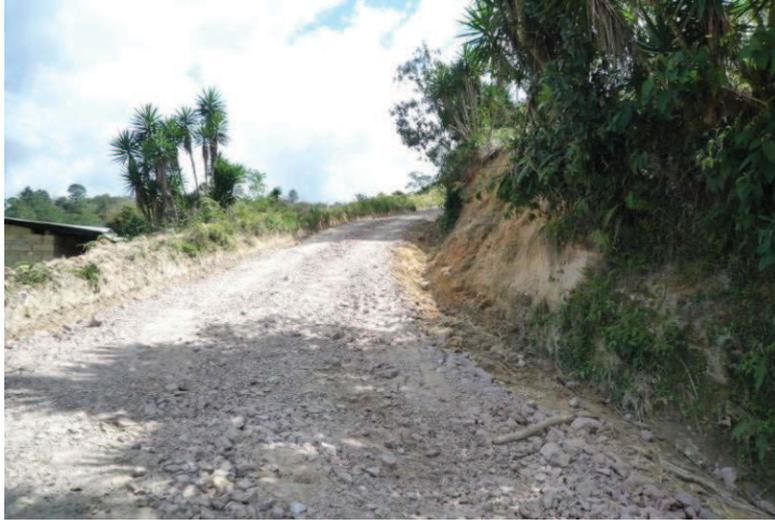
Foto 51: Acondicionamiento de las vías con piedra, para que las volquetas lleguen al primer punto de acopio.
