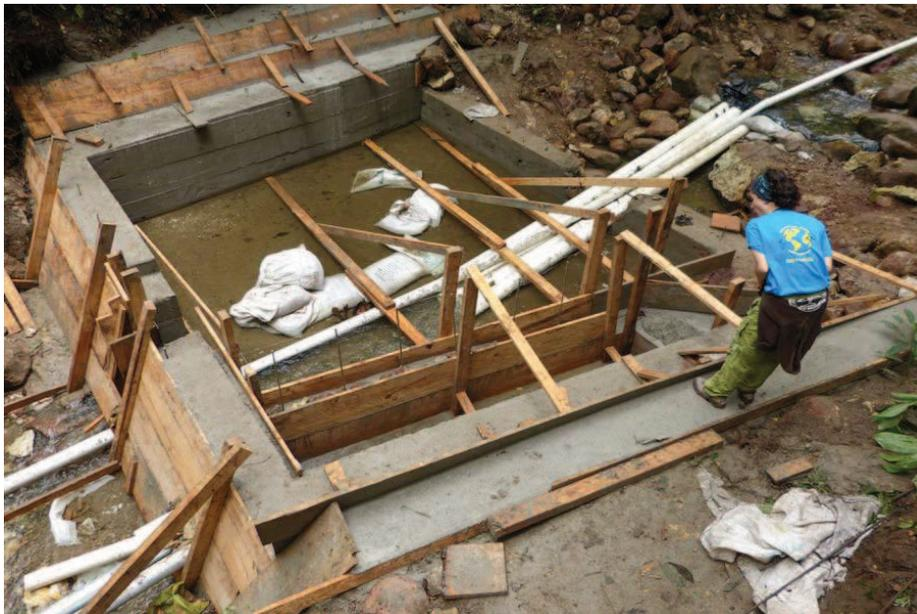
Foto 71: Presa con los elementos de obra principales construidos. En proceso, el inicio de los filtros
