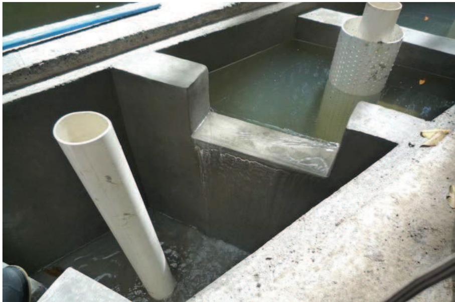
Foto 43: Celdas divididas y tubos de drenaje colocados
