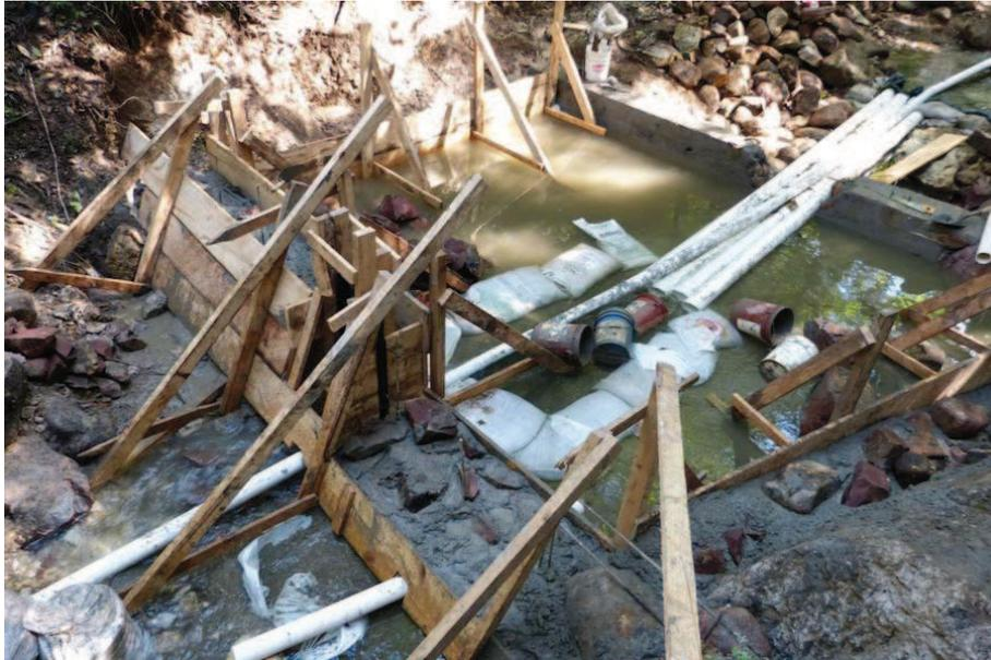
Foto 70: Levantamiento del encofrado de la cortina y de la aleta lateral izquierda.
