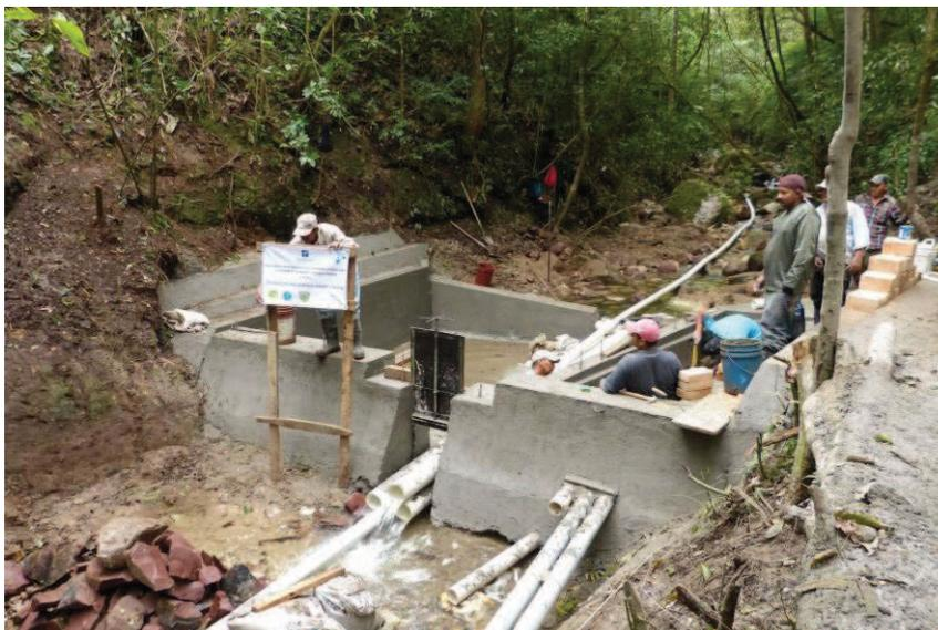
Foto 73: Presa ya desencofrada . En construcción la caja de los filtros. Se puede ver los tres tubos de salida a conducción inicialmente colocados
