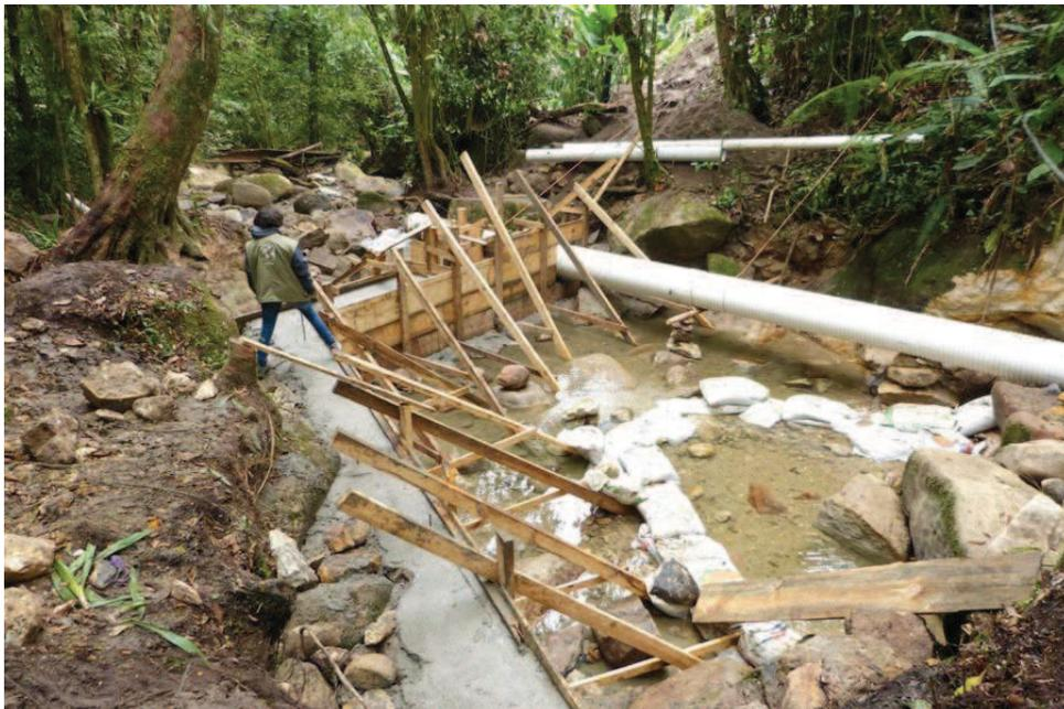
Foto 35: Fraguado de la cortina y de la aleta lateral izquierda
