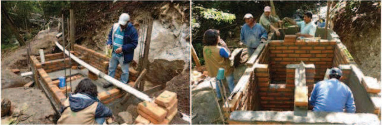
Foto 89: Construcción de la cámara de distribución de caudales.
