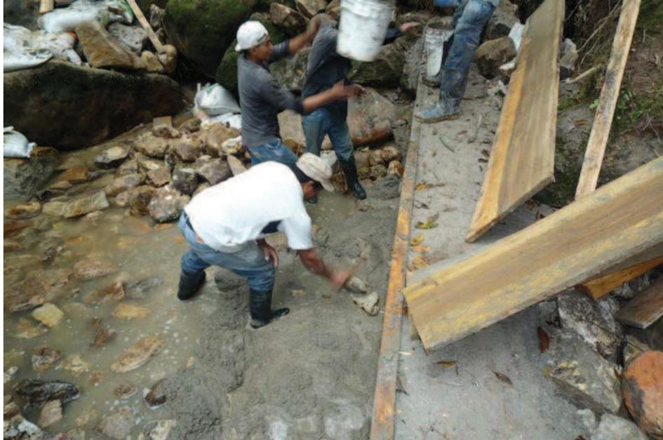
Foto 38: Vertiendo la mezcla de cemento sobre el encachado de piedra para conseguir la solera
