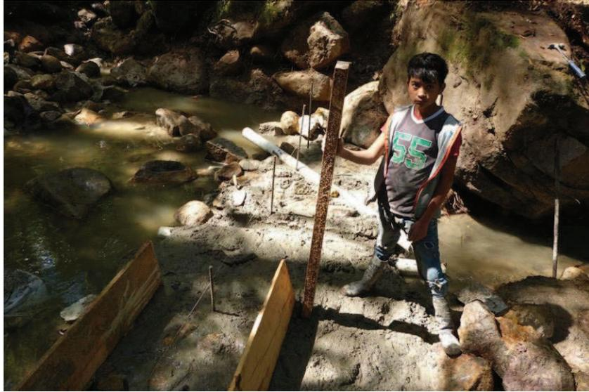
Foto 30: Cimentación de la cortina e inicio del levantamiento de la misma.
