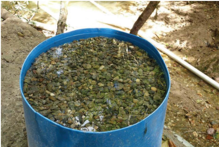
Foto 79: Desinfección de las gravas de los filtros por inmersión en agua con alta concentración de cloro
