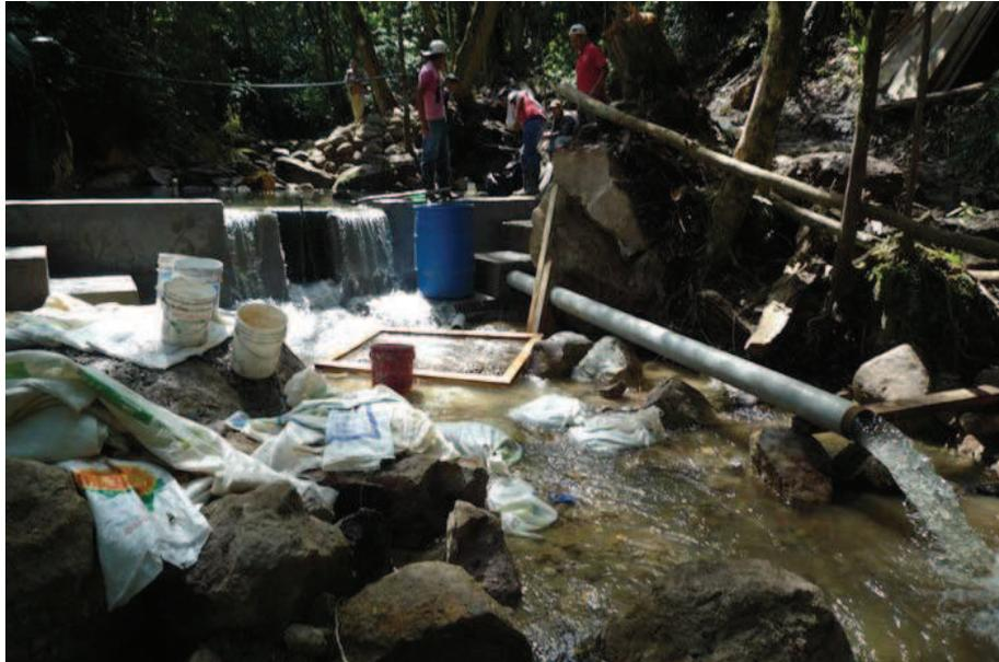
Foto 48: Primera prueba de llenado, se observa la cantidad de agua que llega al tubo de salida
