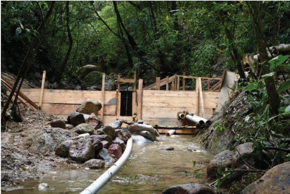
Foto 69: Frontal de la cortina, totalmente encofrada junto con la compuerta. En la parte inferior derecha de la cortina se pueden observar los tres tubos de salida a la conducción.
