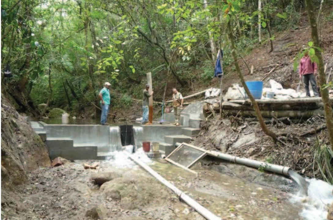
Foto 82: Primera prueba de llenado, se observa la cantidad de agua que sale por el tubo de salida, abajo a la derecha
