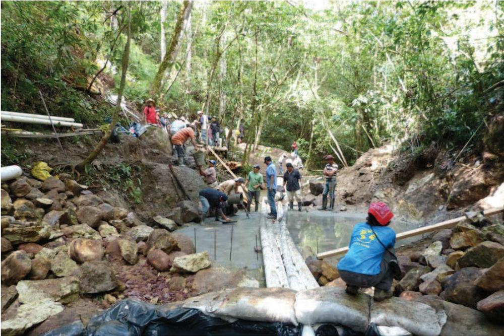
Foto 63: Ejecución de la solera. En primer plano la represa provisional con sacos terreros para derivación del agua del río
