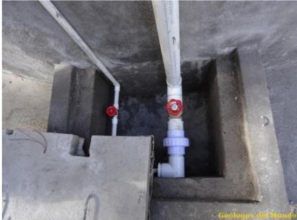
Se instalan las cajas de válvulas para la regulación de entrada y salida del agua. Posteriormente se realiza la conexión de la línea de conducción de entrada al tanque, con una sección de tubería de tres pulgadas, y las de salida de distribución, con una tubería de dos pulgadas de sección y otra tubería de una pulgada y media de sección, para poder distribuir el agua al grupo de viviendas ubicadas a una cota similar a la del tanque y también a las que se ubican por debajo del mismo.
