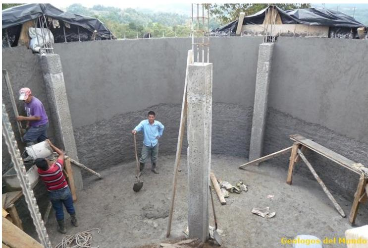
Se recubre con cemento las superficies interior y exterior del muro del tanque de agua, añadiendo a la mezcla un aditivo impermeabilizante.
