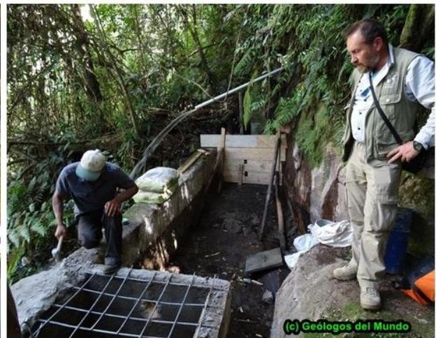
La segunda caja fue adaptada para un mejor aprovechamiento del agua captada y para la instalación posterior de los nuevos conductos de tubería. Se acondicionó el diámetro del conducto de salida al nuevo depósito de agua conforme al nuevo caudal aforado. Por último se incorporó un sistema de filtrado primario, consistente en un relleno de grava, para eliminar las partículas y cuerpos sólidos de mayor tamaño.
