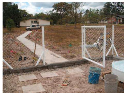
**Imagen 7:** Arriba. Proceso de excavación de la zanja perimetral y fundido con cemento y varilla de hierro. Abajo. Instalación de las dos filas de bloque con la maya y los tubos de hierro. A la derecha se puede ver la puerta y el camino que da acceso a la estación.
