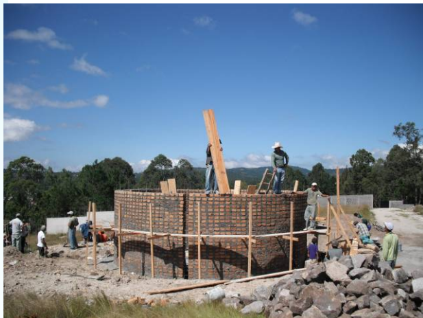
Izquierda: Obras de construcción del tanque. Derecha: El tanque, una vez terminado
