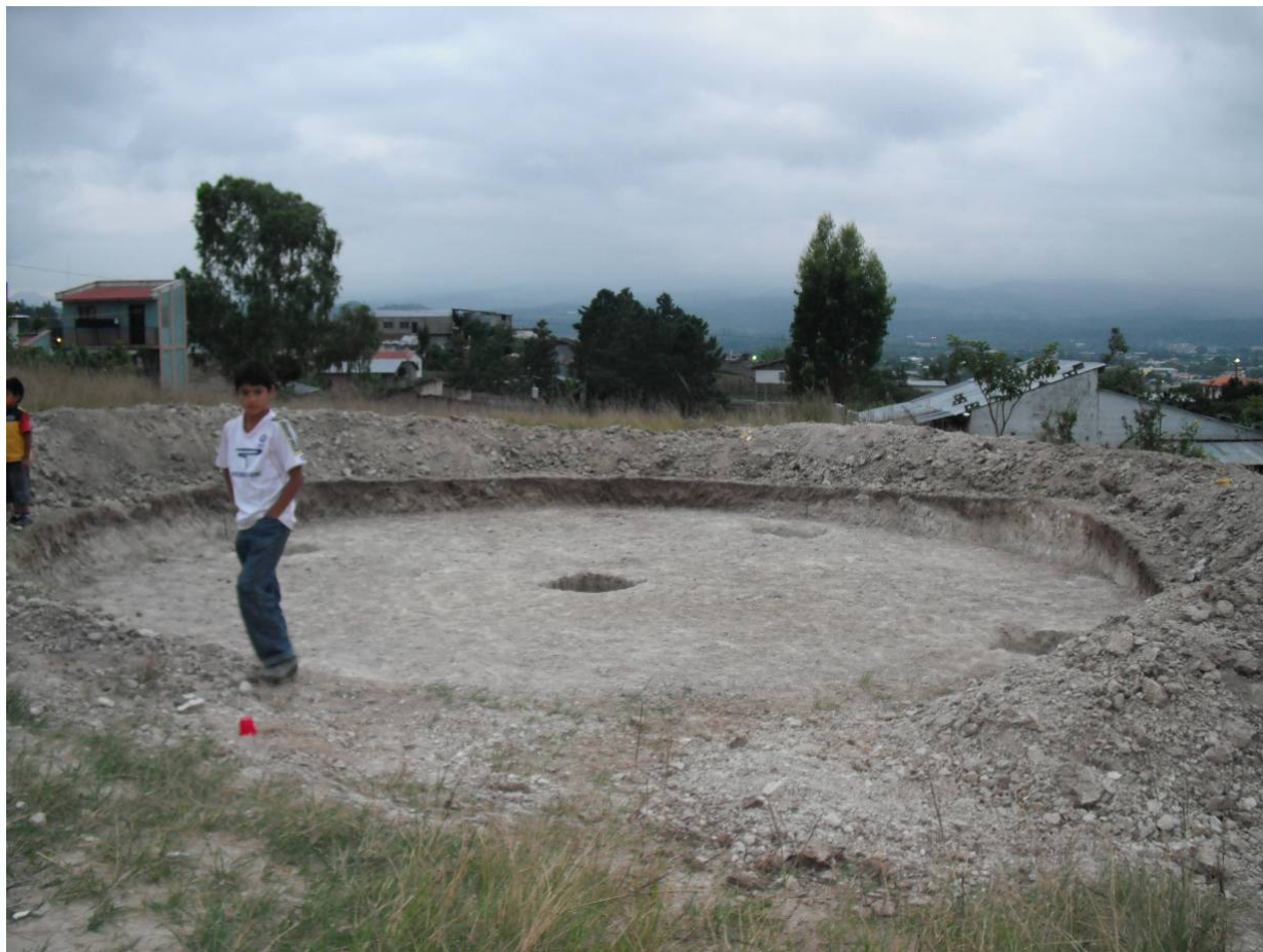
Comienzo de las obras: Profundidad de cimentación y excavación de los contrafuertes y viga central.
