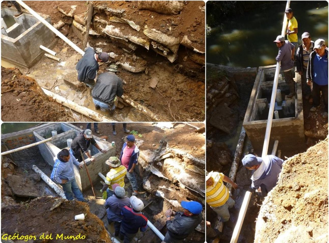
Sustitución de los 60 metros de línea de conducción desde la presa al depósito de agua.
