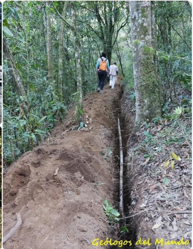
Zanqueo de nuevo trazado de ramal de distribución y colocación de 315 metros lineales de tubería para conexión.
