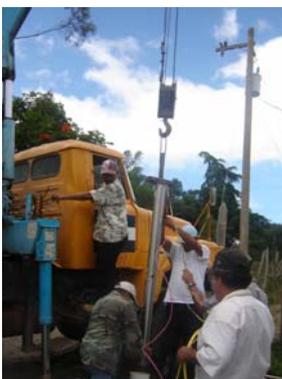
Foto 12: Instalación de la bomba sumergible por Aguas Subterráneas de Comayagua.
