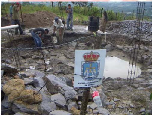
**Foto 10: Inicio de la cimentación del tanque de distribución de agua.**
