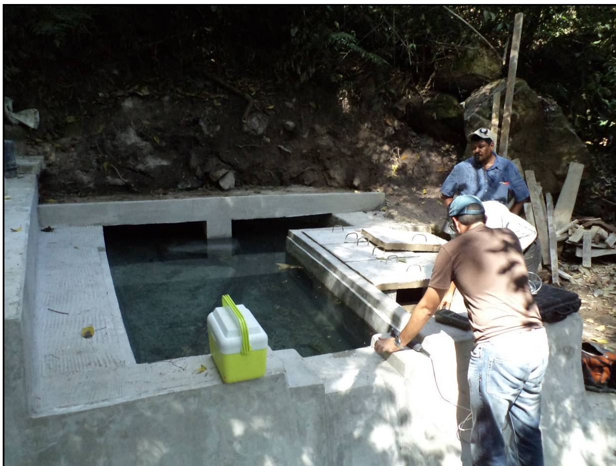
Obra terminada. Represa de abastecimiento para la aldea Rancho Alegre.
