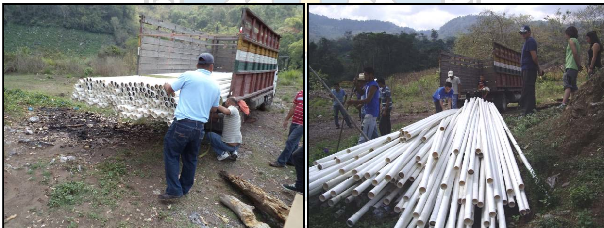
Llegada y descarga del material: 200 lances de RD-21 para el tamo de alta presión.
