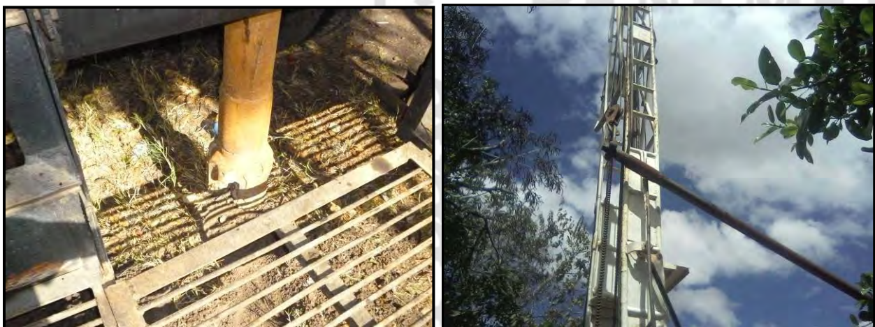
Imágenes 31 y 32. Izquierda: Varillaje listo para comenzar a perforar. Derecha: Acoplamiento de un segundo tubo al varillaje.
