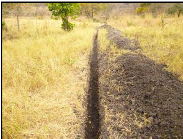
Imágenes 65 y 66: Zanja de la tubería impelencia. A la derecha puede observarse la alta pendiente de acceso al tanque.
