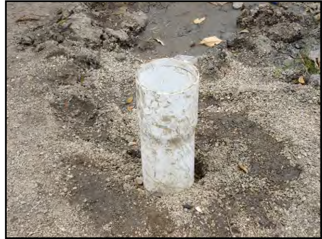
Imágenes 34 y 35: Izquierda: Muestra de roca triturada. Derecha: Entubado final con el empaque de grava
