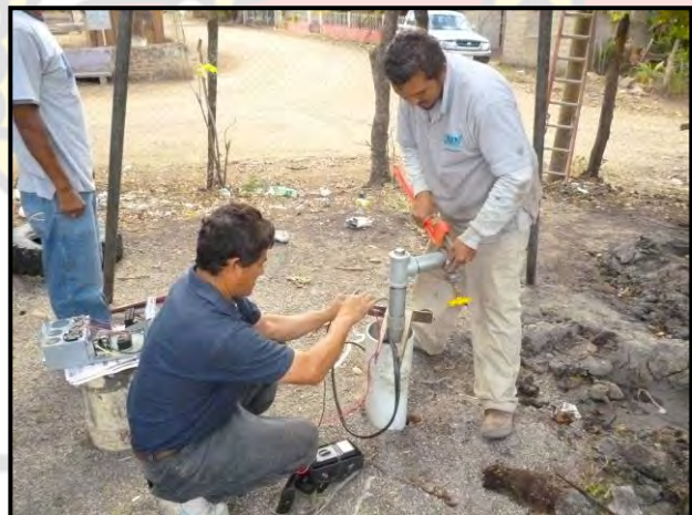
Imágenes 55 y 56: Izquierda: Los operarios de Will Vall Pozos comprueban que el equipo de bombeo y los accesorios se encuentren en condiciones para su instalación. Derecha: Acoplamiento del tren de descarga con la bomba ya instalada.
