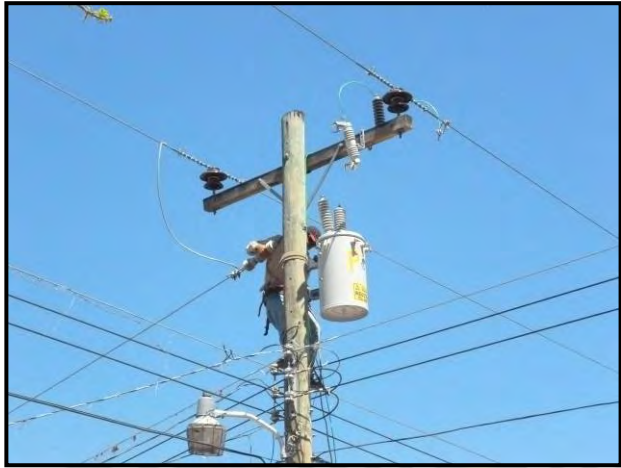
Imágenes 61 y 62: Izquierda: El técnico de la ENEE instalando el cortocircuito del transformador. Derecha: Transformador correctamente instalado listo para ser conectado.
