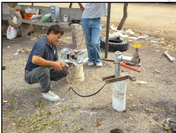
Imágenes 36 y 37: Izquierda: Conexión de la bomba a la red. Derecha: A punto de comenzar el aforo, con el hidronivel emplazado en el pozo.
