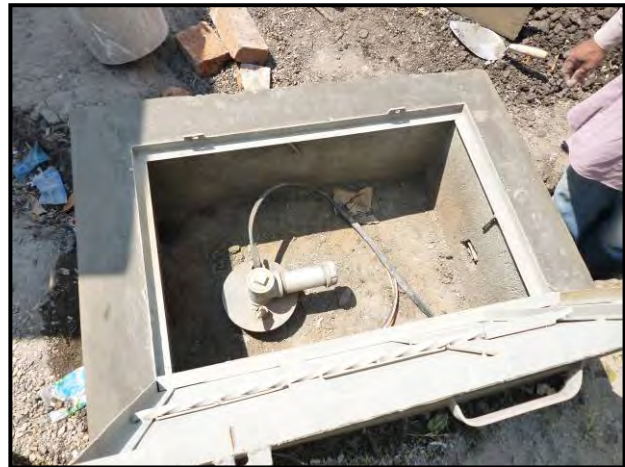
Imágenes 49 y 50: izquierda: Construcción de la caja de protección. Derecha: Caja terminada con la puerta y el pozo, a falta de conectar el tren de descarga.
