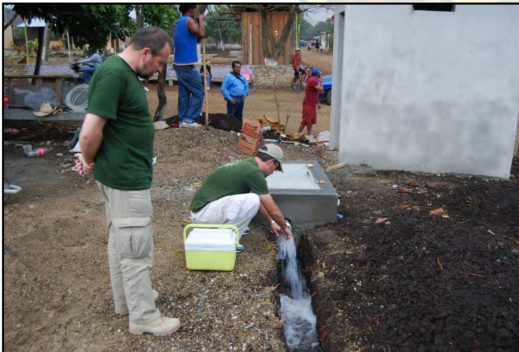
Imágenes 42, 43 y 44: Izquierda. Aspecto del agua. A falta de analizarla, su turbiedad es mínima. Derecha. Análisis físico de la muestra con la sonda Hanna. Abajo: Toma de muestra para el análisis bacteriológico con la caja de protección del pozo ya cerrada y asegurada.
