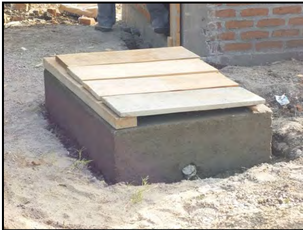
Imágenes 49 y 50: izquierda: Construcción de la caja de protección. Derecha: Caja terminada con la puerta y el pozo, a falta de conectar el tren de descarga.
