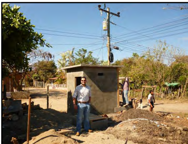
Imágenes 49 y 50: izquierda: Construcción de la caja de protección. Derecha: Caja terminada con la puerta y el pozo, a falta de conectar el tren de descarga.
