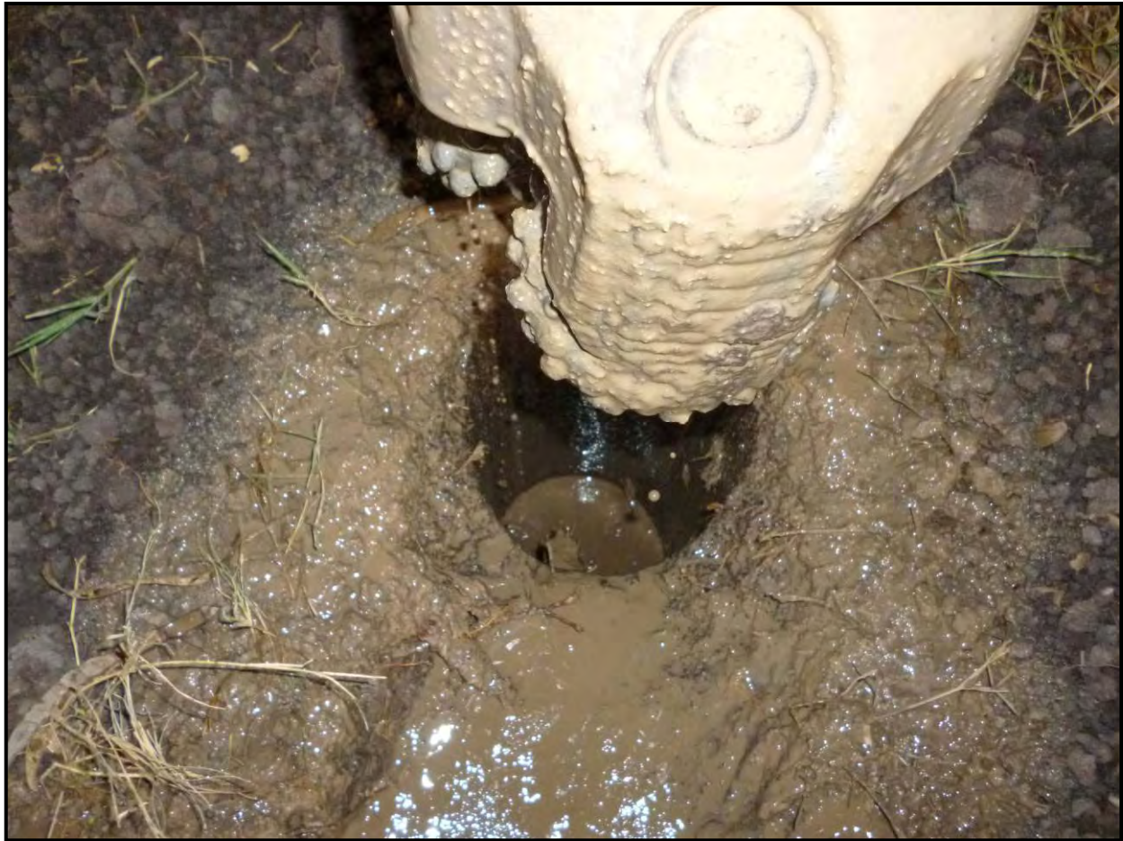
Imagen 33: Extracción del varillaje al final de la jornada.
