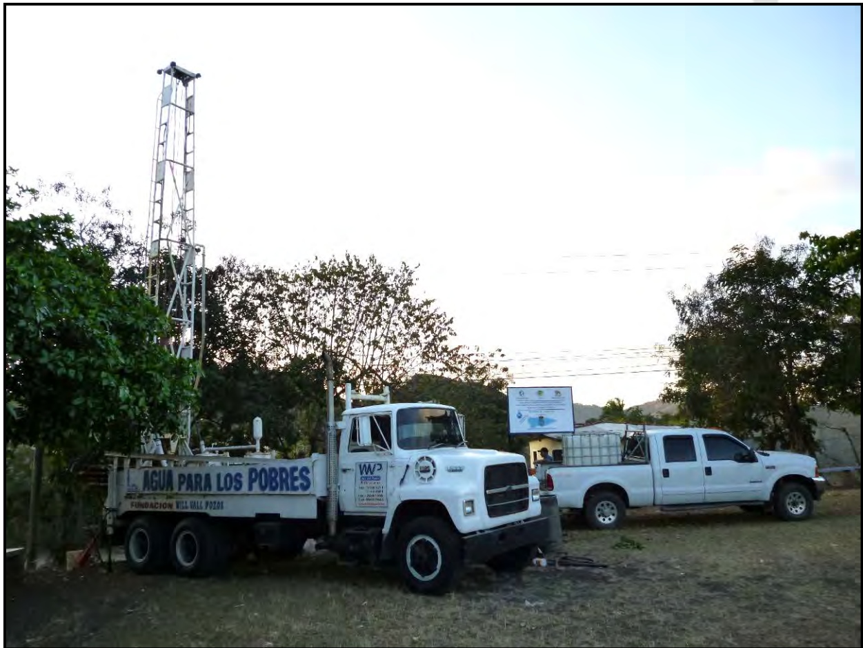
Imagen 28: Máquina perforadora de la empresa Will Vall Pozos lista para comenzar la perforación del pozo.
