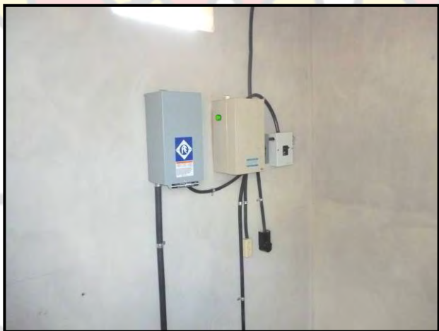
Imágenes 63 y 64: Izquierda: El técnico electricista con los accesorios de la caja de controles. Derecha: Caja de controles correctamente instalada en el interior de la caseta de protección, ya terminada.
