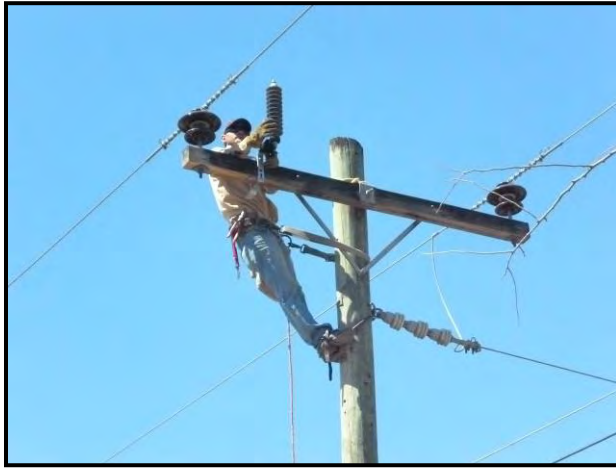
Imágenes 61 y 62: Izquierda: El técnico de la ENEE instalando el cortocircuito del transformador. Derecha: Transformador correctamente instalado listo para ser conectado.
