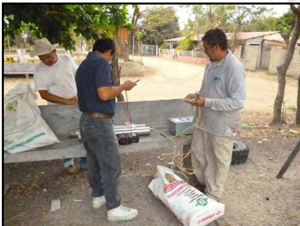
Imágenes 55 y 56: Izquierda: Los operarios de Will Vall Pozos comprueban que el equipo de bombeo y los accesorios se encuentren en condiciones para su instalación. Derecha: Acoplamiento del tren de descarga con la bomba ya instalada.
