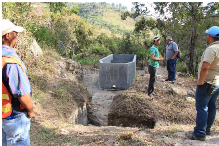
*Desarenador ya acabado de construir. A falta de hacer la instalación de fontanería para que entre en funcionamiento*
