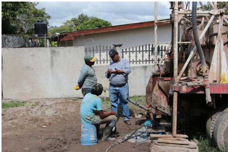
*Tomando datos durante la realización del ensayo de bombeo*
