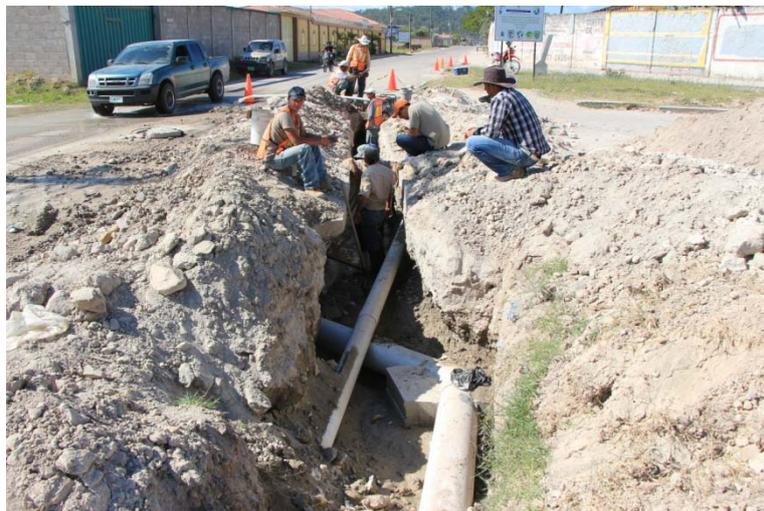
*Finalización de los trabajos de colocación de la nueva tubería*
