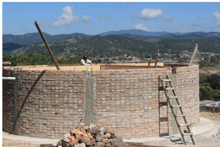
*Realización del encofrado de las vigas para la construcción de la losa superior del tanque*
