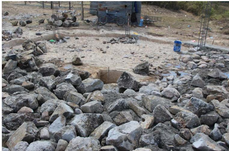
*Excavación y preparación de la base de apoyo del tanque*
