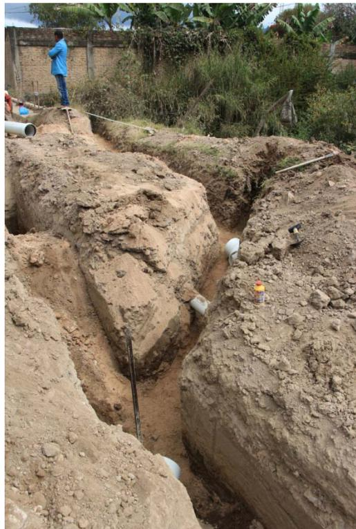
*Detalle del zanjeo para la colocación de la tubería*
