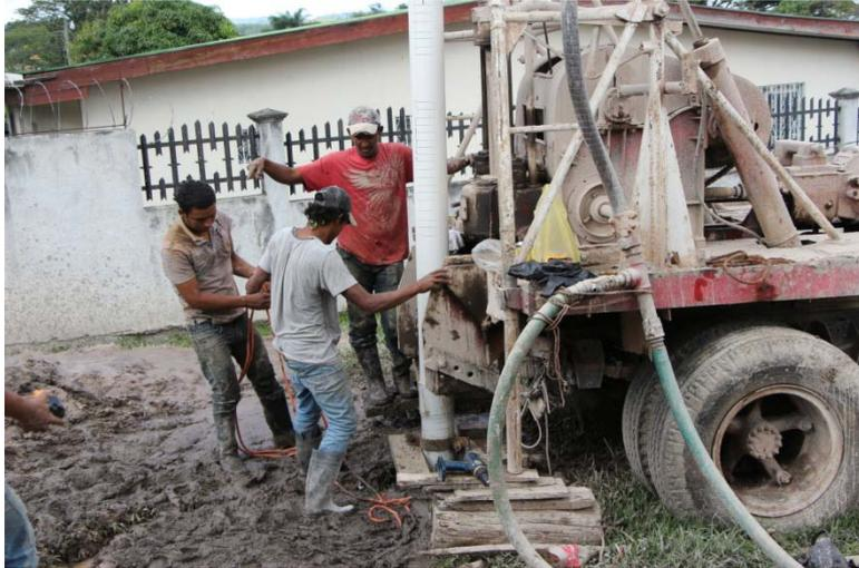
***Instalación de la tubería ranurada una vez finalizada la perforación del pozo. Con esta tubería se permite el paso del agua del acuífero al pozo para que pueda ser bombeada al exterior.***
