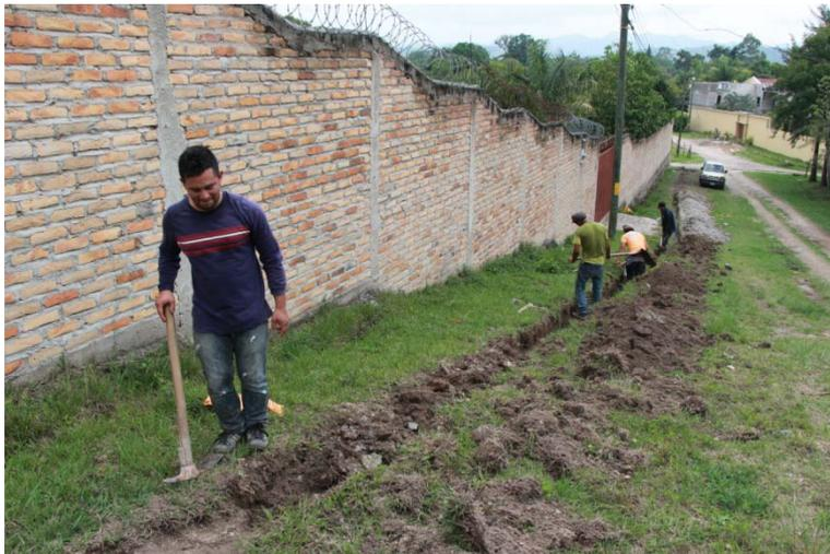
*Realización del zanjeo para instalar la tubería de impelencia del pozo al tanque*
