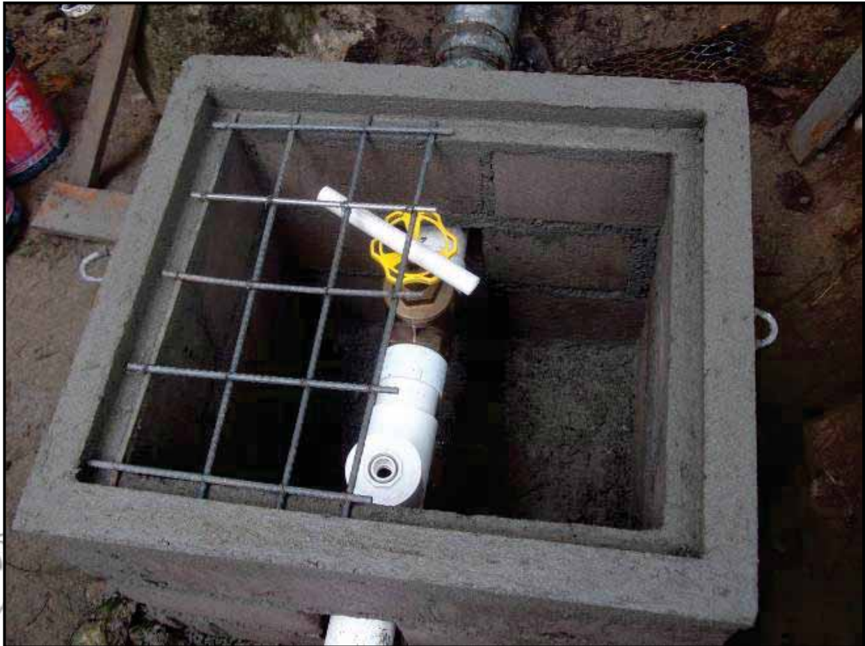
Caja válvula: Caja de protección para las válvulas de compuerta y de aire.
