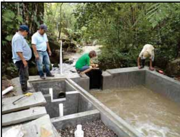
Prueba de llenado: Regulación de la compuerta y entrada del agua al filtro desarenador.
