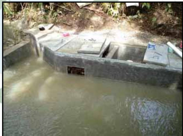
Prueba de llenado: Regulación de la compuerta y entrada del agua al filtro desarenador.
