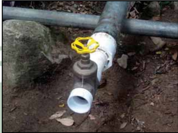
Etapas finales: Construcción del desarenador e instalación de la válvula de compuerta.
