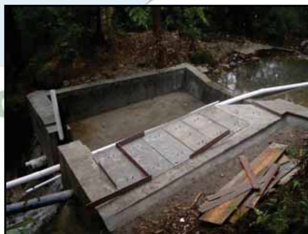
Tapaderas del desarenador: Construcción y colocación de las tapaderas.
