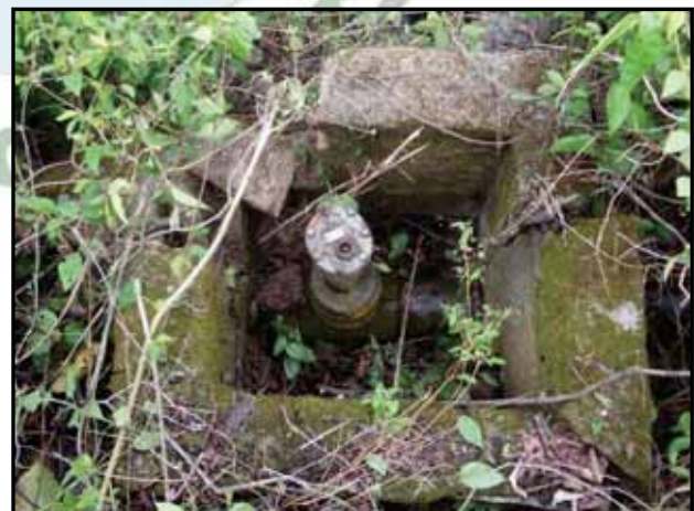
Reconocimiento del terreno: A la derecha, una válvula de aire de la tubería que pasa al lado.
