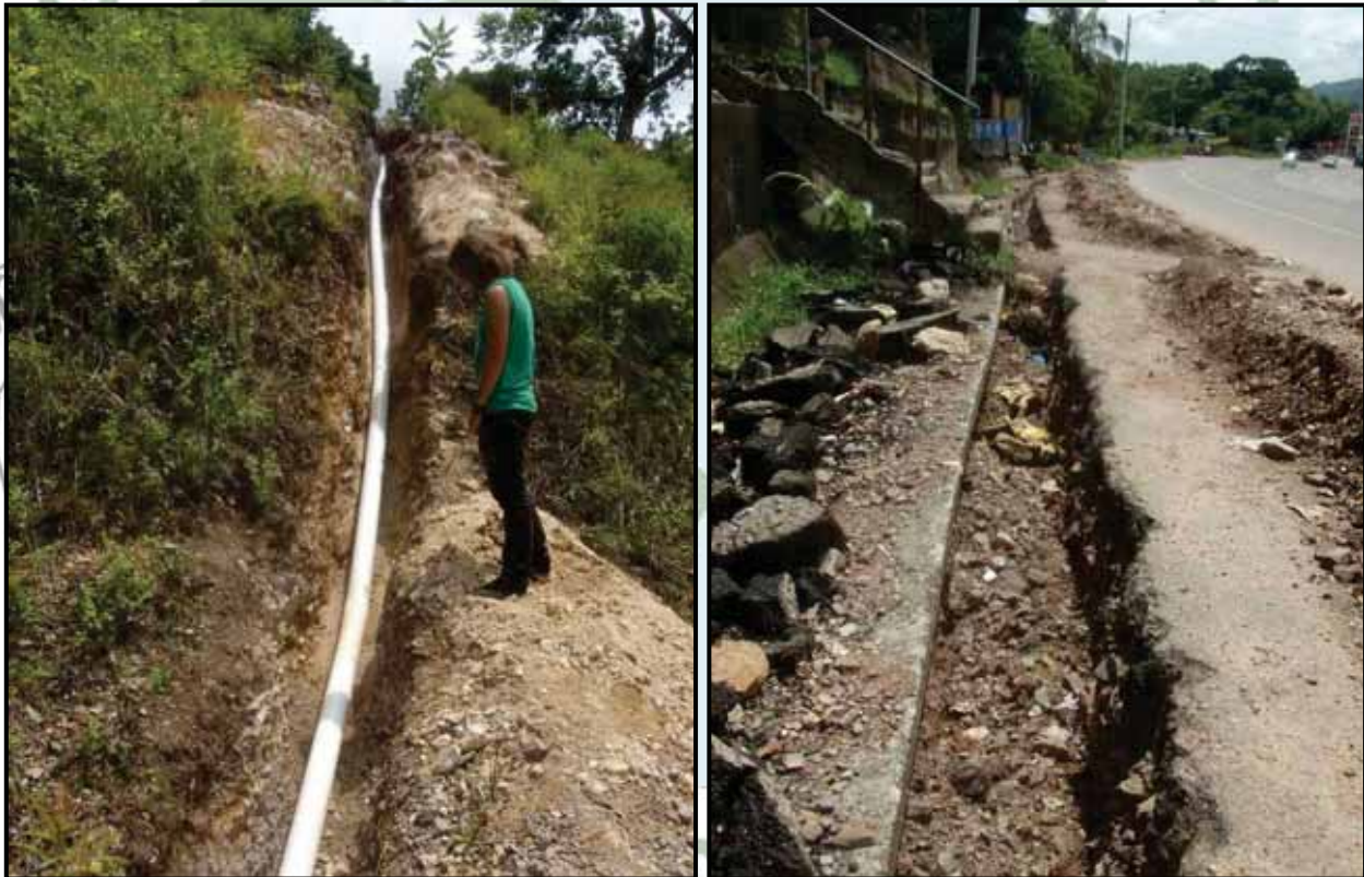
Instalación y enterrado: Tubería de 4" y enterramiento de la misma.
