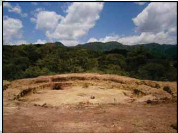
Excavación de los pozos de cimentación y corta de construcción.
