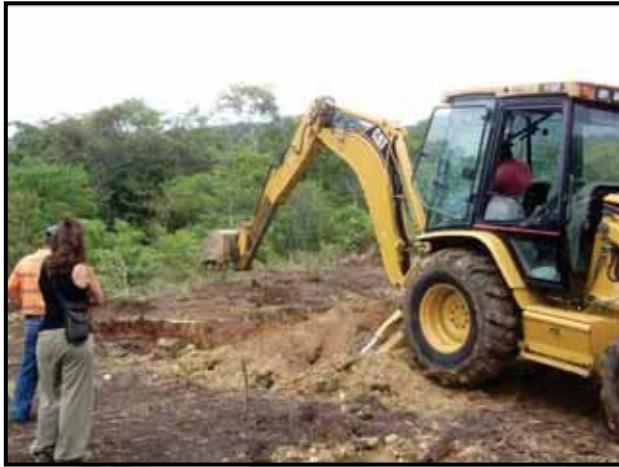
Excavación de los pozos de cimentación y corta de construcción.
