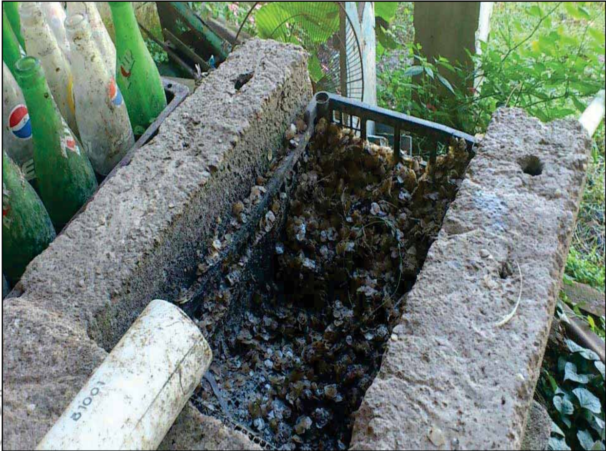
Caja filtrante. Aspecto de una caja de retención de sólidos que había en uno de los restaurantes.
