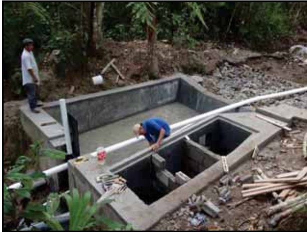
Etapas finales: Construcción del desarenador e instalación de la válvula de compuerta.
