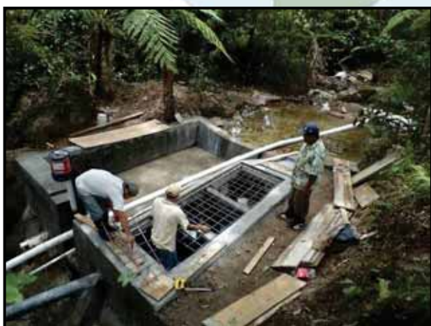
Tapaderas del desarenador: Construcción y colocación de las tapaderas.
