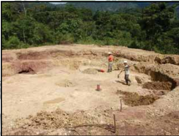
Pozos de cimentación y corta ya excavados.
