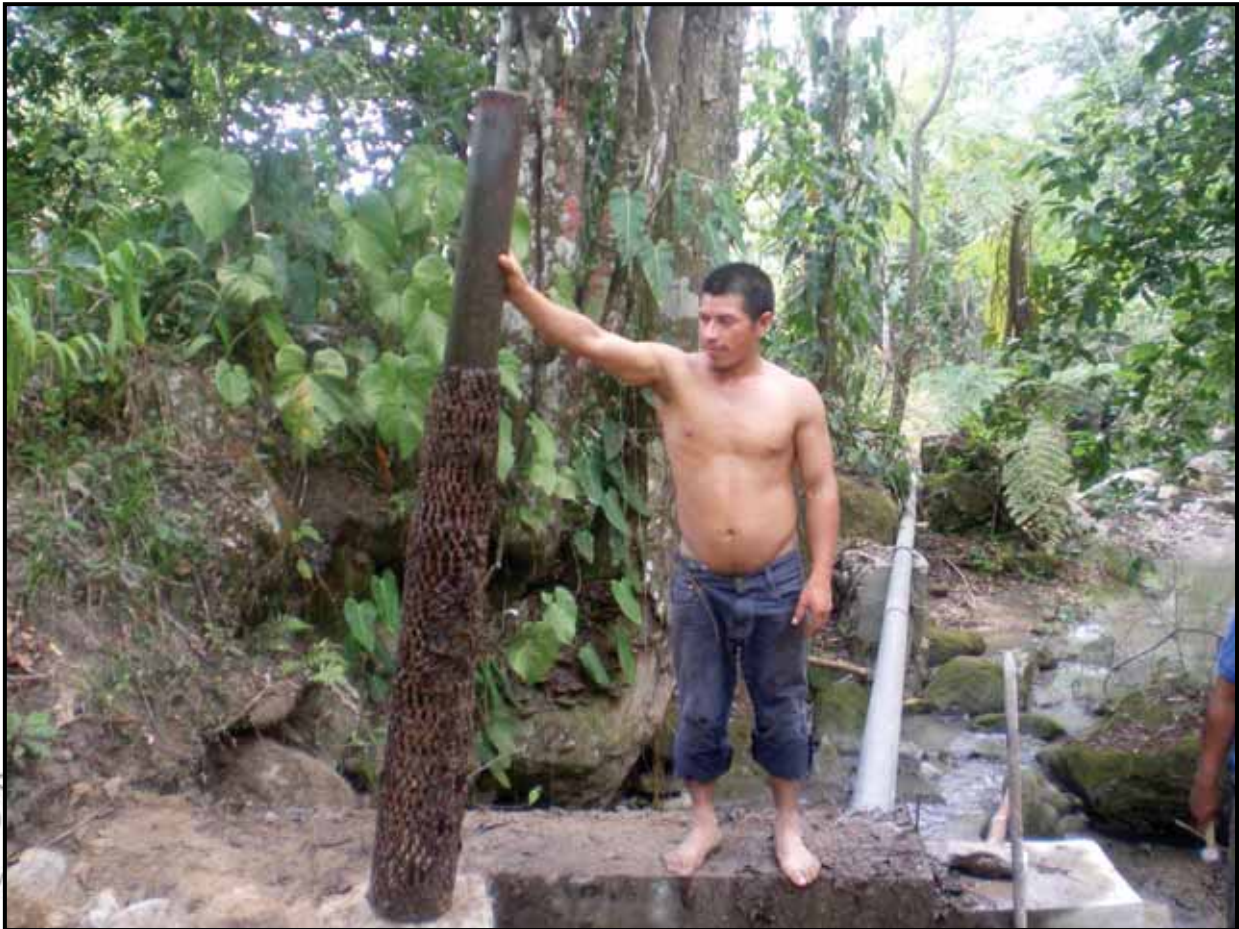
Filtro de la tubería de salida: Oxidado, roto y lleno de sedimentos.
