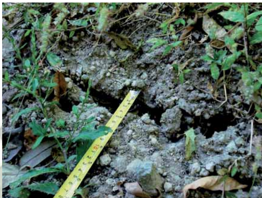
Fig. 47. Detalle de las grietas observadas.
