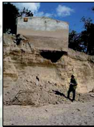
Fig. 21. Imagen donde se aprecia la diferencia entre la cota previa y la actual en el río.
