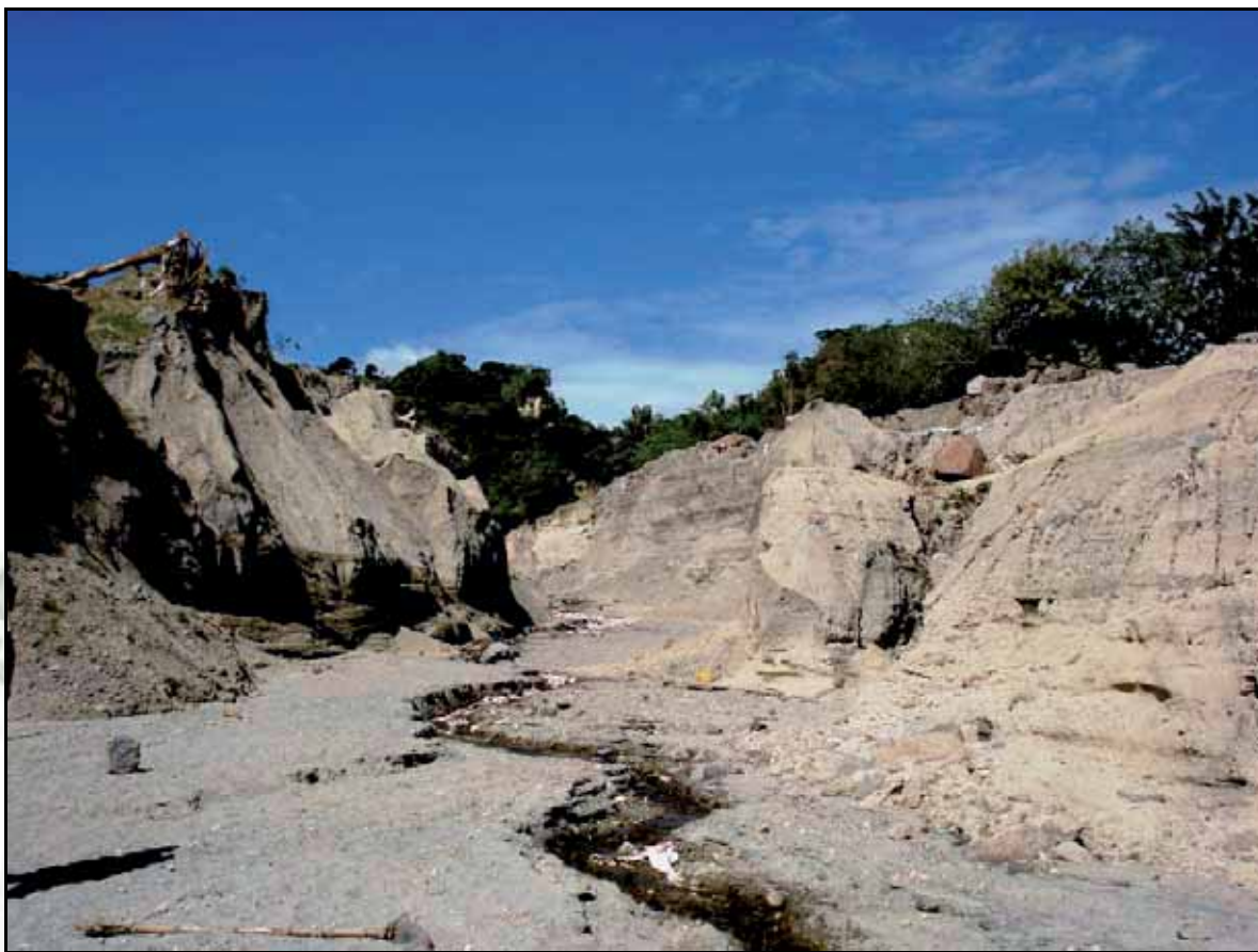
Fig. 40. Quebrada principal de la zona del Club Corinto. Véase la erosión producida por la corriente. Y el caudal normal que fluye en ese punto.
