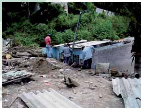
Fig. 15. Vivienda sepultada por el flujo de material. El nivel en el interior de la casa alcanzó los 2 m. (GPS 063)
