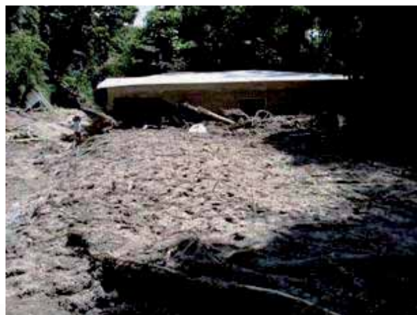
Fig. 24. Casa muy afectada, pero no habitada en el momento del evento. (GPS 071)
