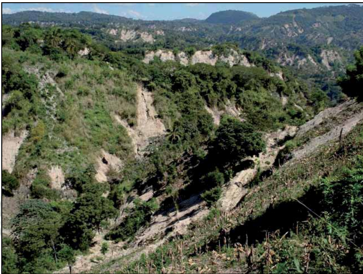
Fig. 17. Vista de la parte media de la cuenca de San Agustín., donde se observan gran cantidad de deslaves.
