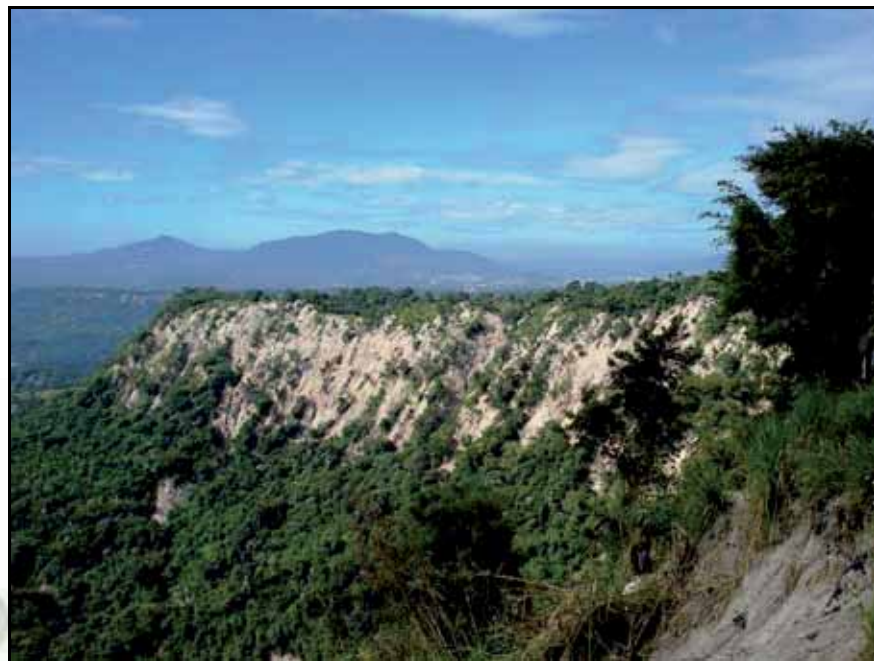
Fig. 45. Vista del escarpe desde el Cantón La Palma. Se observa una primera zona casi vertical de aproximadamente 100 metros de caída.
