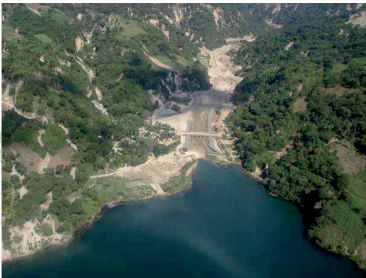
Fig. 39. Vista aérea del desagüe del Lago Ilopango completamente azolvada.
