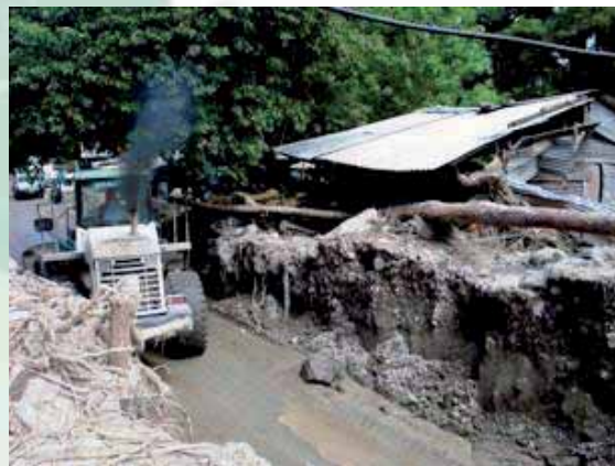
Fig. 38. Maquinaria abriendo paso en la calle principal de Apulo y viviendas afectadas.
