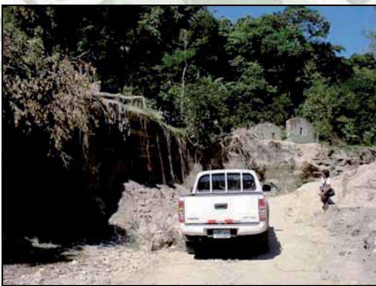
Fig. 15. Erosión sufrida por la quebrada.
