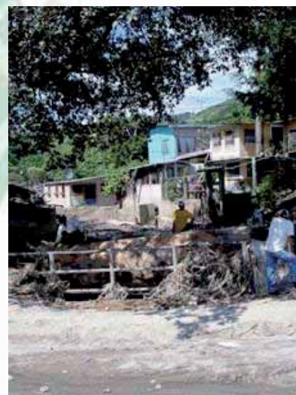
Fig. 28. Gran tronco atravesado en un puente en Apulo.
