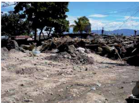
Fig. 29. Puente soterrado debajo de los materiales arrastrados.
