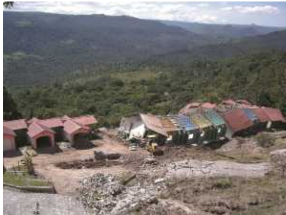
Deslizamiento en la carretera a Danlí. Honduras
