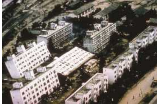
Licuefacción. Niigata, Japón
