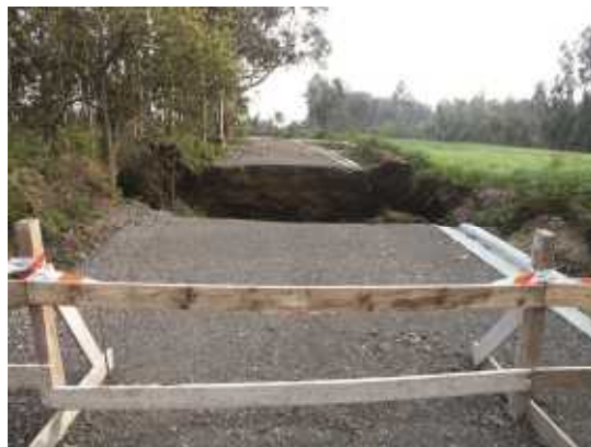
Subsidencia minera en Gozón, Asturias
