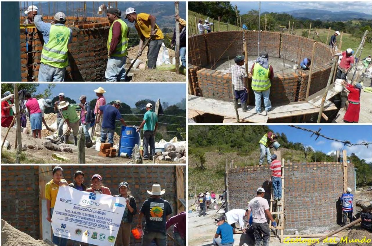
El avance de las paredes hace que en determinado momento se tenga que utilizar andamiaje. Una vez levantadas las paredes de ladrillo, se funden los pilares perimetrales cerrando así los paramentos verticales..
