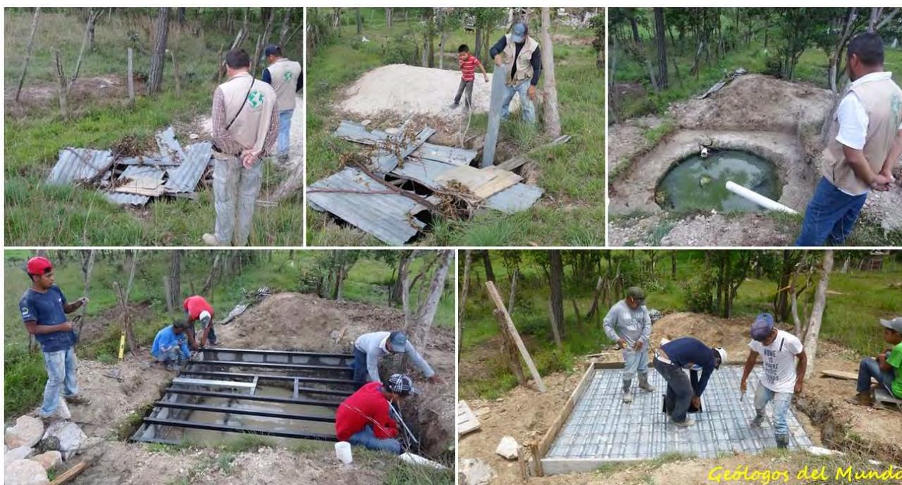
Cerrado de la fosa de líquidos mediante losa con tapa de inspección. Con ello se gana en salubridad del entorno y en seguridad para los niños/as y mayores
