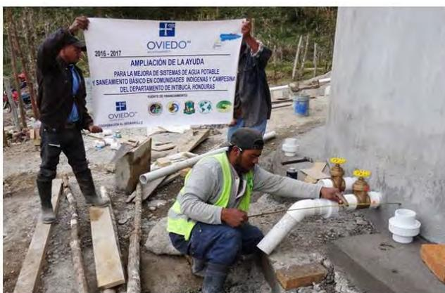
Conexión de entrada de 3" con válvula; en la estrada se realiza una conexión de 1/2 " para la entrada al hipoclorador. Foto Dcha. instalación de dos salidas de 3" con sus válvulas.
