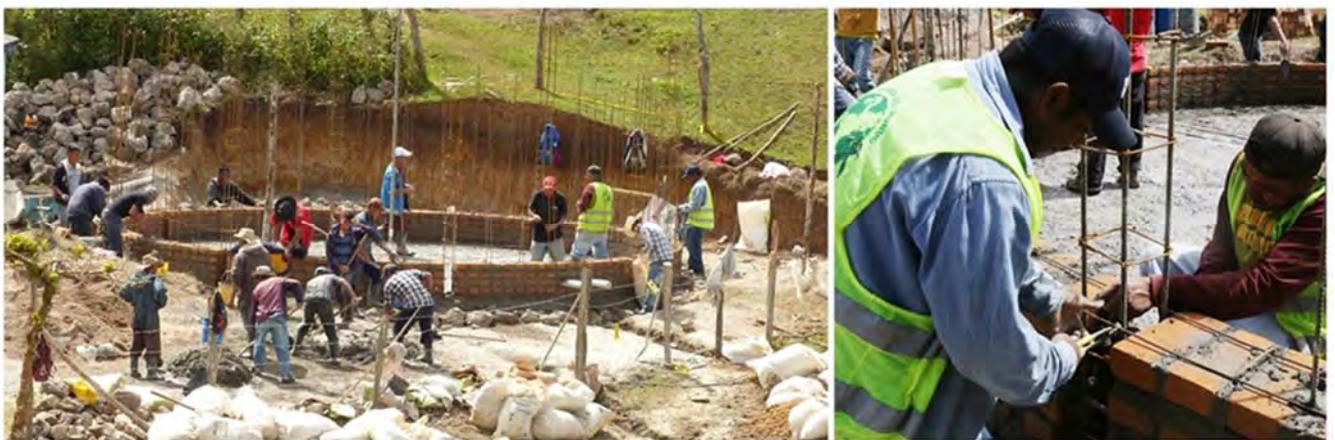
En la foto de la derecha colocando anillos de varilla de hierro para el armado perimetral de las paredes. Estos anillos dobles se disponen cada dos hiladas de ladrillo.
