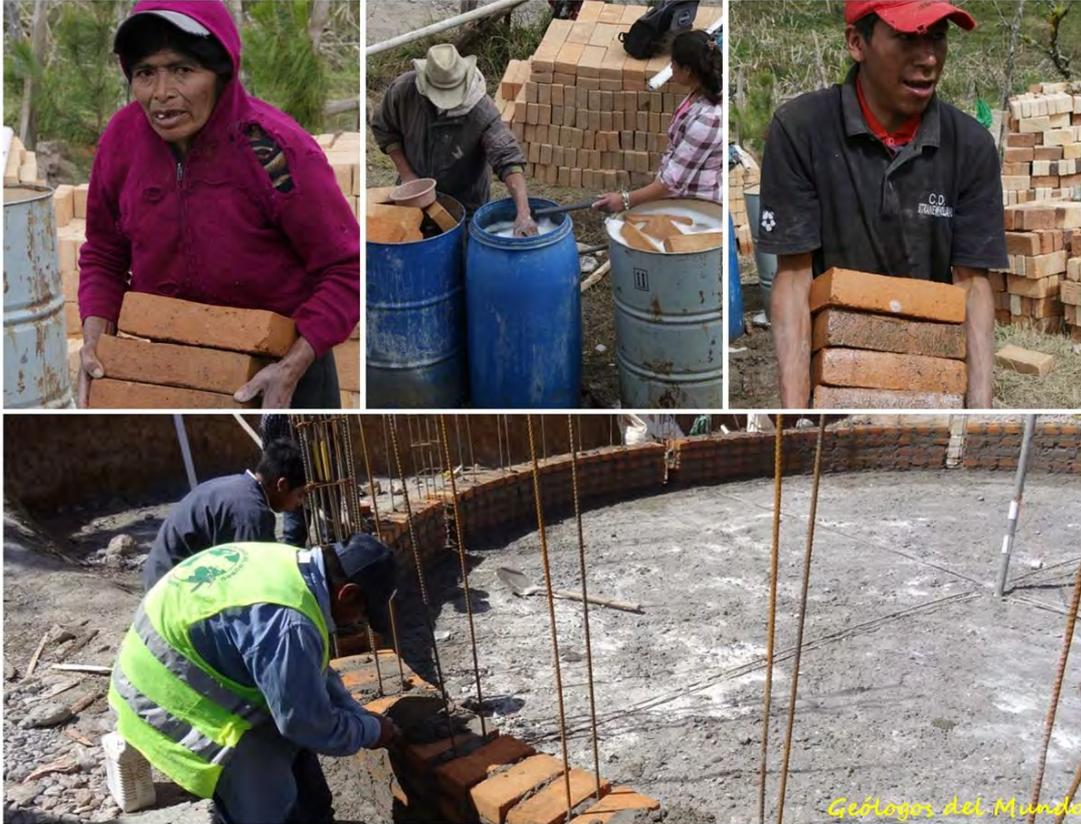
Levantando las paredes con ladrillo rafón dispuesto al tesón. Se observan los bastones de armado. Los ladrillos se sumergen en agua con un aditivo impermeabilizante para minimizar la absorción de agua de las paredes; este aditivo también se añade a la mezcla de cemento y arena con la que se pegan.
