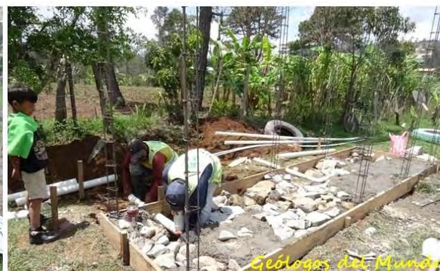
Se aprovecha la cimentación para soterrar las instalaciones de tubería de los sanitarios.
