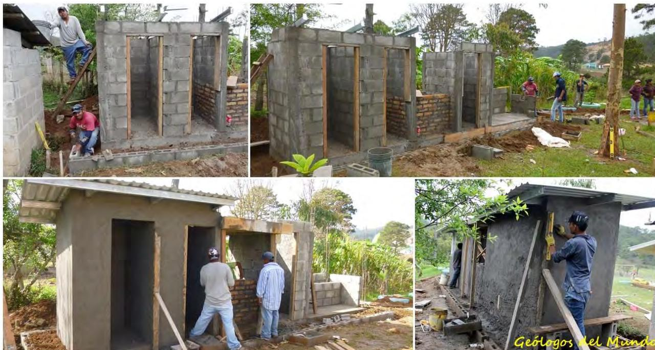
Levantando las paredes, techado y acabado con revoque y enlucido.
