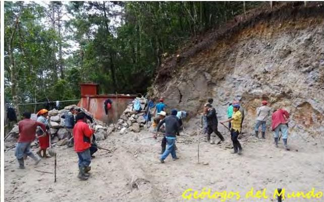
Rasante de excavación de nivelación una vez alcanzada la roca del sustrato. A partir de aquí se realizará la excavación para la cimentación.
