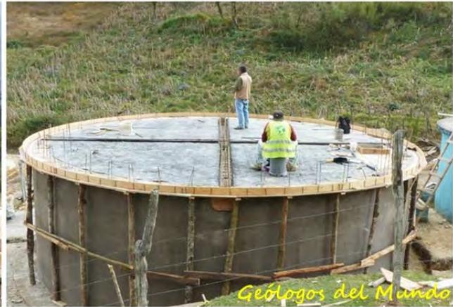
Colocación del plástico sobre en encofrado para cubrir las imperfecciones de la madera.
