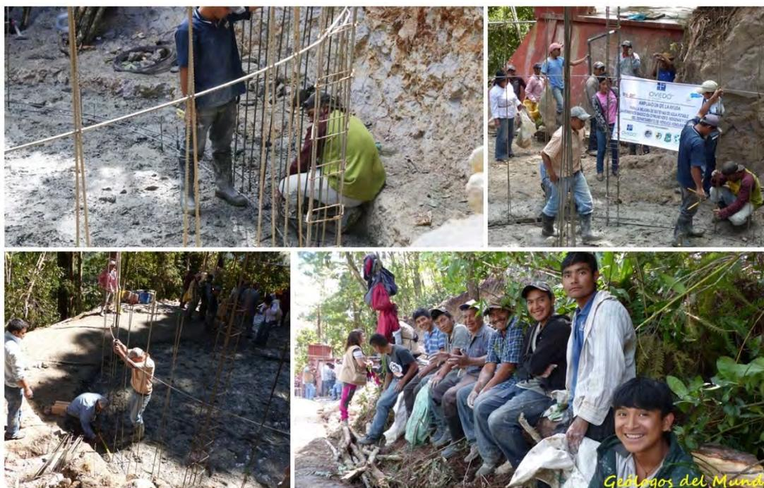
Junto al armado de la losa se disponen solidarias con él, varillas de hierro verticales que formarán parte del armado de las paredes.
