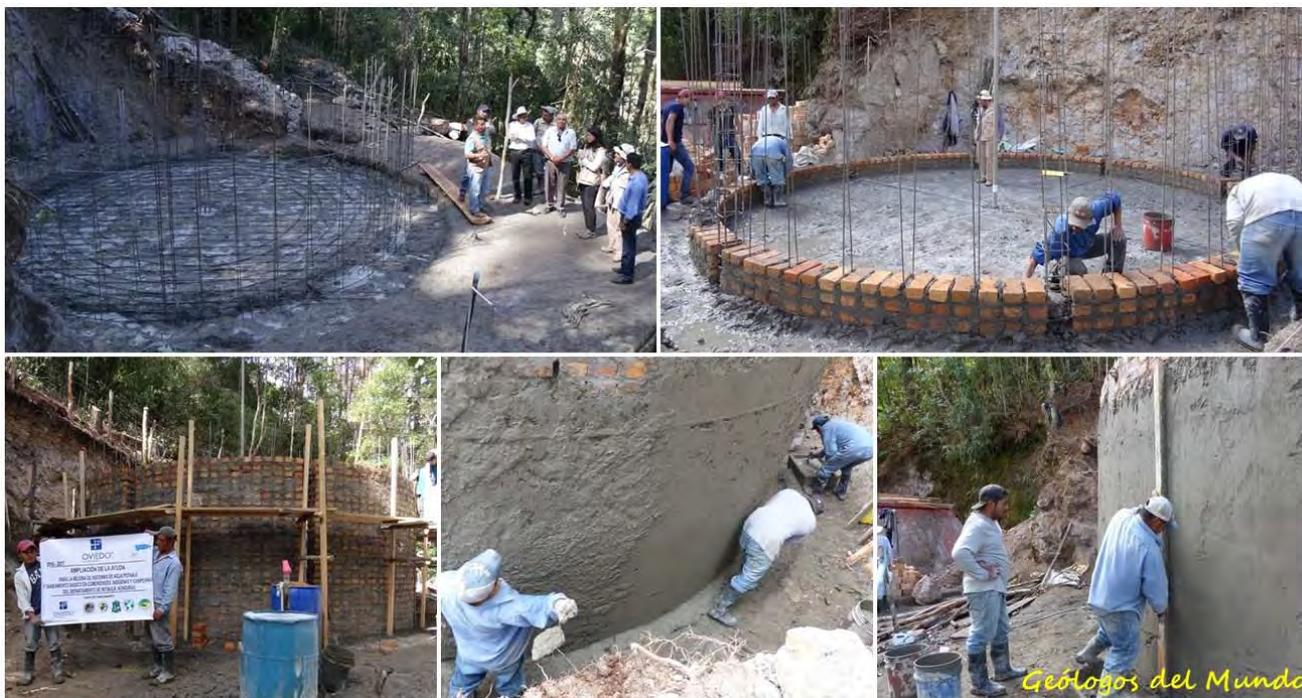
Posterior al armado de la losa, y al armado de los pilares, se comenzó a construir las paredes y su posterior acabado mediante revoque y enlucido.
