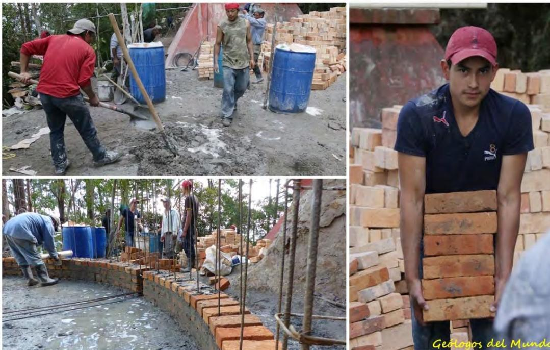
Construyendo las paredes. Se observa el tipo de ladrillo y el armado de hierro. Todas las mezclas de cemento y hormigón son realizadas a mano.
