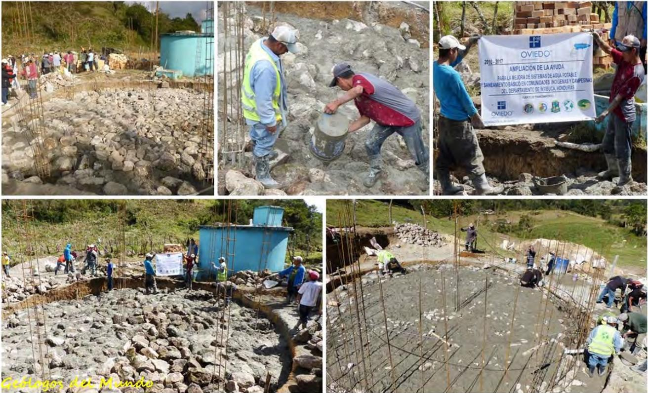
Ejecutando la losa armada de reparto. En la foto inferior derecha se pueden ver ya los colocados los bastones verticales para el armado de las paredes.
