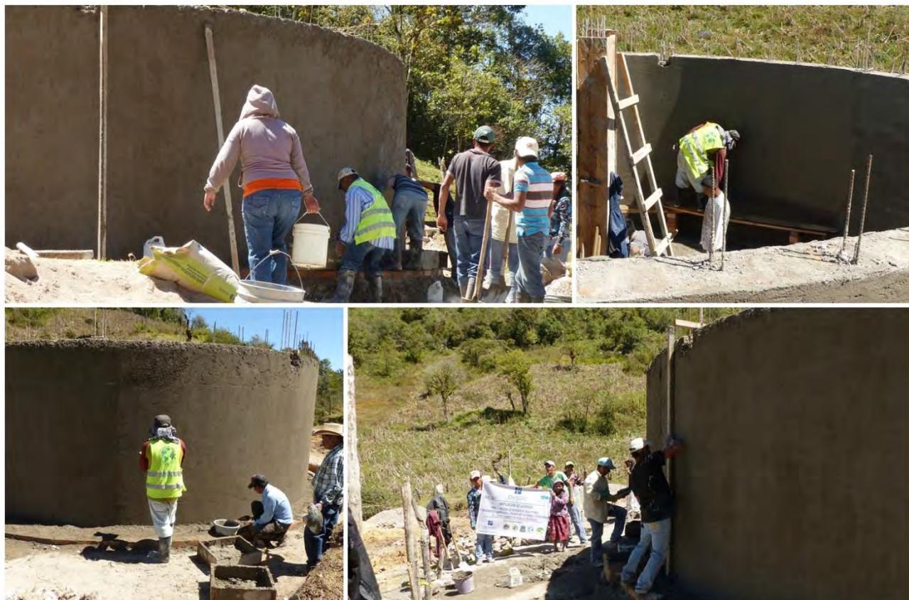
La finalización de la etapa de ejecución de los paramentos verticales finaliza con el revoque o repello y pulido de estas. Se cubren los ladrillos, tanto por el exterior como el interior del depósito, con una mezcla de cemento y arena para refuerzo de las paredes e impermeabilización.
