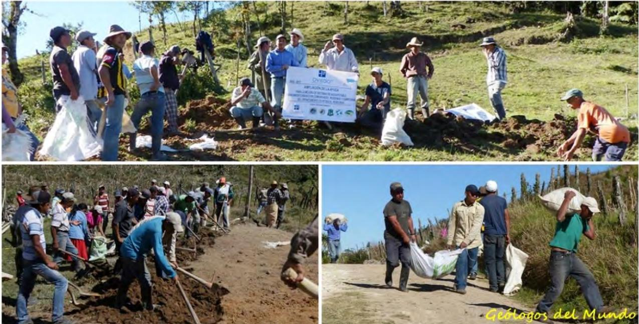
La excavación se realiza de manera totalmente manual al igual que el transporte del material excavado.
