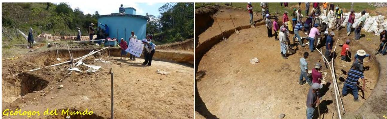
Modificación de trazado de la tubería de distribución en el entorno de la excavación.
