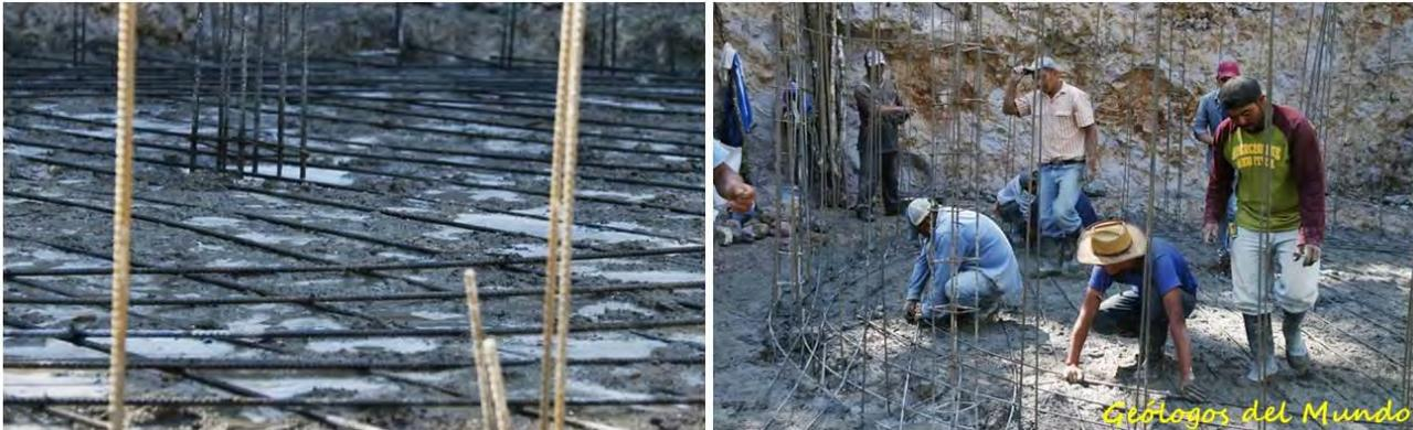
Colocación del armado de la losa. En la foto de la izquierda se observan las varillas verticales (bastones) ya instalados. Una vez recubierto el armado de la losa con hormigón en masa, se comienza la siguiente fase.
