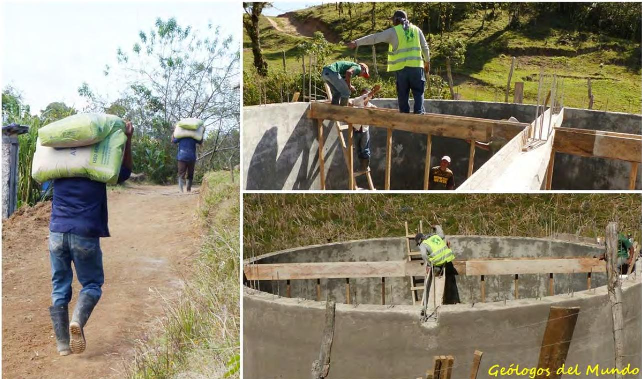
Encofrado de las vigas con tabla de madera. En la foto inferior derecha se puede ver como las cabezas de las vigas se apoyan sobre los pilares perimetrales para que la carga de la losa descargue en su mayor parte sobre ellos y no sobre las paredes..
