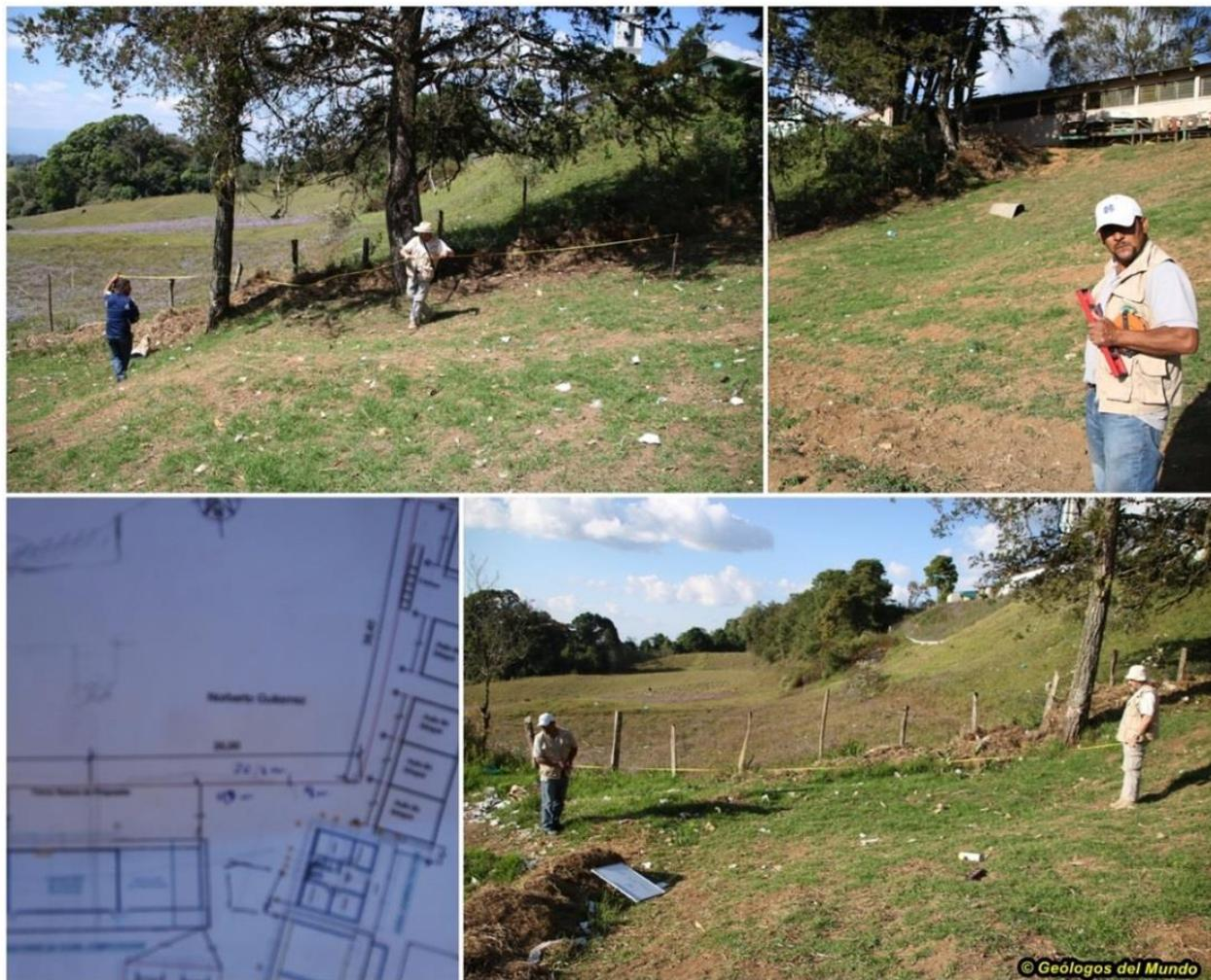
Replanteo en el terreno de las obras y toma de medidas previas al inicio de las excavaciones.
