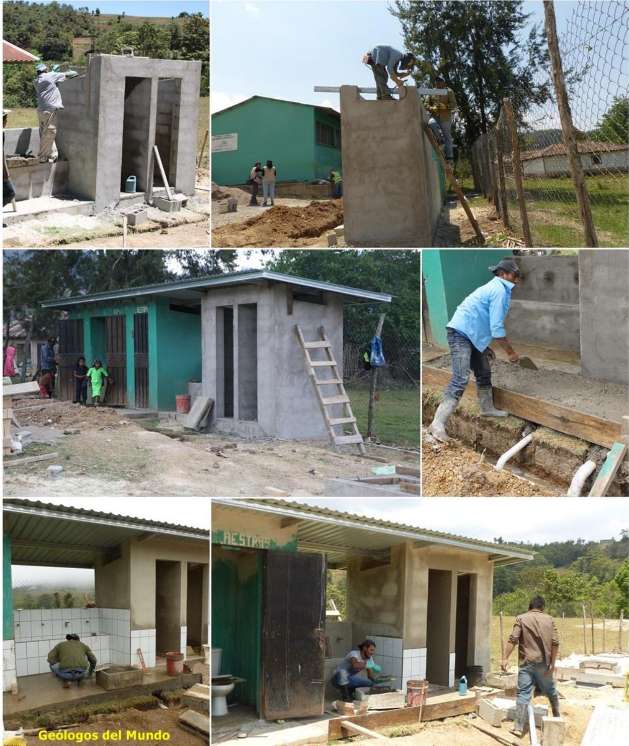
Fases de repello y pulido de los módulos, colocación del techado, construcción de la acera y colocación de la cerámica en las partes interiores y exteriores de los módulos sanitarios.
