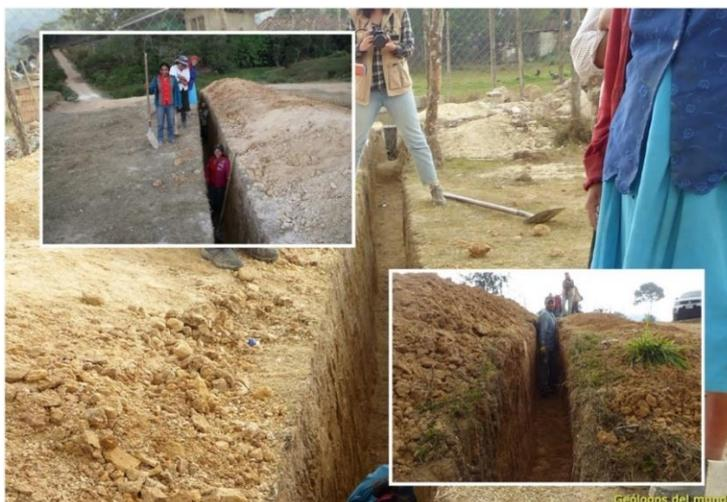
*Excavación de la zanja de desagüe de la fosa séptica. Excavación manual por parte de la comunidad de El Ciprés.*
