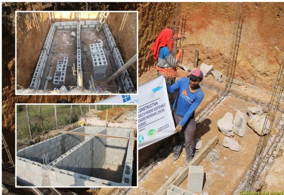
*Cimentación de la fosa, levantamiento de muros verticales y fundido de los castillos de armado de los muros perimetrales.*
