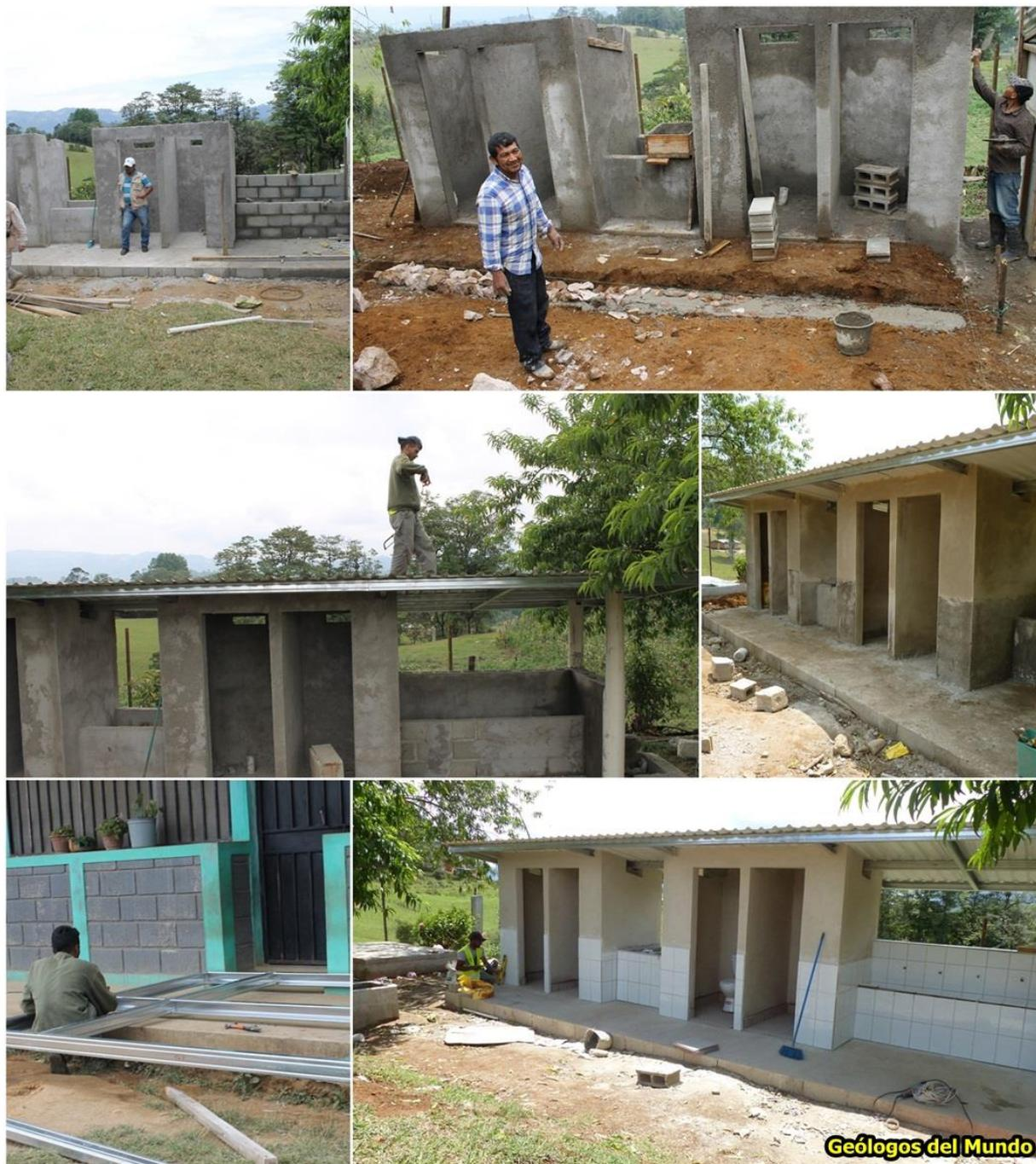
Fases de repello, pulido y colocación de la cerámica. Construcción del techado y colocación del mismo. Construcción de la acera de acceso.
