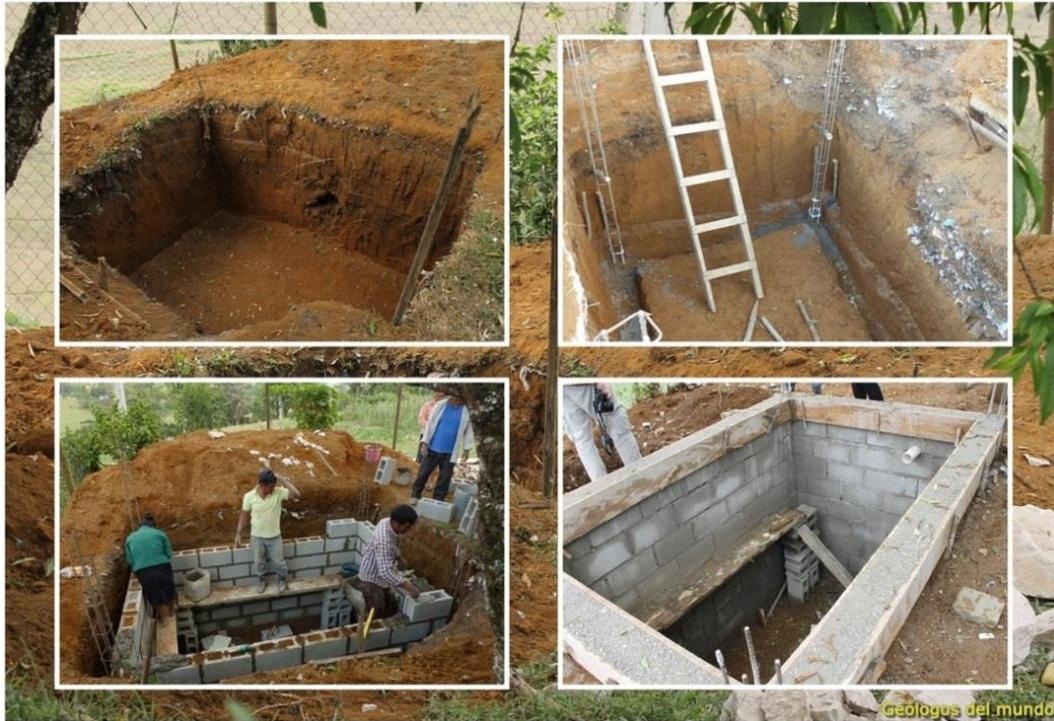
*Excavación, cimentación de muros y armado, construcción de paramentos verticales y soporte para la losa superior.*
