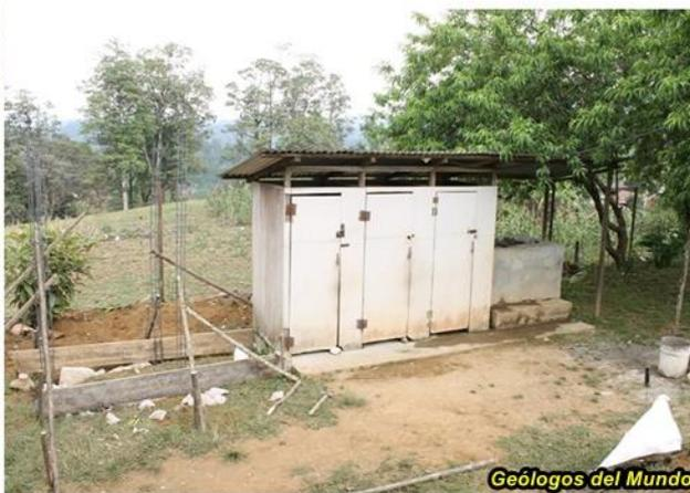
*Replanteo de la ubicación de los módulos. Para que los niños/as sigan disponiendo de los servicios mientras se ejecuta la obra, En la demolición se deja uno de los módulos y la pila operativos y se va construyendo al lado. Finalmente, ese módulo y pila serán sustituidos por el lavamanos.*
