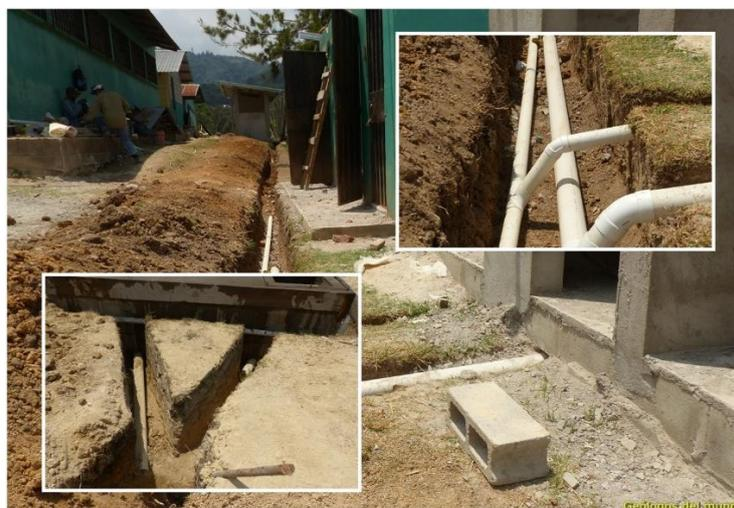
*Conexiones finales entre los módulos sanitarios y la fosa séptica. Colocación de conexiones finales de salida de la fosa y respiraderos de las cámaras sépticas. Una vez terminadas las conexiones se procede al tapado de las zanjas.*
