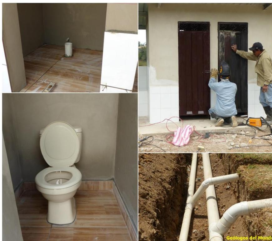
*Instalación de puertas, sanitarios y conexiones finales de fontanería necesarias para el funcionamiento de las instalaciones.*
