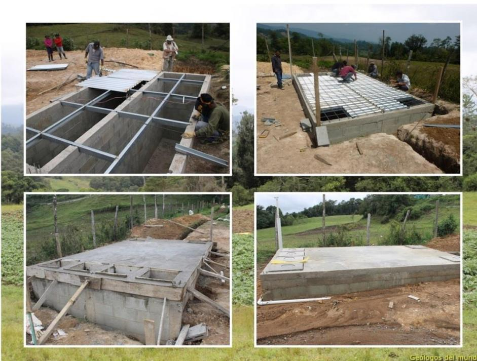
*Encofrado, colocación del emparillado y fundido de la losa. Construcción de tapaderas. El emparillado de armado de la losa superior se construye con varilla de hierro de 3/8" Una vez fundido se deja fraguar el tiempo necesario para que el hormigón alcance una resistencia adecuada*
