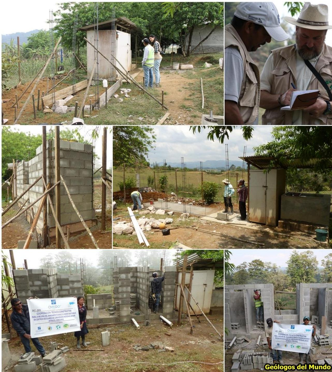
Replanteo en el terreno. Limpieza y acopio de material. Excavación y construcción de la cimentación. Colocación de los castillos de armado de los pilares. Levantamiento de paramentos verticales. Fundido de los castillos de armado de la estructura.
