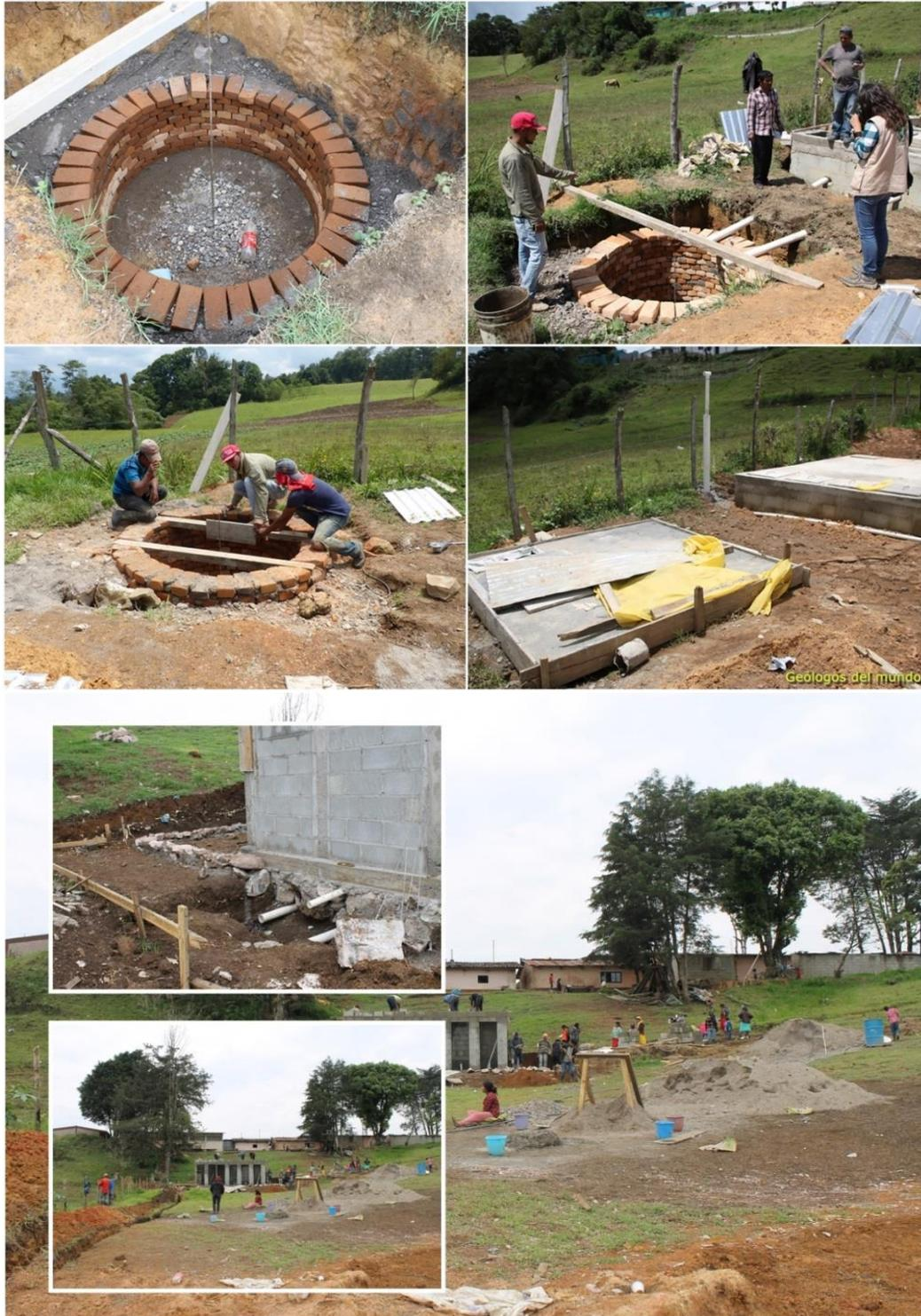
*Construcción del pozo de absorción conectado con la fosa séptica. Excavación de la zanja de desagüe de los módulos sanitarios, lavamanos y pila hacia la fosa séptica*
