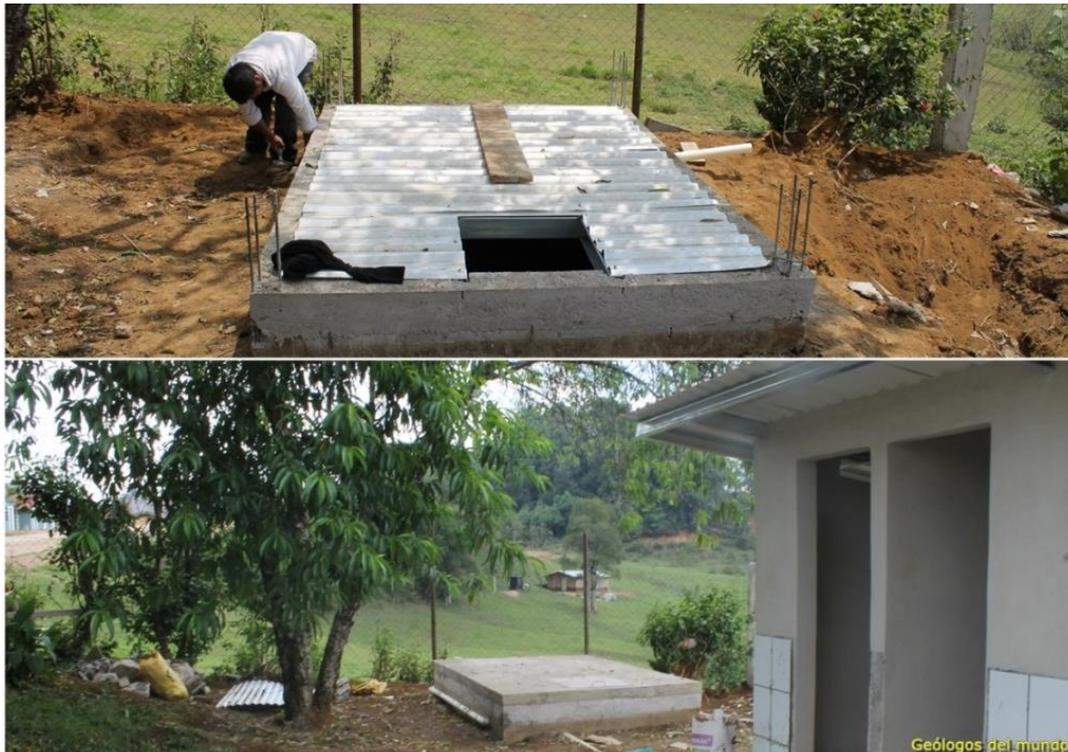
*Se observa la colocación del encofrado para el fundido de la losa, la losa ya fundida y la tapadera de inspección.*
