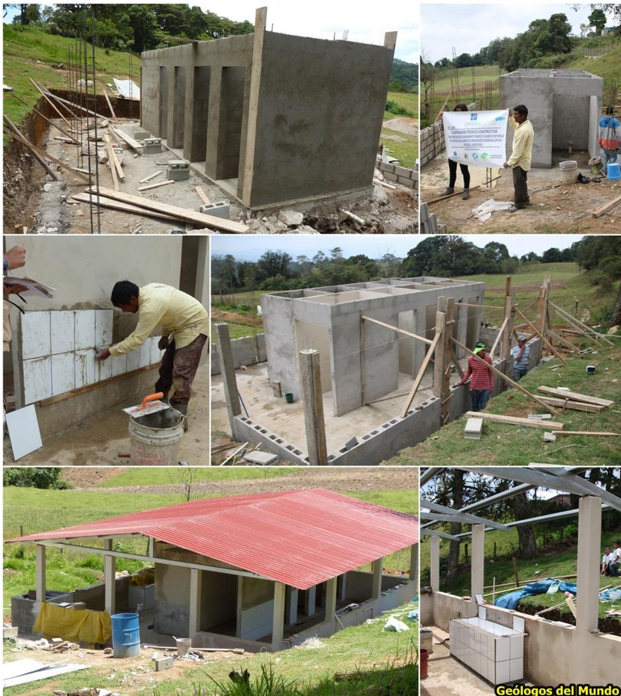
Fases de repello y pulido de los módulos. Construcción de la cimentación y el muro perimetral de cierre. Colocación del techado y la cerámica. En la foto inferior derecha se puede ver uno de los lavamanos.
