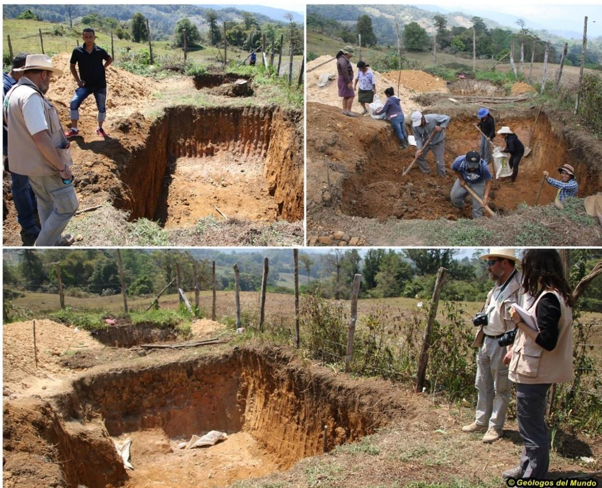
*Excavación de la fosa séptica que se realiza en un primer momento con una retroexcavadora y posteriormente a mano por gentes de la comunidad quienes realizan la nivelación final del terreno.*
