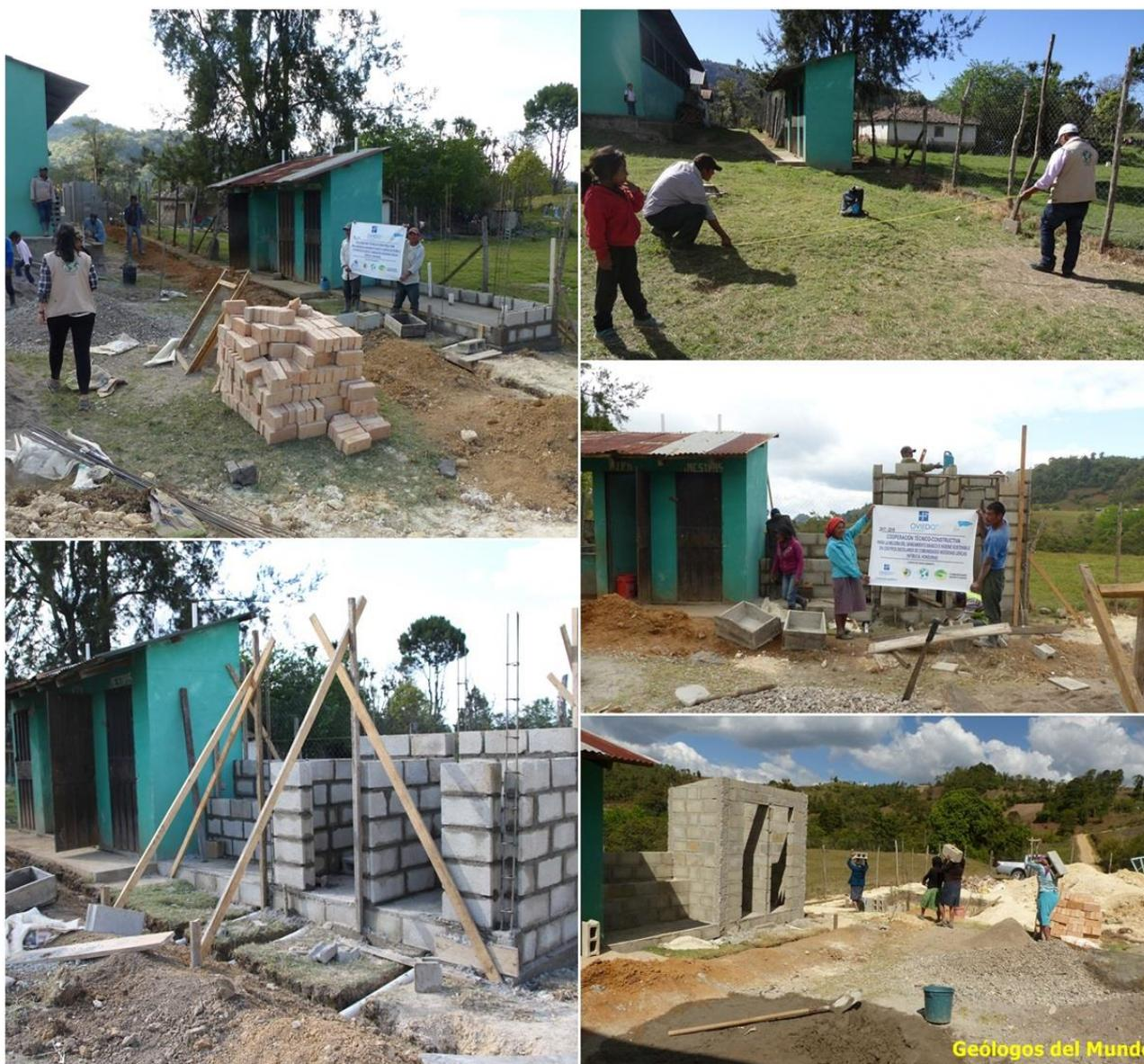
Mediciones en el terreno. Acarreo y acopio de material. Cimentación, construcción de la solera e instalación de las primeras conexiones de fontanería. Levantamiento de paramentos verticales, encofrado y fundido de los pilares de la estructura.
