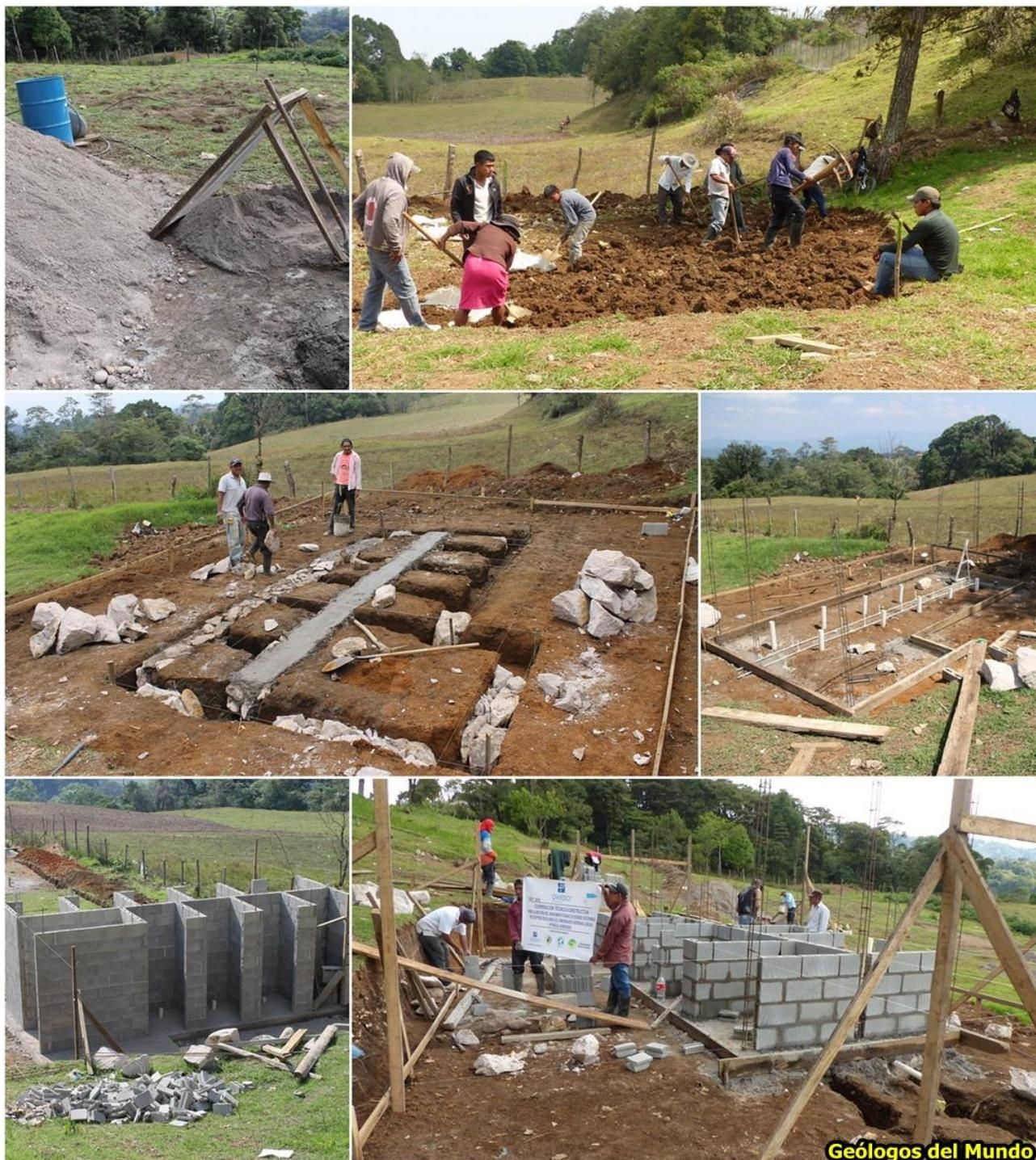
*Limpieza, nivelación y excavación manual en el terreno. Construcción de la cimentación, instalación de las conexiones de fontanería y levantamiento de paramentos verticales. Fundido de los pilares de armado de la estructura.*
