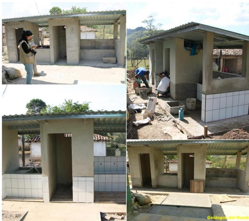
*Detalles del repello y pulido de los módulos sanitarios. Se observa también la construcción de la acera y escaleras de acceso y la colocación de la cerámica y el techado del complejo sanitario.*
