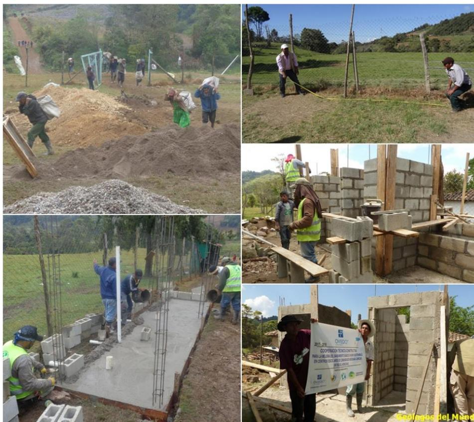
Cimentación de la estructura mediante pilares con zapatas aisladas y losa continua. Se observa también la colocación de los castillos de armado de la estructura. Levantamiento de paramentos verticales mediante bloques de hormigón y fundido de castillos.
