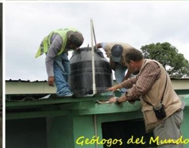
Obras ya terminadas. Se instaló un sistema autónomo de agua mediante un pequeño depósito tipo “rotoplas” en el techo de los módulos que, mediante válvulas anti retorno, permite su llenado automático desde la red y dar servicio de agua continuo a equipamiento del Centro que lo requieren, como nebulizadores, lavamanos y los propios sanitarios. Igualmente se instaló un lavamanos en el interior del Centro.
