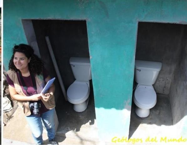
Tazas sanitarias hidráulicas ya instaladas y la nueva techumbre. A falta de repello interior, colocación de puertas y pintado.
