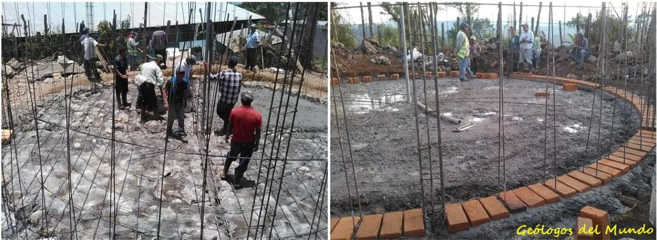
Losa armada de reparto. A la izquierda colocando ya el armado de hierro de la parte superior de la losa. Con la última capa de compresión se deja embebida una hilada de ladrillo perdido que servirá como arranque de las paredes. En Ambas se observan el armado de los pilares y varillas dobles verticales del armado vertical de las paredes.
