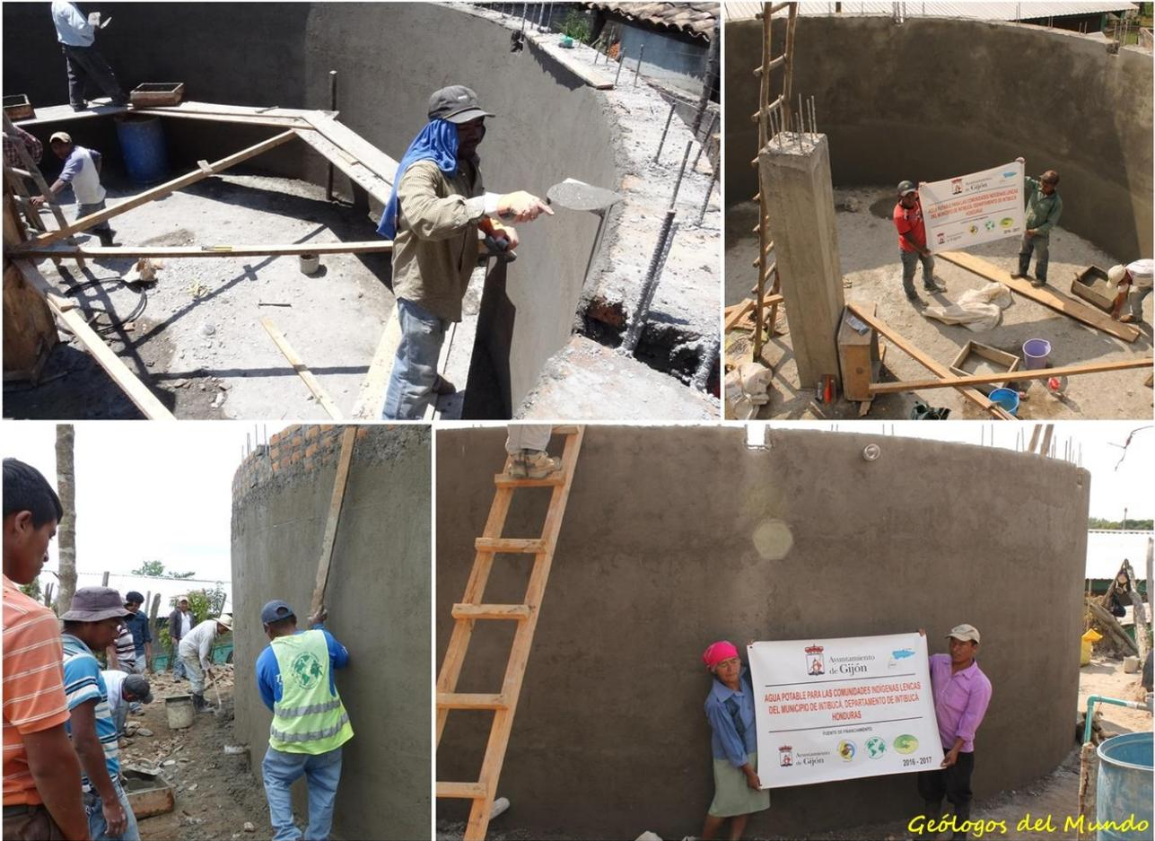
La finalización de la etapa de ejecución de los paramentos verticales finaliza con el revoque o repello y pulido de estas. Se cubren los ladrillos, tanto por el exterior como el interior del depósito, con una mezcla de cemento y arena para refuerzo de las paredes e impermeabilización.
