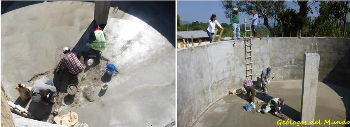
Ejecución del piso del interior del depósito. Se realiza con una pequeña pendiente hacia lo que será el tubo de limpieza y reboso.
