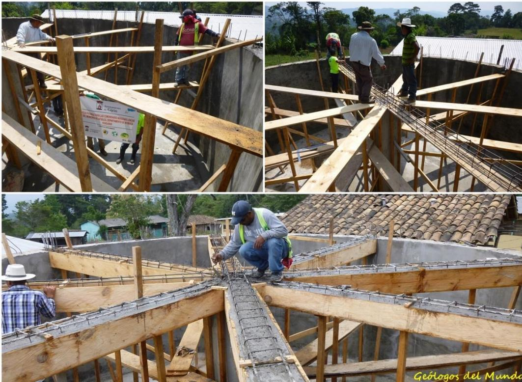
Encofrado de las vigas con tabla de madera., se observa también la colocación del hierro del armado de las vigas y las vigas ya fundidas a las que se les deja una parte del armado sin cubrir para que sirva de enlace con la losa superior cuando se funda.
