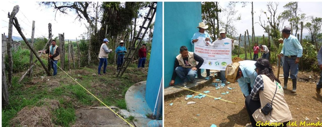
Mediciones del terreno para el plantel del tanque de 32.000 galones (121, 13 m<sup>3</sup>). Para encajarlo y añadiendo una pequeña acera perimetral de servicio se necesitaba mínimamente una superficie circular de 5 metros de radio.
