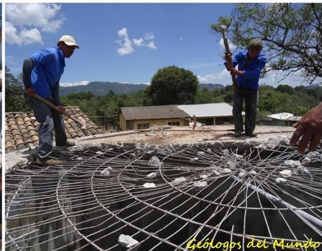
Demolición de la losa superior. El entramado de hierro fue sirviendo de estructura resistente cortándose al finalizar.
