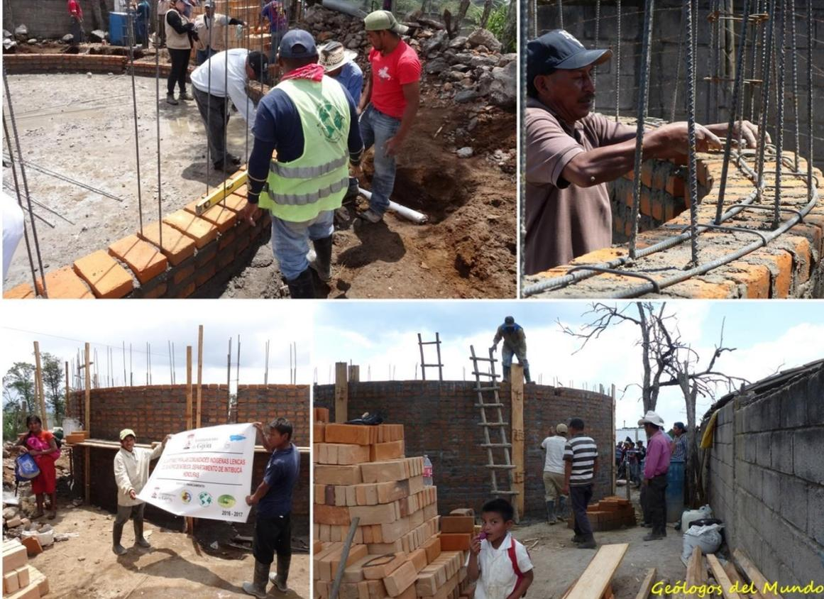
Levantando las paredes con ladrillo rafón dispuesto al tesón. Se observan los bastones de armado. Los ladrillos se sumergen en agua con un aditivo impermeabilizante para minimizar la absorción de agua de las paredes; este aditivo también se añade a la mezcla de cemento y arena con la que se pegan.
