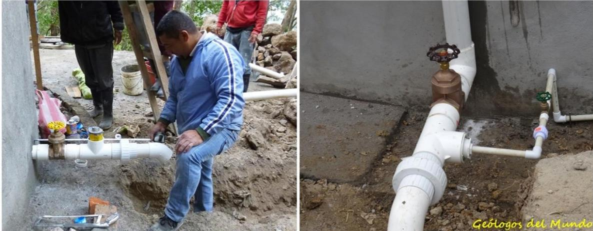
Conexiones de entrada y salida. En la estrada se realiza una conexión de ½ “ para la derivación de agua al hipoclorador.
