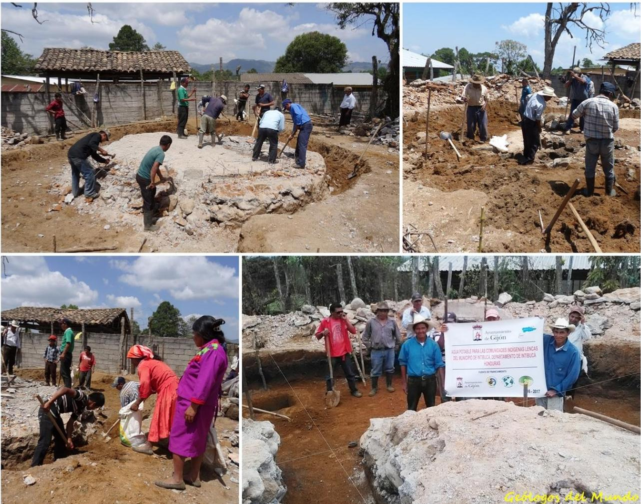
Excavación de rasante de cimentación y saneado de la antigua cimentación para poder incorporarla como parte de la nueva cimentación. También se excavaron a partir de esa rasante los pozos para la cimentación de los pilares de la estructura.
