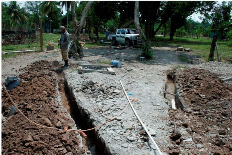
**Zanqueo para la tubería que conecta el pozo con el tanque de distribución**
