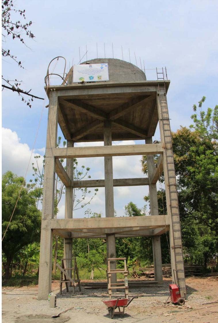
**Tanque ya construido y primera fase de cargado de las paredes para darle la impermeabilidad a la estructura.**
