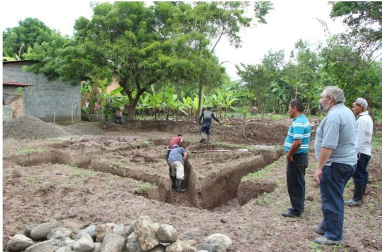
**Terminación de la excavación de la cimentación con el cajado definitivo donde van a ir las zapatas.**
