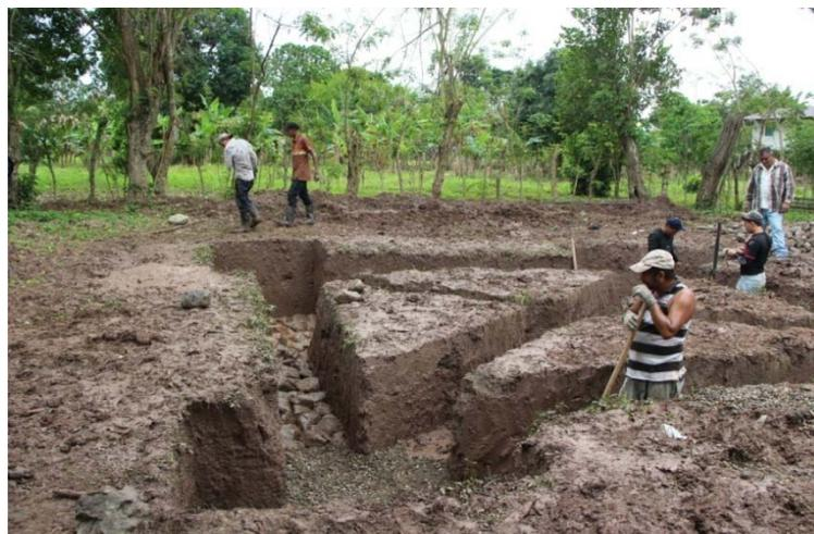
**Encchado de fondo de excavación previo al vertido de hormigón de limpieza para colocar la estructura metálica.**
