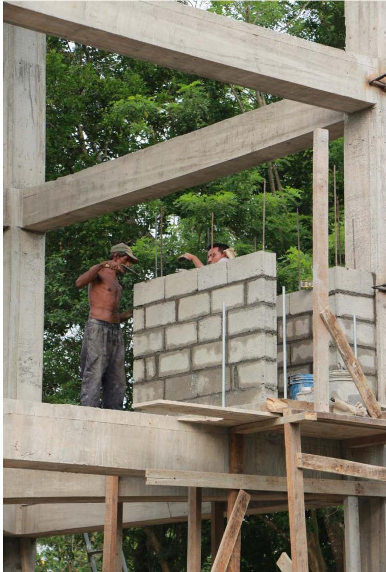
**Fase de construcción de la caseta donde van instalados los controles eléctricos de la bomba. Se ha elegido la ubicación de la caseta en el primer piso de la estructura porque la zona se inunda periódicamente con la llegada de huracanes. Se ha hecho así porque de esta manera se protegen los instrumentos eléctricos vitales para el perfecto funcionamiento del sistema de almacenamiento y distribución de agua.**
