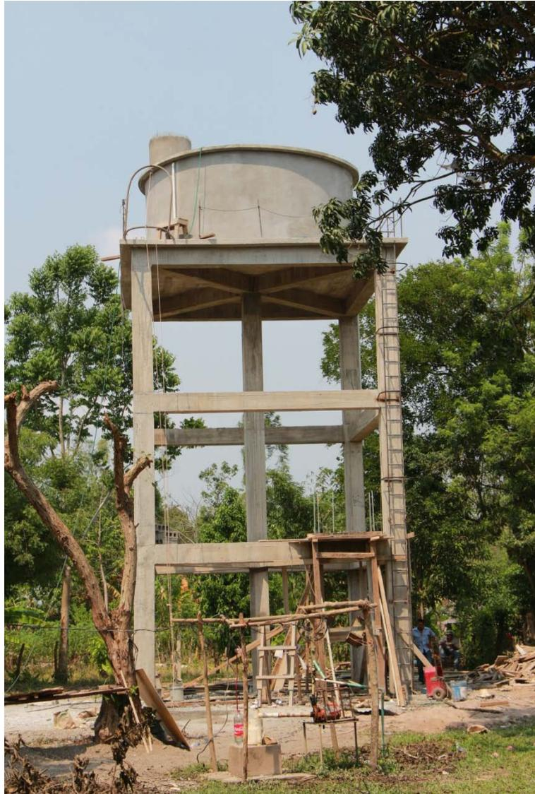
**Tanque totalmente acabado, con el fratasado final ya ejecutado. El hipoclorador se ha construido con planta redonda para que se acomode a la estructura del tanque.**
