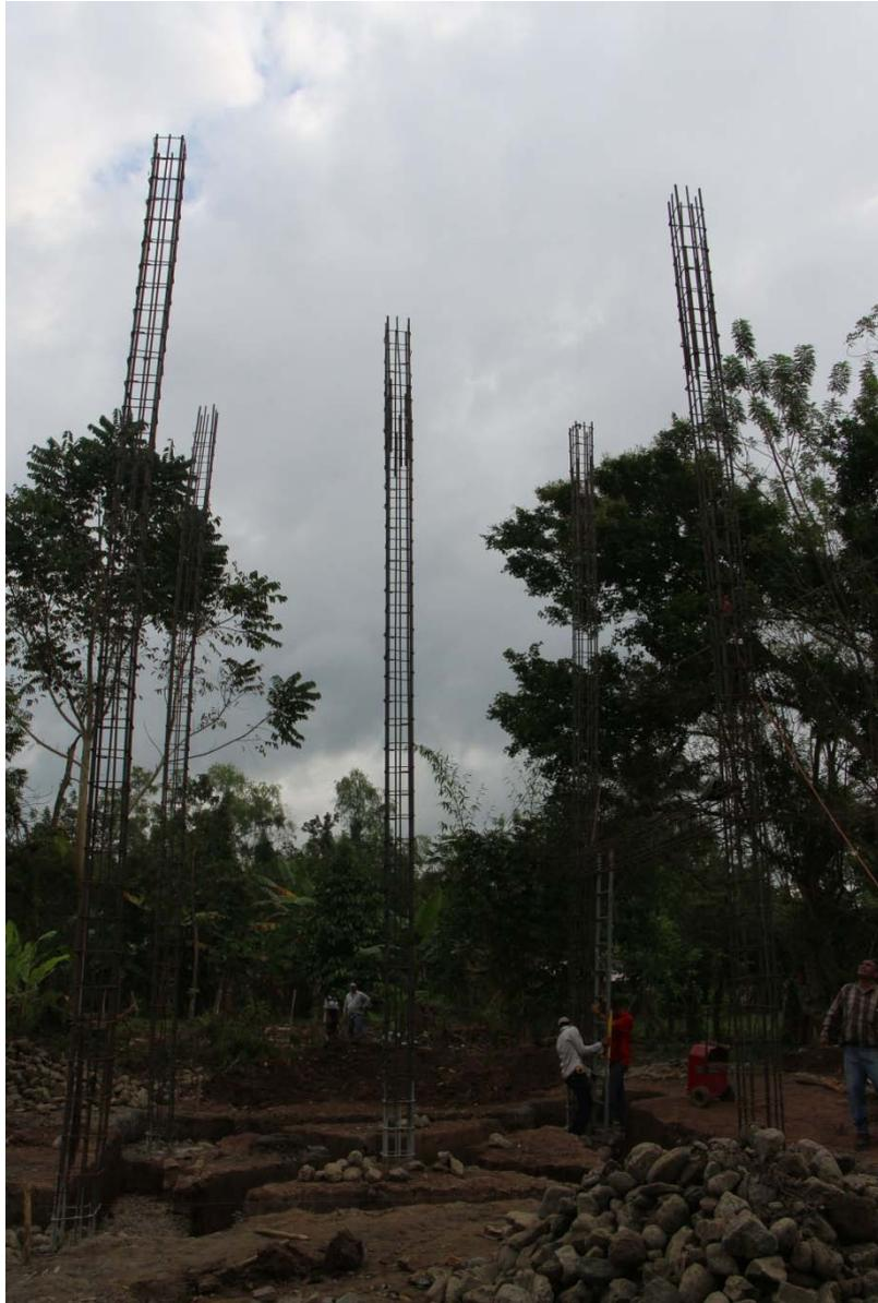
Colocación del armado de hierro de los pilares principales de la estructura
