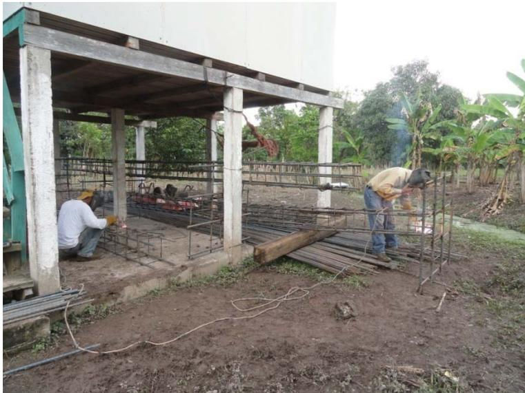
**Trabajos de la preparación de la estructura de hierro para la construcción del edificio elevado que soportará el tanque**
