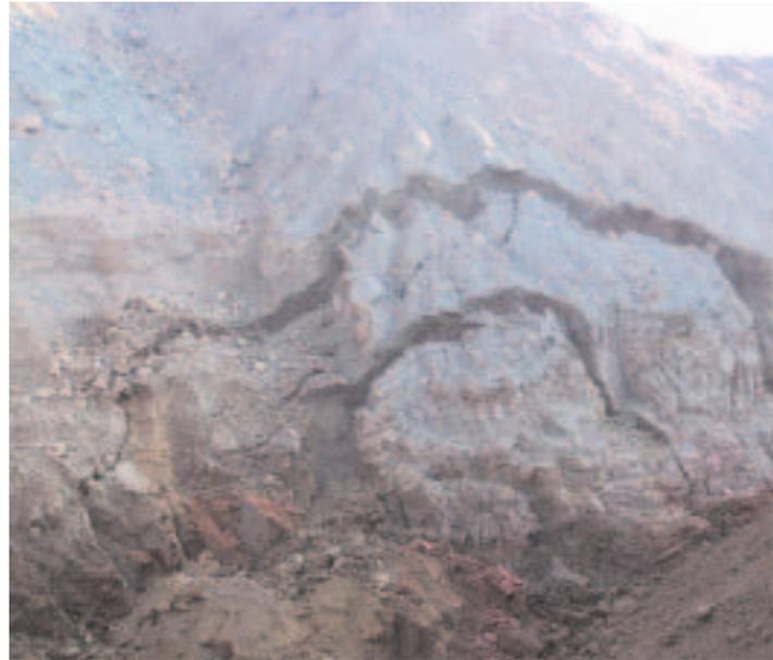
Deslizamiento rotacional generado en un talud en el que no se han tenido en cuenta los factores que aseguren su estabilidad (altura del talud y cohesión de los materiales).
