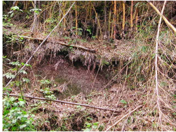
Fotografía 7.3.- Inestabilidad del terreno en la formación Bálsamo. Cantón Potrerillos.
