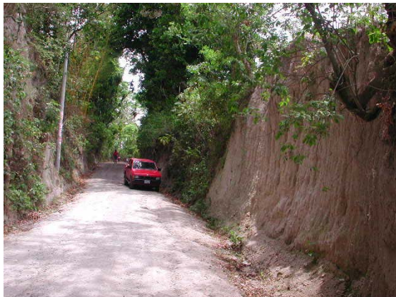
Fotografía 7.5.- Taludes de carretera pertenecientes a la Formación Cuscatlán. Cantón El Guaje.
