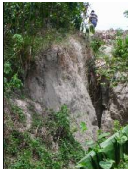
Fotografía 6.5.- Formación de cárcavas en supuesto camino. Lotificación Miramar.
