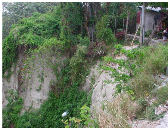
Fotografía 7.10.- Formación de un barranco en Casco Urbano. Colonia Tres de Mayo.
