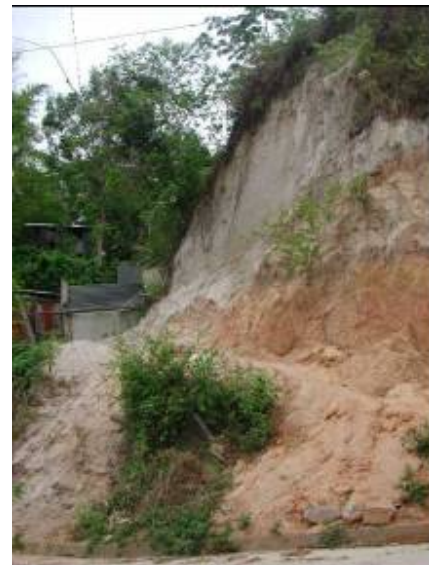
Fotografía 6.13.- Deslizamiento traslacional y desprendimientos asociados. El Porvenir.
