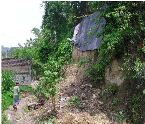
Fotografía 6.11.- Deslizamiento traslacional ocurrido en los terremotos del 2001. Cantón Chaltepe.
