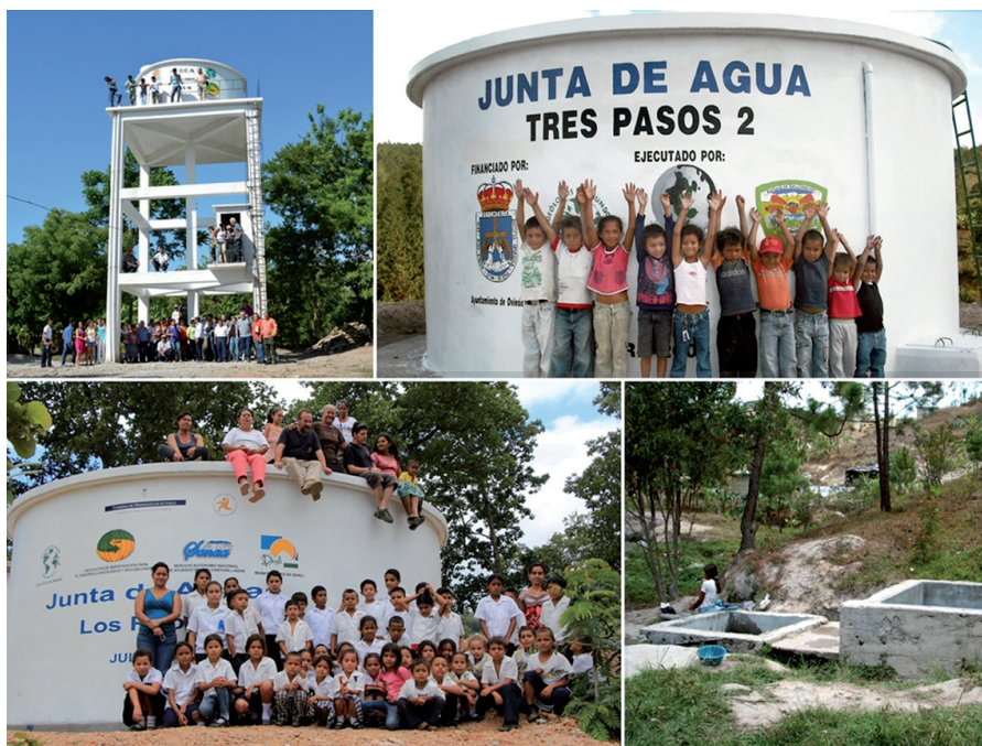
Figura 9: Ejemplos de tanques y represas construidos por GM Asturias durante el periodo 2004-2014).
