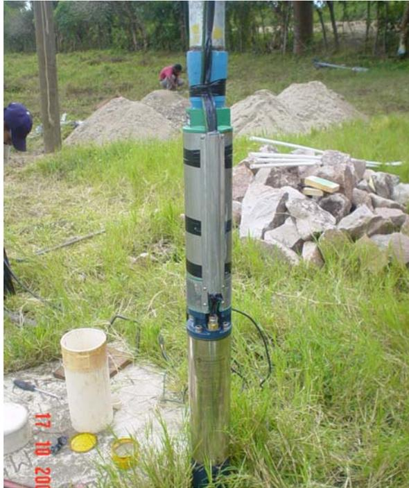
Foto 3.4.1.. Bomba instalada en el pozo.
