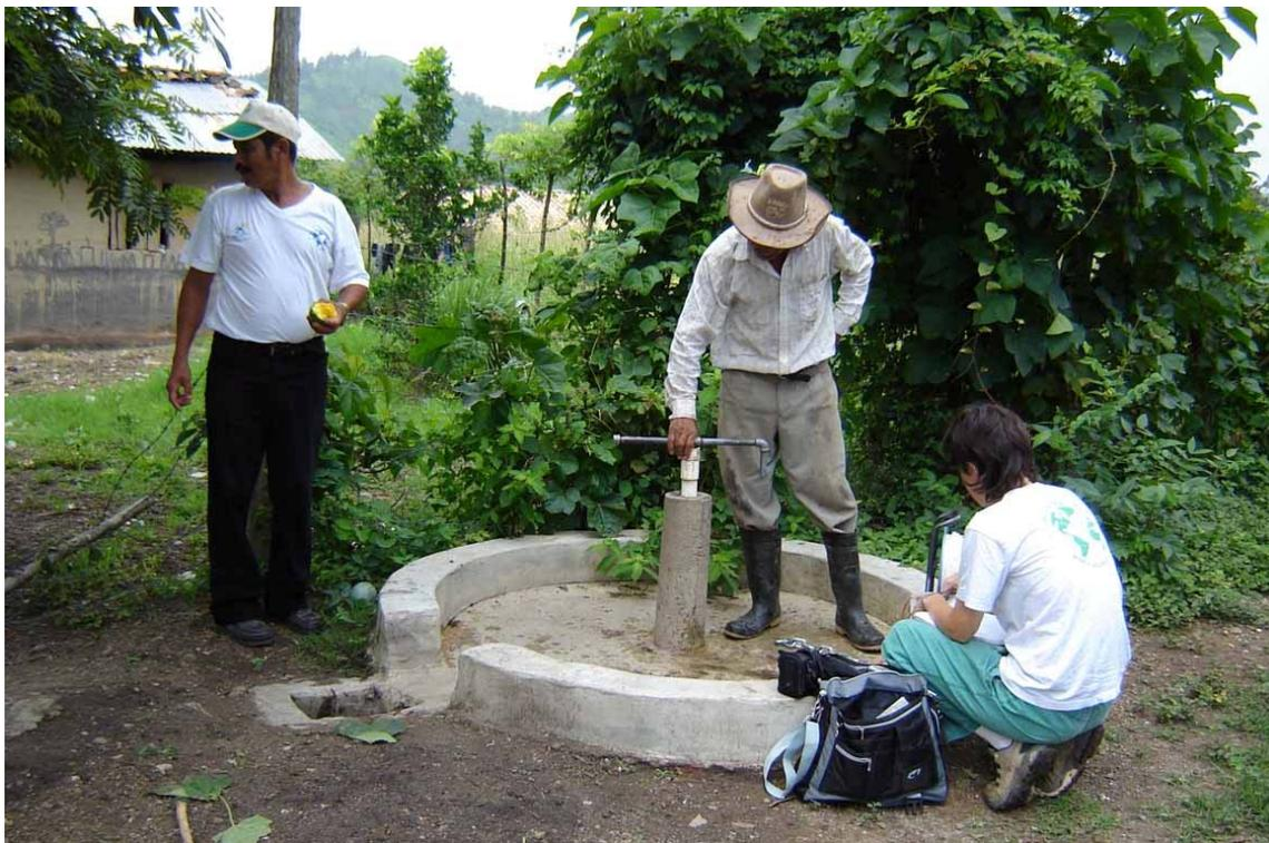
**Figura 4.4. Bomba manual Emaflex o Flexi OPS (P-01, El Zamorano).**
