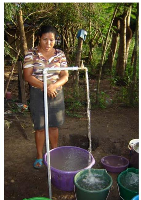
**Foto 3.7.3. Bastón y llave recién instalados en La Suiza**
