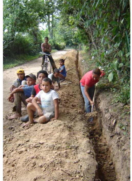
**Foto 3.7.2. Excavación del zanjo de la conducción de La Suiza**
