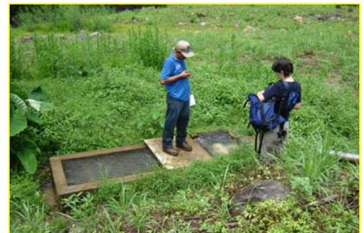
Figura 1.6.1. Desarenador de la captación de El Águila
