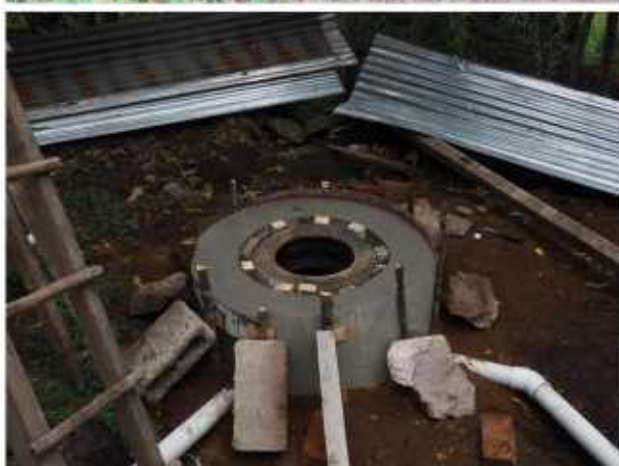
Etapas de construcción del pozo de absorción asociado a la fosa séptica.
