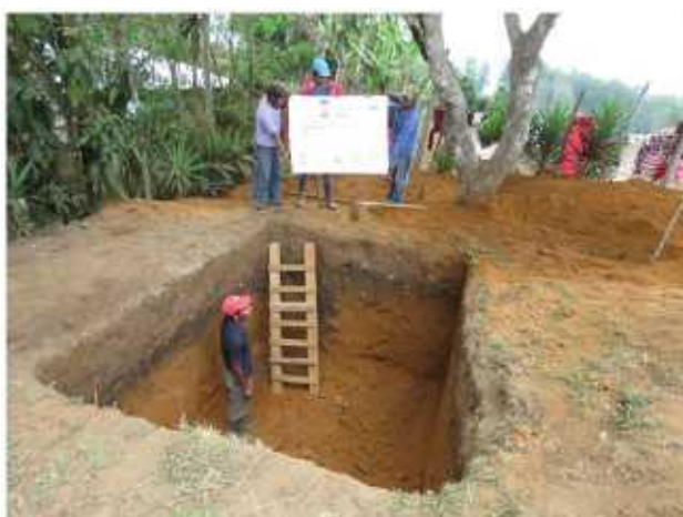
Excavación de vaciado para la fosa séptica.
