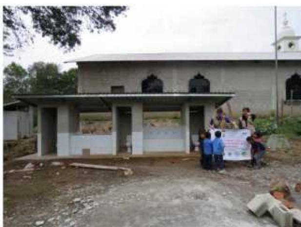
Módulos con los sanitarios ya instalados. A la derecha todo el conjunto de saneamiento: pozo de absorción en primer plano, fosa séptica y en la esquina superior derecha los módulos.
