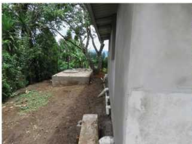
Instalación de conexión con la fosa séptica.
