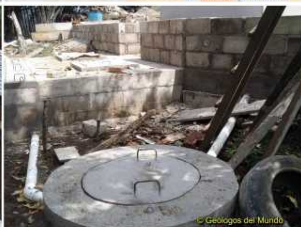
Etapas de construcción del pozo de absorción asociado a la fosa séptica.
