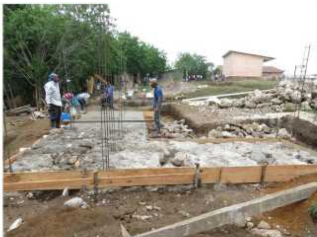
Cimentación y levantando paredes de los módulos sanitarios. Se construyen con bloque de hormigón.
