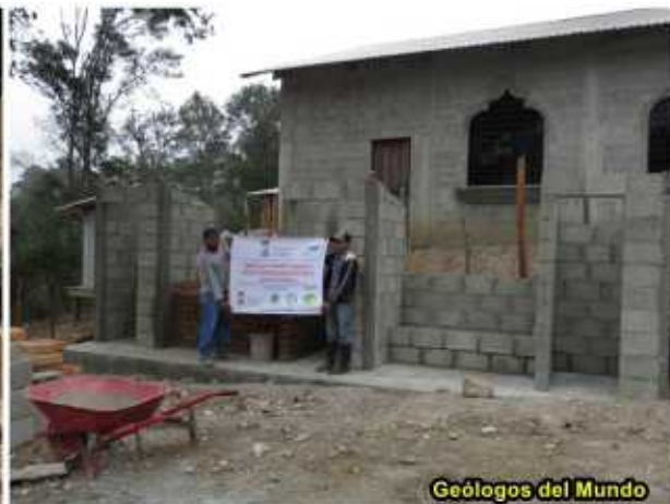
Construcción paredes con bloque de hormigón. La pila/lavadero se construye con ladrillo rafón.
