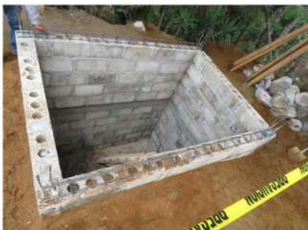
Muros de la fosa construidos con bloque de hormigón. A la derecha, fosa ya cubierta superiormente por la losa.
