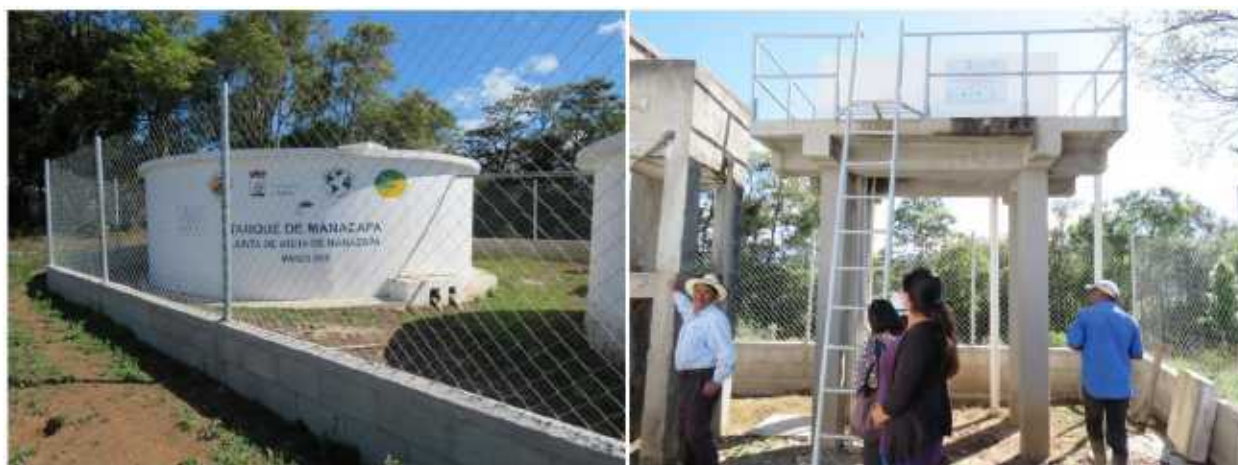
Depósito de agua de Manazapa, y caja derivadora de caudales en perfecto funcionamiento.
