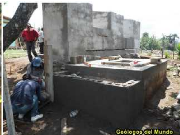
Muros de la fosa construidos con bloque de hormigón. A la derecha, fosa ya cubierta superiormente por la losa.
