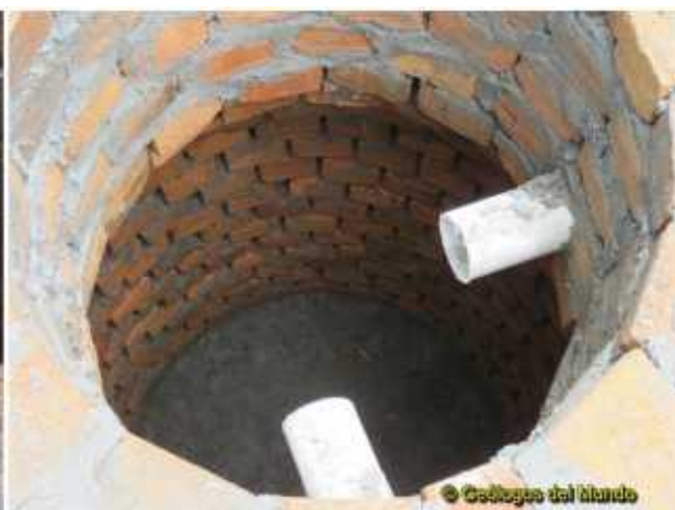
Levantando los muros de la fosa. A la izquierda se puede ver la división interna en dos celdas.
