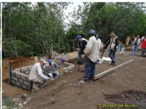
Levantando los muros de la fosa. A la izquierda se puede ver la división interna en dos celdas.
