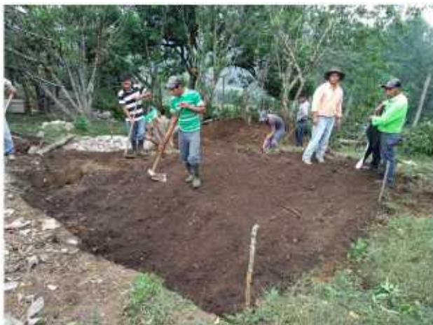
Limpieza y desbroce de la ubicación.
