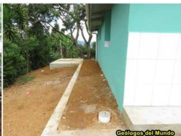
Conjunto fosa- pozo de absorción, a la derecha se puede ver la posición relativa de la fosa respecto a los módulos.
