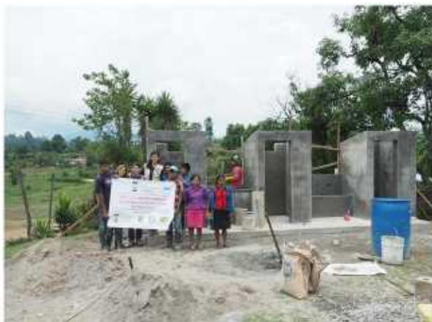
Paredes de los módulos, pila y lavamanos ya repelladas. A la derecha techado y colocación de cerámica.
