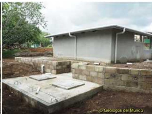
Losa de cierre de la fosa con las correspondientes tapaderas de inspección y mantenimiento. A la derecha aspecto general del entorno.
