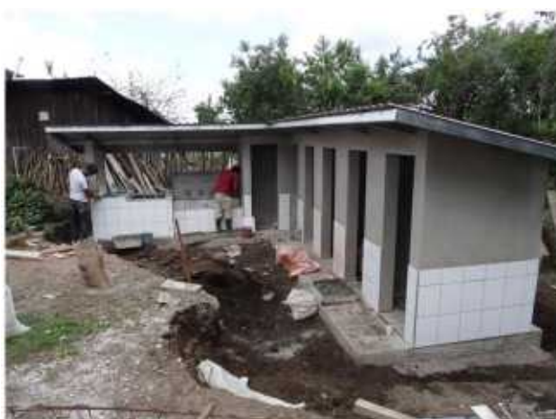
Colocación de cerámica en el interior de los módulos y en el tercio inferior de las paredes. A la derecha pintado y con los sanitarios instalados, acondicionando el entorno con una cuneta de drenaje.
