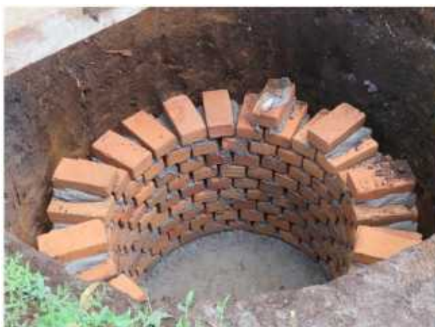
Levantando los muros de la fosa. A la izquierda se puede ver la división interna en dos celdas.
