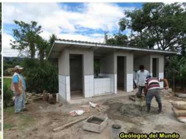
Paredes de los módulos, pila y lavamanos ya repelladas. A la derecha techado y colocación de cerámica.
