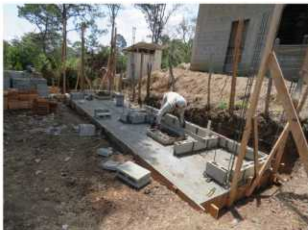
Construcción paredes con bloque de hormigón. La pila/lavadero se construye con ladrillo rafón.
