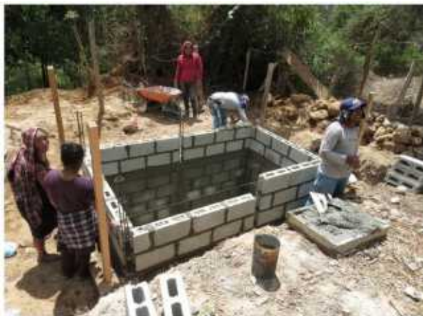
Construcción de los muros de la fosa con bloque de hormigón. A la derecha fosa ya cubierta con la losa de sellado.
