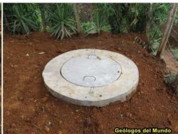
Muros de la fosa construidos con bloque de hormigón. A la derecha, fosa ya cubierta superiormente por la losa.
