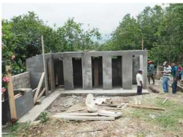
Paredes de los módulos terminadas y repelladas. A la derecha colocada la estructura soporte del techado..
