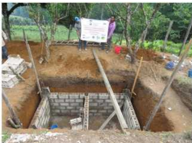
Levantando los muros de la fosa. A la izquierda se puede ver la división interna en dos celdas.
