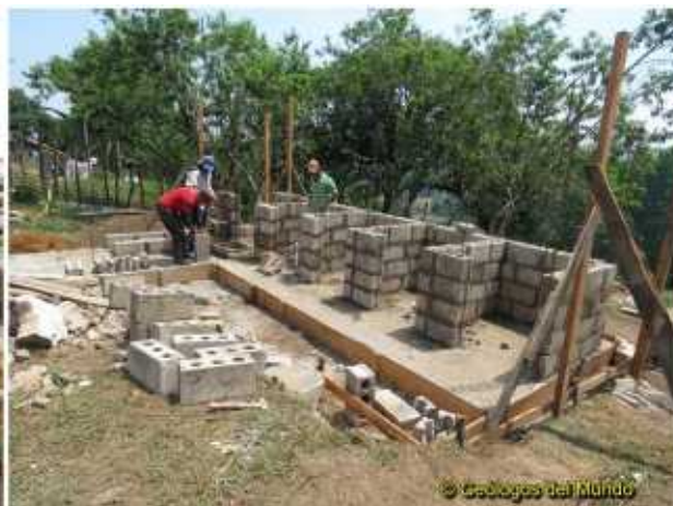
Cimentación y levantando paredes de los módulos sanitarios. Se construyen con bloque de hormigón.
