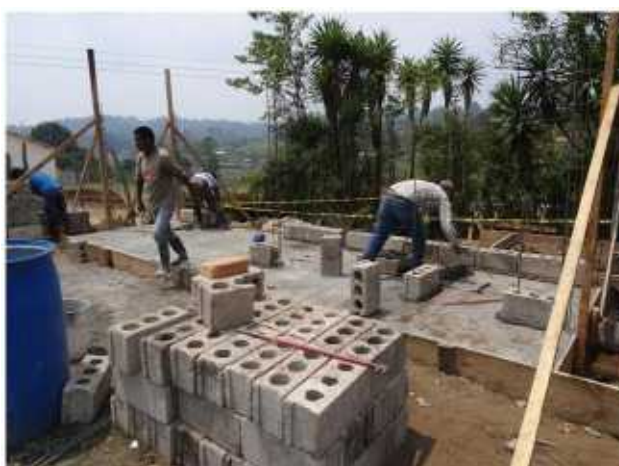
Arranque y levantando las paredes de los módulos, pila y lavamanos.
