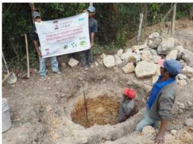
Excavación para el pozo de absorción y pozo ya construido con ladrillo rafón y anillo perimetral filtro de piedra y grava.
