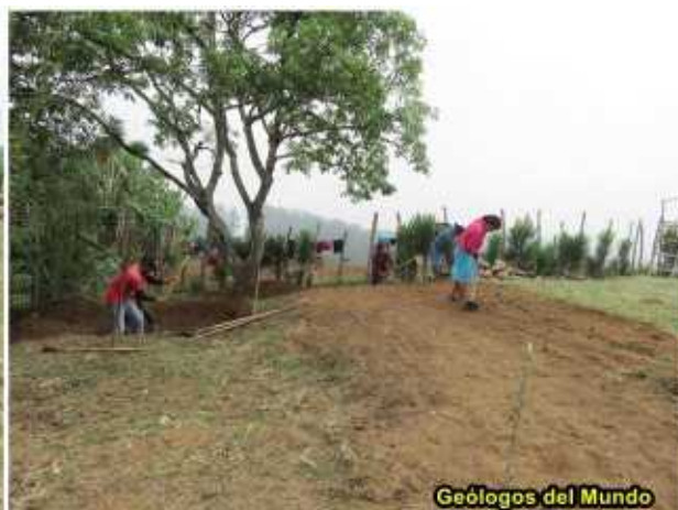
Replanteo de la ubicación de los módulos sanitarios, fosa séptica y pozo de absorción.
