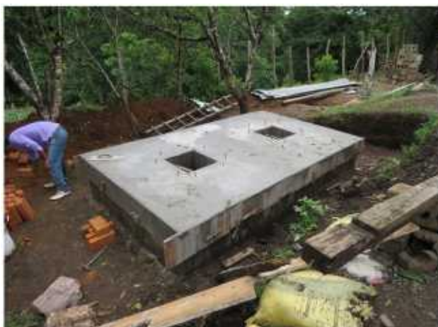
Losa de cierre de la fosa con las correspondientes tapaderas de inspección y mantenimiento. A la derecha aspecto general del entorno.
