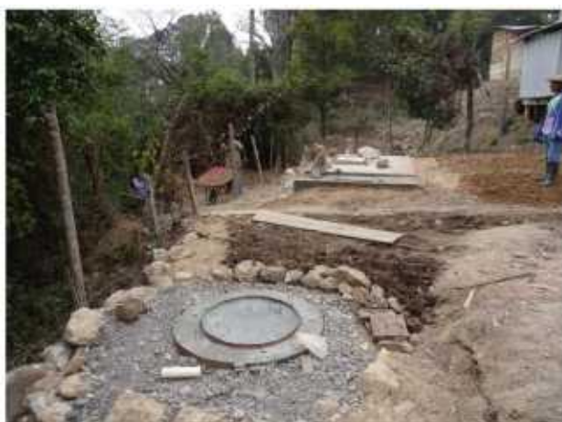
Conjunto fosa- pozo de absorción ya finalizado a falta de restitución del terreno.
