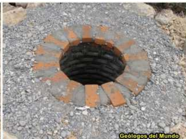
Excavación para el pozo de absorción y pozo ya construido con ladrillo rafón y anillo perimetral filtro de piedra y grava.
