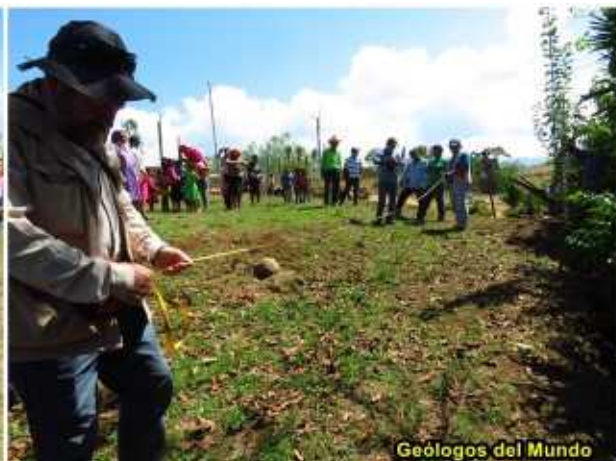
Replanteo de la ubicación de los módulos sanitarios, fosa séptica y pozo de absorción.
