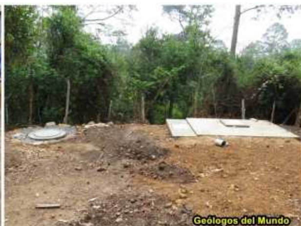
Conjunto fosa- pozo de absorción ya finalizado a falta de restitución del terreno.
