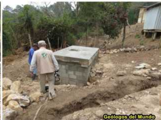
Construcción de los muros de la fosa con bloque de hormigón. A la derecha fosa ya cubierta con la losa de sellado.
