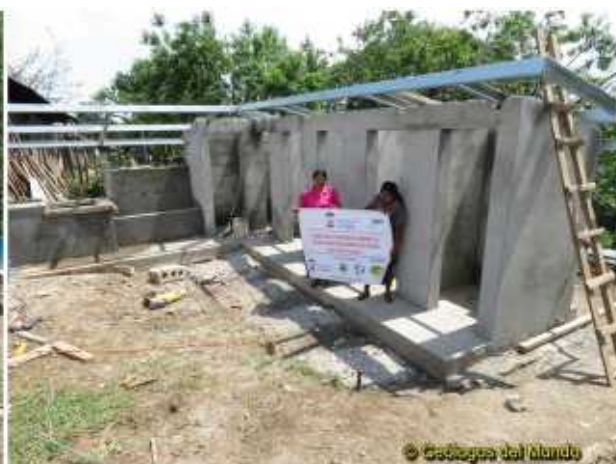
Paredes de los módulos terminadas y repelladas. A la derecha colocada la estructura soporte del techado..
