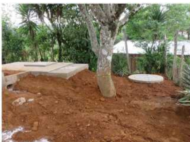
Conjunto fosa- pozo de absorción, a la derecha se puede ver la posición relativa de la fosa respecto a los módulos.
