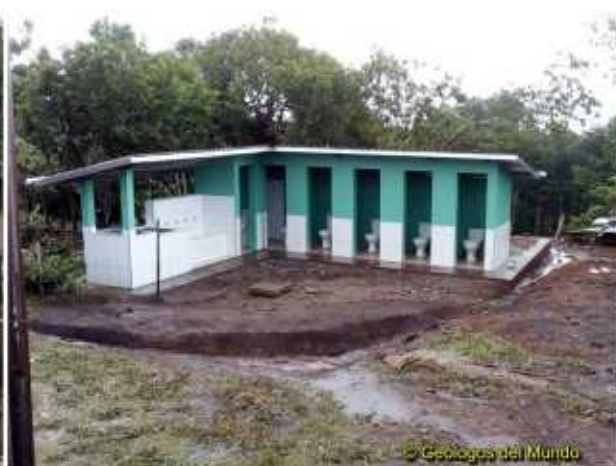
Colocación de cerámica en el interior de los módulos y en el tercio inferior de las paredes. A la derecha pintado y con los sanitarios instalados, acondicionando el entorno con una cuneta de drenaje.
