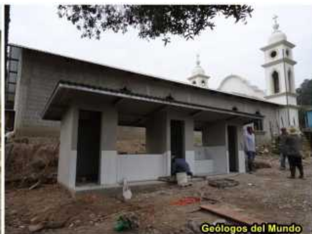
Techado y placado con piezas de cerámica en suelo, lavamanos, pila y tercio inferior de las paredes.
