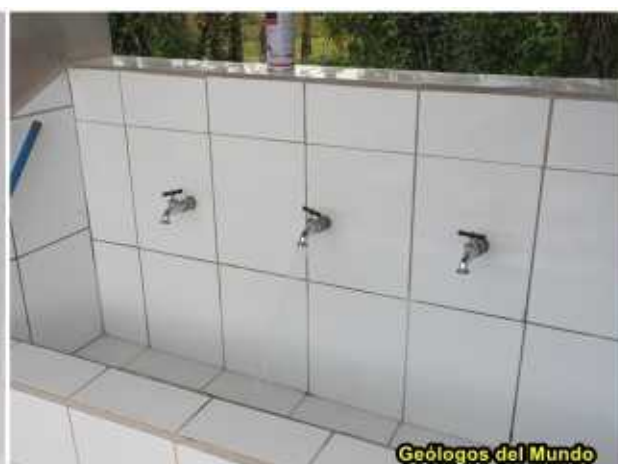
Sanitarios hidráulicos instalados; se observa el piso de cerámica ya colocado. A la derecha el lavamanos corrido con cuatro puestos.
