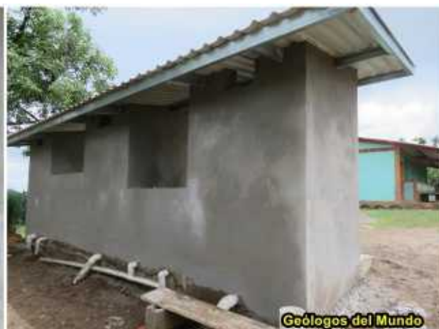
Paredes de los módulos, pila y lavamanos ya repelladas. A la derecha techado y colocación de cerámica.
