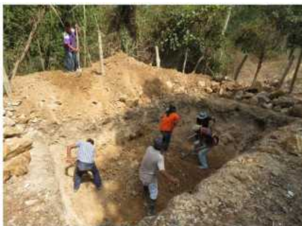
Excavación para la fosa.
