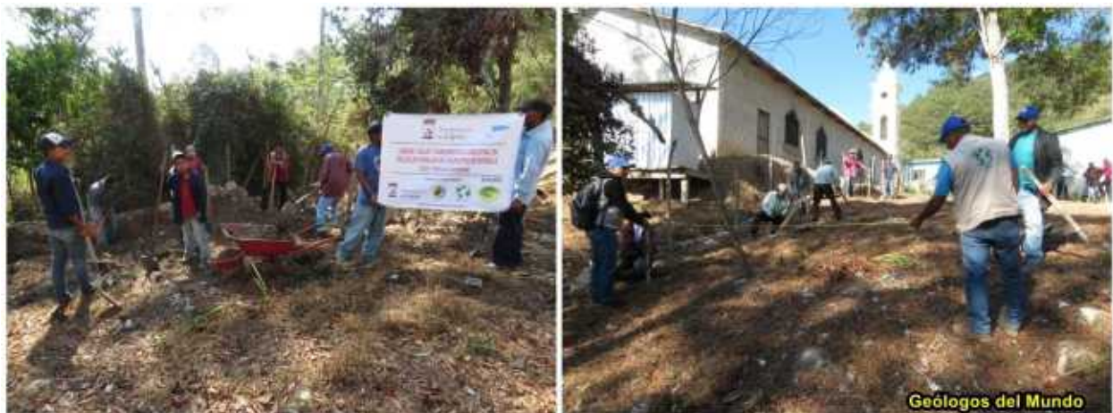
Limpieza y desbroce del puesto de trabajo. En la foto de la derecha, el replanteo de la ubicación de las infraestructuras.
