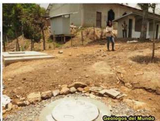
Módulos con los sanitarios ya instalados. A la derecha todo el conjunto de saneamiento: pozo de absorción en primer plano, fosa séptica y en la esquina superior derecha los módulos.
