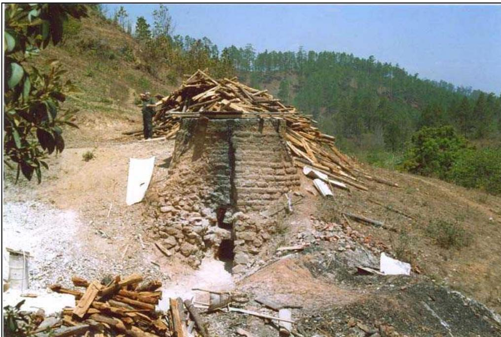
Foto 10.8 – El horno simple en el pueblo La Calera usado para producción del cal vivo.
