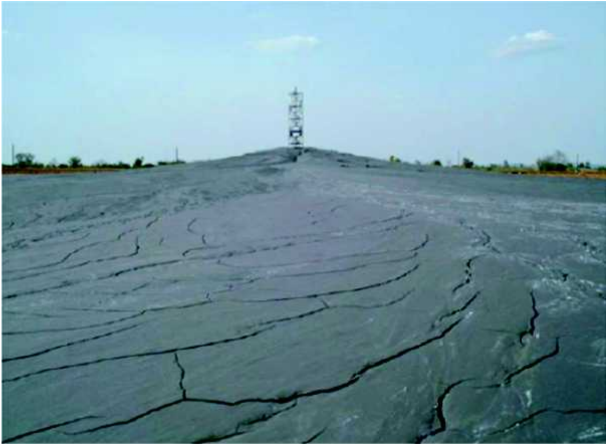
Figura 3.30 Vertido de Lodos Espesados; la Torre que se Apprecia al Fondo es el Punto de Vertido.
