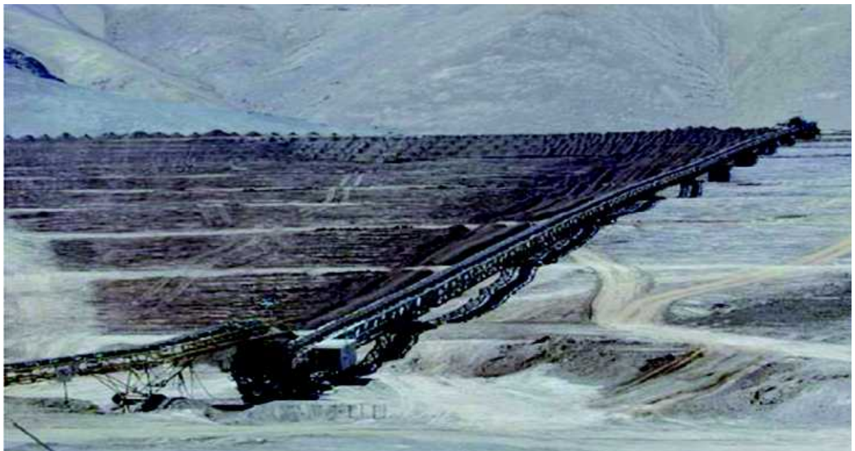
Figura 3.38 Vertido en Forma de Pasta mediante Cinta Transportadora.
