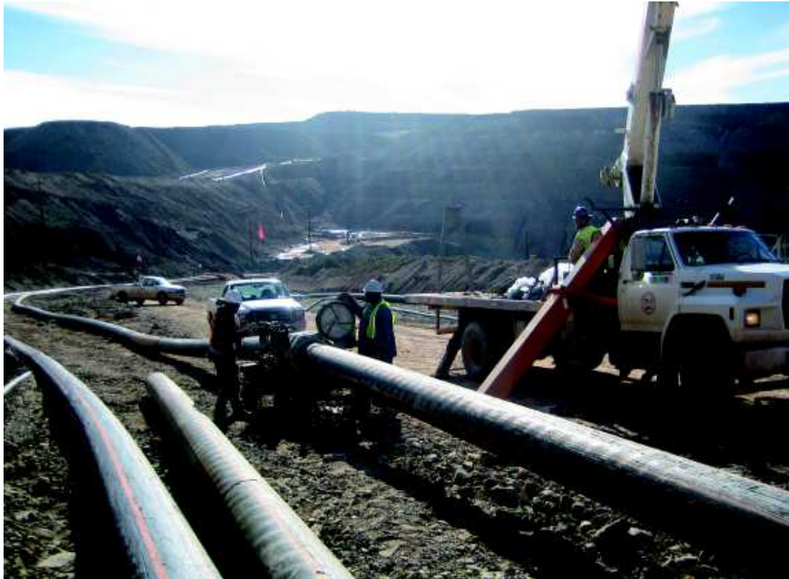
Figura 3.6 Operaciones de Construcción de la Conducción de Suministro de Agua a una Mina
