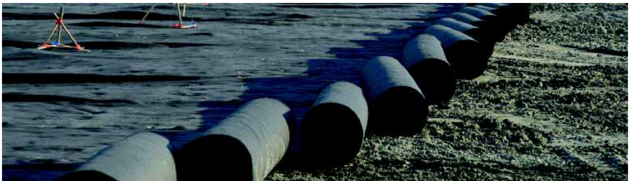
Figura 3.39 Colocación del Geotextil de una Cubierta Seca. (TAILSAFE, 2007)
