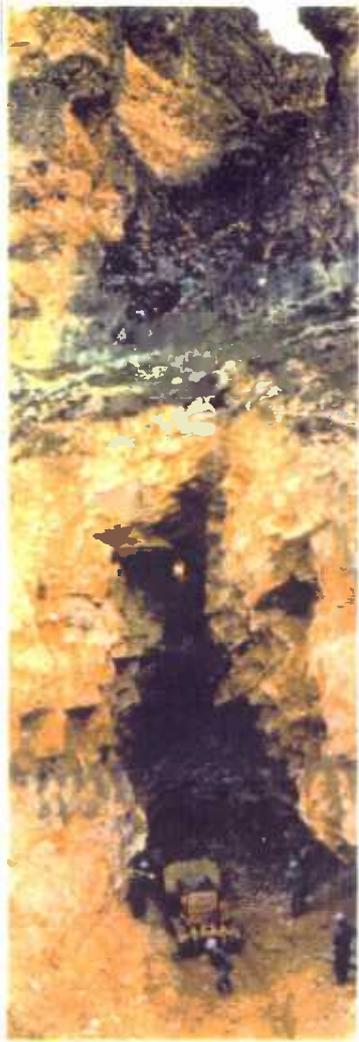
FIGURA 7.27. DESESCOMBRO, EN EL VASO DE LA PRESA, JUNTO A UN ESTRIBO, DE RELLENOS KARSTICOS CONSTITUIDOS POR ARCILLAS. EN LA PARTE ALTA DE LA EXCAVACION SE OBSERVA LA PRIMITIVA ENTRADA DE LA CUEVA
