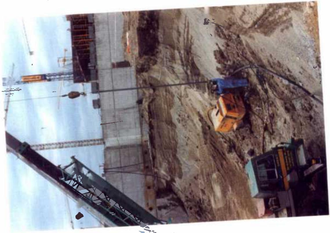
FIGURA 7.17. COLOCACION DE UNA BOMBA EN UN POZO
