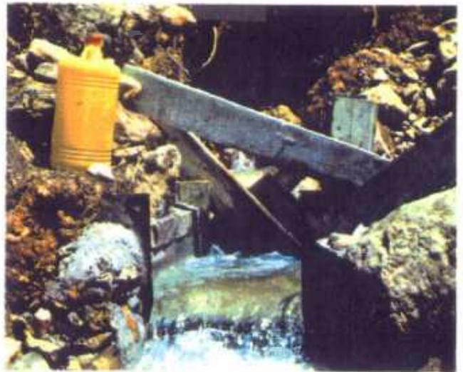
FIGURA 7.30. FUGA APARECIDA EN LA PROLONGACION DEL ESPEJO DE FALLA DEL TUNEL DE DESVIO
