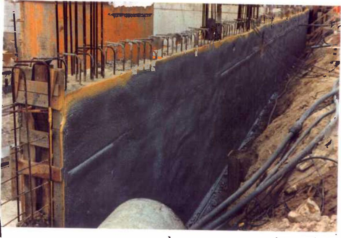
FIGURA 7.8. RECUBRIMIENTO IMPERMEABILIZANTE EXTERIOR DE LA PANTALLA
