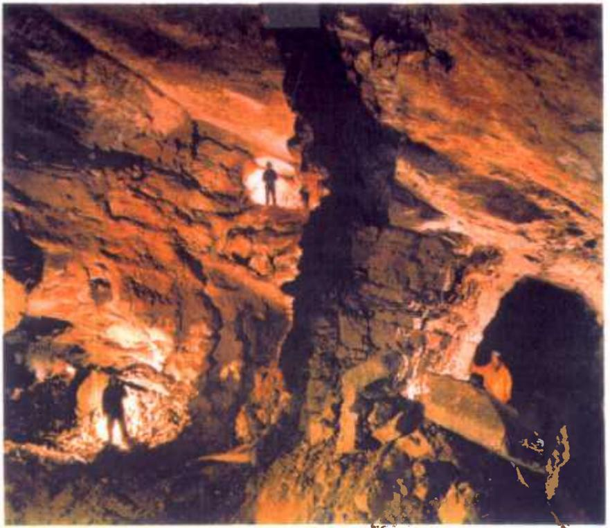
FIGURA 7.28. CAMARA KARSTICA EN EL INTERIOR DEL ESTRIBO DERECHO DE UNA PRESA, APARECIDA AL EXCAVAR LOS RELLENOS ARCILLOSOS
