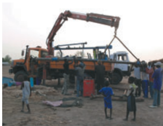
Ensayo de bombeo
