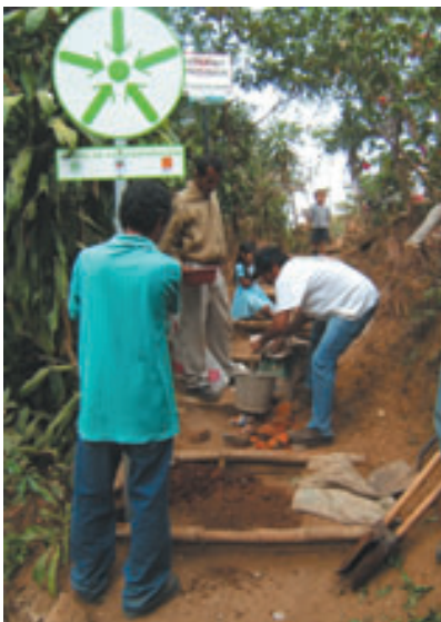
Trabajos de señalización de un punto de reunión
