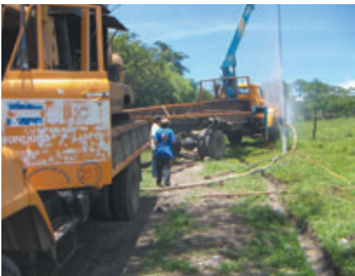
Limpeza del pozo Noé Cruz
