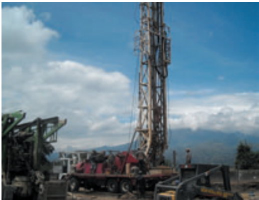
Natabuela: instalación del revestimiento del pozo
