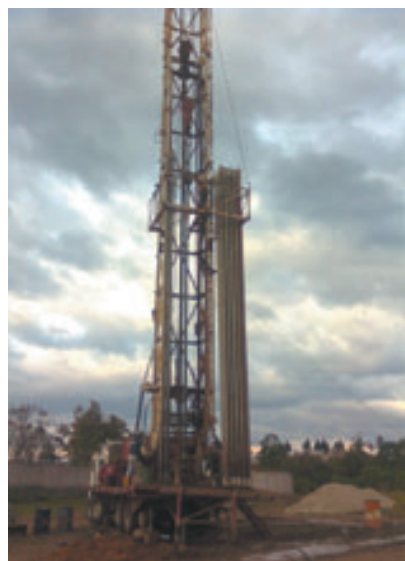
Máquina de perforar durante el trabajo
