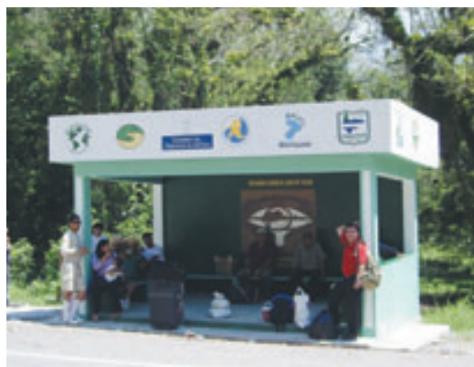
Caseta de autobús construida por GM y sus contrapartes
