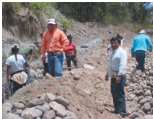
Trabajos en el sitio
