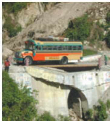
Puente al pie del Cerro Lec antes del deslizamiento
