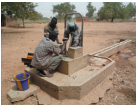
Construcción del aforo
