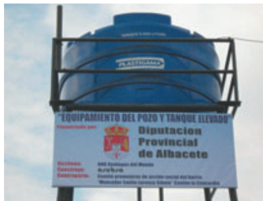
El depósito ya construido con el cartel de los financiadores
