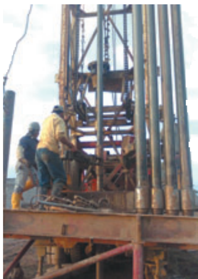
Trabajos durante la del pozo de La Esperanza
