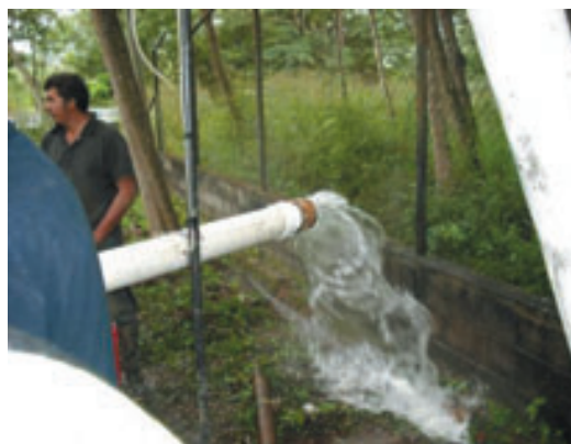
Ensayo de bombeo
