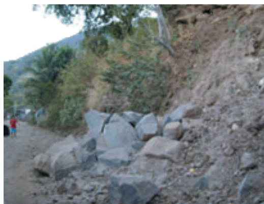
Caída de bloques en un camino de Conchagua
