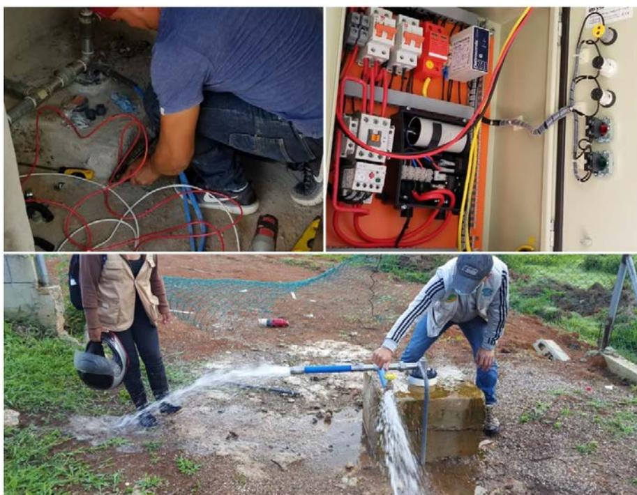
Instalación de controles de bomba sumergible y bomba trabajando correctamente.
