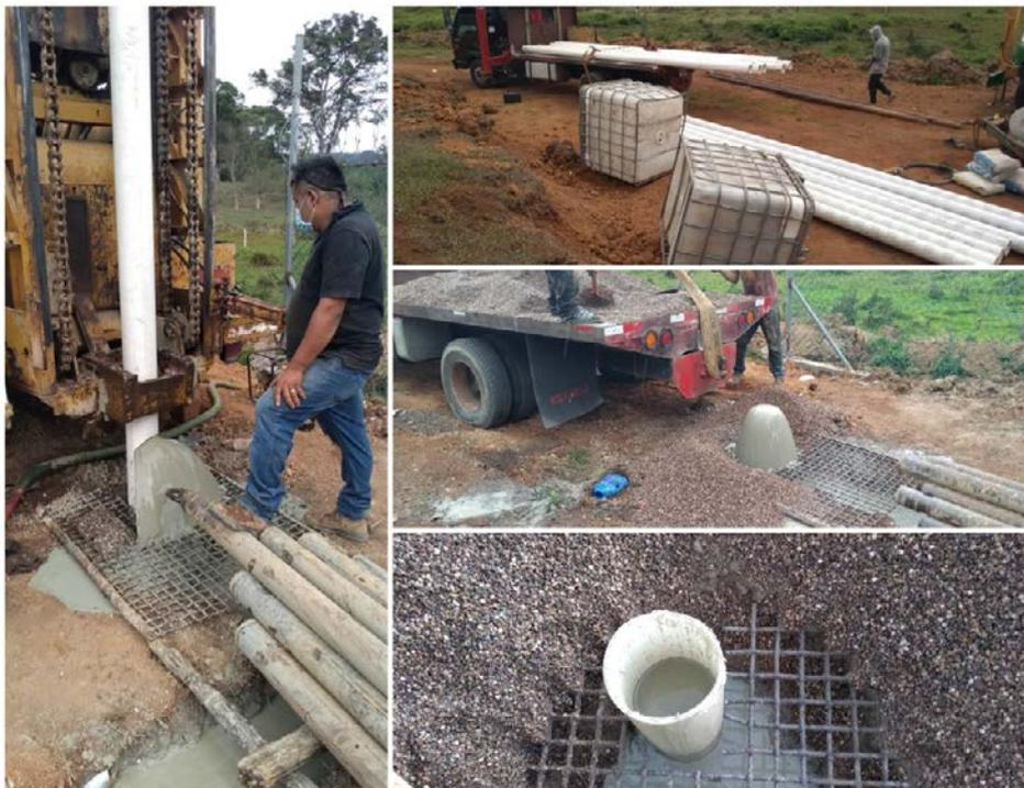
*Construcción del pozo con tubería de PVC de diámetro 6" y filtro interanular de gravín.*
