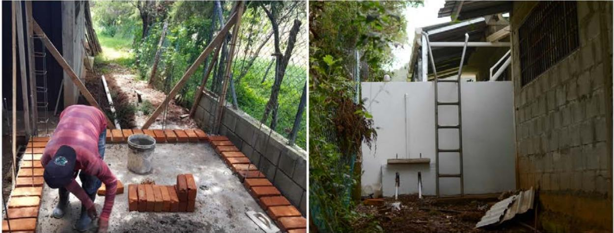
*Construcción de cisterna para almacenamiento de aguas lluvia recogidas de los techos de la edificación. Capacidad 8,25 m<sup>3</sup>.*
