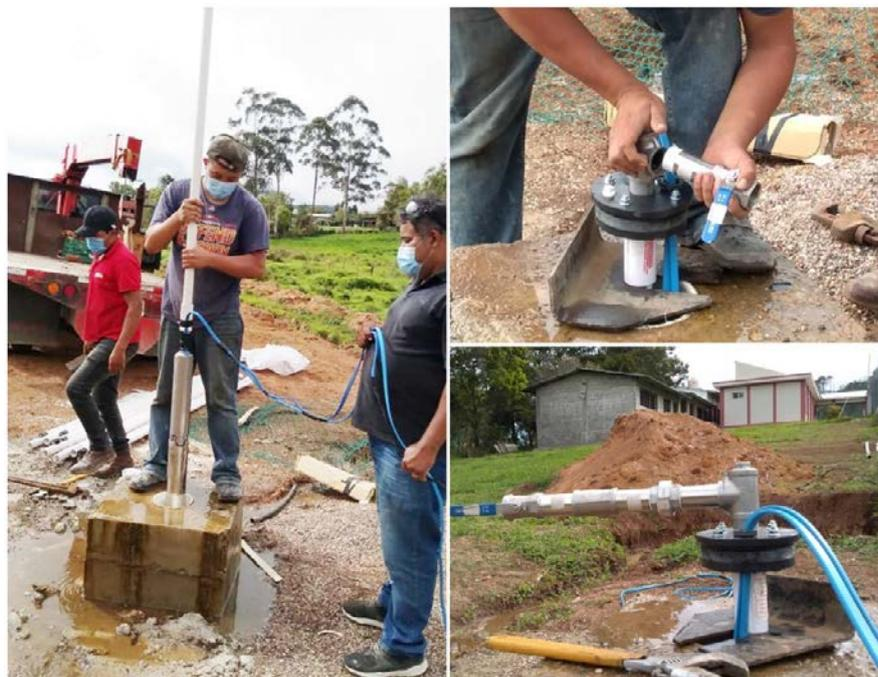
Proceso de instalación de la bomba sumergible monofásica de 3 HP.
