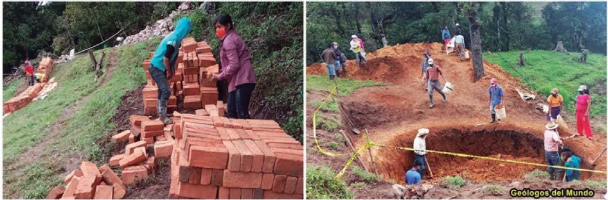
Figura 18.- ladrillo utilizado y excavación de cimentación y arranque
