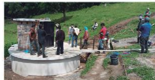
Cisterna (capacidad 24,605 litros) y sistema de bombeo a depósito
