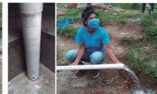
Bomba de agua.
