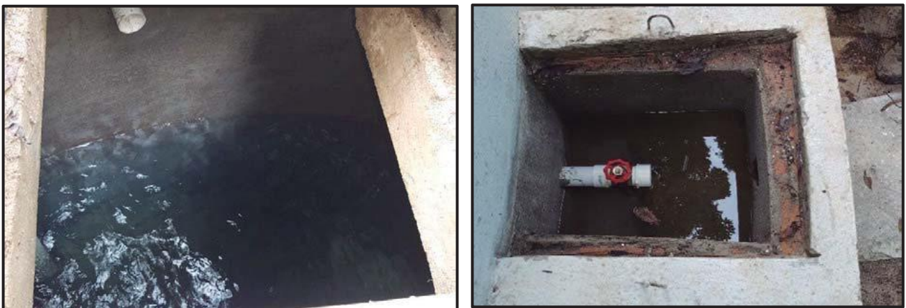
Imagen 8: Detalle del interior del tanque y de las cajas válvula .
