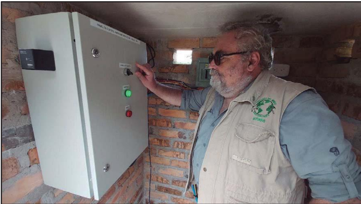
Imagen 5: Prueba de funcionamiento de la bomba.
