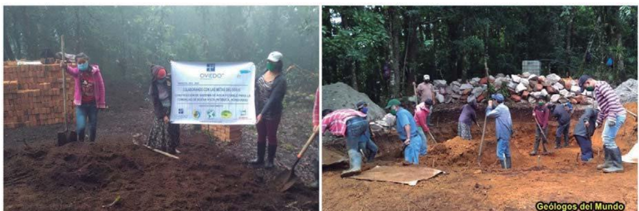
Figura 27.- Puesto de trabajo y excavación de rasante de cimentación. Participación comunitaria.
