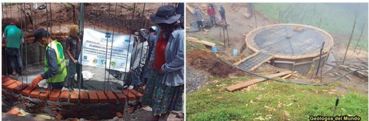
Figura 20.- Labores de construcción de los paramentos de cierre verticales (paredes); a la derecha las paredes ya finalizadas con sus correspondientes repellos, y el encofrado y armado de la losa de cierre superior dispuesta para su fundido con hormigón. Su capacidad final es de 6.500 galones (24.605 litros)
