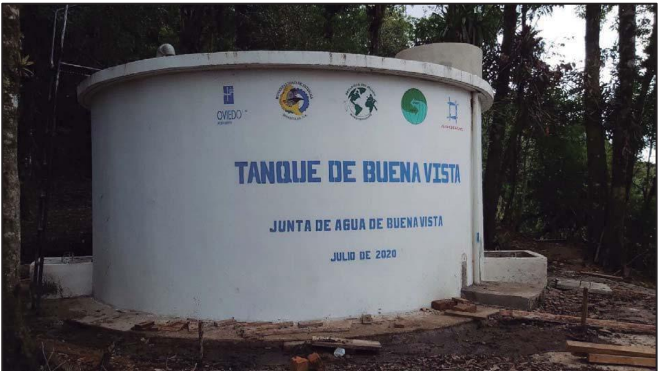
Imagen 7: Aspecto exterior del tanque de distribución de Buena Vista.
