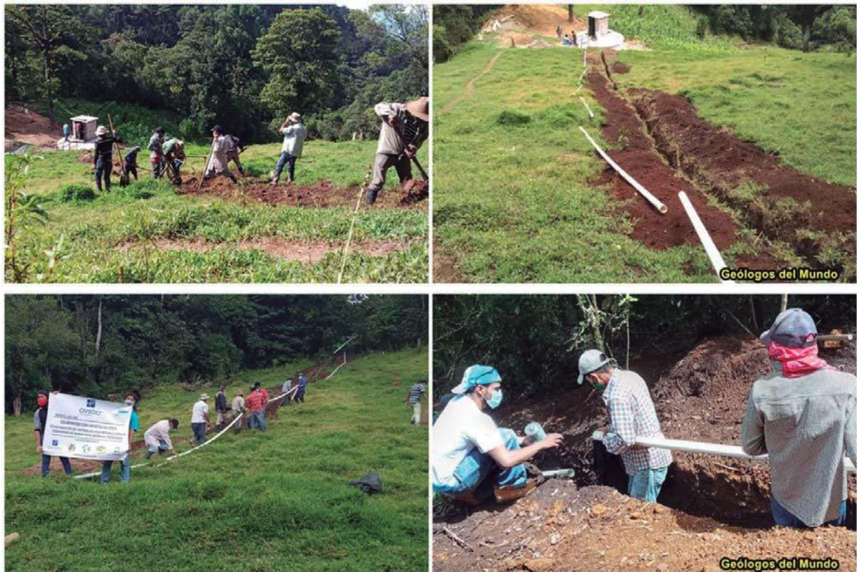
Figura 26.- Zanqueo e instalación de tubería de impulsión a depósito de almacenamiento. De forma paralela a esta tubería, y en la misma zanja se instaló un tramo de una de las líneas de distribución, diferenciándolas mediante pintura de color azul para la impulsión y verde para la de distribución.
