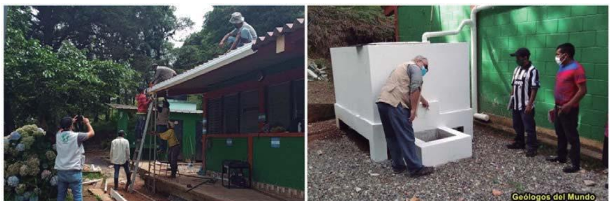
Figura 40.- Instalación de canaletas para el sistema de captación de aguas lluvia, y cisterna ya funcional.
