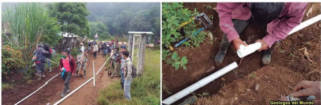
Figura 34.- Instalación de líneas de distribución.
