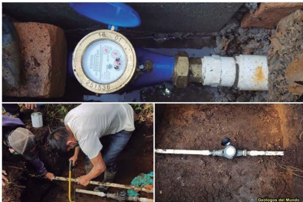
Figura 36.- Instalación de macromedidor de las tres (3) líneas de salida del depósito.
