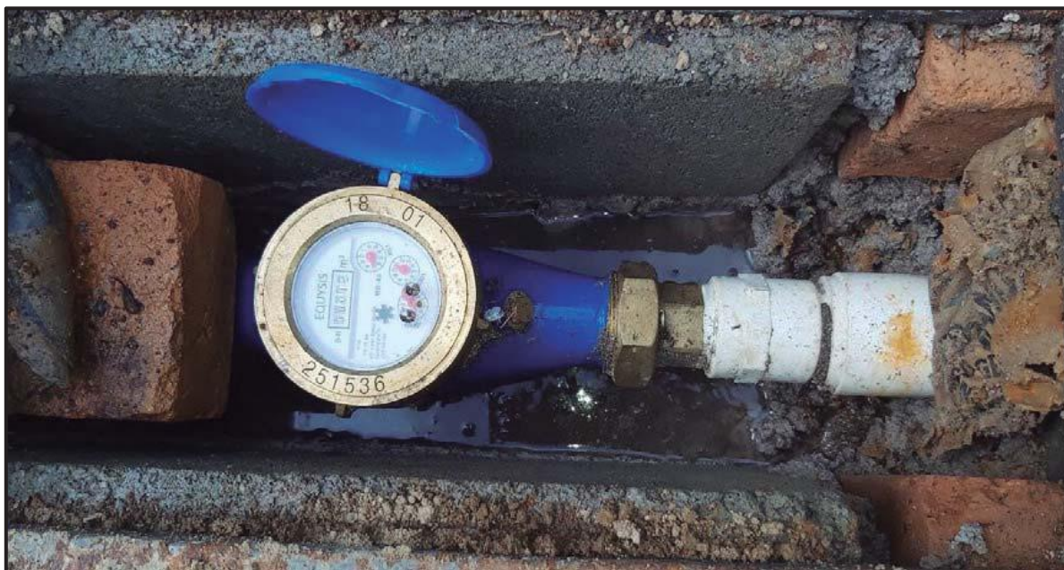
Imagen 9: Macromedidor instalado
