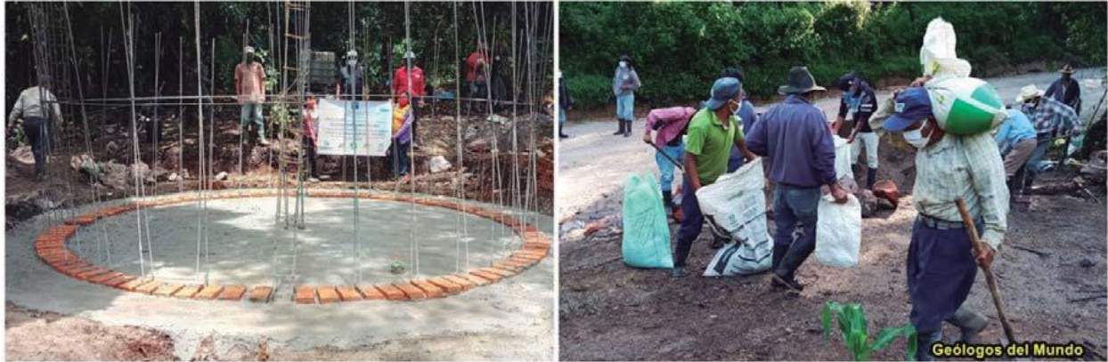
Figura 28.- Cimentación realizada y arranque de la pared; se observa el armado vertical de varillas de hierro; el horizontal se irá instalando a medida que avance el levantado de la pared. La comunidad participando en las labores de transporte de material y asistencia a la mano de obra calificada.
