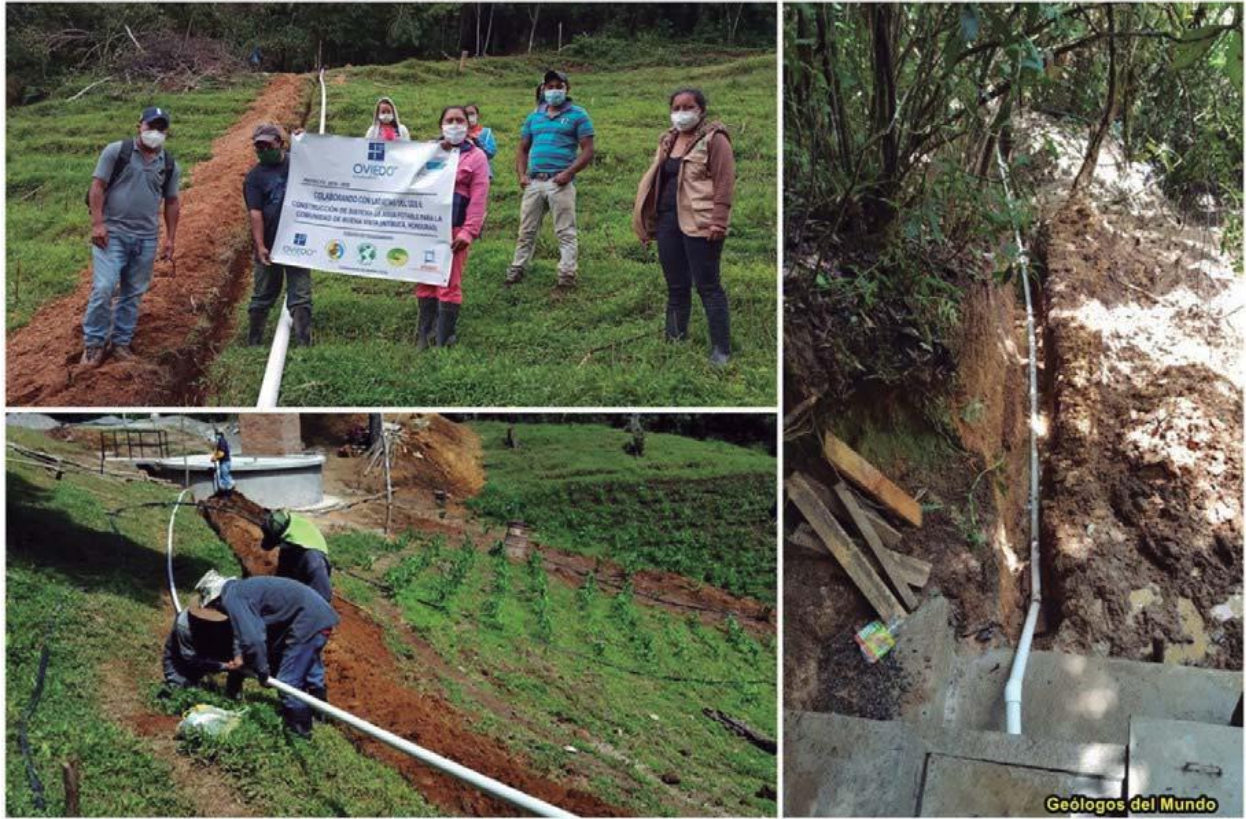
Figura 21.- Instalación de tubería de conducción obra toma a cisterna de bombeo.
