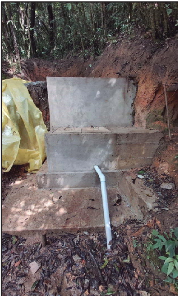
Imagen 2 Obra de captación con las dos cámaras. Detalles de la misma
