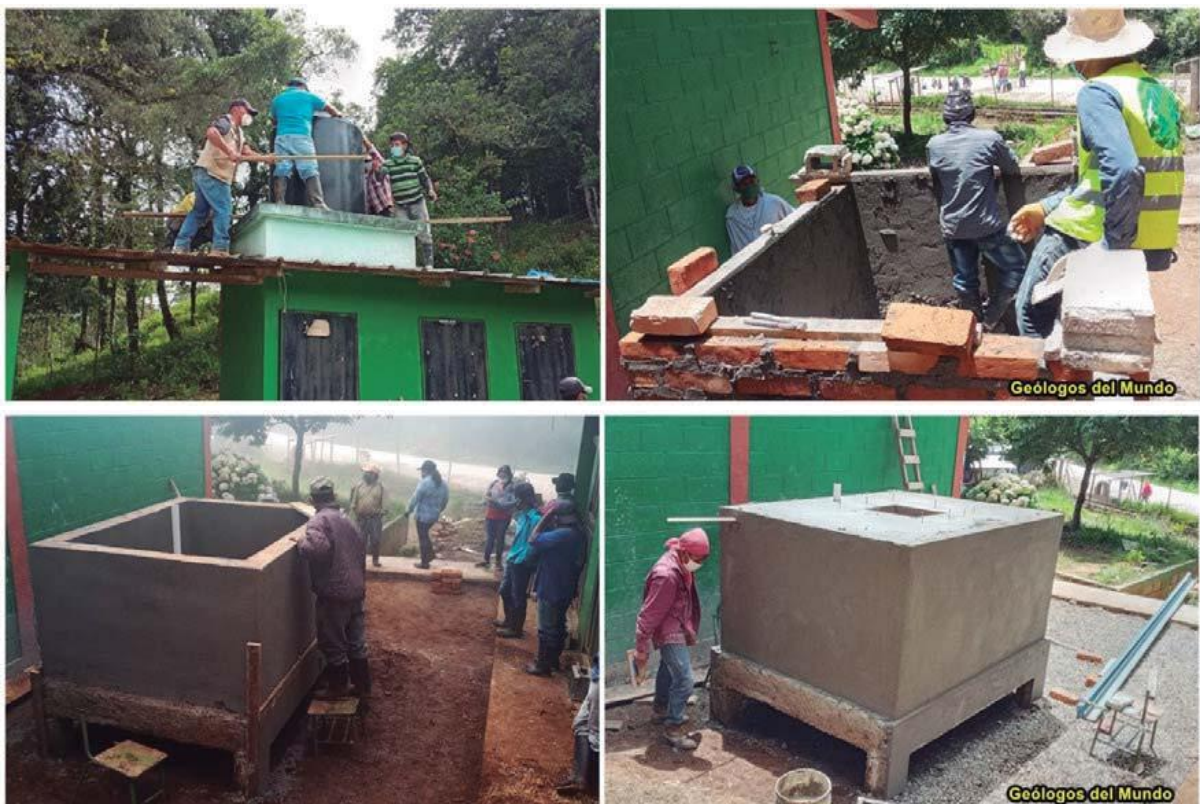
Figura 39.- “Roptoplas” y construcción de la cisterna de almacenamiento de aguas lluvia. Capacidad 2.500 litros.
