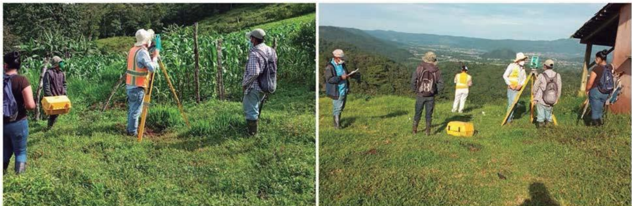
Figura 14.- Labores de campo de topografía para infraestructuras y líneas de distribución.
