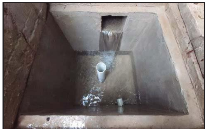
Imagen 2 Obra de captación con las dos cámaras. Detalles de la misma
