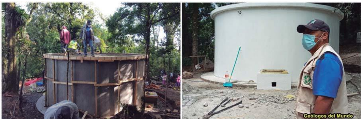
Figura 30.- Paredes completas y encofrado de la losa superior para su armado y fundido. Depósito finalizado.
