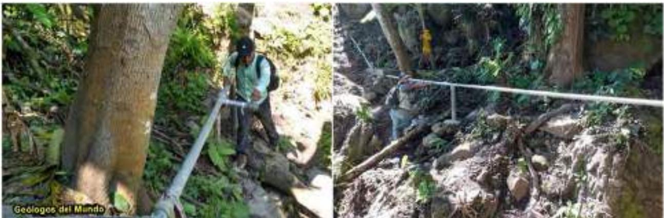
Figura 166.- Restitución de tubería mediante sustitución de PVC por HG suspendida en apoyos anclados.
