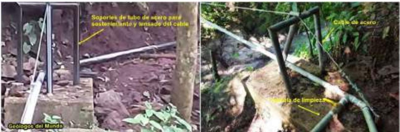
Figura 91.- Soportes para la sustentación de la tubería de conducción sobre el Río Blanco. Se realizaron mediante una estructura de tubo de acero anclada mediante una zapata de hormigón, que permite el tensado del cable de acero del que va colgado el tubo a modo de tablero de un puente colgante. Etapa COVID-19
