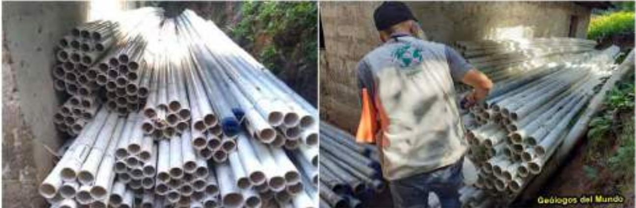
Figura 82.-Acopio de tubería PVC y HG para la instalación de la línea de conducción. Se utilizaron tubería de 3" y 2" de diámetro, siendo la mayor parte de la línea de 2". Etapa COVID-19
