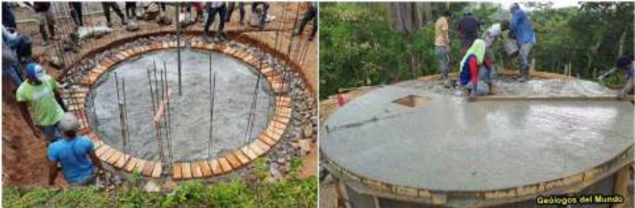
Figura 70.- Primera hilada de ladrillos de las paredes y fase del fundido de la losa superior. Etapa COVID-19
