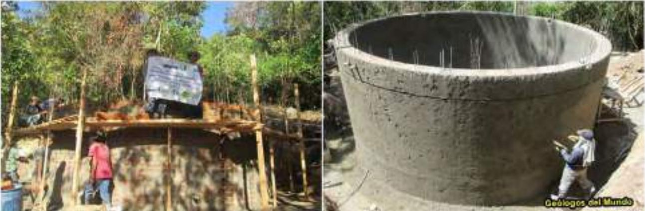
Figura 65.- Construcción de las paredes. A la derecha en proceso del repellado exterior y con el interior ya repellado y preparado para un pulido. Etapa Pre-COVID-19.
