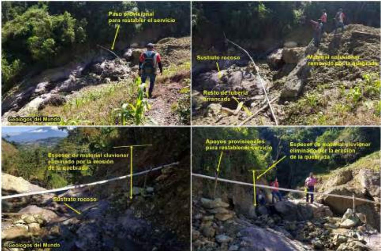
Figura 161.- Diferentes vistas afecciones en la “quebrada seca” una vez disminuido su caudal. Se aprecia que de nuevo volvió a quedar seca pero con una considerable modificación erosiva de su perfil longitudinal y transversal.
