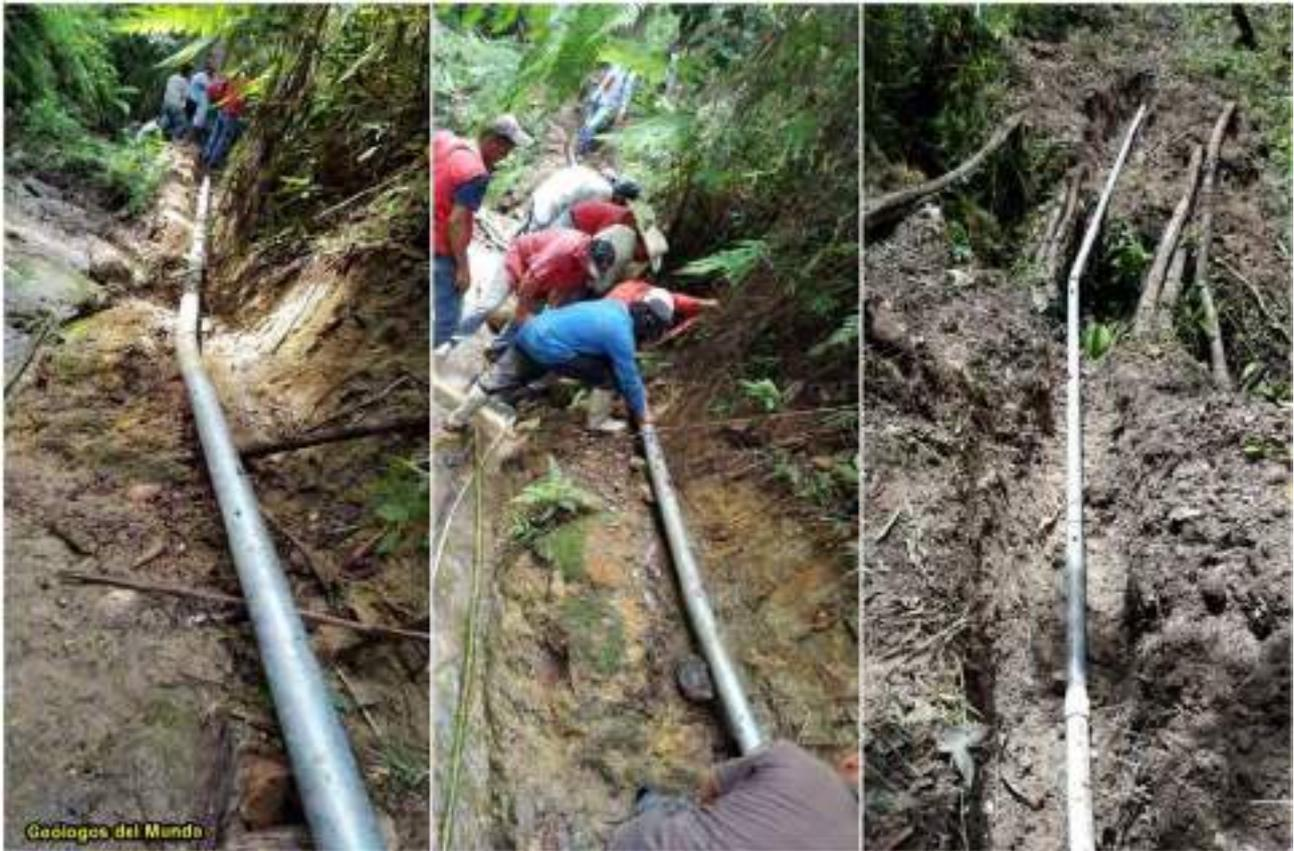
Figura 111.- Instalando la tubería de conexión obras toma-caja concentradora. Etapa Pre-COVID-19.
