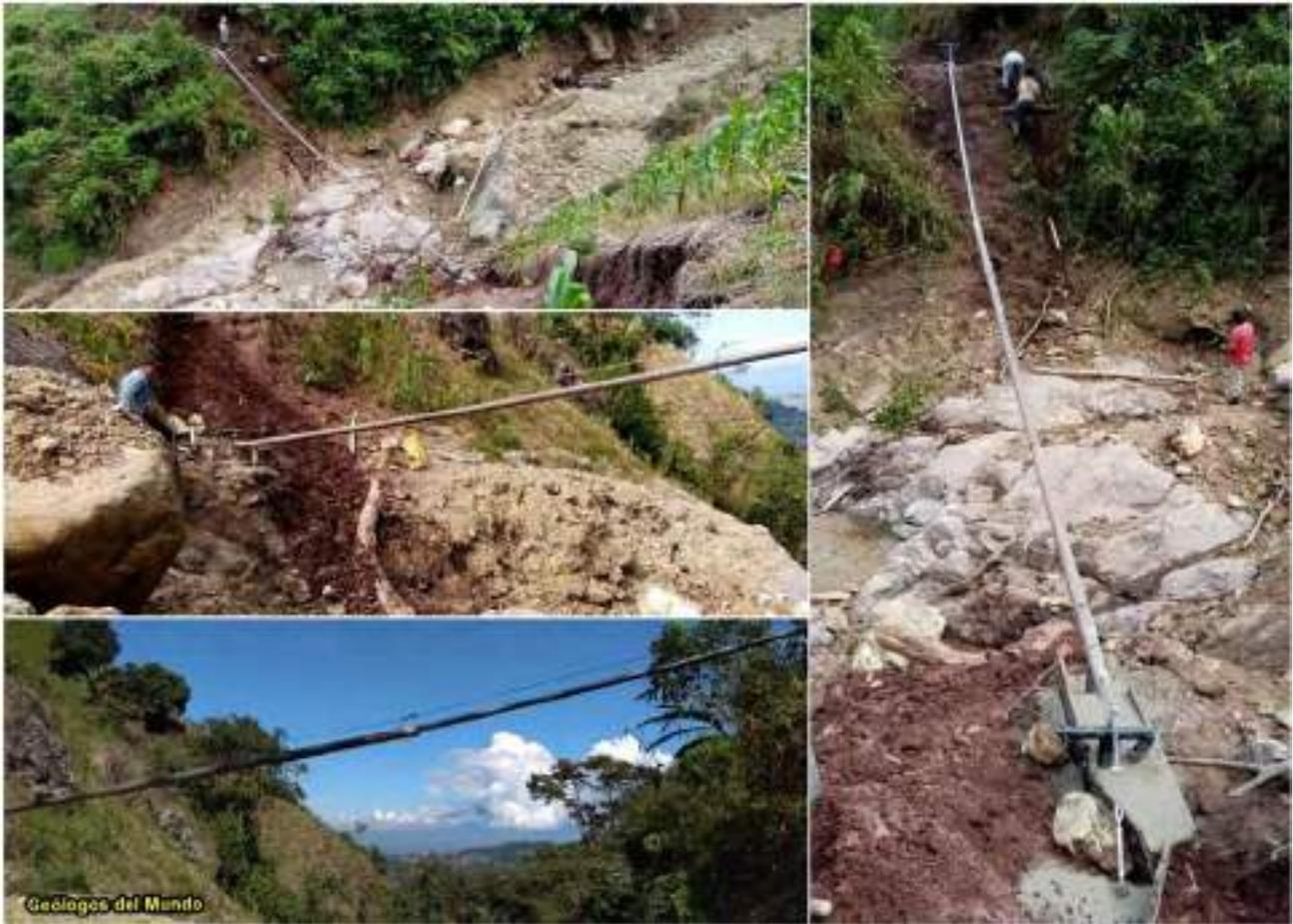
Figura 165.- Otro de los pasos aéreos para el que, por su longitud, fue utilizado soportes anclados y cable de acero tensado. Actuaciones de paso en la “quebrada seca” donde inicialmente se había realizado u paso aéreo más corto y simple.
