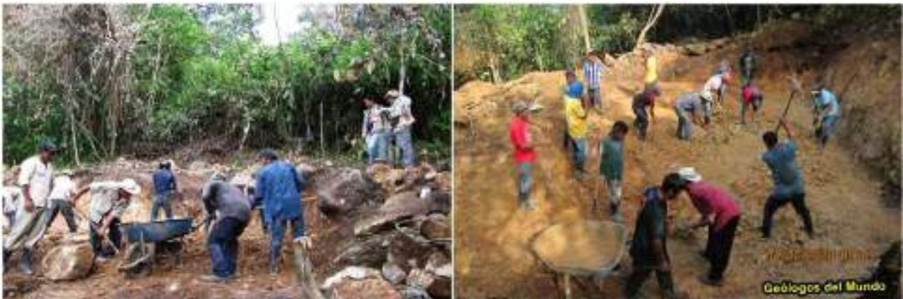
Figura 60.- Excavación de nivelación para la obtención de un plantel desde cuya rasante se procede a la excavación de cimentación. Etapa Pre-COVID-19.
