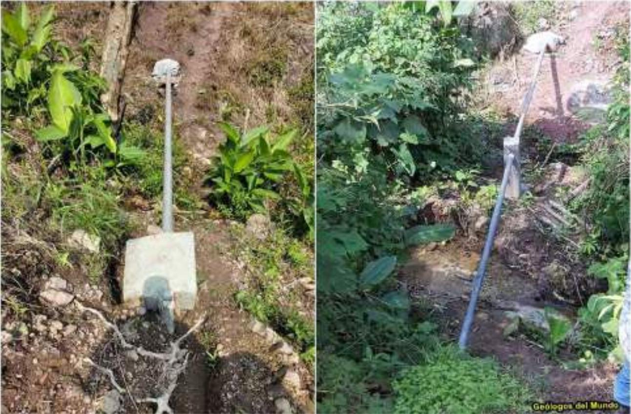
Figura 88.- En función del tipo y longitud de las quebradas se utilizaron diferentes tipologías de pasos aéreos, desde simples apoyos con anclajes , anclajes y puntos intermedios de apoyo, y paso aéreo con cable como en el caso del relieve a salvar sobre el Río Blanco. Etapa COVID-19.
