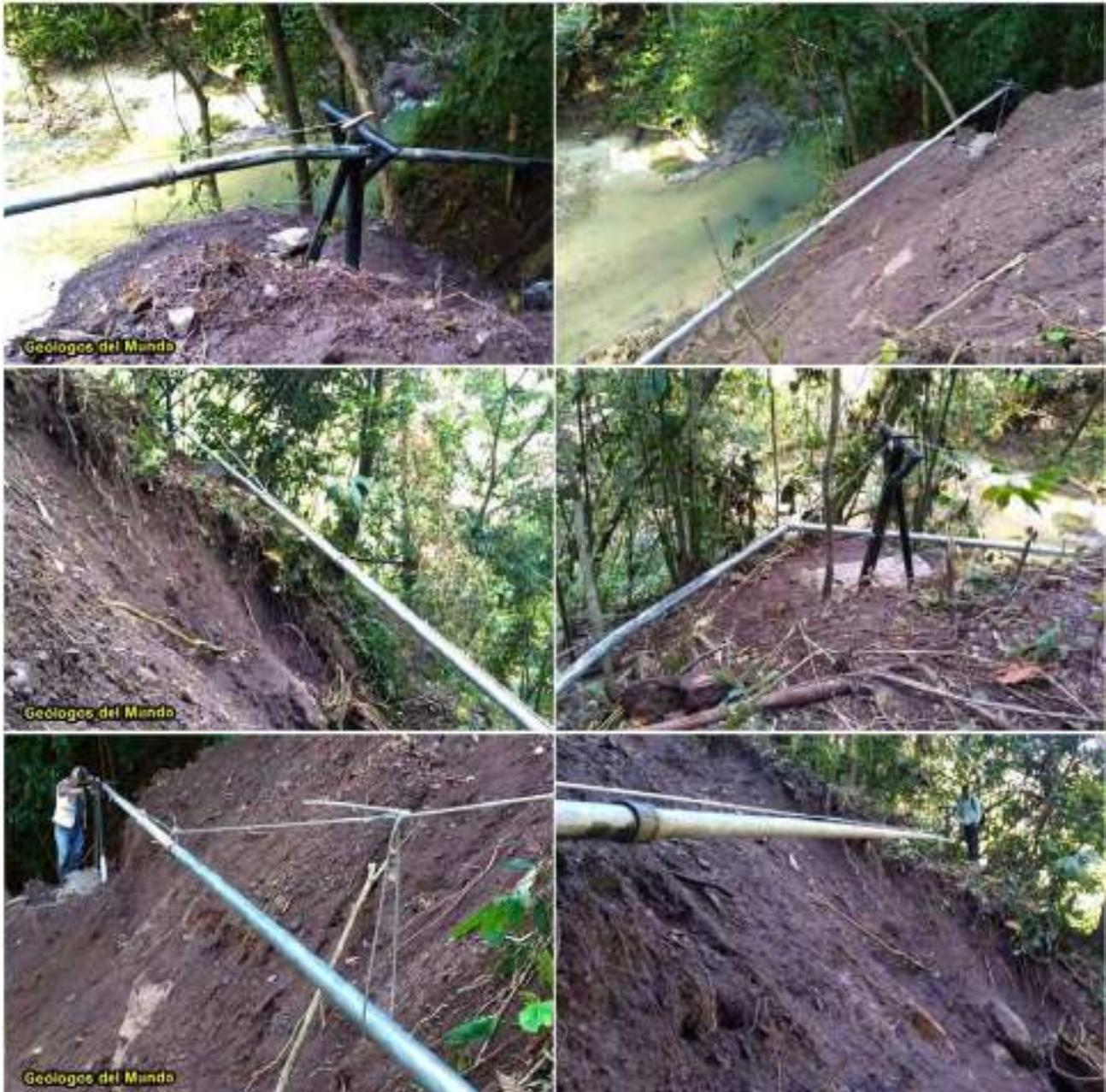
*Figura 164.- Diferentes imágenes de la reposición de la línea mediante un paso aéreo de cable. Se observa el corte del gran deslizamiento sobre el Río Blanco que fue necesario salvar mediante la estructura colgante.*
