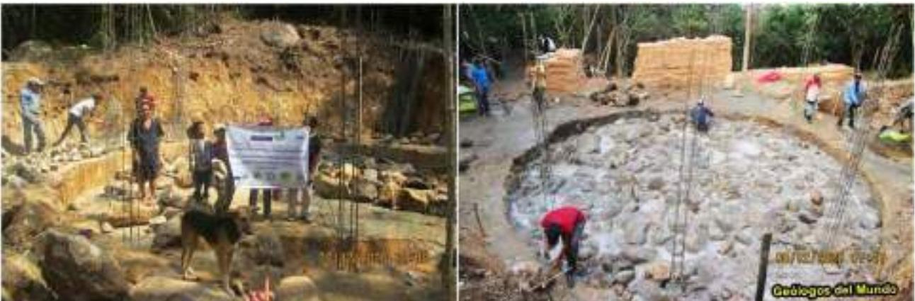
Figura 63.- Cimentación. A la izquierda los castillos, y a la derecha la losa de hormigón ciclópeo. Se observa las armaduras de los castillos y columna central ya instalada. Etapa Pre-COVID-19.
