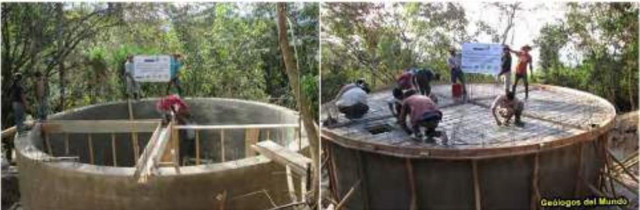
Figura 66.-Encofrado de las vigas y armado de la losa de cierre del depósito sobre el encofrado correspondiente. Etapa Pre-COVID-19.
