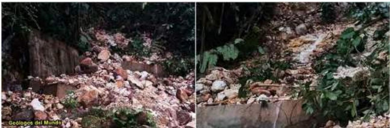
Figura 162.- Avalancha de rocas sobre la estructura de la obra toma. Las torrenciales lluvias y las fuertes pendientes hicieron que se desestabilizara por encima de la obra toma un coluvión, formado por bloques, gravas y materiales finos, que se precipitó sobre la estructura de captación construida; en la imagen se observan los grandes bloques que no pudieron ser arrastrados por el agua.
