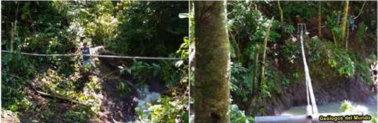
Figura 90.- Instalación del paso aéreo sobre el río Blanco. Es el punto más bajo de la línea en el que las fuertes pendientes de bajada y de subida crea grandes presiones en la tubería. Etapa COVID-19.
