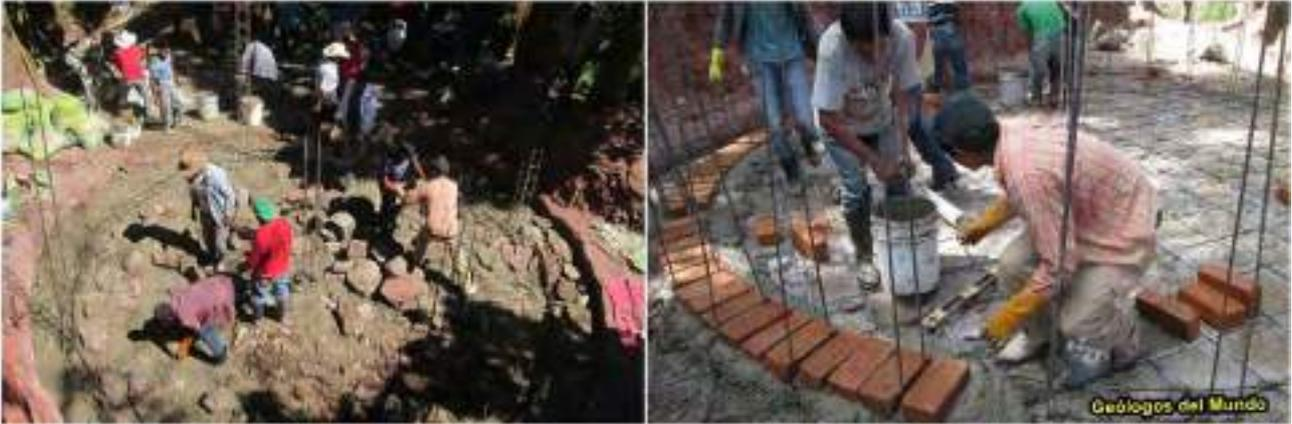
Figura 96.- Cimentación y colocación del arranque de las paredes. Etapa Pre-COVID-19.
