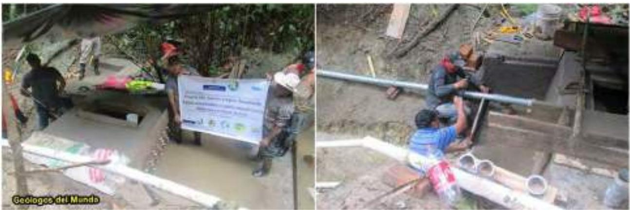
Figura 105.- Fase ya avanzada de la construcción B2. En la imagen inferior derecha colocando el tubo se salida de 3" que llevará el agua captada hacia la caja concentradora.. Etapa Pre-COVID-19.
