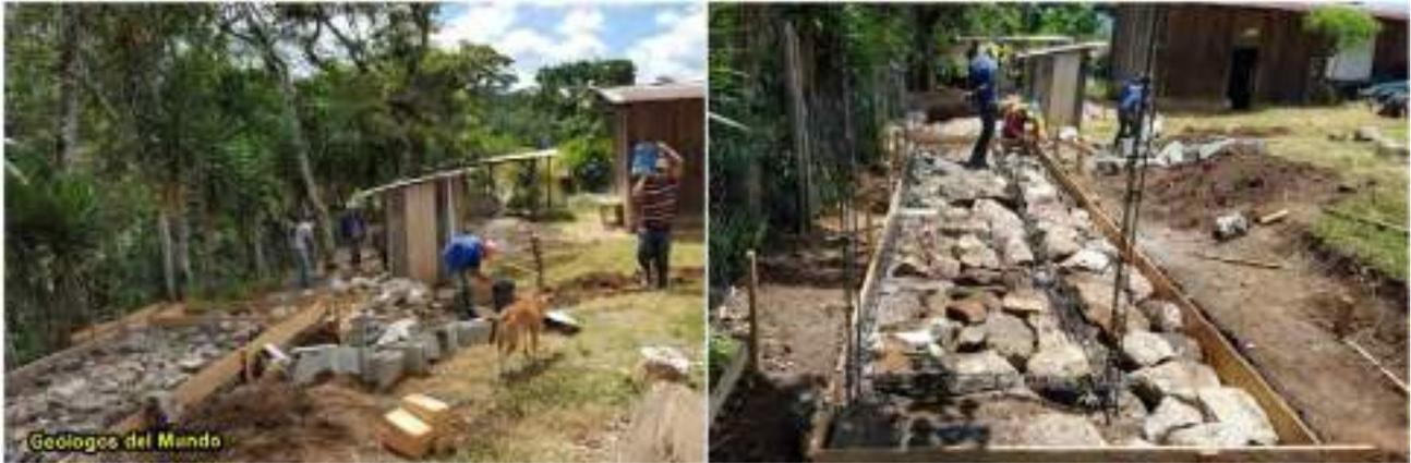
Figura 127.- Construcción de la cimentación. Al fondo se puede ver las estructuras de madera de las letrinas a las que van a sustituir los módulos. Etapa COVID-19.
