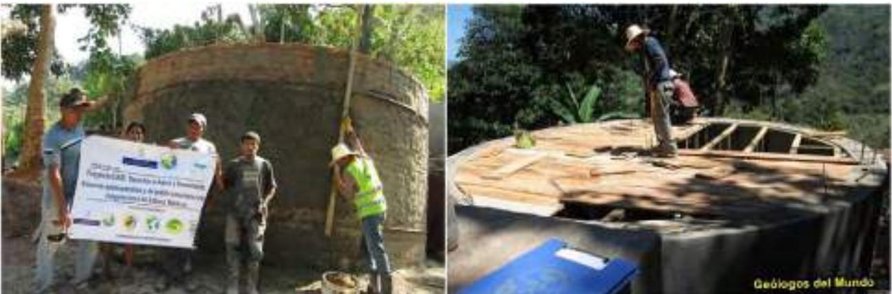
Figura 97.- Paredes ya finalizadas y en proceso de repello exterior. A la derecha, encofrando para el fundido de la losa superior. Etapa Pre-COVID-19.
