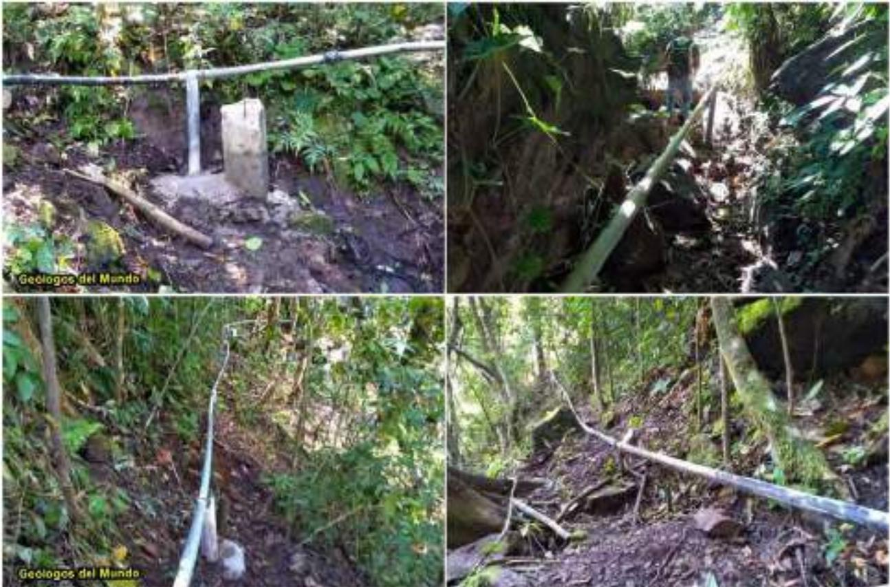
Figura 167.- Diferentes tramos de tubería restituida sostenida por apoyos y anclajes.
