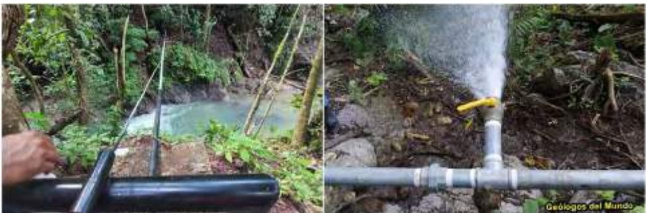
Figura 92.- Paso aéreo sobre el Río Blanco ya finalizado y puesto en servicio; a la derecha el agua del circuito saliendo por la válvula de limpieza. Etapa COVID-19.
