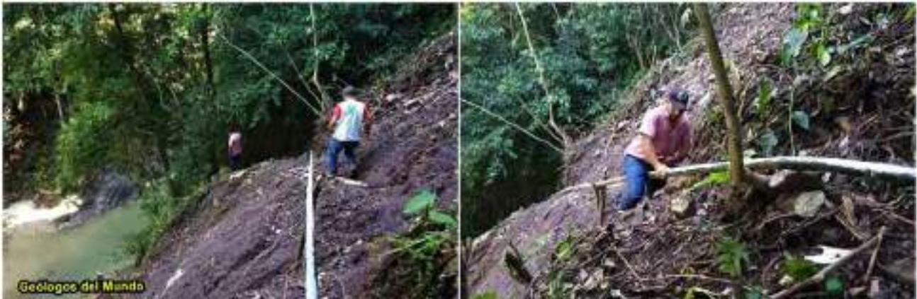
Figura 158.- Vista del deslizamiento de tierra en el punto 1 que cortó la línea de conducción. En la imagen se observa una tubería instalada temporalmente para reanudar el servicio en espera de las actuaciones de reposición.
