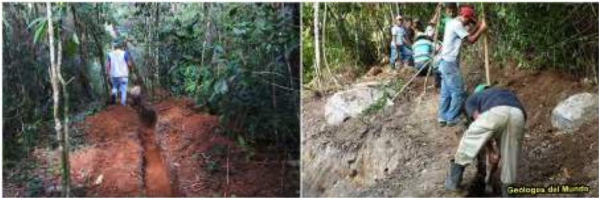
*Figura 58.- Zanjeo para la Instalación de línea de conducción con todos sus accesorios. Etapa Pre-COVID-19.*
