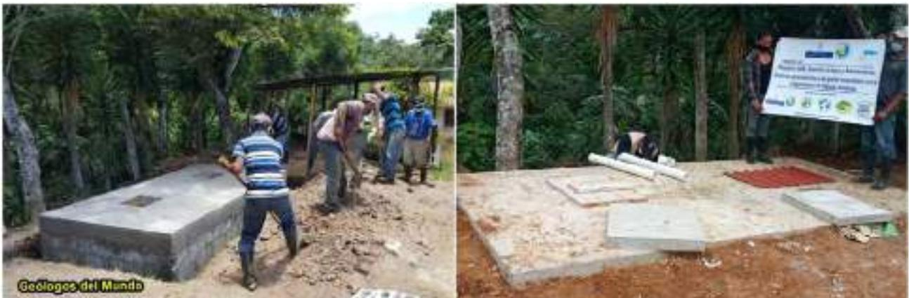
Figura 134.- Fosa séptica ya finalizada. Realizando el trasdosado y aterramiento de la fosa.
