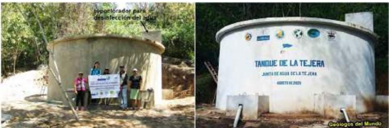
Figura 69.- Depósito de almacenamiento y distribución de agua potable de 20.000 galones de capacidad ya finalizado, pintado y con rotulado identificativo en el que figuran los diferentes participantes en el proyecto. Etapa Pre-COVID-19.
