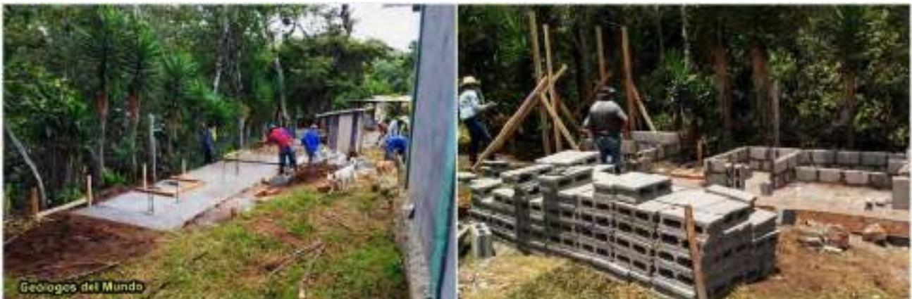
Figura 128.- Solera sobre cimentación para el arranque de las paredes y fase de levantado de paredes del conjunto de módulos. Etapa COVID-19.
