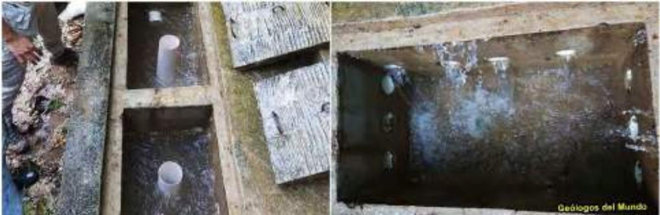
*Figura 80.- Obra toma en funcionamiento. Se observan dos tubos verticales que corresponden al rebose y limpieza de sendas cámaras. A la derecha entrada de agua a la cámara concentradora. Etapa Pre-COVID-19.*
