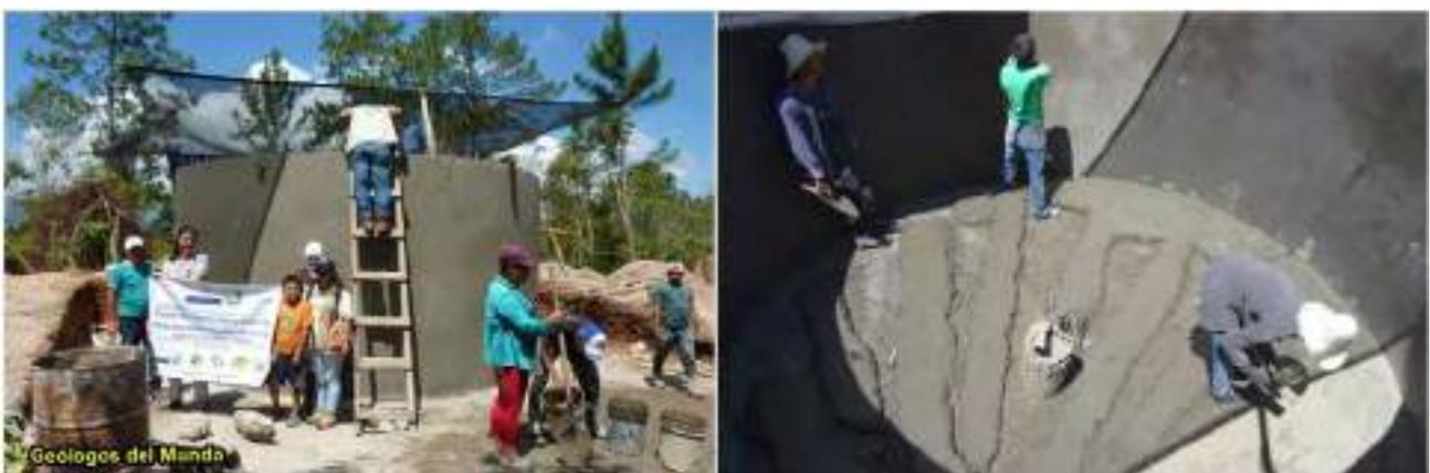
Figura 117.- Paredes del depósito ya repelladas interna y externamente. A la derecha construyendo el piso sobre la solera. Etapa Pre-COVID-19.
