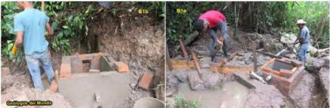
Figura 101.- Construcción de la obra toma B1 en El Pacayal. A la izquierda recogida de un alumbramiento de agua (B1b) que tributará a la obra toma principal B1a. Etapa Pre-COVID-19.
