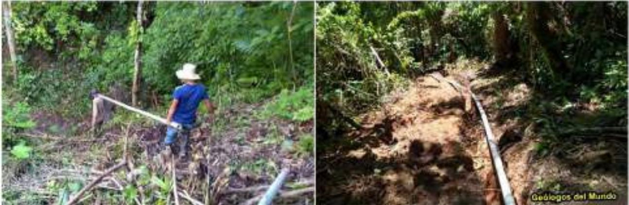
Figura 85.- El porteo de la tubería y del resto de materiales necesarios (accesorios, cable de acero, cemento, arena, grava) se realizó a lomos de las personas de la comunidad por caminos y pasos de gran dificultad. Etapa COVID-19.
