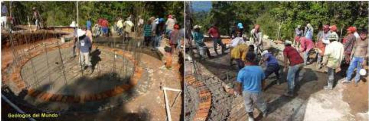
Figura 115.- Primera hilada de ladrillos, que serán el arranque de las paredes, y procediendo al fundido de la solera armada. A la derecha los miembros de la comunidad colaborando activamente como mano de obra no cualificada. Etapa Pre-COVID-19.
