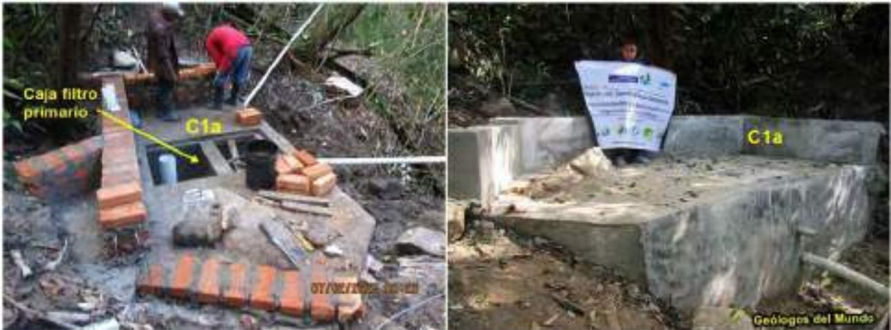
Figura 52.- Obra toma C1a en fase de construcción y una vez finalizada a falta de limpieza y reposición del lugar. Etapa Pre-COVID-19.
