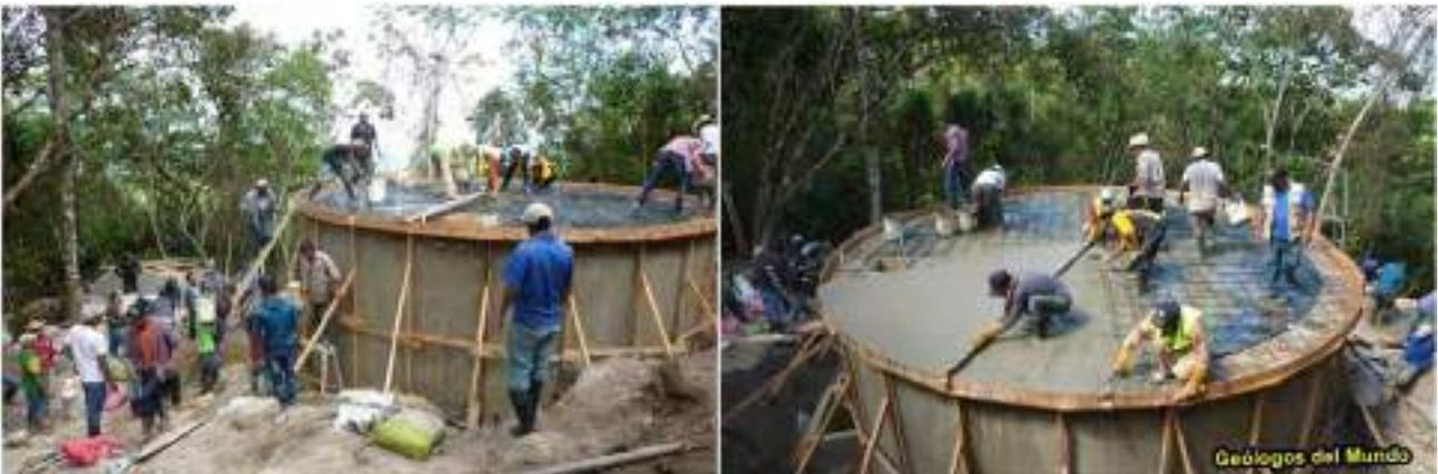
Figura 67.- Fundido de hormigón de la losa superior de cierre del depósito. Todas las operaciones se realiza totalmente a mano, con lo que la participación de trabajo comunitario es fundamental ya que hay que fundir lo más rápido que se pueda. Etapa Pre-COVID-19.
