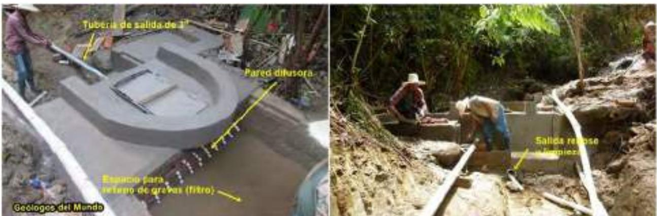
Figura 106.- Una fase más avanzada de la construcción en donde se observa una estructura en forma de herradura destinada a derivar lateralmente en agua de la quebrada en avenidas para proteger el interior de la captación; así mismo la pared difusora para de entrada del agua. Etapa Pre-COVID-19.
