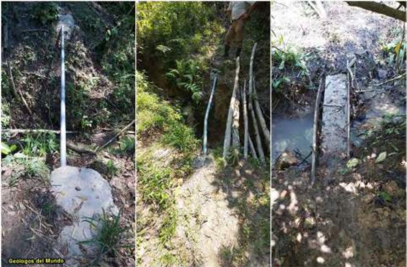
Figura 113.- Pasos aéreos recubrimiento de tubería en pequeñas quebradas. Etapa Pre-COVID-19.
