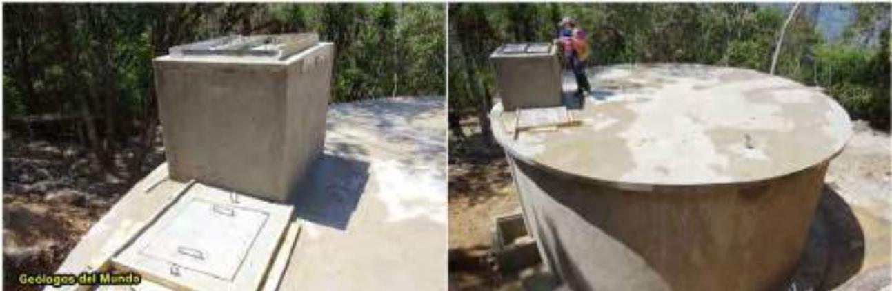
Figura 68.- Hipoclorador por goteo ya finalizado junto a la tapa de inspección del depósito. El hipoclorador es el elemento destinado a la desinfección mediante cloro del agua del depósito.
