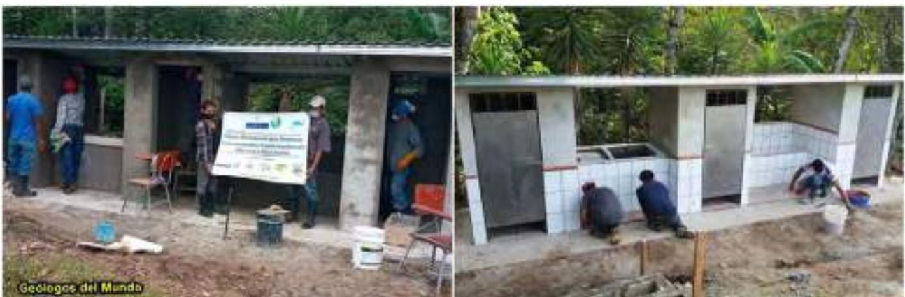
Figura 129.- Fases de finalización de repellado y de colocación de cerámica con las puertas metálicas ya colocadas e igualmente instalada la cubierta de lámina de la techumbre.. Etapa COVID-19.
