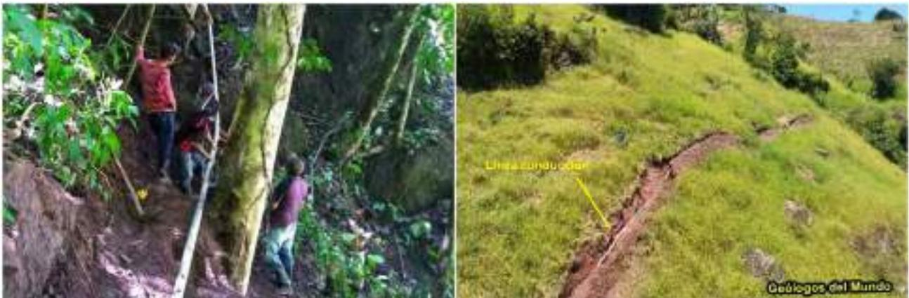
Figura 86.- Instalación en superficie con tubos HG, e instalación en zanja con tubos de PVC. El relieve complicado y la dificultad de zanjeo fueron dos constantes que obligaron a grandes esfuerzos para la instalación. Etapa COVID-19.
