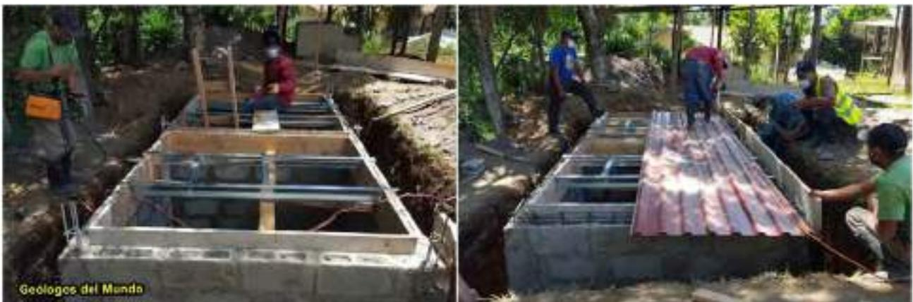
Figura 133.- Paredes de la fosa ya lantadas y realizando en encofrado perdido para el funcido de la losa de su cierre superior. Se utilizaron perfiles metálicos soldados y lámina ce zinc. Etapa COVID-19.
