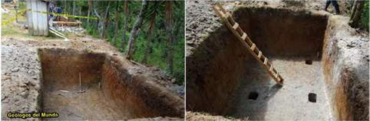
Figura 132.- Excavación de la fosa y pozos para la cimentación de los castillos. Etapa COVID-19.
