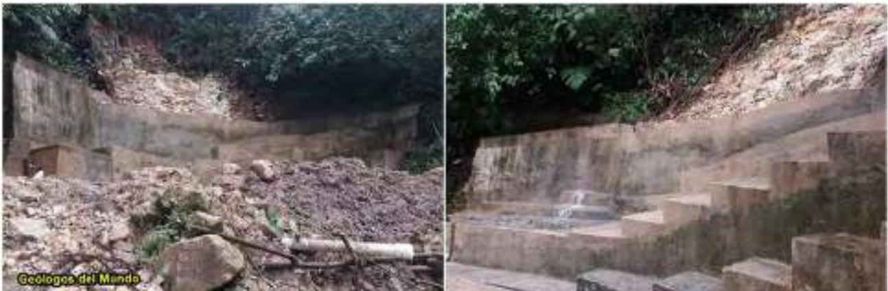
Figura 168.- Obra toma una vez realizado el desescombro del material de bloques que la cubrió. Se puede observar la ausencia de daños estructurales y funcionales. Tan solo se repuso un tramo de la tubería de salida a conducción y la parte exterior del sistema de limpieza.
