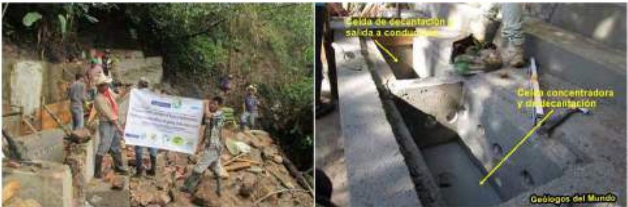
Figura 78.- Fase de construcción. A la derecha el detalle de las dos cámaras (concentradora y decantadora) que quedan practicable para las labores de mantenimiento y limpieza. Etapa Pre-COVID-19.
