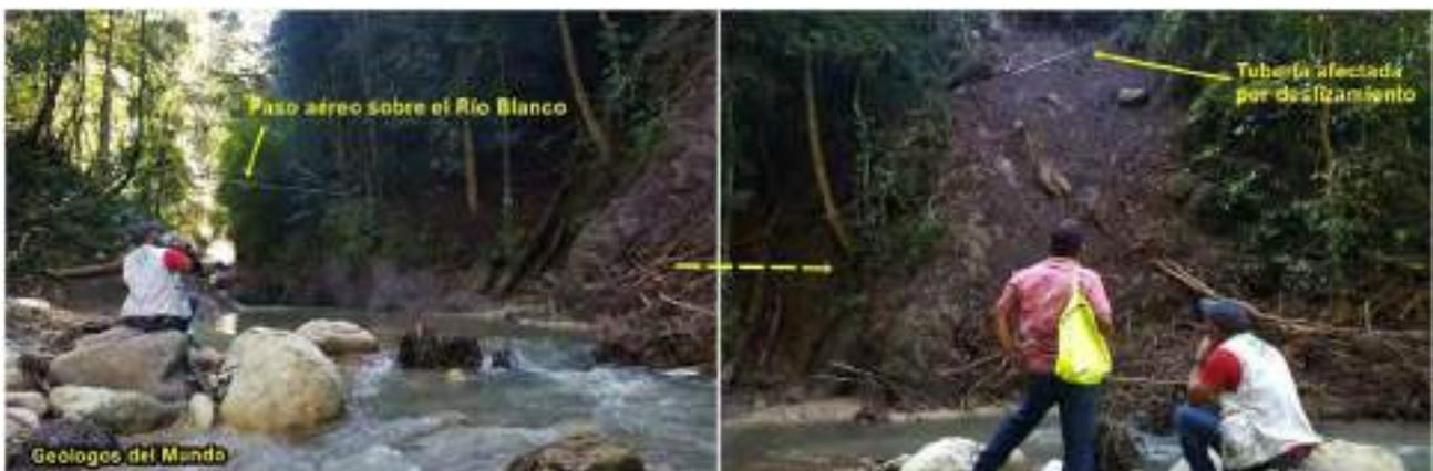
Figura 157.- Afecciones a línea de conducción en el punto 1 debido a un corrimiento de tierra que arrastró la tubería instalada.
