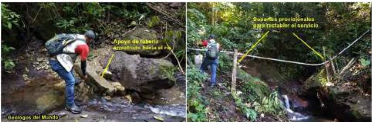
Figura 159.- Afecciones a soportes para la instalación de tubería aérea.
