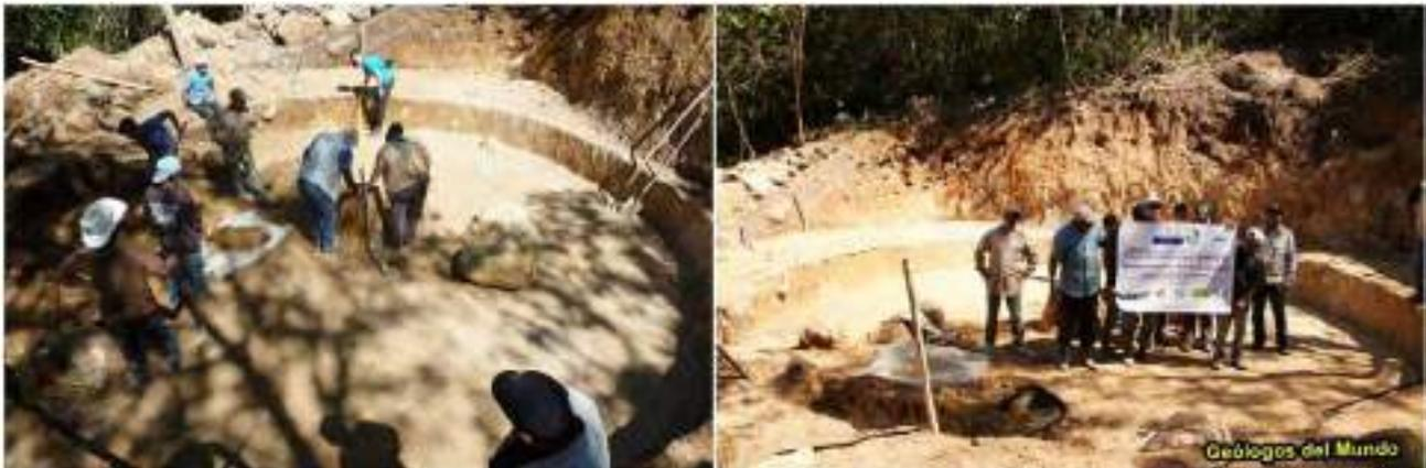
Figura 61.- Excavación de cimentación ajustada ya a la geometría circular de la losa. Etapa Pre-COVID-19.
