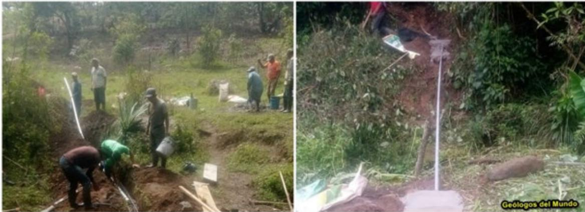
Figura 19.- Instalación de tubería de conducción. En su mayoría mediante tubos de PVC, aunque en localizaciones concretas con pasos aéreos o en recubrimiento bajo cauces se utilizó tubería de HG (hierro galvanizado).
