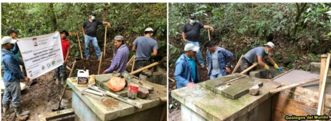
Figura 9.- Construcción de la nueva captación de agua. Se observa la obra toma antigua que siguió dando servicio hasta la finalización de la nueva para evitar el corte de suministro a la comunidad.
