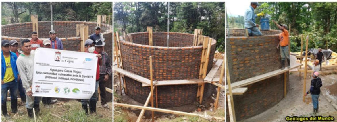
Figura 14.- Levantado de las paredes. Etapa de fundido de los castillos. A la derecha, los castillos ya fundidos y desencofrados, se procede al inicio del repello interior.
