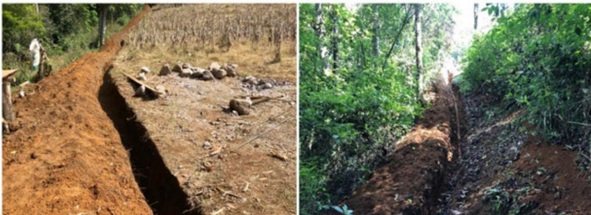
Figura 18.- Zanqueo para la línea de conducción. Fue realizada íntegramente por medios manuales como trabajo comunitario. El total zanqueado fue de 552 metros lineales.
