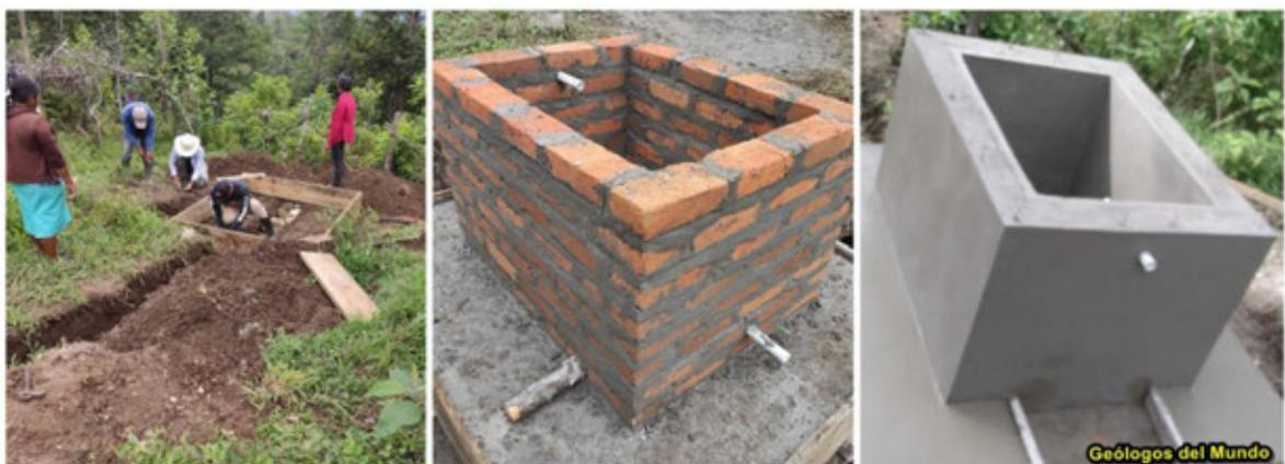
Figura 28.- Estructura rompecarga en tres etapas de construcción.
