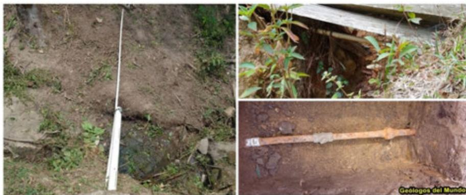
Figura 22.- Estado de la línea de distribución existente a sustituir.
