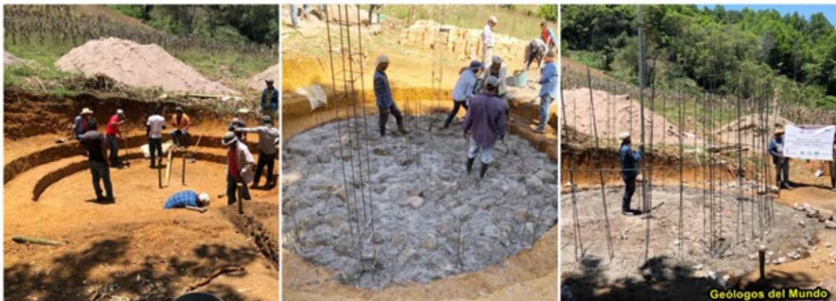
Figura 12.- Etapa de cimentación. A la derecha, excavación de cimentación. En el centro, cimentación con losa ciclópea; se observan las armaduras de los castillos perimetrales. A la derecha, cimentación ya terminada con la solera armada; se observa todo el entramado de hierro vertical que forma parte del armado de las paredes.
