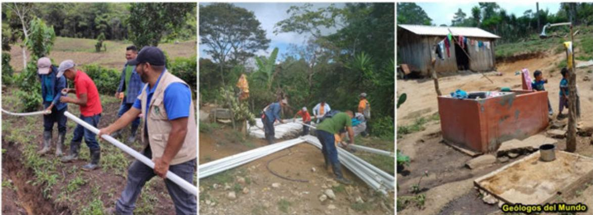
Figura 27.- instalación tubería de distribución. A la derecha, derivación para acometida domiciliaria.
