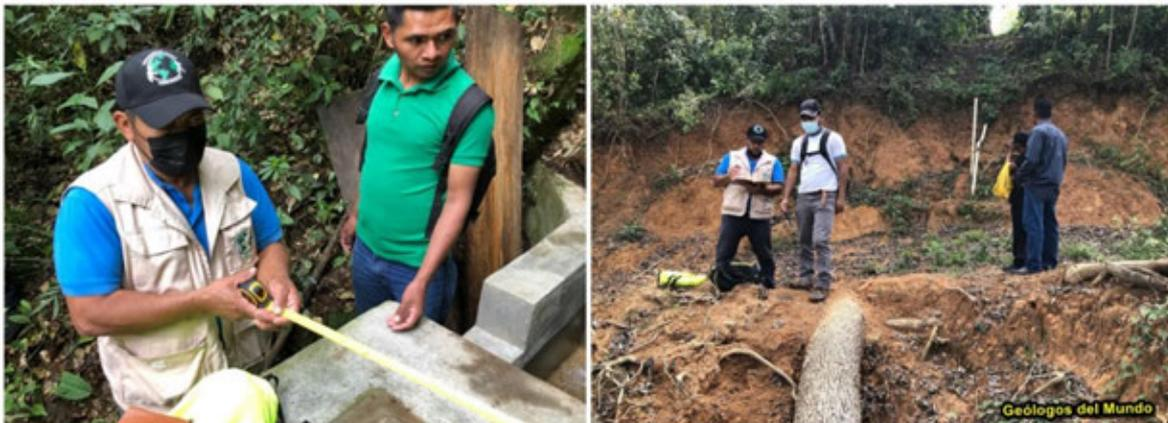
*Figura 5.- Replanteo en campo de las actuaciones. Maestro constructor y TRC municipal recorren las ubicaciones de las infraestructuras y ajustan las mediciones consensuando con líderes comunitarios.*
