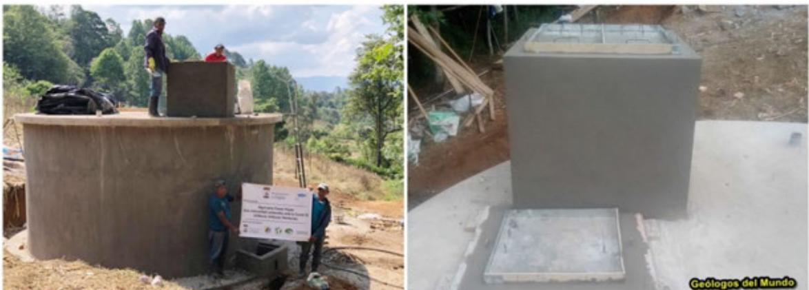
Figura 16.- Hipoclorador sobre losa del depósito.
