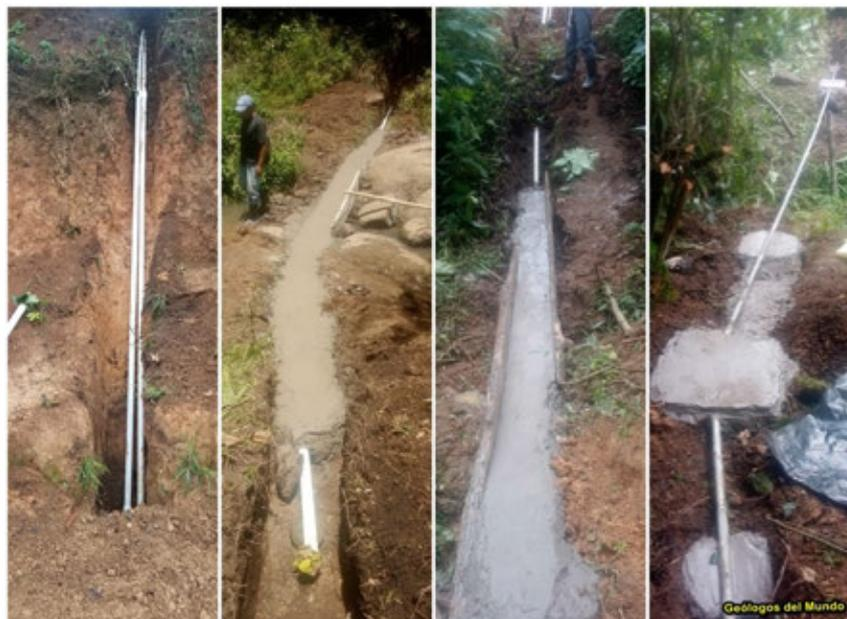
Figura 21.- Tubería doble (depósito nuevo y depósito antiguo); pasos recubiertos armados en quebradas y pasos aéreos con soportes, anclajes y dados.
