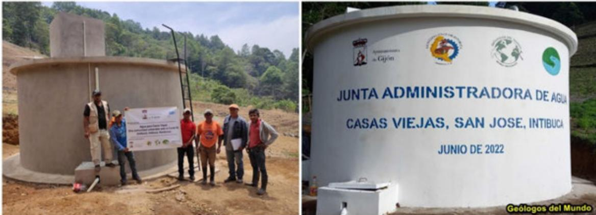
Figura 17.- Depósito e hipoclorador terminados y conectados. A la izquierda se observa otros elementos: acera perimetral, caja de protección de válvulas y escalera de acceso a clorador. A la derecha, el depósito ya pintado y rotulado.
