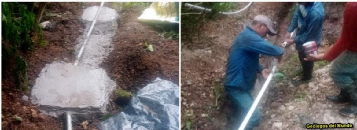
Figura 20.- Izquierda, anclajes y dados soporte de hormigón en pasos aéreos con tubería de HG. Derecha, instalación en zanja de tubería de PVC.
