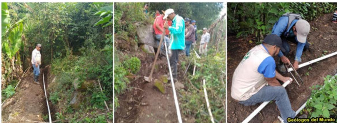
Figura 25.- Instalación de tubería de distribución.
