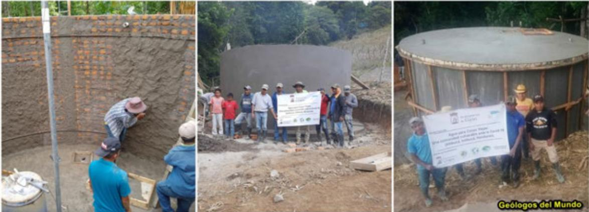
Figura 15.- Repello de paredes y fundido de losa superior. A la izquierda, paredes en fase de repello con mortero; en el interior sobre el repello se realiza un pulido o afinado con lechada de cemento. En el centro, paredes acabadas. A la derecha, losa superior de cierre ya fundida con hormigón armado.
