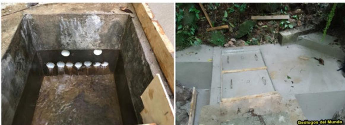
Figura 10.- Entrada de agua en la caja toma concentradora. A la derecha, aspecto de la obra ya finalizada.
