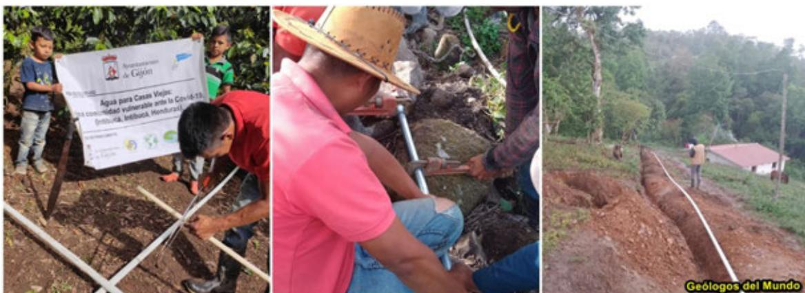
Figura 26.- instalación de tubería de distribución. En el centro, instalando tubos HG.
