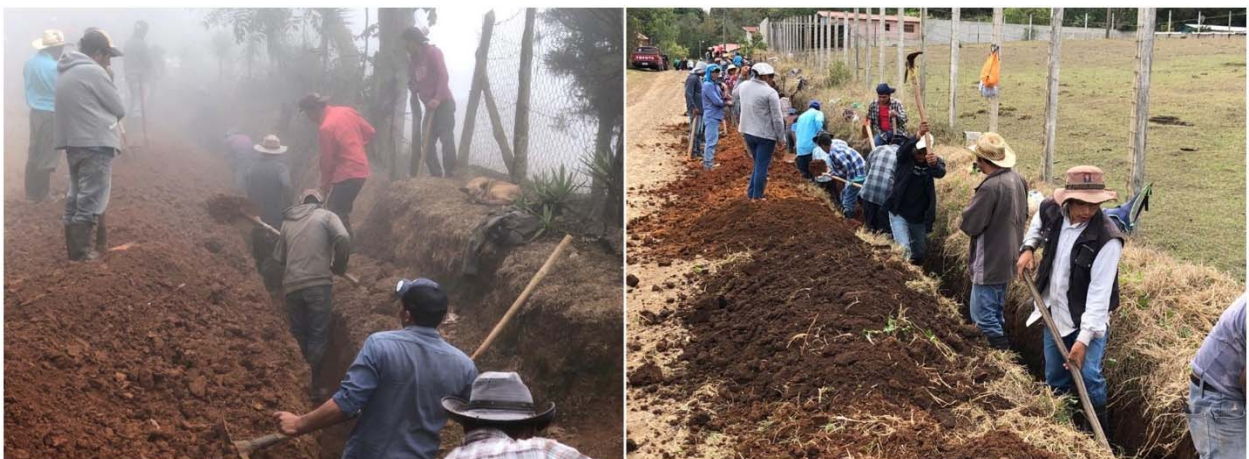
Figura 15.- Trabajo comunitario de apertura de zanja.
