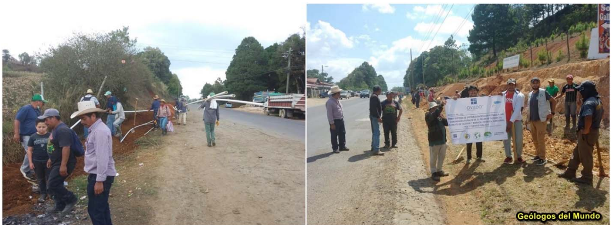
Figura 25.- Instalación de línea de distribución hacia Las Flores (El Pelón de Ologosí) con la traza paralela a calle pavimentada.
