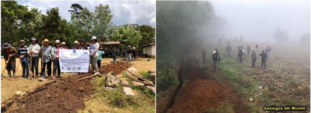
Figura 14.- En los grupos de trabajo participaron tanto mujeres como hombres abriendo zanja en una longitud de 11.900 metros.
