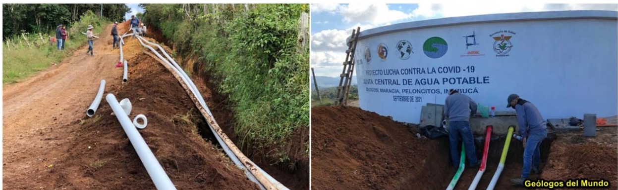
Figura 20.- Instalación de tubería de distribución desde el depósito de almacenamiento. Se marcan con colores las líneas para cada comunidad. El depósito de almacenamiento forma parte de las infraestructuras construidas durante la primera etapa de abastecimiento a estas comunidades con el proyecto cofinanciado por la AACD (2020), que incluyó además la captación y todo el sistema de bombeo para hacer llegar el agua al depósito.
