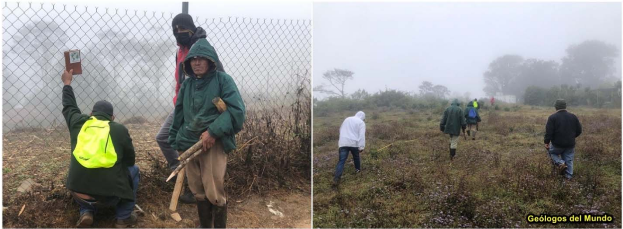
Figura 10.- Labores de replanteo de líneas de distribución y ubicación de fuentes comunales.
