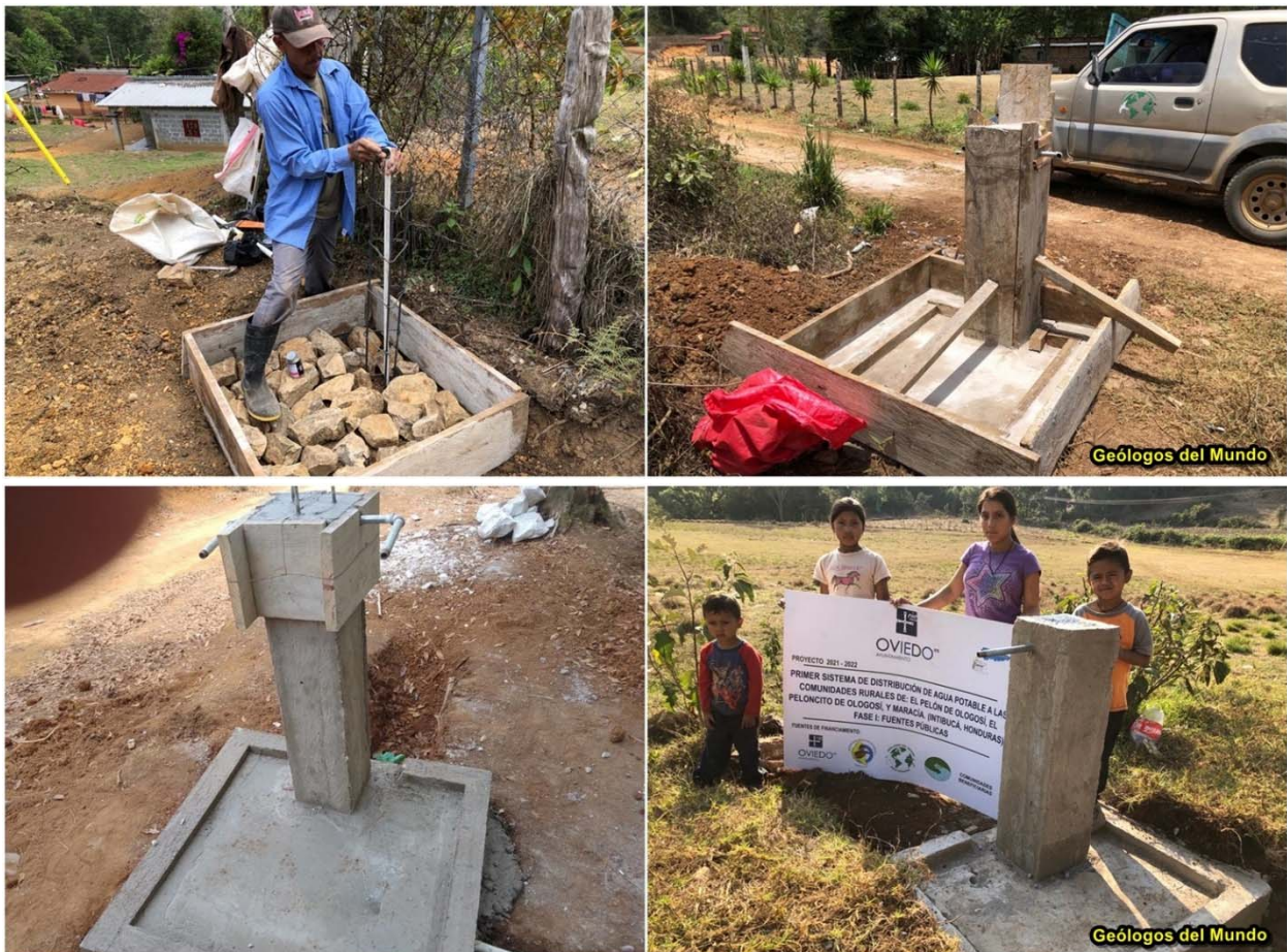
Figura 29.- Etapas de construcción de las fuentes comunitarias. Responden a una tipología simple de una columna fundida de hormigón de la que, según la población que atiende, dispone de dos (2) o un (1) caño provistos de su correspondiente grifo.
