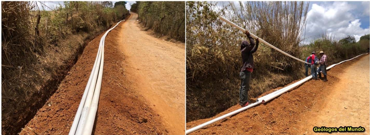
Figura 21.- Tuberías de 3 pulgadas dispuestas para ser introducidas en la zanja. En este caso se trata de un tramo del trazado común para las tres comunidades.
