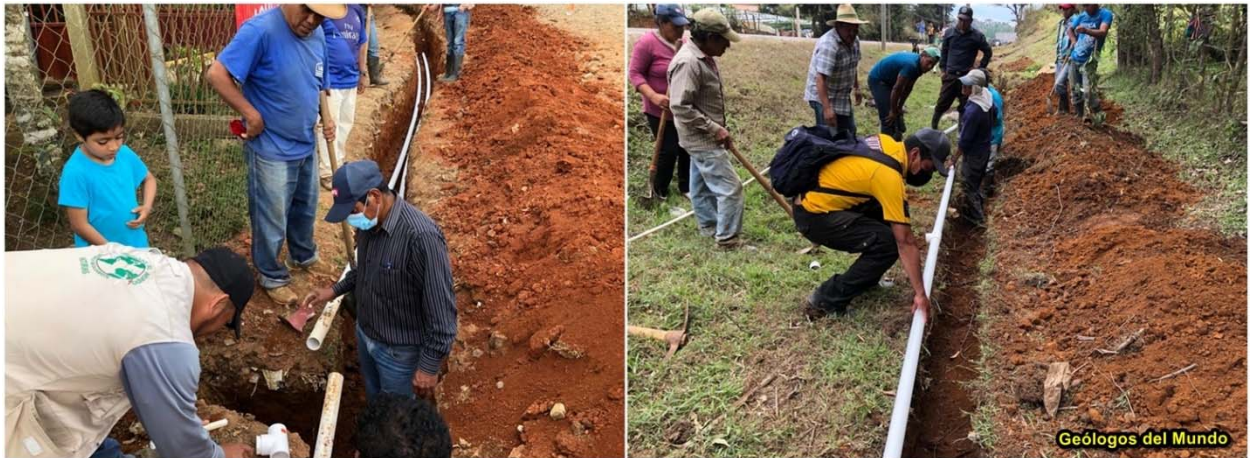
Figura 24.- Instalación de tubería y accesorios. Tubería de 2 pulgadas. A la izquierda tramo conjunto para dos comunidades (dos tuberías en zanja); a la derecha la distribución ya para una comunidad (una tubería en zanja).
