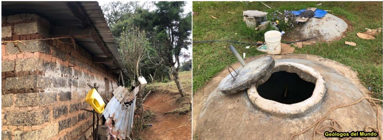
Figura 8.- Recogida de agua de lluvia de techumbre para ser almacenada aljibes enterrados ya totalmente obsoletos y muy difíciles de limpiar, con lo que su fondo está colmatado por sedimentos y materia orgánica.
