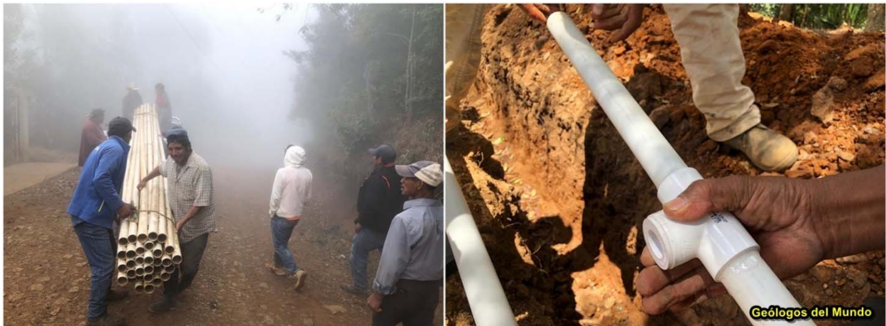
Figura 22.- Transporte la tubería a los puestos de trabajo y supuesta en obra. A la derecha, una tee y reductor para la derivación hacia una de las fuentes.
