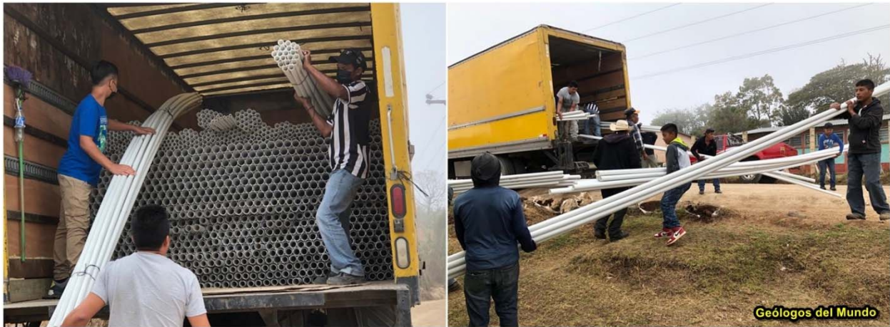
Figura 17.- Recepción de la tubería a instalar.
