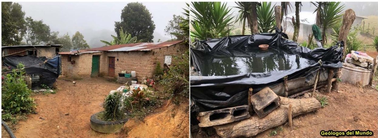
Figura 7.- Precario almacenamiento de agua de lluvia procedente de la techumbre de la vivienda. A la izquierda se puede observar la tipología de la techumbre a base de láminas de zinc en muy mal estado; el agua de lluvia recogida, además del sedimento fino del polvo acumulado y de los excrementos de aves, contendrá otros elementos químicos derivados de la alteración de las láminas, entre ellos hierro.
