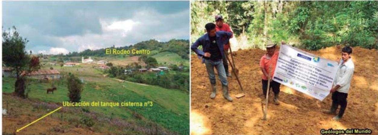
Figura 59.- A la izquierda, una vista desde la ubicación del tanque cisterna nº3 en la que se alcanza a ver la comunidad de El Rodeo Centro; por su posición relativa una parte de la comunidad puede ser servida ya por gravedad desde el tanque cisterna. A la derecha, realizando labores de excavación de explanación.
