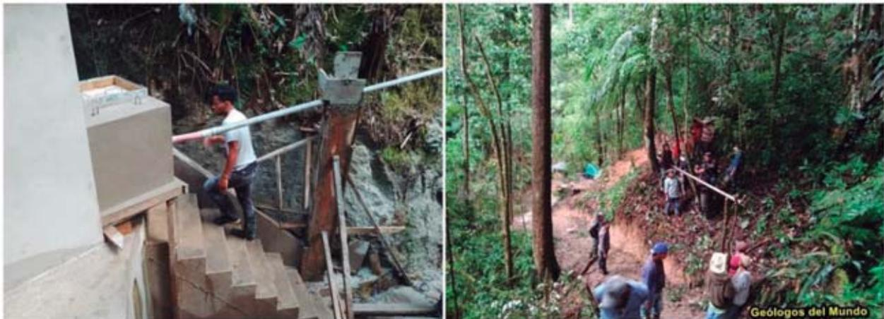
Figura 65.- instalación de tubería HG. A la izquierda, salida de la obra toma/bombeo 1.
