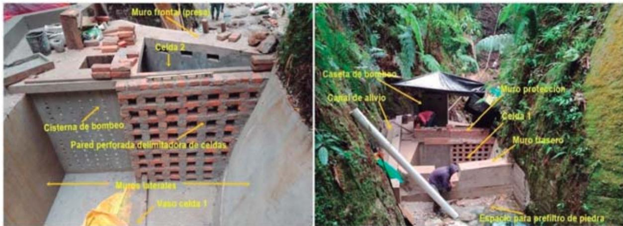
Figura 43.- Delimitación del vaso en dos celdas. La celda 1 fue rellena con bloques de piedra, coronada con gravas, que hace de filtro a la vez de evitar dejar un gran hueco con agua libre en el que pudieran caer animales o personas. La celda 2, se recubrió con una losa.
