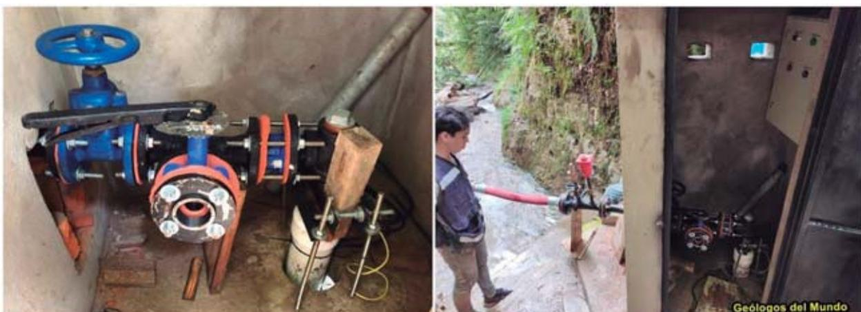
Figura 76.- Conjunto bomba - tren de descarga ya instalados en la cisterna n° 1 ubicada en la obra toma.
