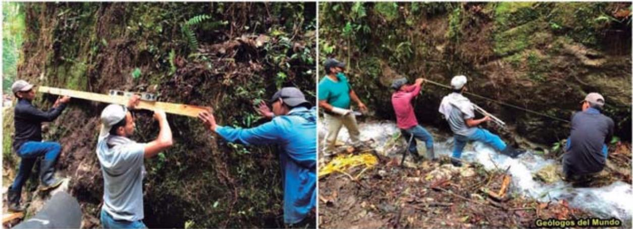
Figura 34.- Nivelación para altura de muros y excavación.
