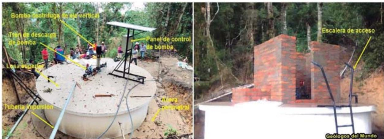
Figura 57.-A la izquierda, tanque cisterna nº2 ya finalizado y con la bomba ya instalada sobre su losa. A la derecha, la caseta de protección de la bomba en fase de construcción.
