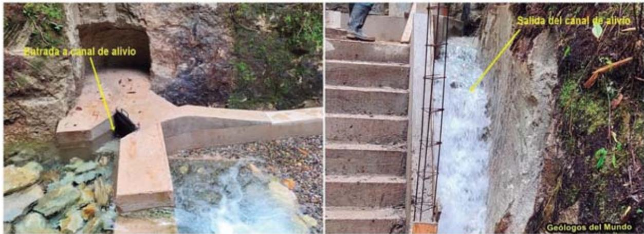
Figura 46.- Detalle de entrada y salida del canal de alivio.
