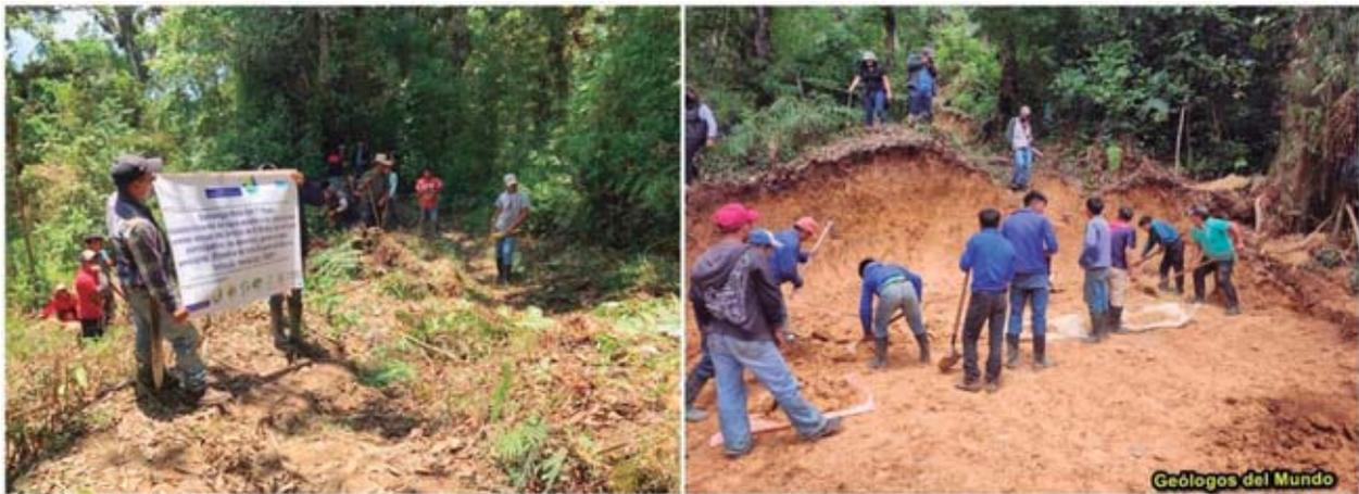
Figura 50:- A la izquierda, labores de desbroce y limpieza del área en la que se construyó la cisterna 2. A la derecha, labores de explanación de nivelación (plantel) a partir de la cual se marcó la excavación de enterramiento y cimentación.
