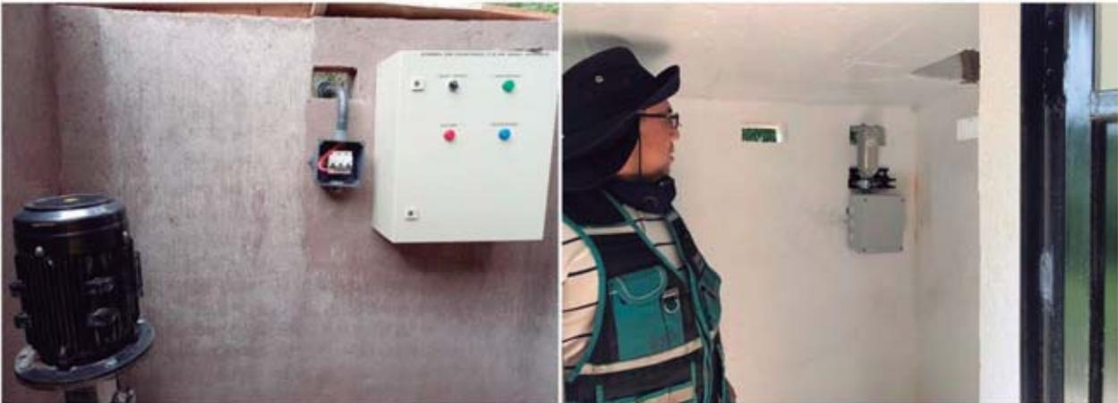
Figura 85.- A la izquierda, entrada de acometida eléctrica, panel de control y bomba nº 2. A la derecha entrada eléctrica para la bomba nº1.
