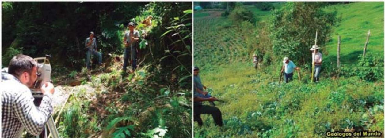
Figura 22.- Levantamiento topográfico de replanteo.
