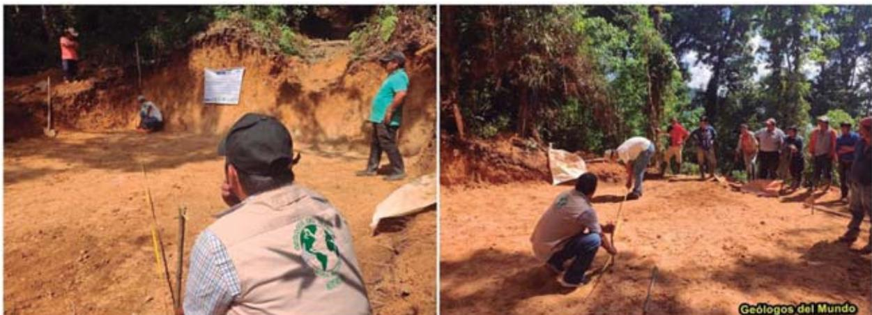
Figura 51.-Explanación de nivelación ya realizada. Sobre ella, el marcado del diámetro de excavación para la profundización de enterrado y para la cimentación.
