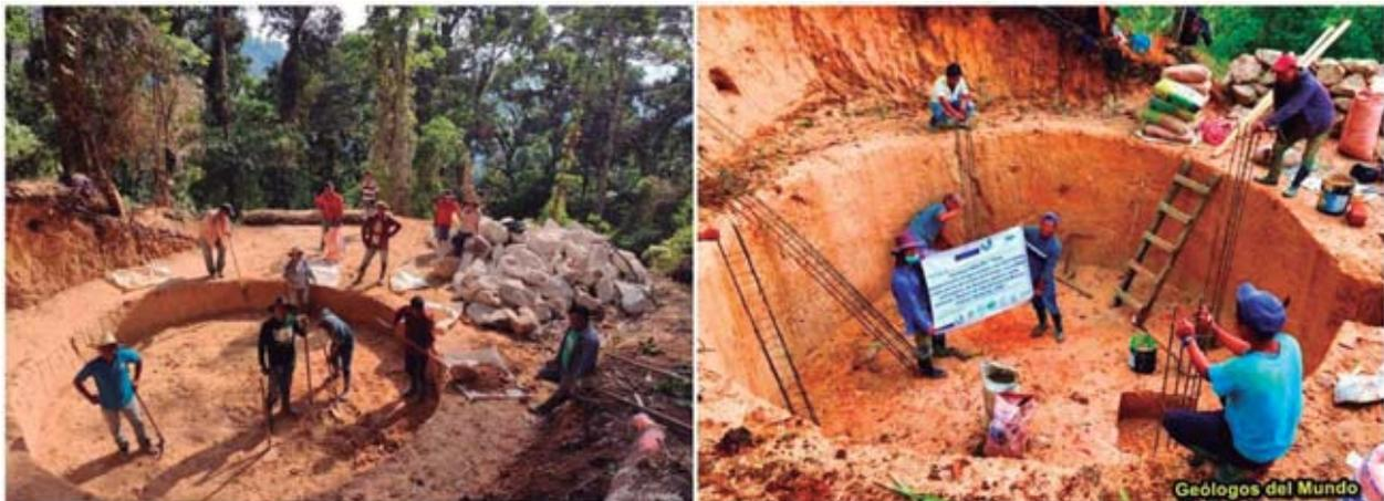
Figura 53.- A la izquierda, proceso de excavación de enterramiento y cimentación. A la derecha, la excavación alcanzada ya la rasante de cimentación e inicio de esta con la instalación del armado de los cuatro castillos perimetrales de refuerzo de las paredes.
