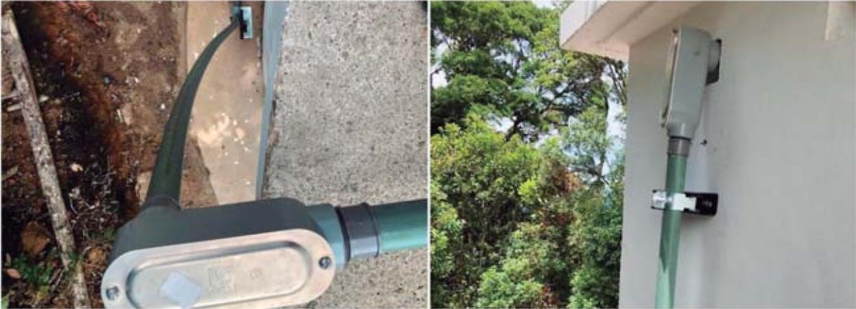
Figura 84.- Acometida eléctrica de entrada a caseta de bombeo 2.
