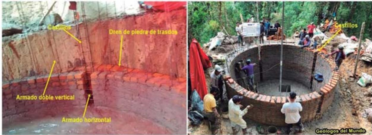
Figura 55.- Construcción de las paredes. A la izquierda paredes en el tramo enterrado; a la derecha, paredes ya en la parte aérea llegando a la altura final y a falta del fundido de los castillos.
