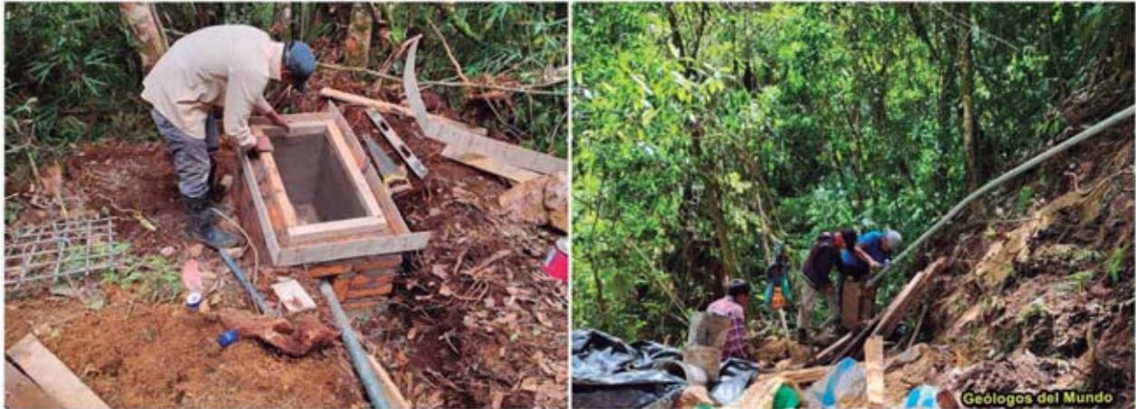
Figura 70.- en la instalación se intercalan válvulas de aire que van protegidas por cajas de obra.
