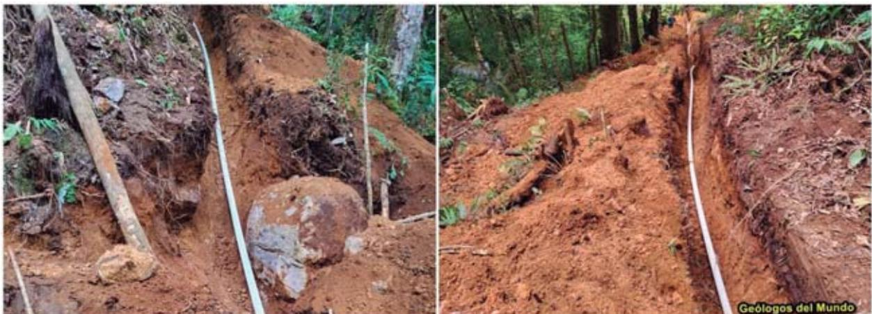
Figura 71.- Los tramos de tubería de PVC se instalan en zanja para su protección.
