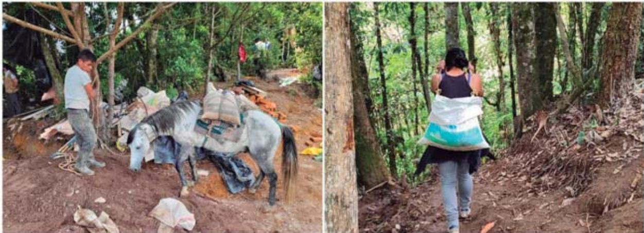
Figura 31.-Acarreo de materiales (piedra, arena, cemento, etc) hasta el puesto de trabajo.
