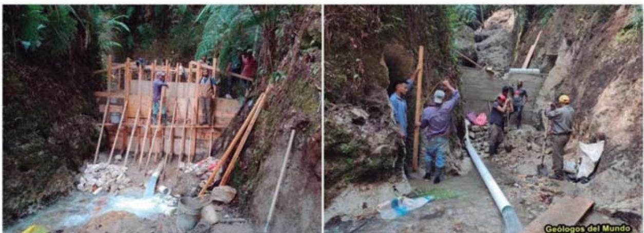
Figura 38.- Encofrado y construcción del muro trasero que delimitará el vaso. A la derecha, muro trasero ya desencofrado y los estribos del muro frontal (presa) ya excavados.
