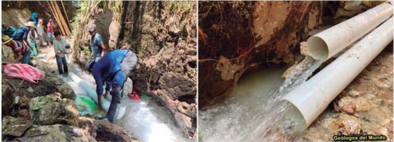
Figura 36.- Labores de drenaje del agua del área de trabajo mediante un entubado temporal.
