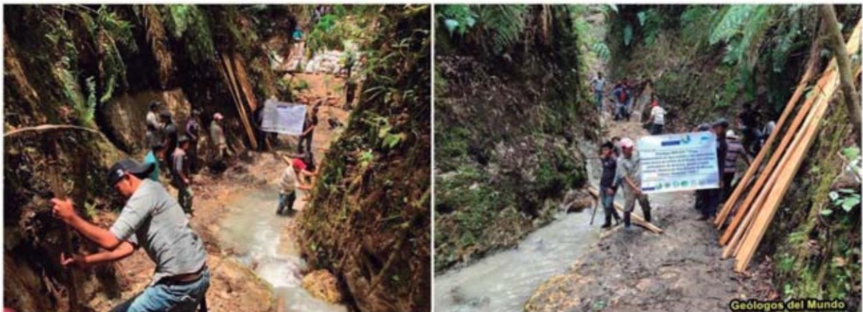
Figura 35.- Limpieza y sobreexcavación del espacio a ocupar por el vaso de la obra toma.
