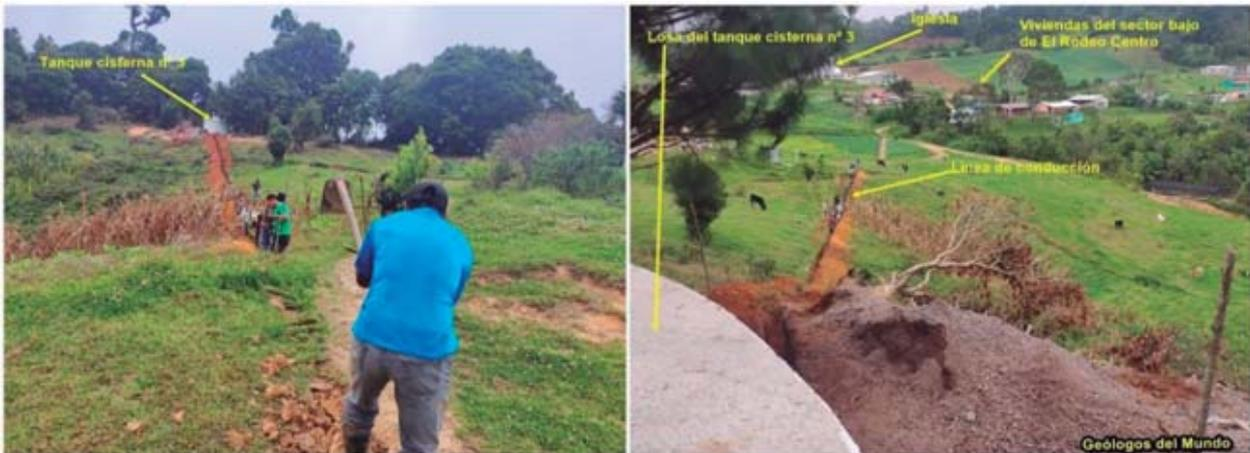
Figura 91.- Trazado de línea de conducción. Excavación de zanja e instalación.
