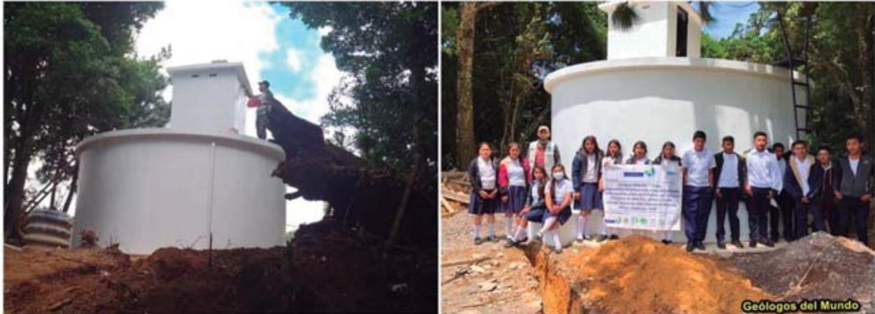
Figura 62.- Tanque cisterna nº3 ya finalizado y en fase de pintado.
