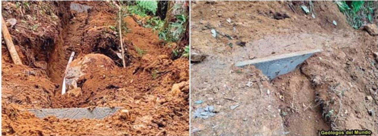
Figura 72.- Como quiera que en el relleno de zanja la tierra queda con un cierto esponjamiento, para evitar el arrastre de la tierra por las lluvias, se instalaron transversalmente a la zanja, barreras antierosión fabricadas de hormigón. Estas, además proporcionan fijación a la tubería para que la vibración durante el bombeo no las remueva.
