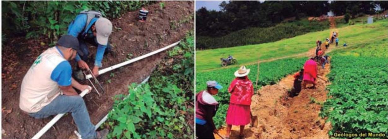
Figura 93.- Instalación de tubería y aterrado de zanja.
