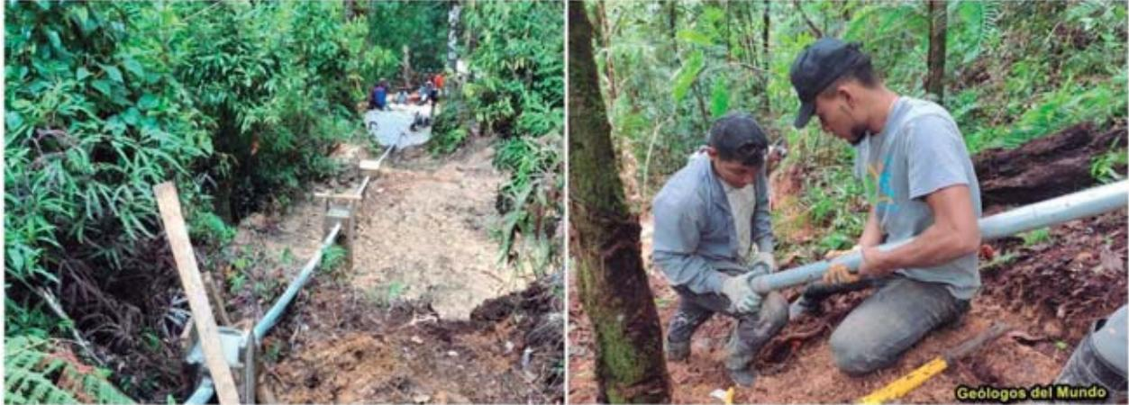
Figura 69.- Instalación de tubería. A la izquierda, el arranque de la impulsión desde la cisterna 2 (al fondo) hacia la cisterna 3.
