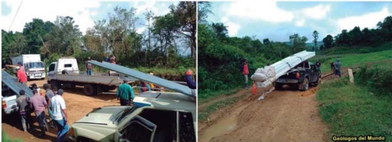
Figura 64.- Recepción de los materiales para la instalación de las líneas de impulsión (tubos y accesorios). Ambas líneas (bombeo 1 a bombeo 2, y bombeo 2 a cisterna 3) están compuestas por tramos de tubería de HG (acero galvanizado) de célula 30 y de PVC SDR21 y SDR26. Todos ellos de diámetro 2”.
