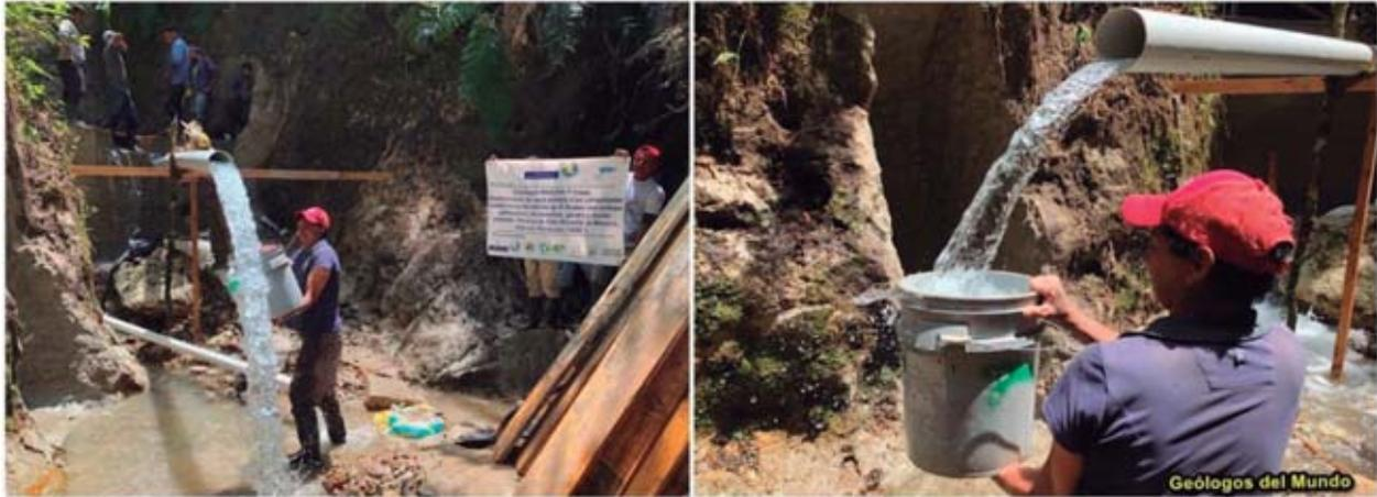
Figura 39.- Con el muro trasero ya construido, se procedió a realizar un aforo volumétrico de la fuente con un resultado de 160 gal/min.
