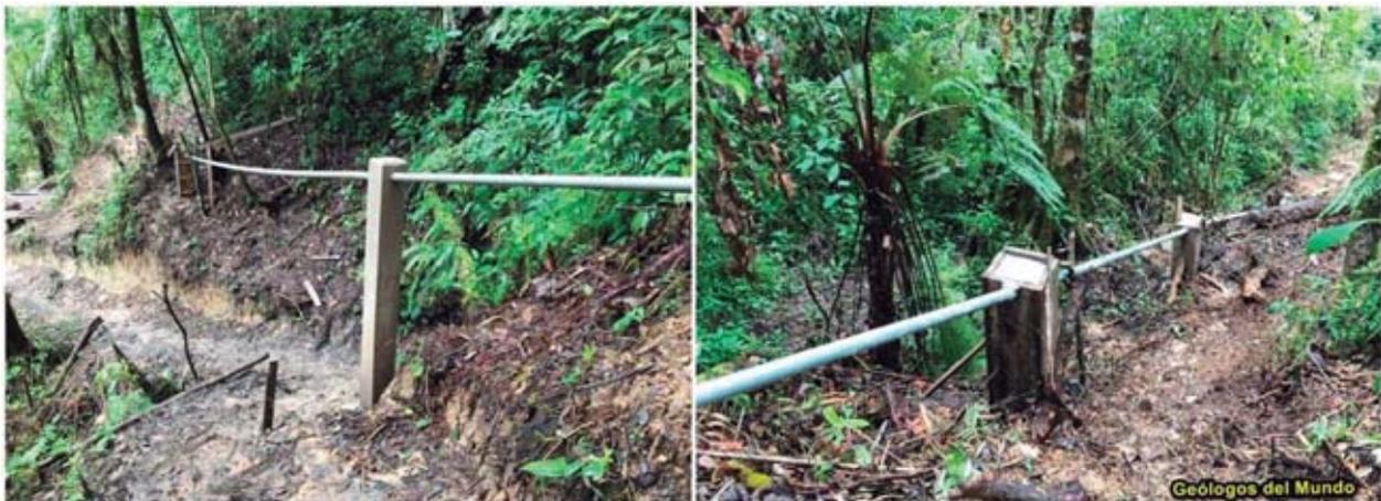
Figura 68.- Para mantener el nivel de la tubería y fijarla, se realizaron diferentes tipos de soportes y anclajes.
