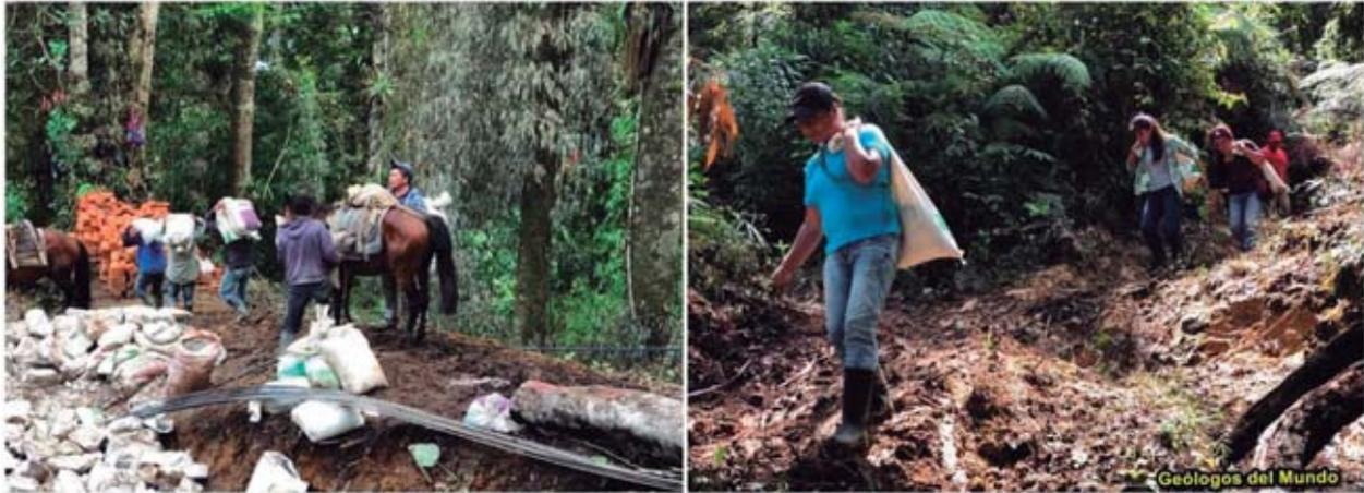
Figura 52.- Acarreo y acopio en el puesto de trabajo de los materiales de construcción.
