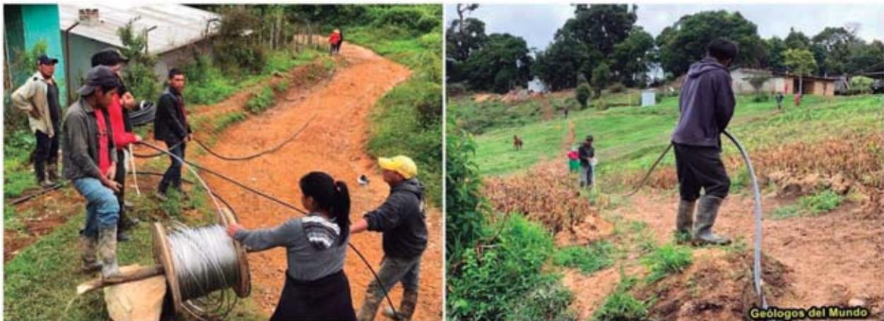
Figura 80.- Tarea de la formación de los mazos de cable de cada tramo introduciendo los cables en una manguera para su posterior instalación.
