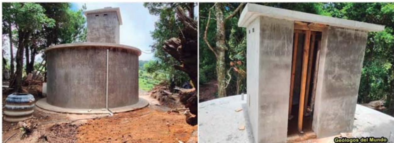
Figura 61.- Tanque cisterna nº 3 ya finalizado. A la derecha, la ceseta de protección para la bomba a colocar en la Fase II de lproyecto.
