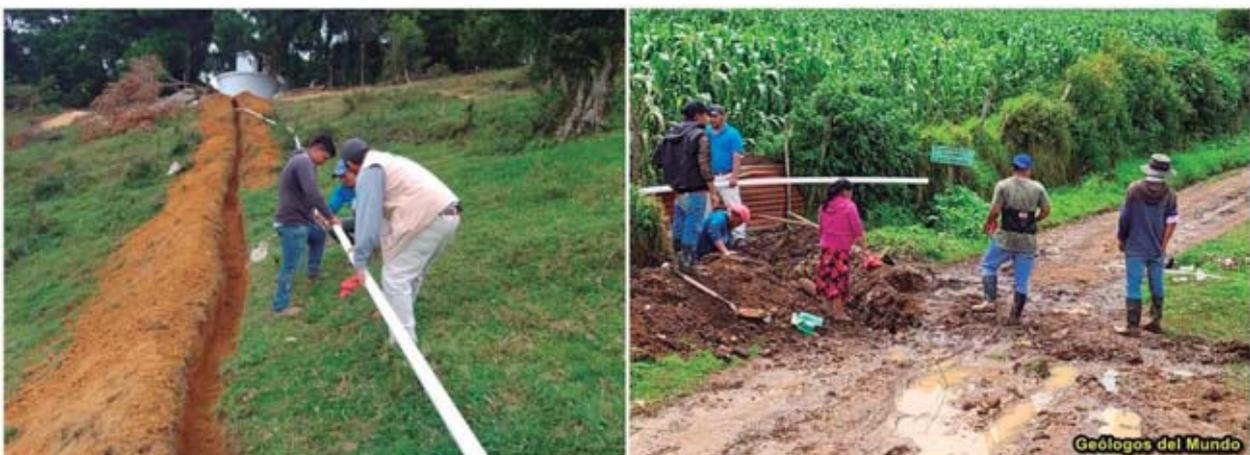
Figura 92.- Instalación de tubería de conducción de PVC 2".
