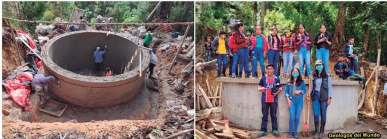
Figura 56.- A la izquierda, labores de repello interno y externo. A la derecha, cisterna finalizada ya fundida la losa superior.
