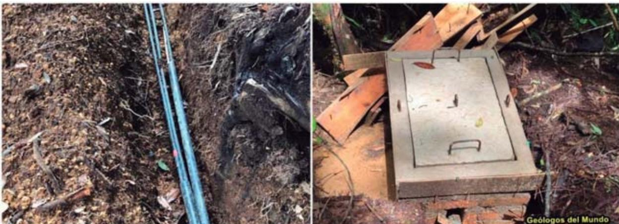
Figura 83.- Detalle del cableado en la zanja donde se construirá una de las cajas de registro. A la derecha, construida ya la caja de registro en la que los cables quedan libres de la manguera de protección para poder hacer en caso necesario las comprobaciones eléctricas de cada cable (continuidad, intensidad de corriente, voltaje, etc).
