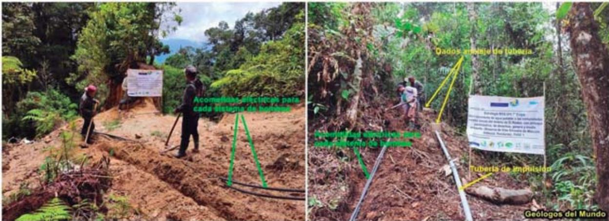
Figura 82.-Tarea de soterrar los mazos de cable de la acometida eléctrica a las bombas de agua.
