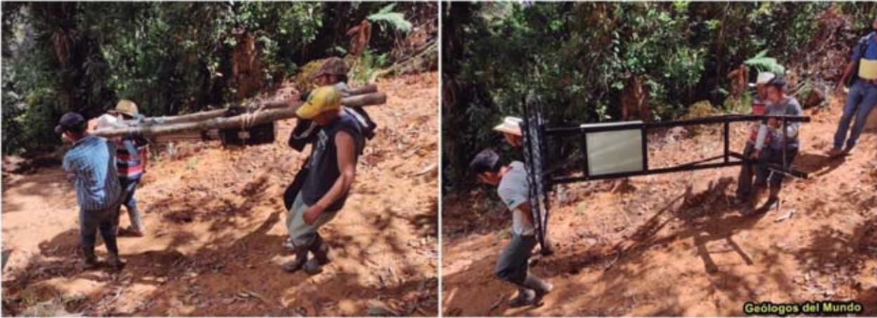
Figura 77.- Transporte al puesto de instalación de la bomba periférica y su correspondiente panel de control.
