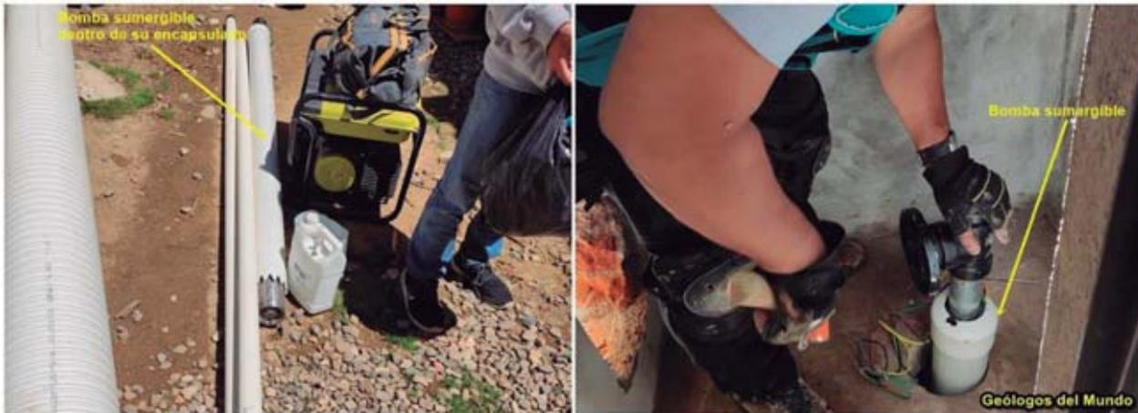
Figura 74.- Izquierda, bomba sumergible preparada para su instalación en la cisterna de bombeo n°1 (obra toma); a la derecha, bomba ya introducida dentro de la cisterna y conexión para recibir el tren de descarga.
