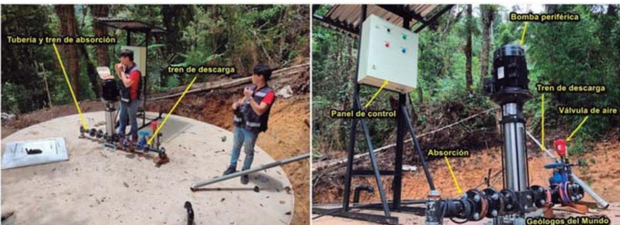
Figura 79.- Conjunto de bomba, tren de absorción, tren de descarga y panel de control ya instalados sobre la losa de la cisterna de bombeo nº 2.
