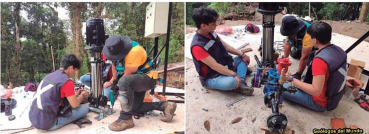
Figura 78.- Labores de instalación de la bomba periférica de eje vertical y su tren de absorción y de descarga sobre la losa superior de la cisterna de bombeo nº2.
