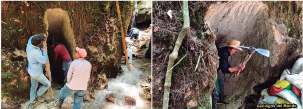
Figura 37.- Excavación de estribos y cimentación de los muros frontal y trasero. Excavación manual.
