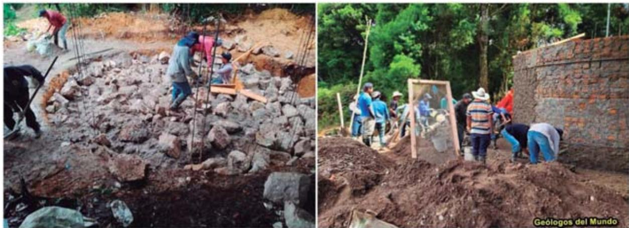
Figura 60.- Izquierda, fase de cimentación. A la derecha, paredes en fase de repello.
