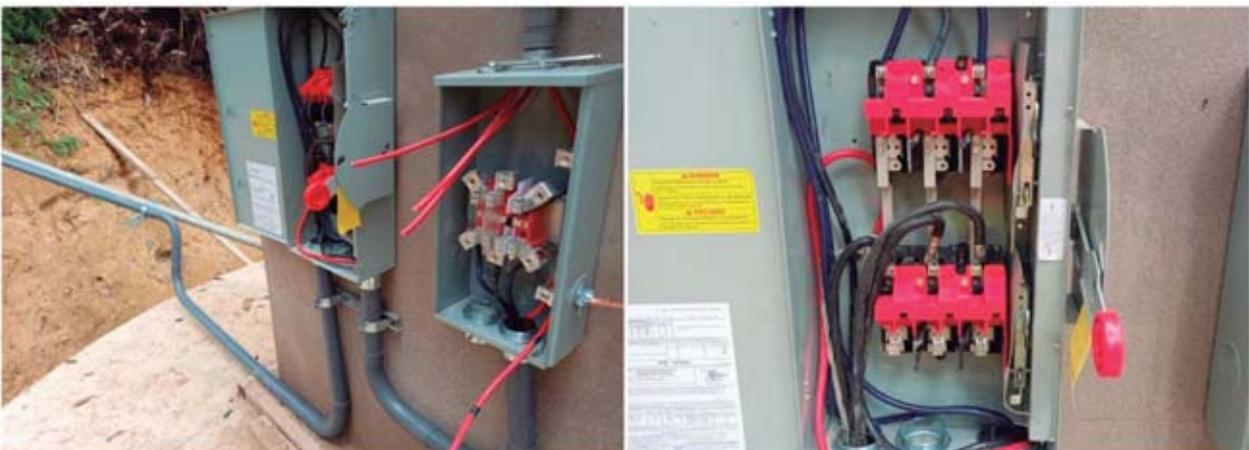
Figura 86.- Equipamiento eléctrico en cisterna nº2 para la conmutación eléctrica entre bombas nº 1 y nº2 y llevar a cabo el bombeo secuencial.
