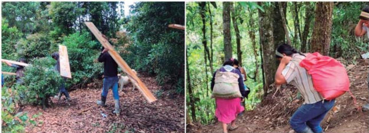
Figura 32:- El acceso al puesto de trabajo de la obra toma es difícil y con fuerte pendiente, teniendo que realizarse el acarreo en una longitud de unos 900 metros.
