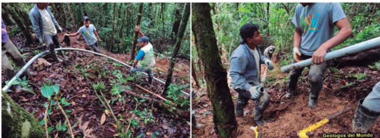
Figura 66.- Las fuertes pendientes del relieve complica enormemente la instalación, en especial la de HG.
