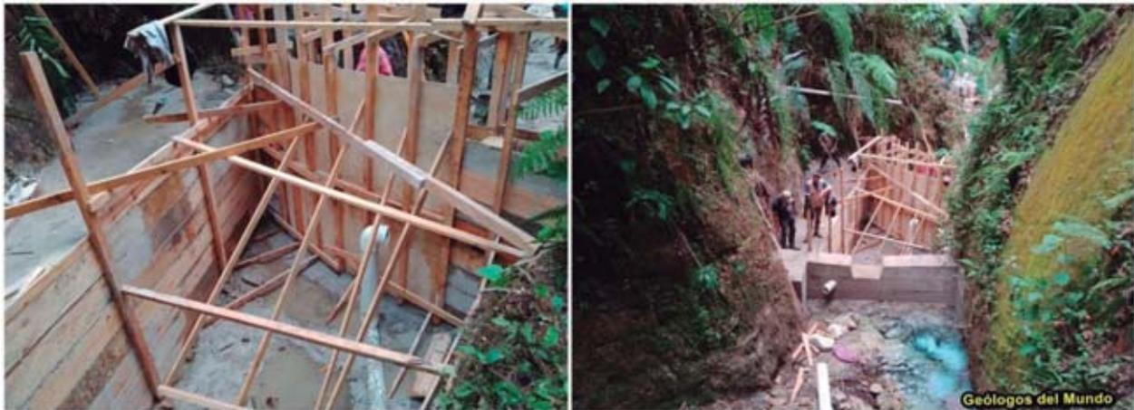
Figura 40.- Construcción de muros frontal (presa) y laterales, que junto al trasero delimitaran el vaso de acumulación de agua.
