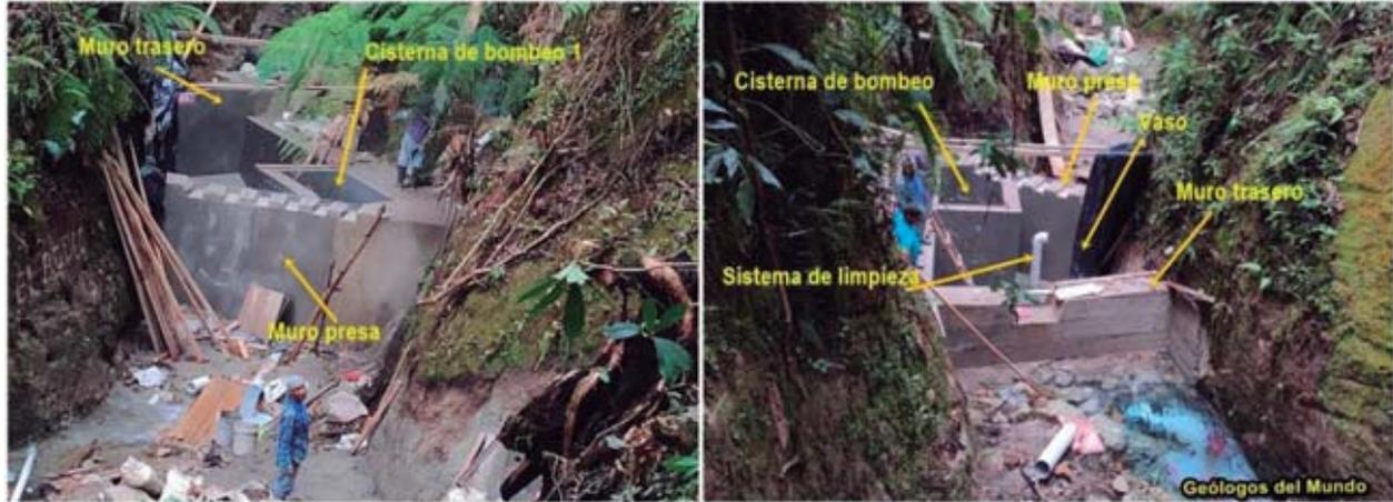
Figura 42.- Vista general del conjunto obra toma/cisterna de bombeo 1 en una fase avanzada de construcción.
