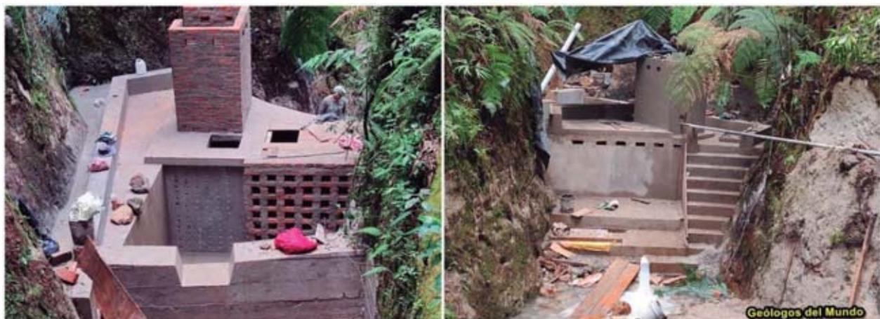
Figura 44.- Vista trasera y frontal de la obra toma/cisterna de bombeo 1 .
