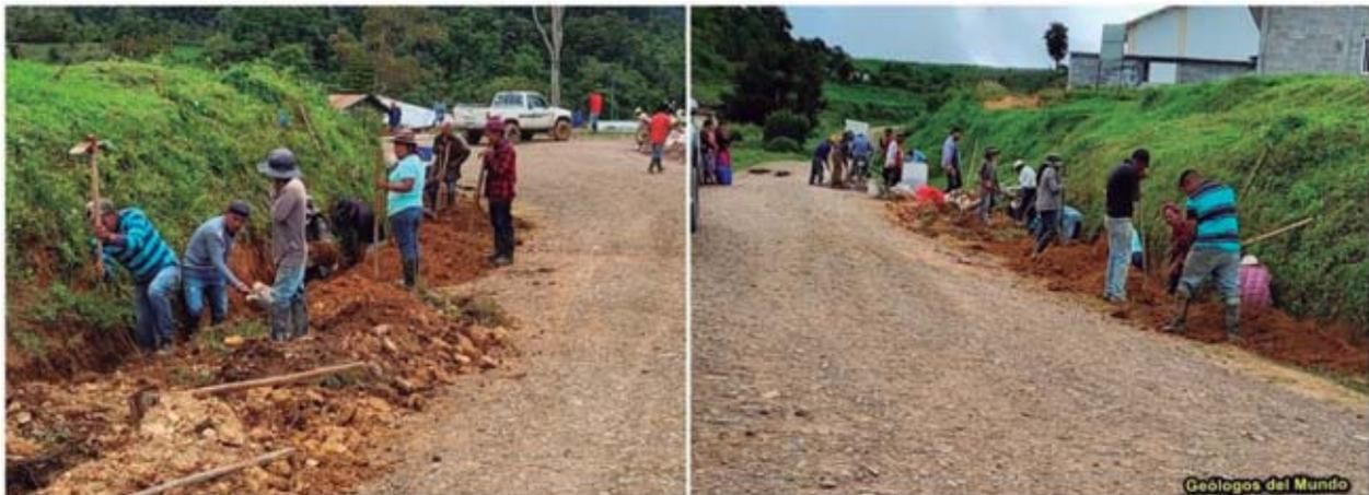
Figura 94.- Excavación de zanja de interconexión entre fuentes e instalación de tubería.
