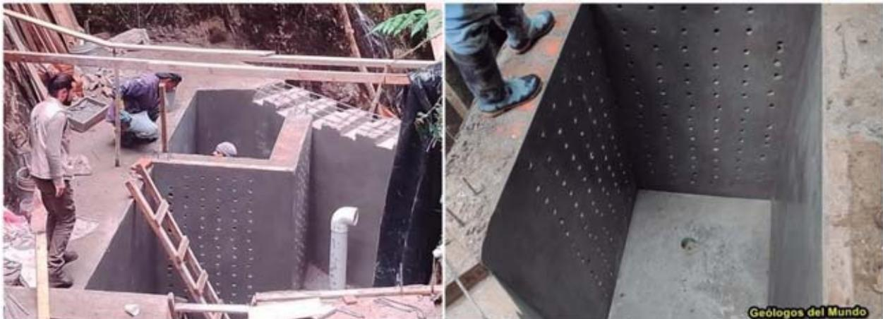
Figura 41.- Cisterna para el bombeo de agua nº1. Se observa sus paredes perforadas.
