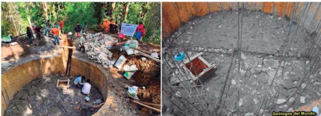
Figura 54.- Cimentación de losa ciclópea y vigas riostras a falta de la solera armada. A la derecha se observa el armado vertical que fue parte de las paredes.
