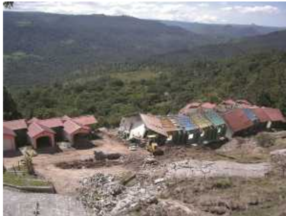
Deslizamiento en la carretera a Danlí, Honduras
