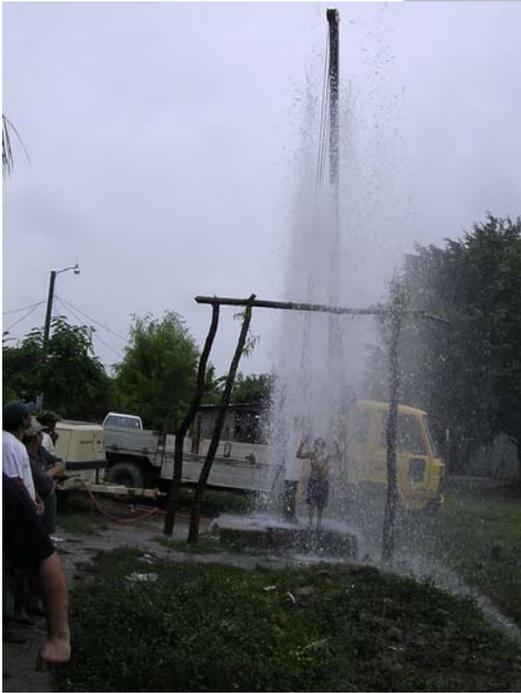
Fotografía 7. Proceso de “limpieza” del pozo P6 con aire comprimido.
