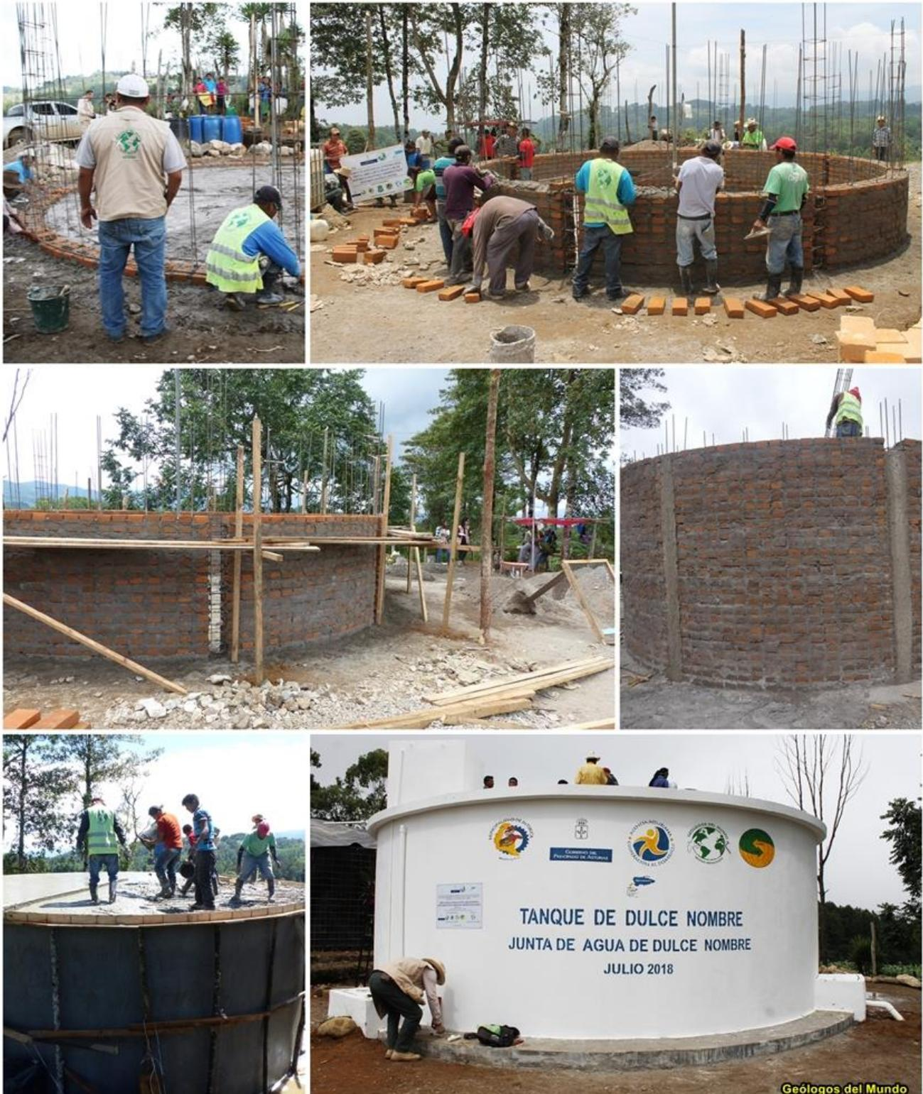
Levantamiento de las paredes y depósito ya finalizado con el hipoclorador para desinfección del agua en la losa superior de cierre.
