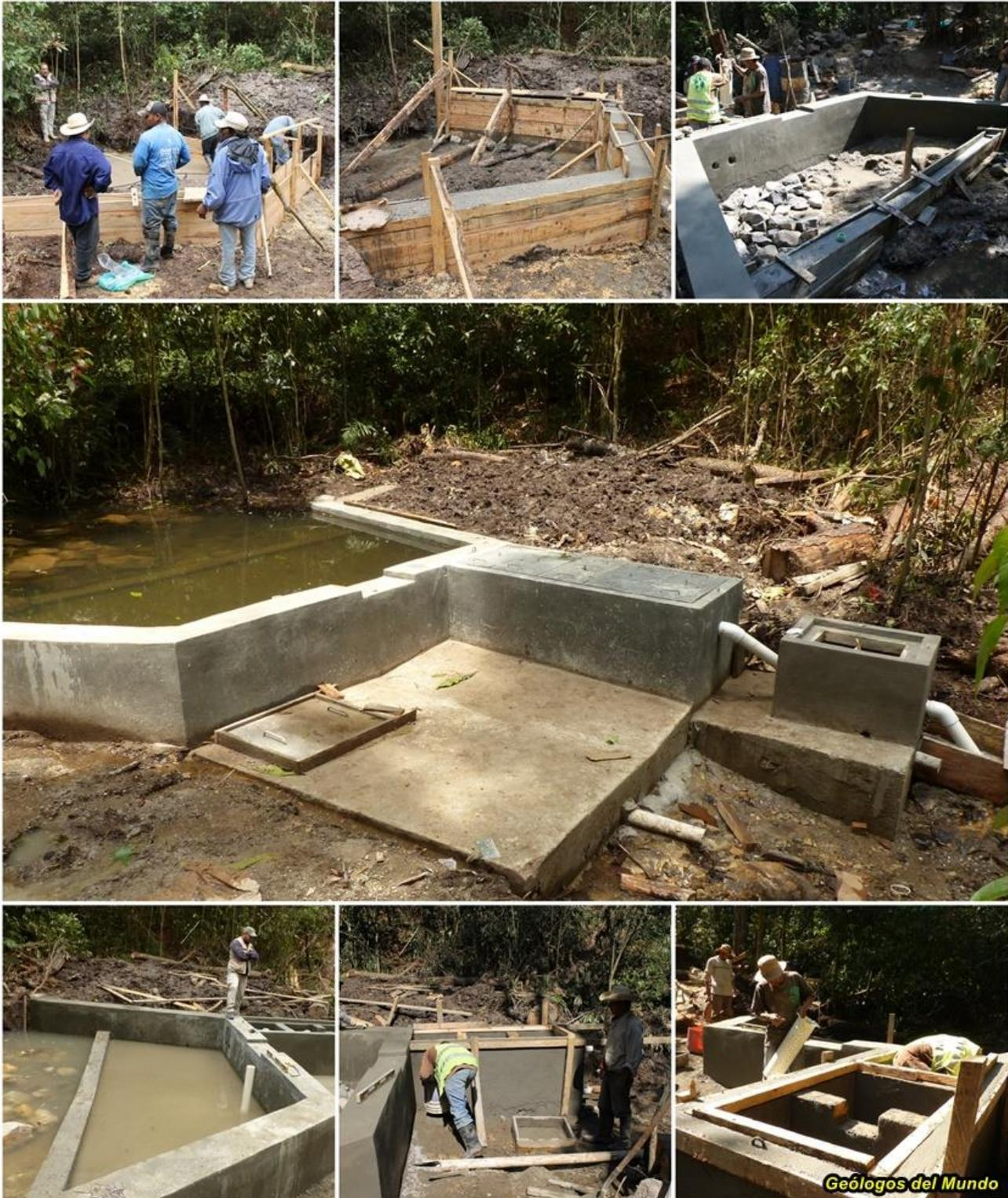
*Distintas fases de la construcción de la obra toma y el filtro primario.*
