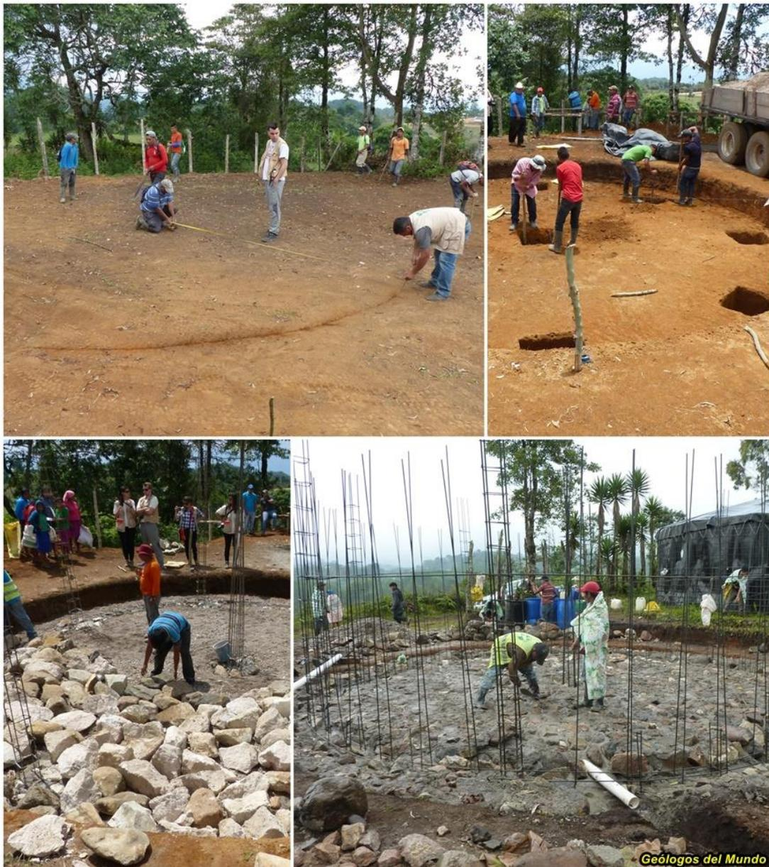
Labores de marcado, excavación de cimentación y cimentación del depósito.
