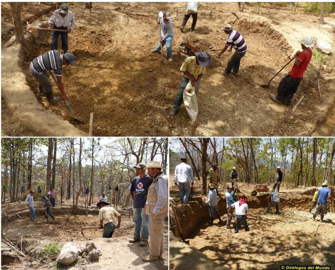
*Excavación de cimentación. Una vez replanteado en el terreno la ubicación del depósito, se inició con un desbroce y limpieza y una excavación de nivelación del plantel; a partir de ahí se llevó a cabo la excavación para la cimentación. Todo ello a mano por parte de los miembros de la comunidad, sin ningún tipo de maquinaria*
