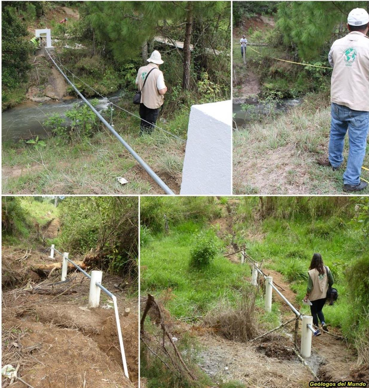
*Pasos aéreos en la línea madre de distribución. La tubería de la línea es de PVC Ø 1”, para su protección en los pasos y facilitar el mantenimiento,, en todos los pasos se optó por colocar tubería guía de HG de Ø 1 ½” e introducir por su interior la tubería de PVC 1” de la línea.*
