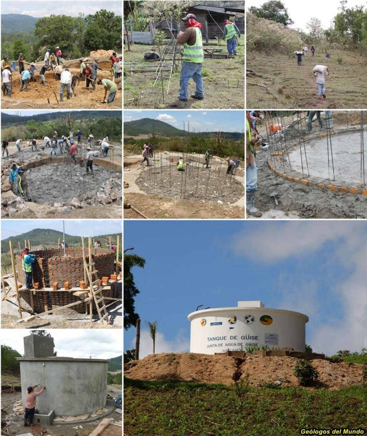
*Distintas fases de construcción del depósito de Güise con capacidad para 10.000 galones. Sobre la losa superior se construyó el hipoclorador para la desinfección del agua servida. En total, el tiempo empleado desde el inicio de la construcción del tanque y hasta proceder a su primera carga, fue de 31 días entre los que se cuenta los correspondientes al fraguado de la losa superior de cierre.*
