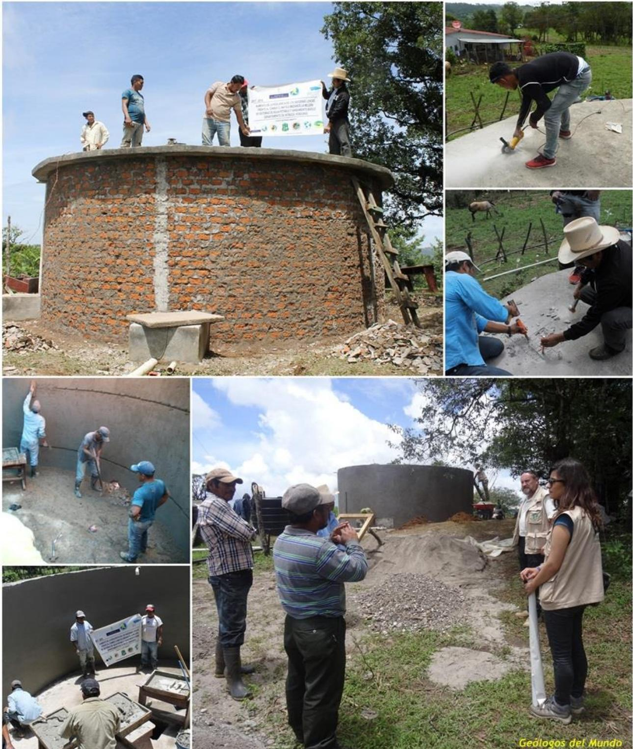
Diferentes fases de la reconstrucción: eliminación de repellos, demolición de losa superior, reposición de los repellos interior y exterior.
