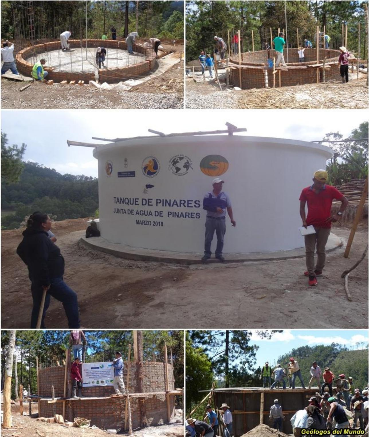
Diferentes etapas de construcción de las paredes y depósito ya finalizado.
