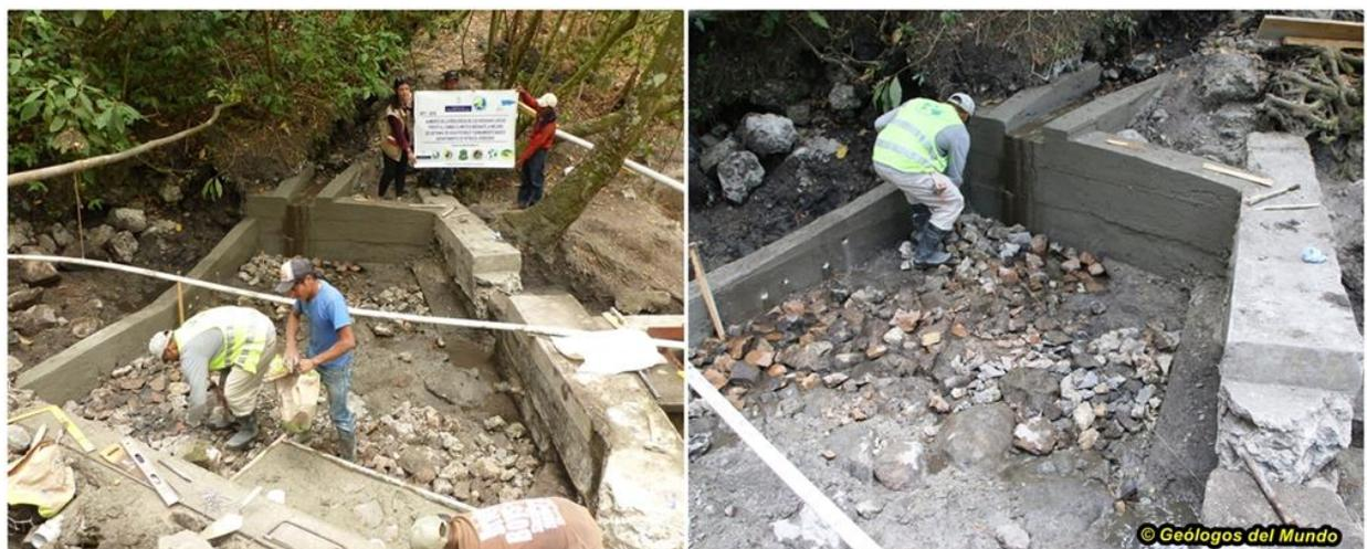
Construcción del piso del vaso de la represa para evitar fugas de agua y favorecer la limpieza y mantenimiento. En la imagen se pueden observar ya contruídos las aletas laterales y el muro trasero; sobre la aleta izquierda el vertedero para incorporación de agua lateral..
