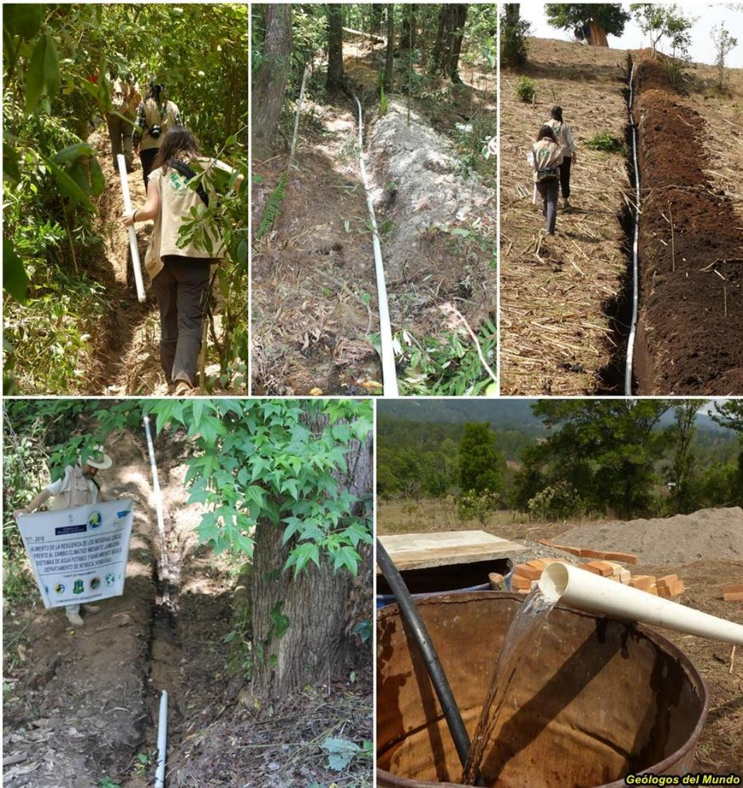
Zanjeo e instalación de la tubería de conducción desde la obra toma hasta el depósito de agua.
