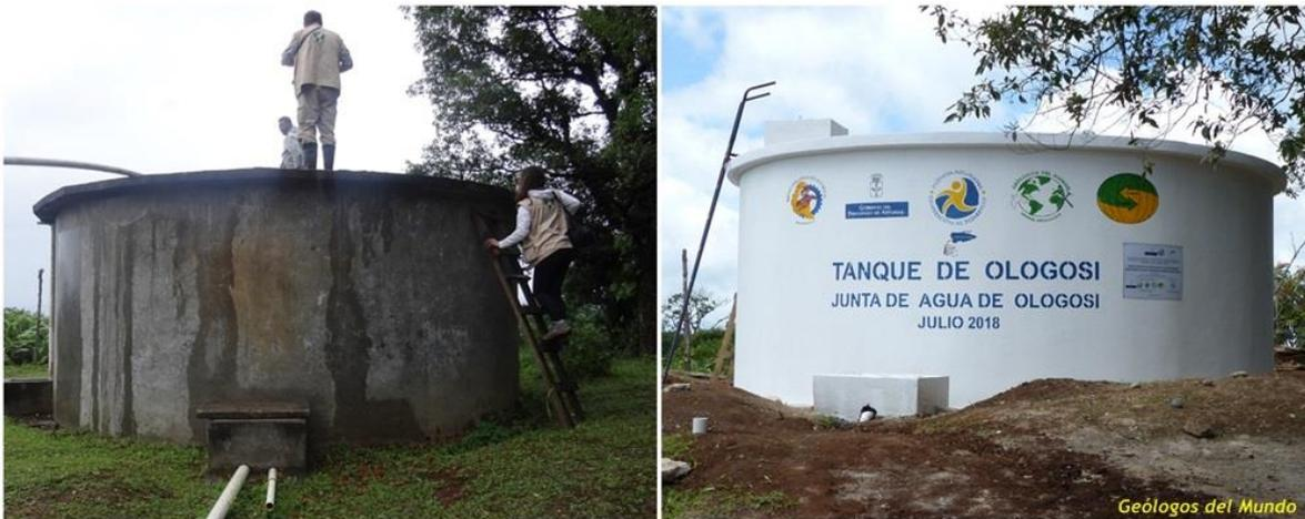
El antes y el después de la reconstrucción. En total la actuación supuso 30 días de trabajo que incluyen el fraguado de la losa. Durante ese tiempo tuvo lugar igualmente la instalación del pozo, y el zanjeo e instalación de la tubería de impulsión.
