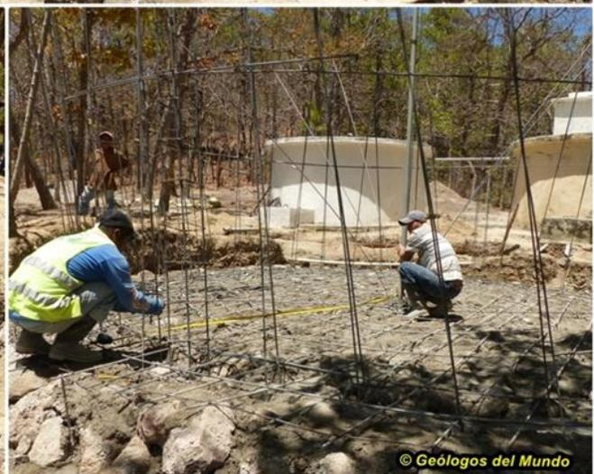
Cimentación y armado de la losa de reparto.
