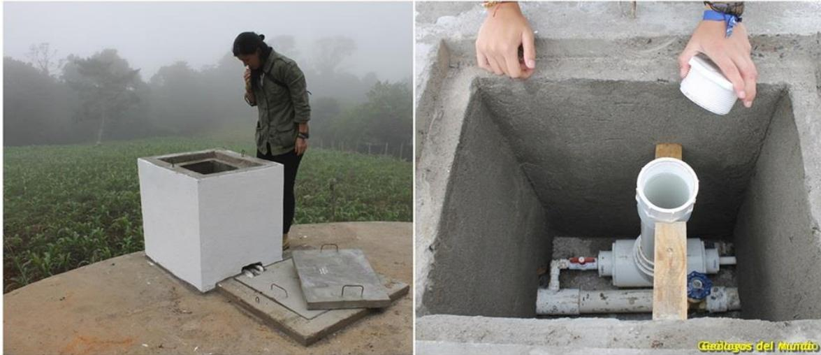
Construcción del clorador para la desinfección. En este caso, al ser por bombeo, el agua cruda no estará entrando al depósito de forma continuada sino solamente en los periodos establecidos para el bombeo; por tanto no se instala un clorador por goteo sino por tableta.
