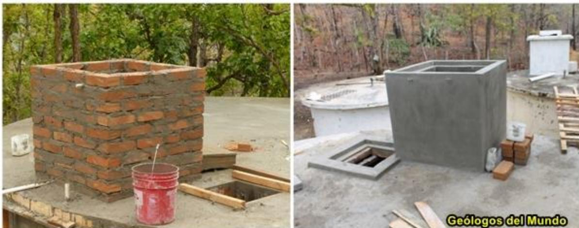
Hipoclorador sobre la losa superior del depósito. Es el elemento para la desinfección del agua mediante goteo de cloro.
