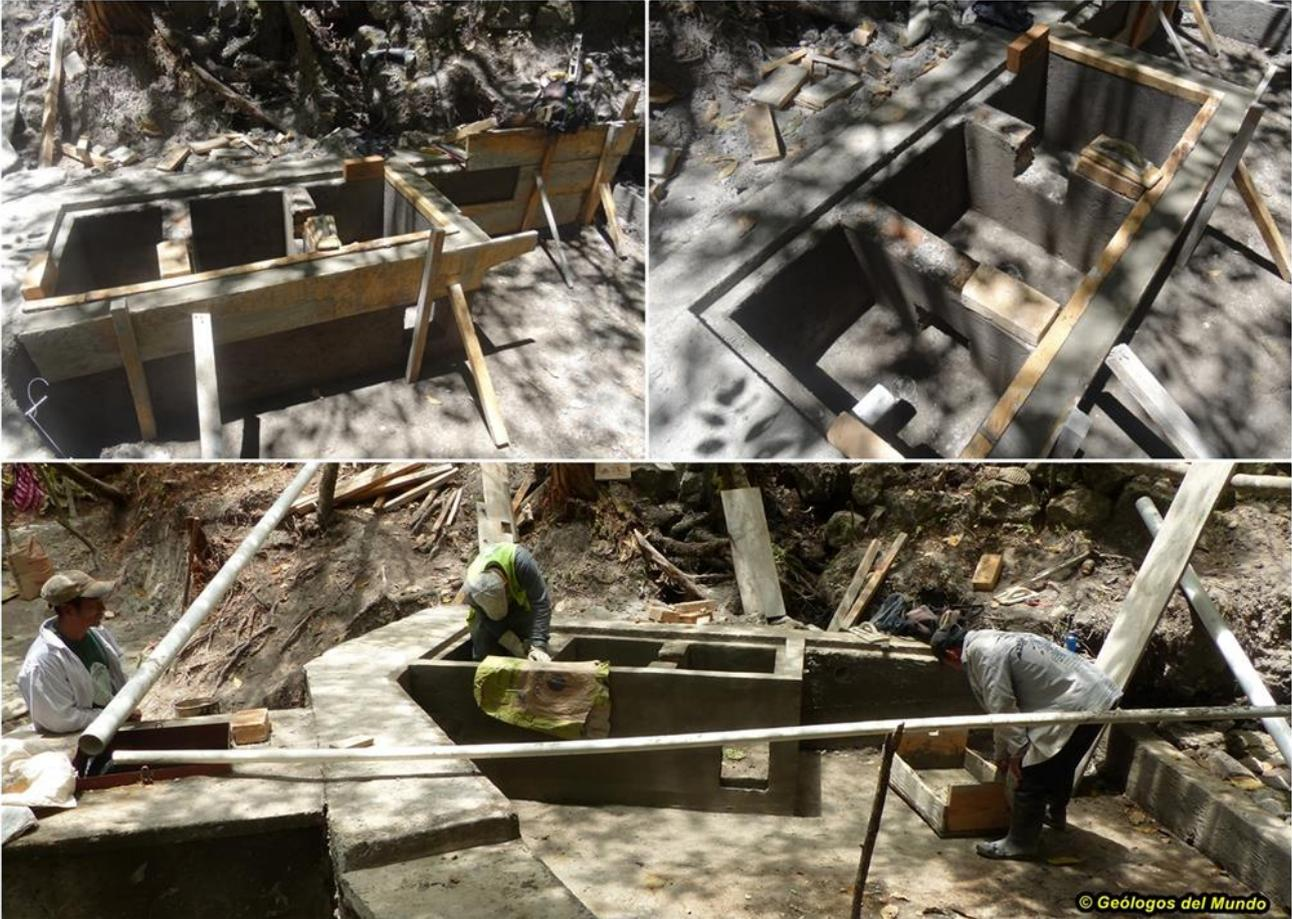
*Construcción de la caja filtro primario de tres celdas anexa a la aleta lateral derecha. Se puede observar el piso del vaso ya construido.*
