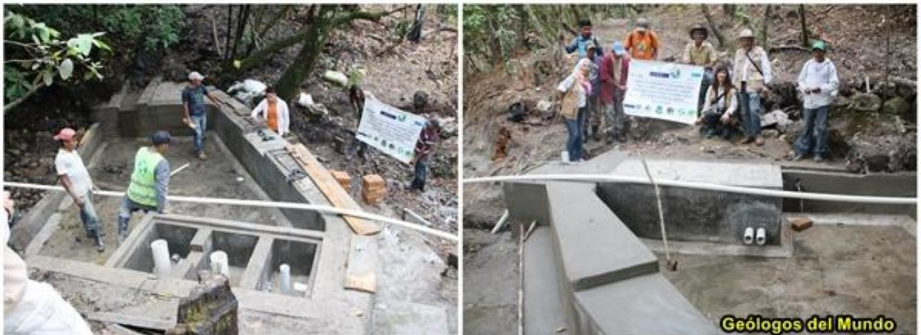
*Caja filtro finalizada. Se observa ya realizada la reposición total del muro frontal.*
