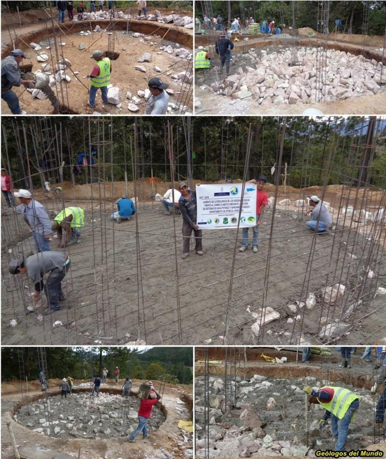
*Etapa de cimentación. Pozos para los castillos perimetrales y el pilar central, y losa de hormigón ciclópeo sobre la que se dispone una solera armada. En las fotografías se pueden ver los armados de castillos y pilar central, así como los armados verticales de las paredes de ladrillo rañón.*
