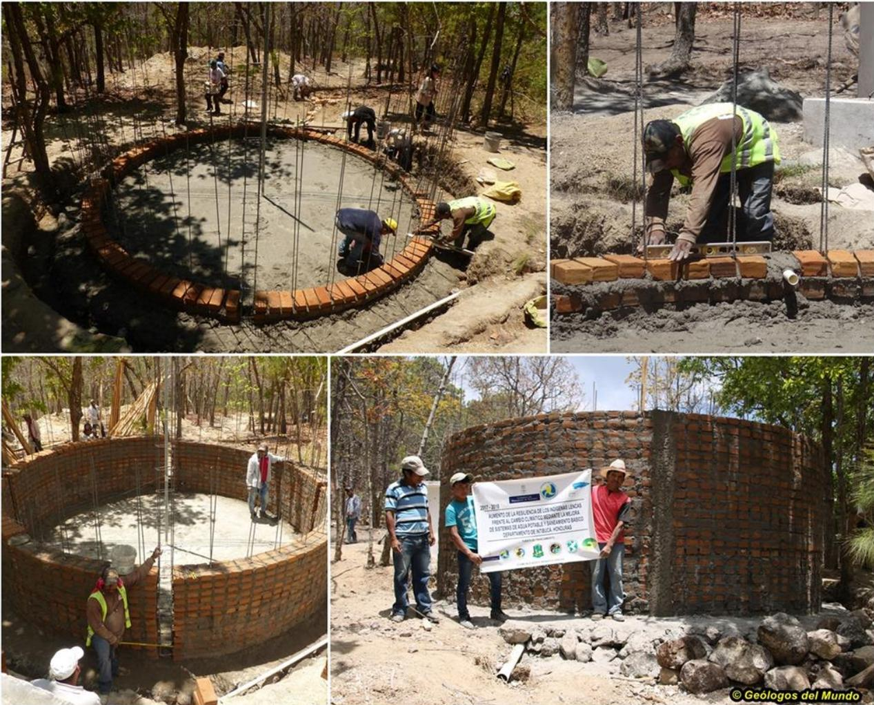
Levantando las paredes de ladrillo rañón con refuerzo de anillos de varillas de acero corrugado.
