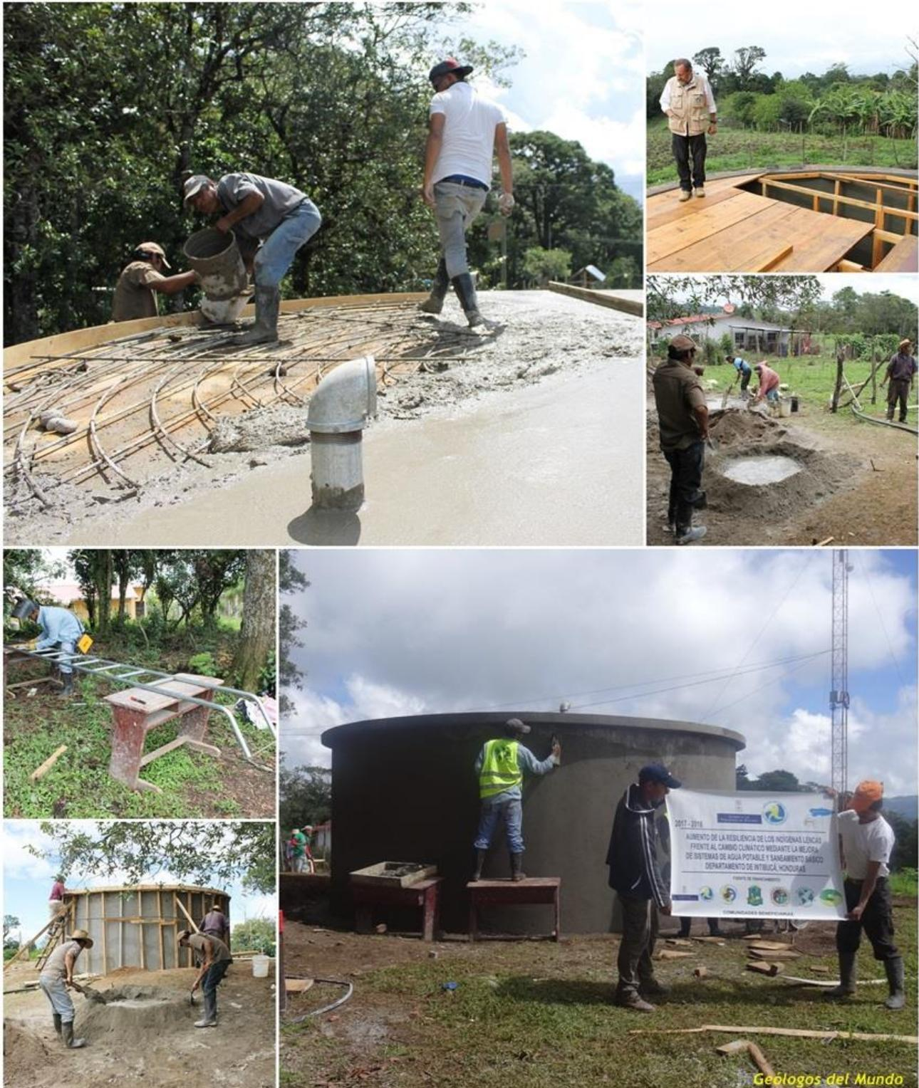
Construcción de la nueva losa superior, fabricación de escalera de acceso y pulido final del depósito.
