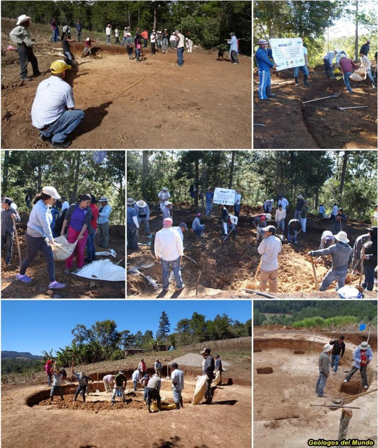
*Fase de replanteo, excavación del plantel y excavación de cimentación.*
