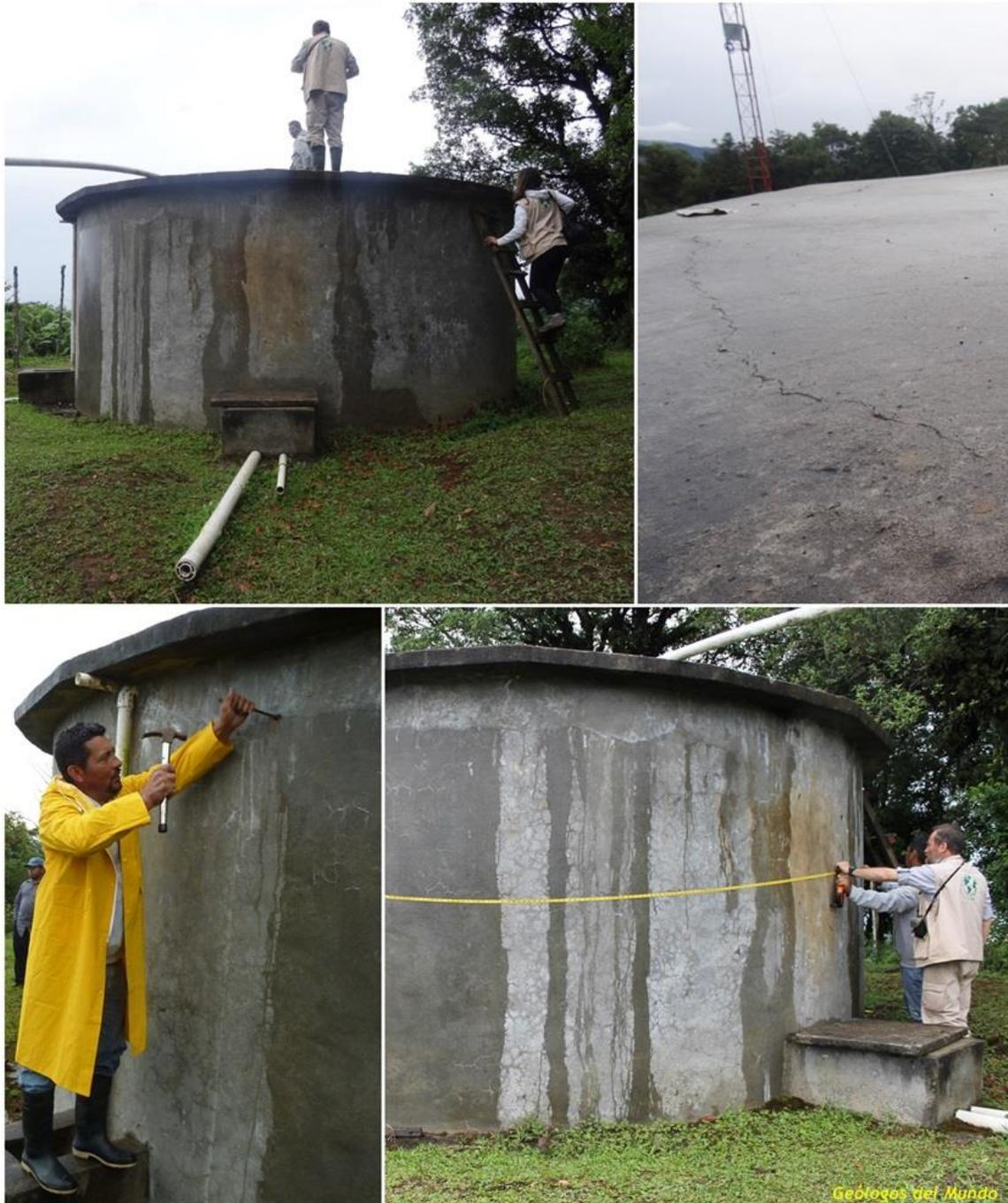
*Estado inicial del depósito de Ologosí, observándose fugas de agua y las grietas de la losa superior. En las fortos interiores, pruebas para determinar el estado estructural.*
