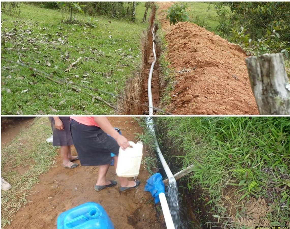
*Línea de conducción instalada con el agua en el punto de construcción del depósito.*
