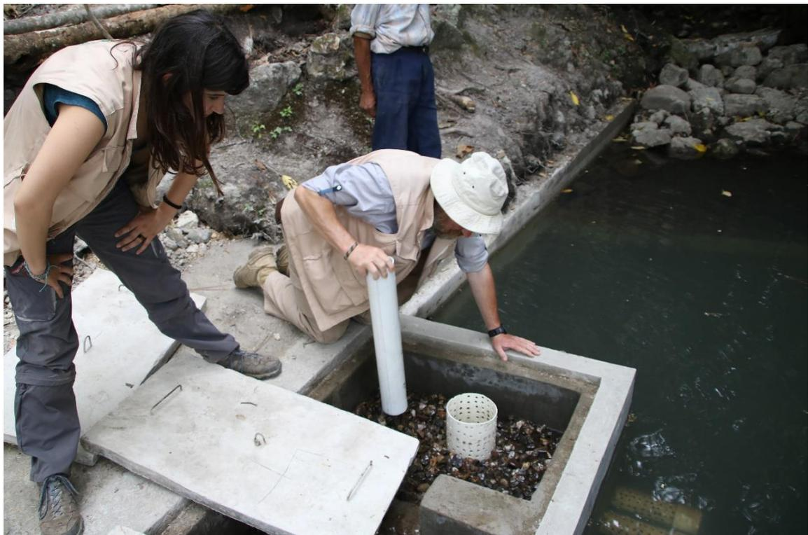
*Obra toma ya totalmente finalizada y en funcionamiento. Detalle del filtro primario de gravas y arenas ya operativo.*
