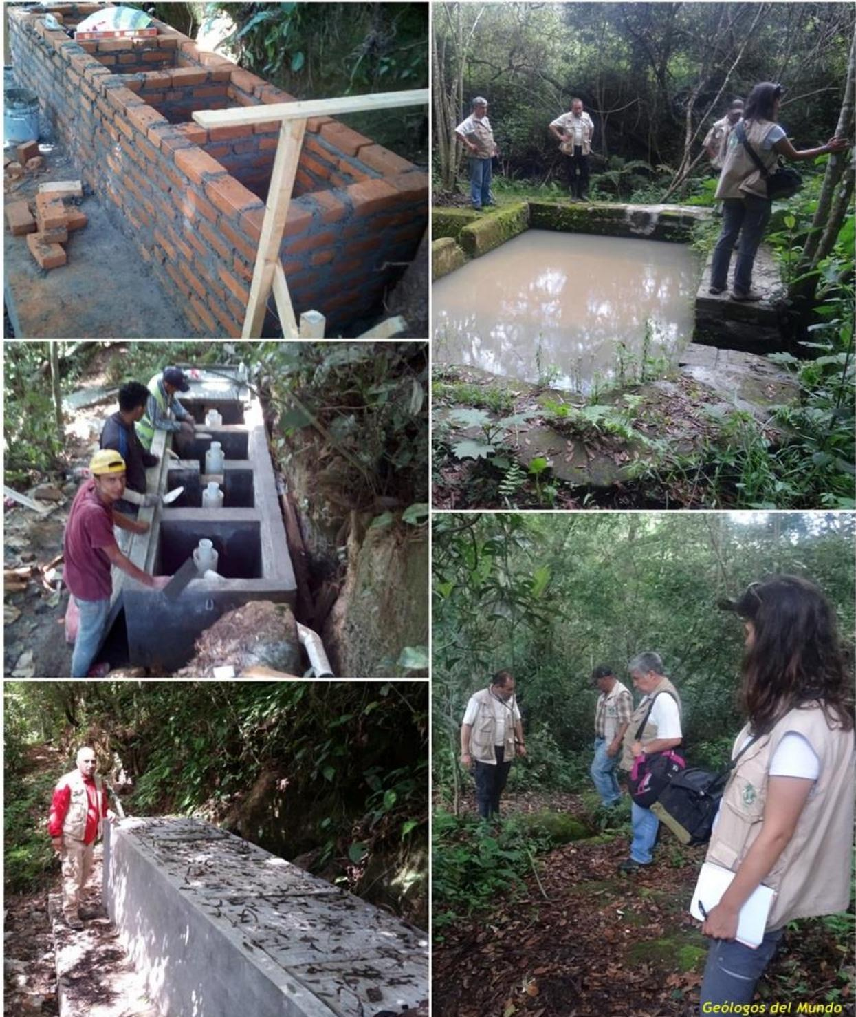
Construcción del filtro primario. A la izquierda, diferentes etapas de la construcción; a la derecha fases de campo para determinar su ubicación
