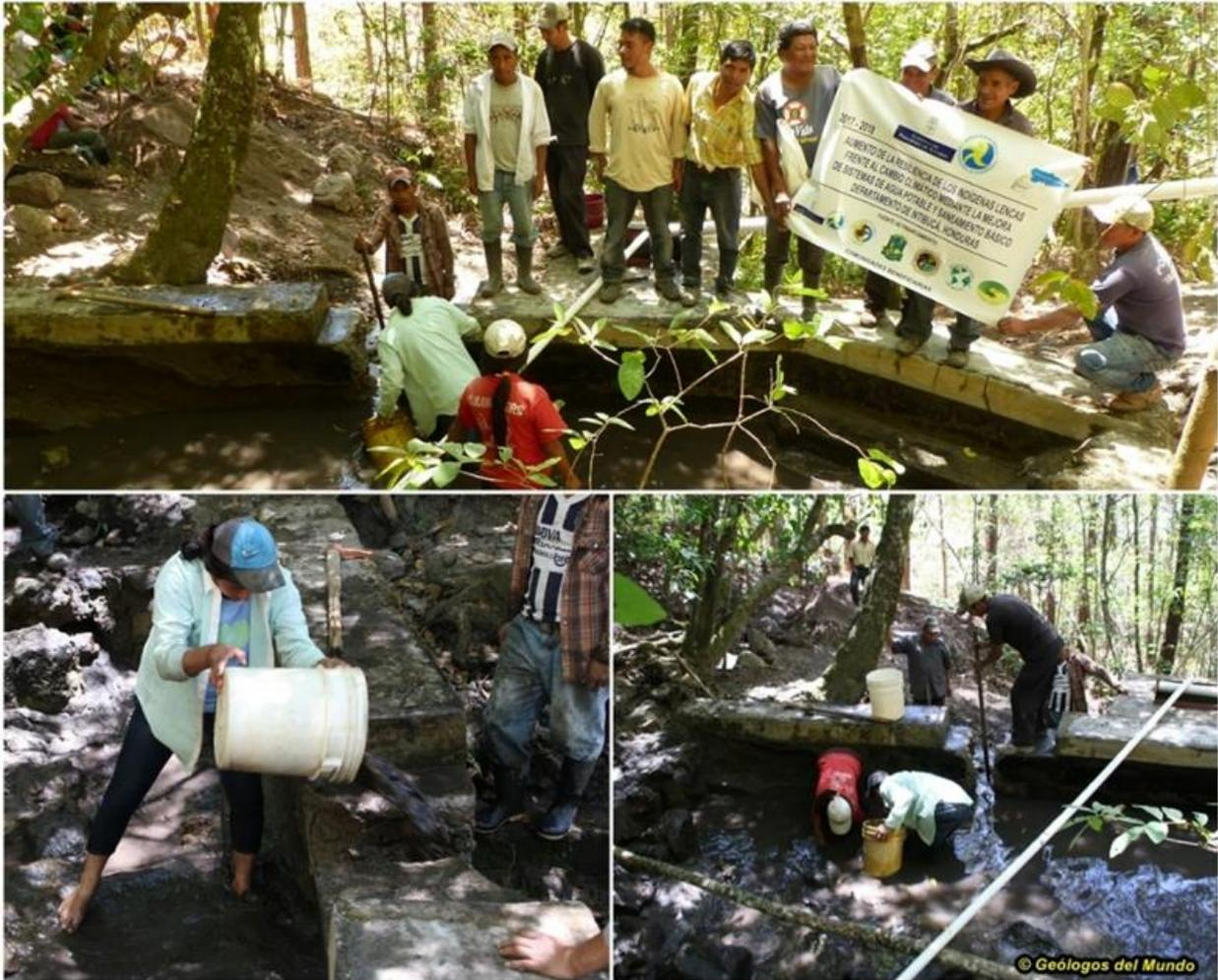
Vaciado y limpieza de fangos del interior del vaso. Rotura del muro frontal para colocación de tubo de limpieza.
