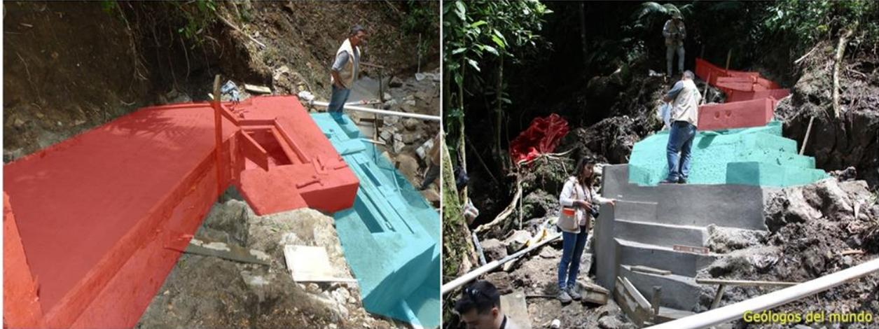
*Obra toma para la captación de agua en Dulce Nombre. Figuración por colores; en rojo está representada la estructura de concentración y en azul la estructura de captación.*
