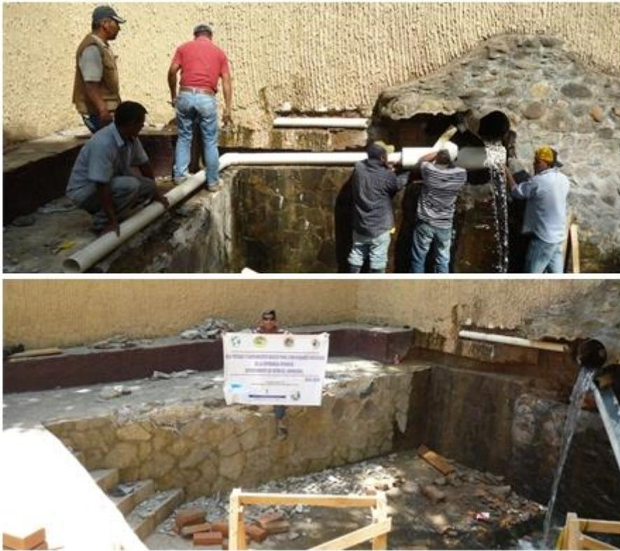
**Figura 68: Colocación de la pila de captación**
