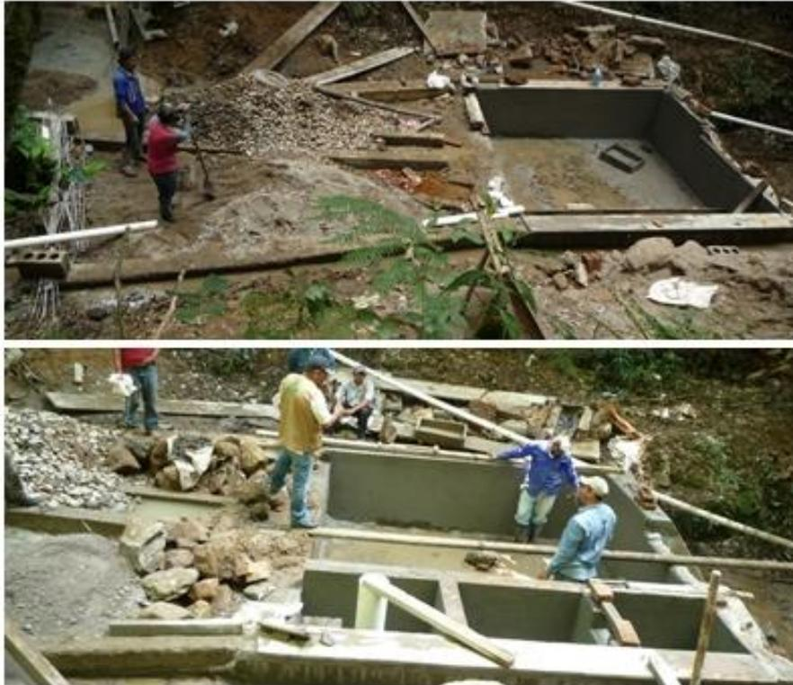
**Figura 21: Reconstrucción de la Fuente grande y dotación de filtros**
