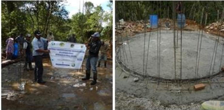
**Figura 33: Cimentación del tanque**
