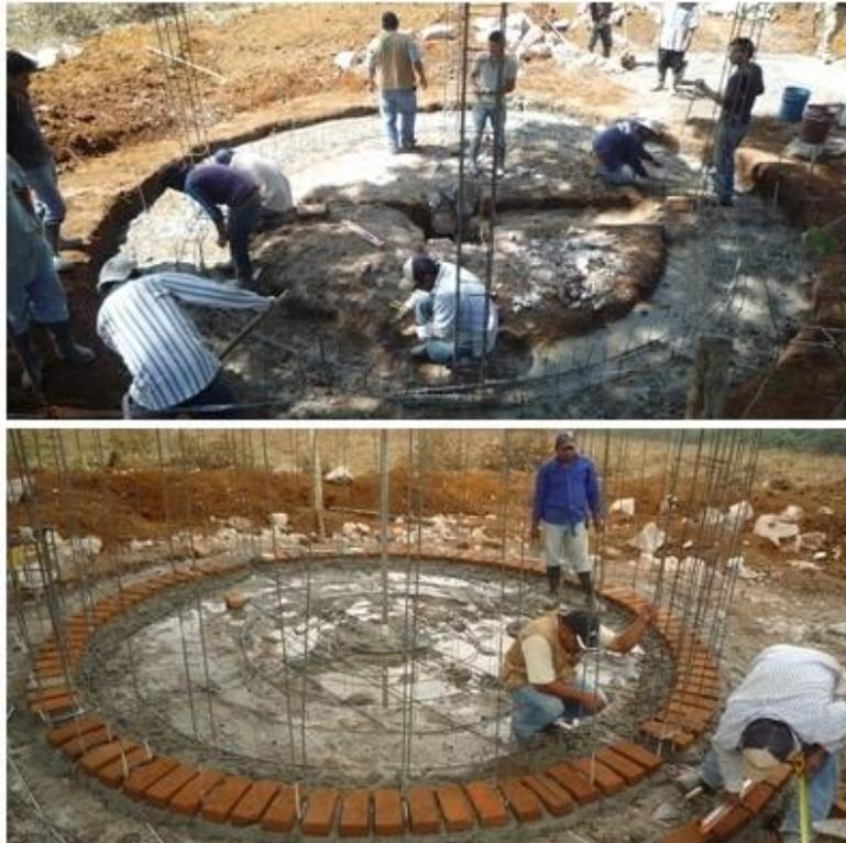
**Figura 51: Cimentación e hilada perdida de ladrillos**
