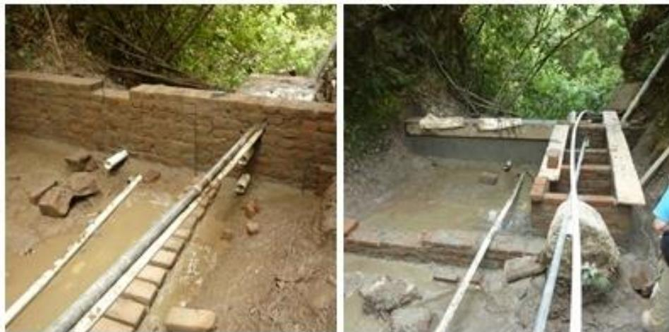
**Figura 48: Presa y filtros en construcción**
