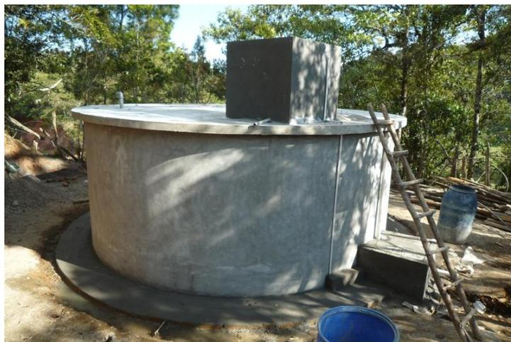
**Figura 36: Losa ya fraguada e hipoclorador construido**
