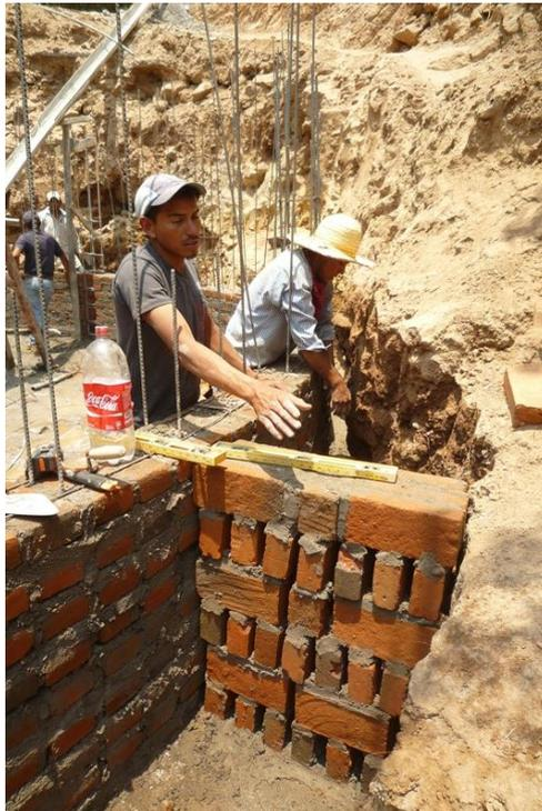
**Figura 62: Murete de drenaje para el trasdosado**
