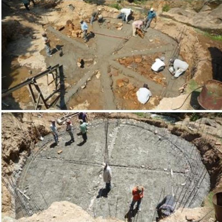
**Figura 60: Cimentación de la losa inferior del tanque**
