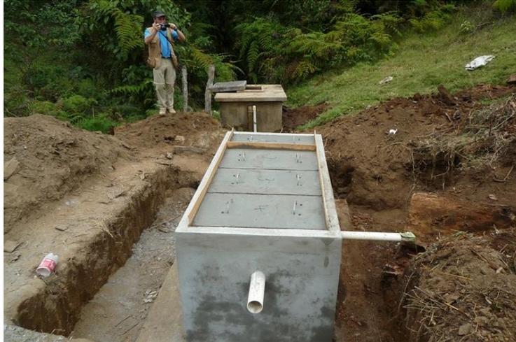
**Figura 28: Cámara recolectora nueva en primer plano, y cámara vieja al fondo**
