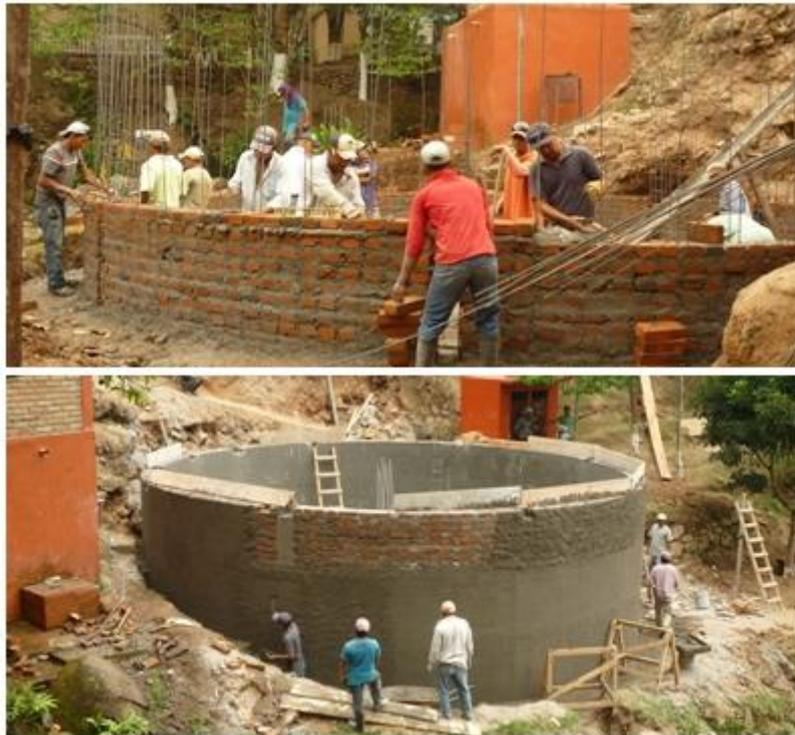
**Figura 61: Levantando las paredes del tanque**
