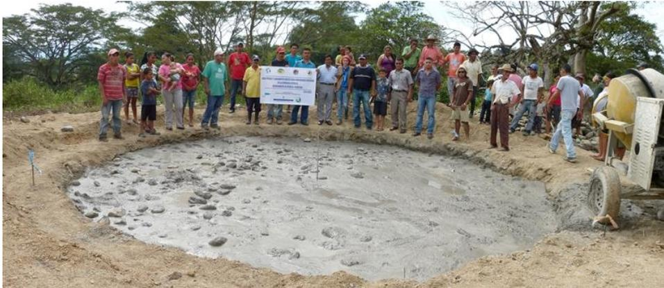
**Figura 40: Cimentación de la losa inferior del tanque**
