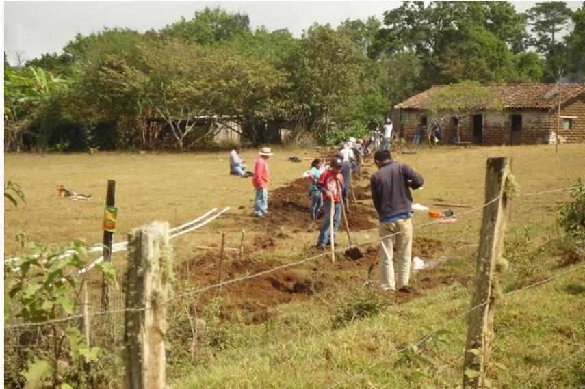
**Figura 56: Zanjeo para la tubería**
