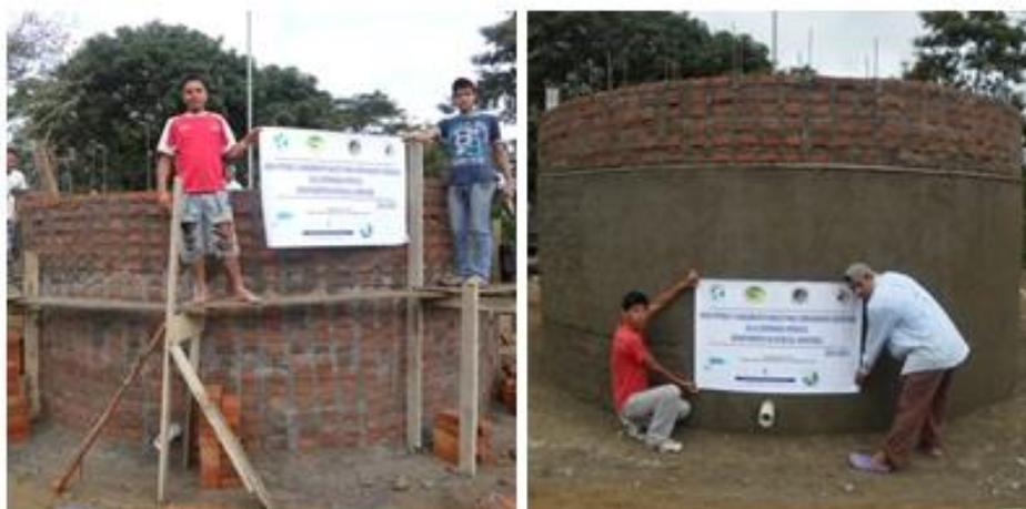
**Figura 41: Levantamiento de las paredes del tanque**
