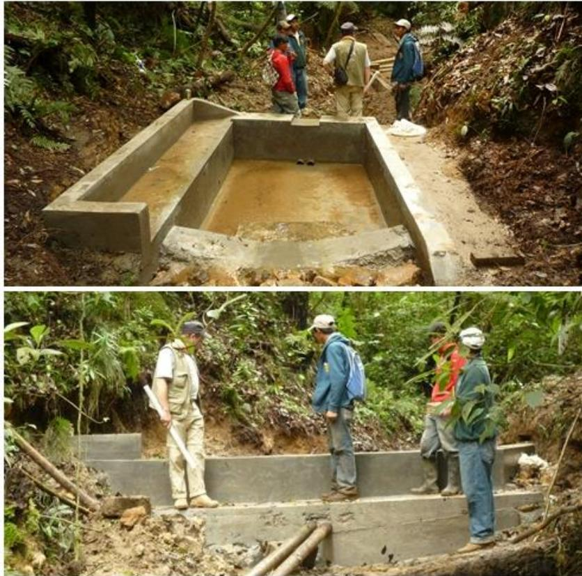
**Figura 22: Pequeñas represas para captación de agua hacia la presa de la Fuente Grande**
