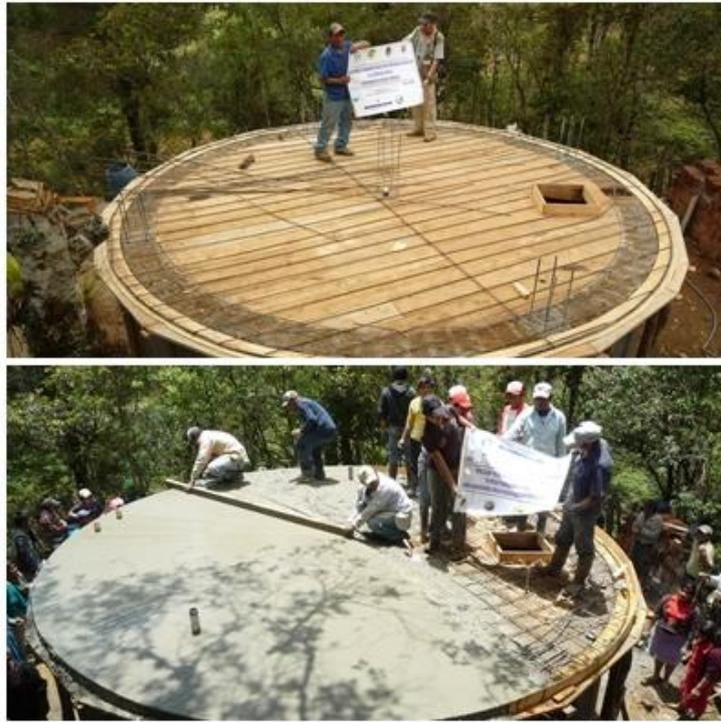
**Figura 35: Fundición de la losa superior**
