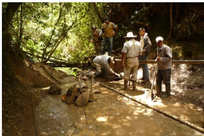
**Figura 47: Demolición del muro frontal de la presa vieja**
