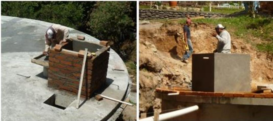
**Figura 65: Construcción del hipoclorador**
