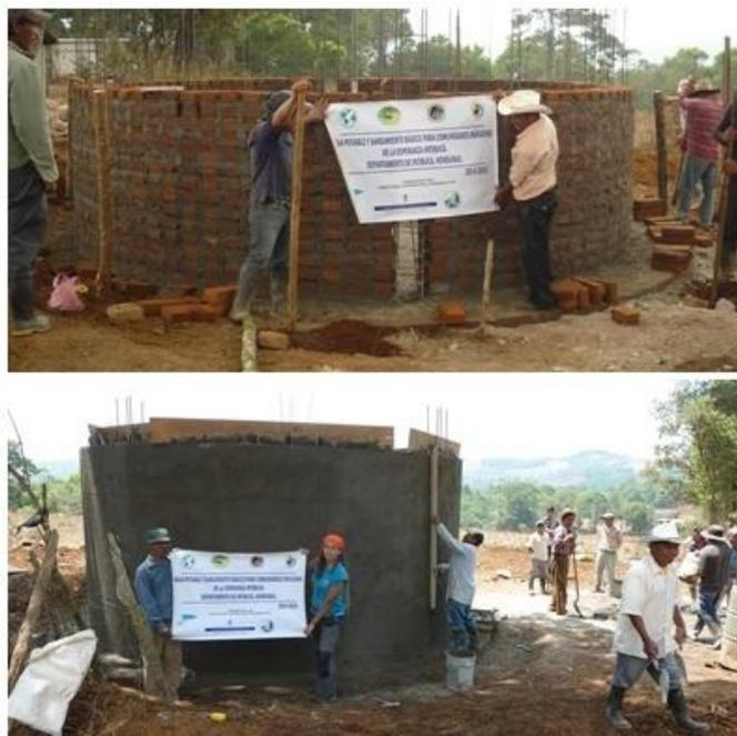
**Figura 52: Levantamiento de las paredes**
