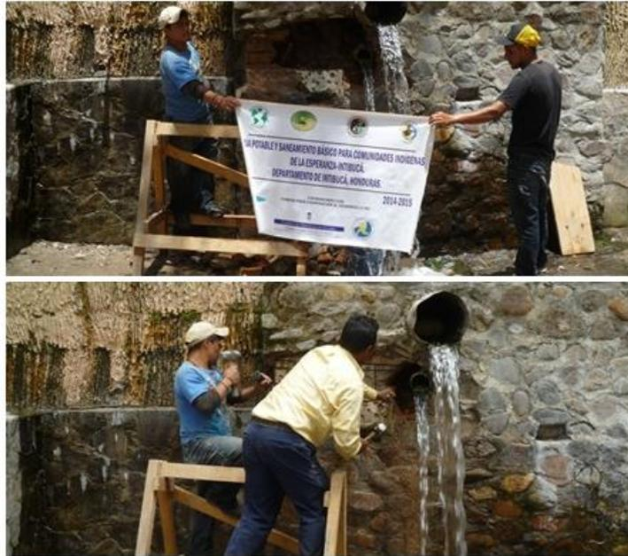
**Figura 67: Rotura del frente del baño para captar el chorro inferior**
