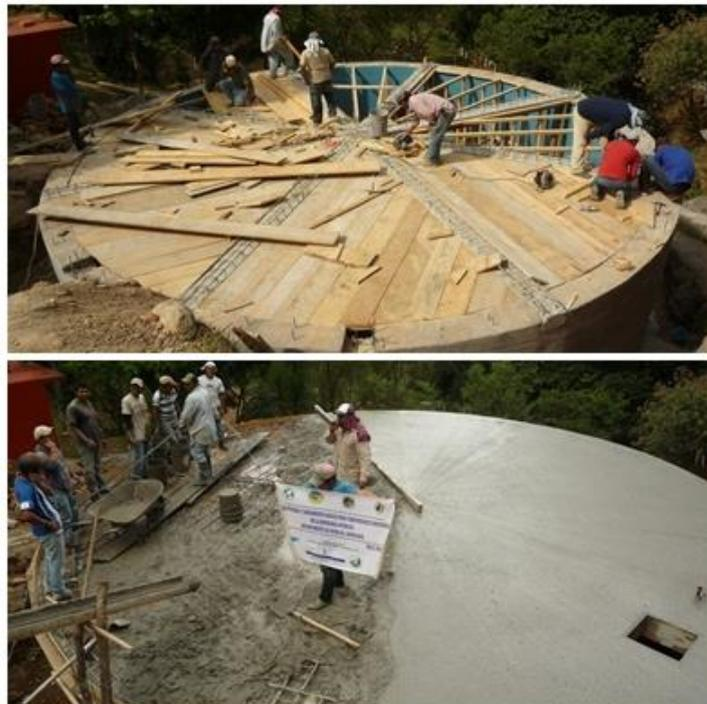
**Figura 64: Encofrado y cimentación de la losa superior**
