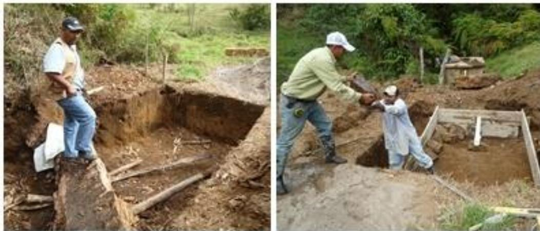
**Figura 27: Construcción de la nueva cámara recolectora**
