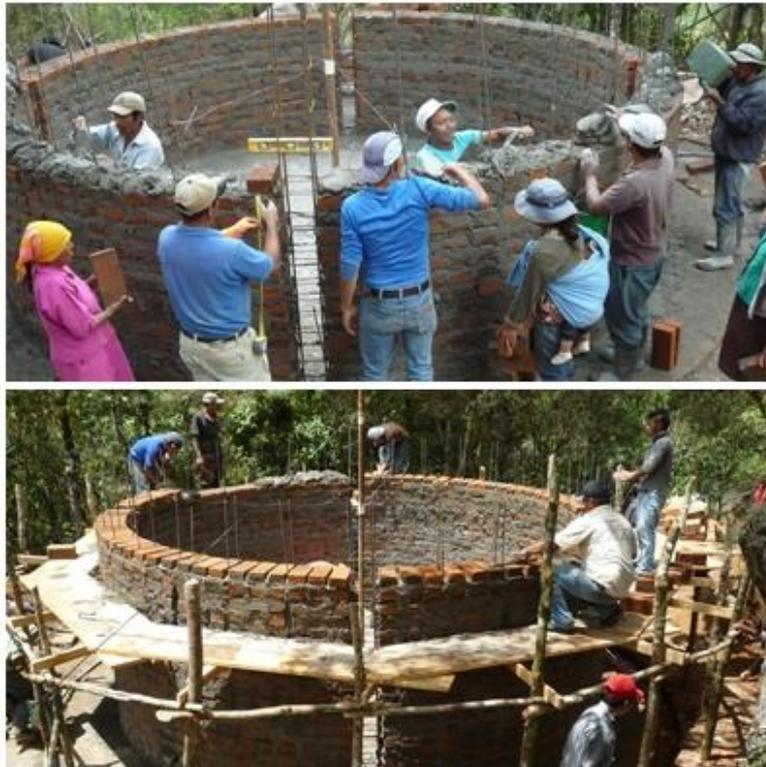
**Figura 34: Levantamiento de las paredes del tanque**
