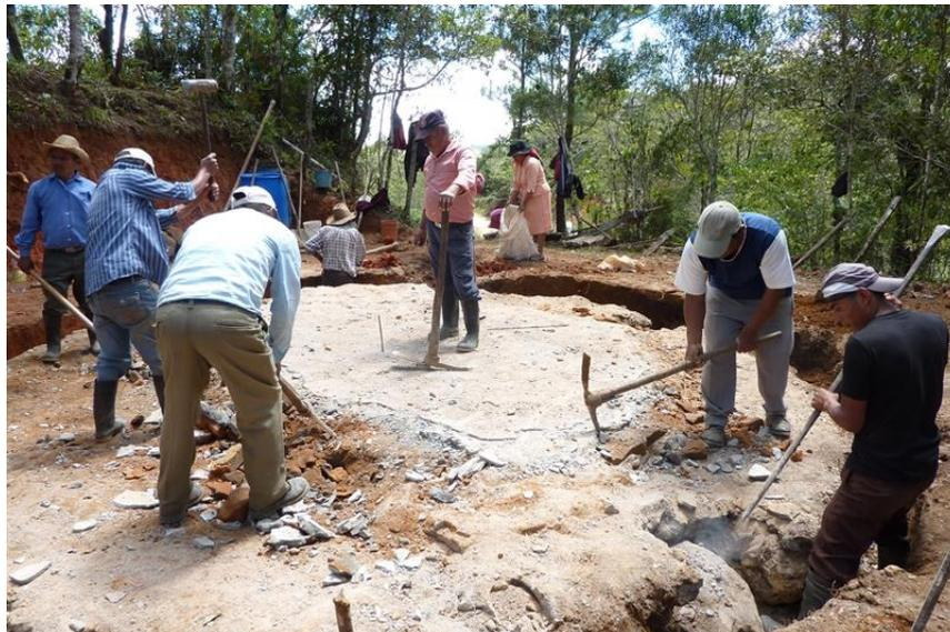
**Figura 32: Excavación para ampliar el perímetro del tanque**
