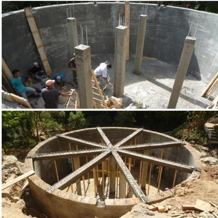
**Figura 63: Castillos y vigas fundidos**
