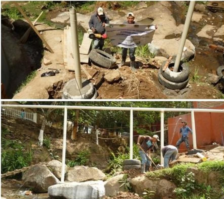
**Figura 69: Paso aéreo para conducir el agua al tanque**
