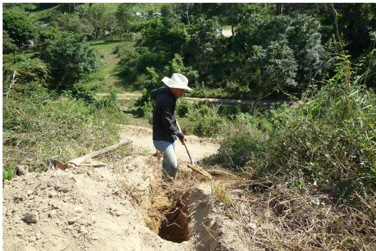
**Figura 44: Zanjeo para la tubería de distribución**
