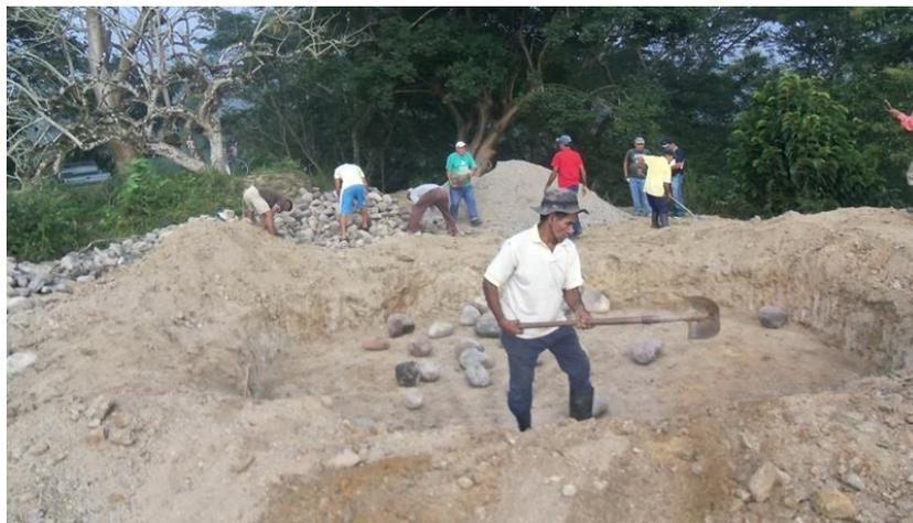
**Figura 39: Excavación del plantel para el tanque**
