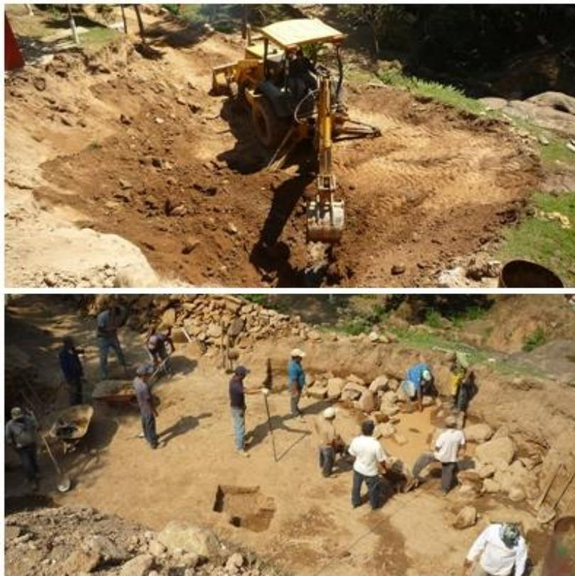
**Figura 59: Excavación con máquina y canteros**
