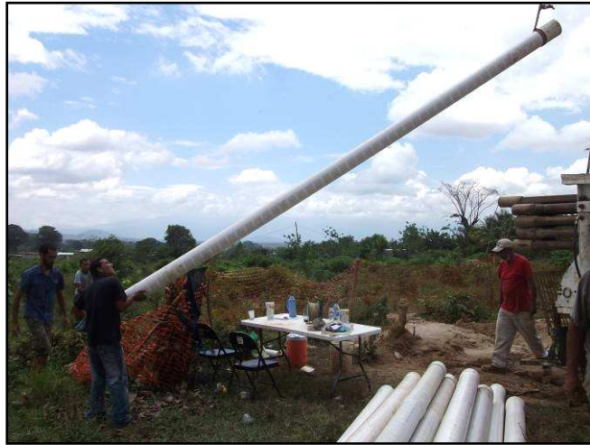
Operarios de “Will Vall Pozos” durante la instalación del Ademe de 8”.
