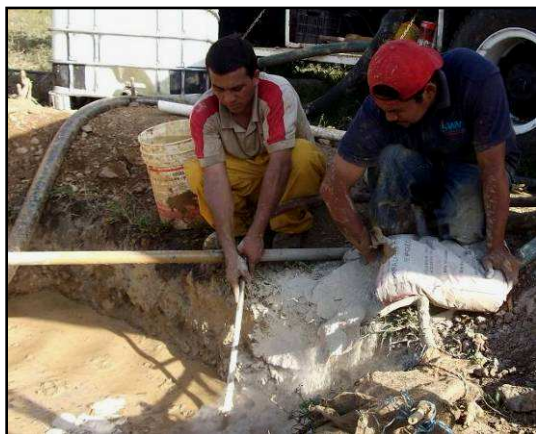
Operarios de “Will Vall Pozos” regulando la viscosidad de los lodos de perforación, a la izda usando Bentonita y a la derecha cáscara de arroz.
