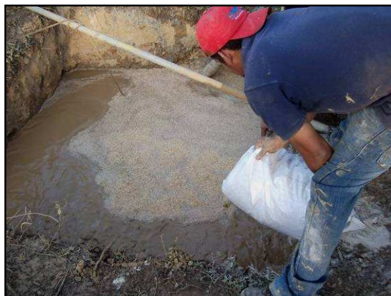
Operarios de “Will Vall Pozos” regulando la viscosidad de los lodos de perforación, a la izda usando Bentonita y a la derecha cáscara de arroz.
