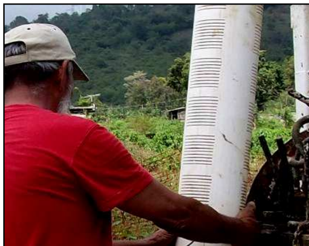
Detalle de las características de los tramos de rejilla instalados en el sondeo
