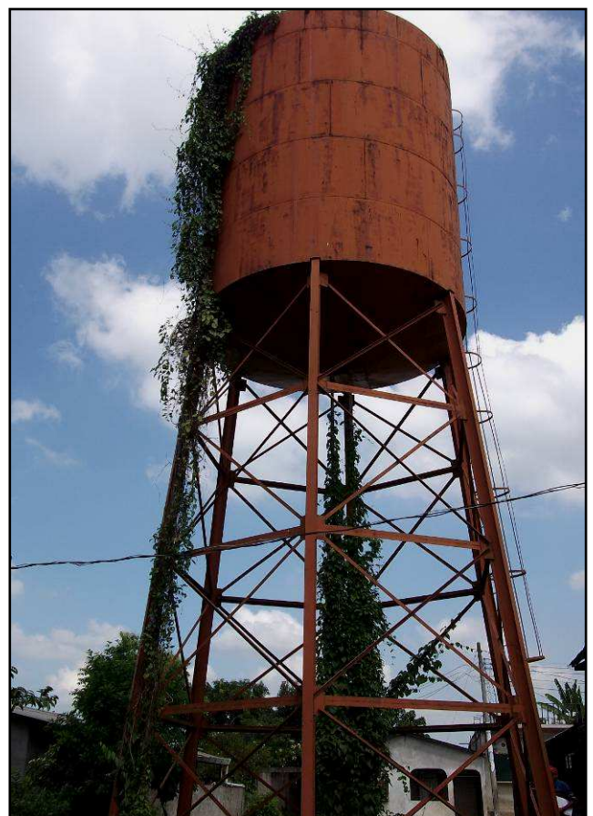
Tanque elevado de la colonia La Primavera
