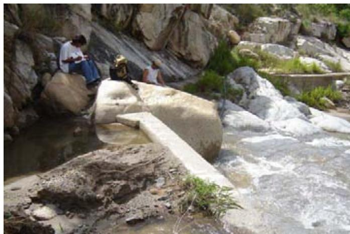
**Fotografía 5.1. Captación del Sistema de Agua por Gravedad de la Comunidad de Los Arados en el Río Mosonte**
