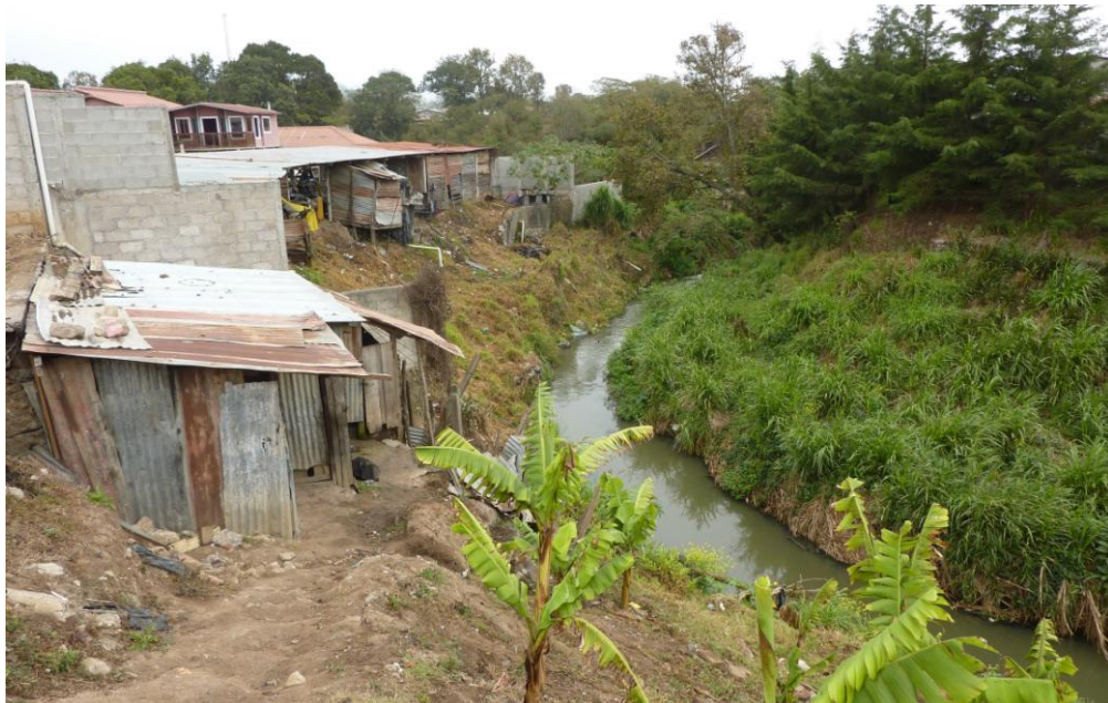
Construcciones en la faja de protección de la margen izquierda de un curso fluvial
