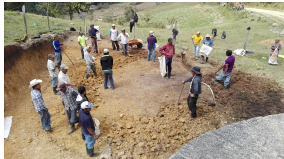
Labores de excavación del terreno para emplazamiento del nuevo depósito, muy próximo al antiguo existente, en el proyecto de Planes de Yamaranguila.
