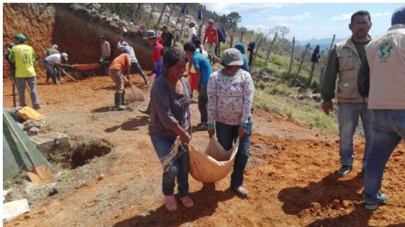
Visita de Campo. Trabajos de excavación para emplazamiento de Depósito Regulador. Proyecto de Portillos del Norte
