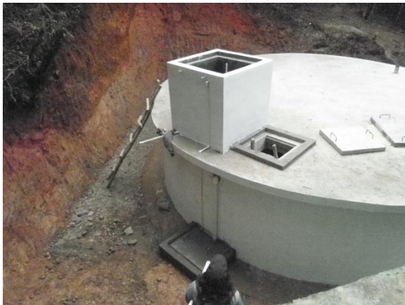
Detalle de la instalación del sistema de cloración en la parte superior del tanque, adosado al hueco de entrada al interior del tanque.
