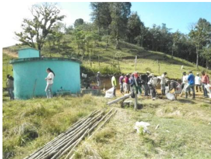
Labores de excavación del terreno para emplazamiento del nuevo depósito, muy próximo al antiguo existente, en el proyecto de Planes de Yamaranguila.
