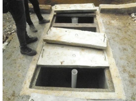
Panorámica de la obra toma en el proyecto del Tabor (en la imagen de la izquierda) y detalle de la caja filtro compartimentada (en la imagen de la derecha).
