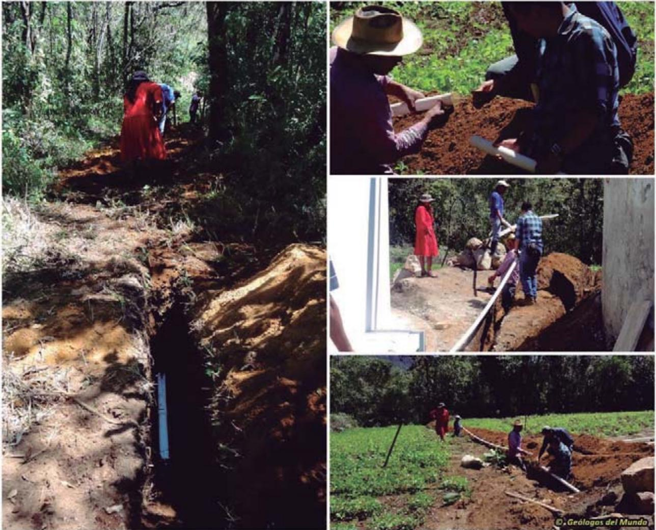
Instalación de tubería de distribución para sectorizar el servicio.
