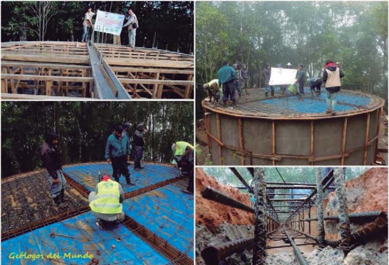
Encofrado de las vigas y de la losa superior de cierre, y colocación del armado de hierro
