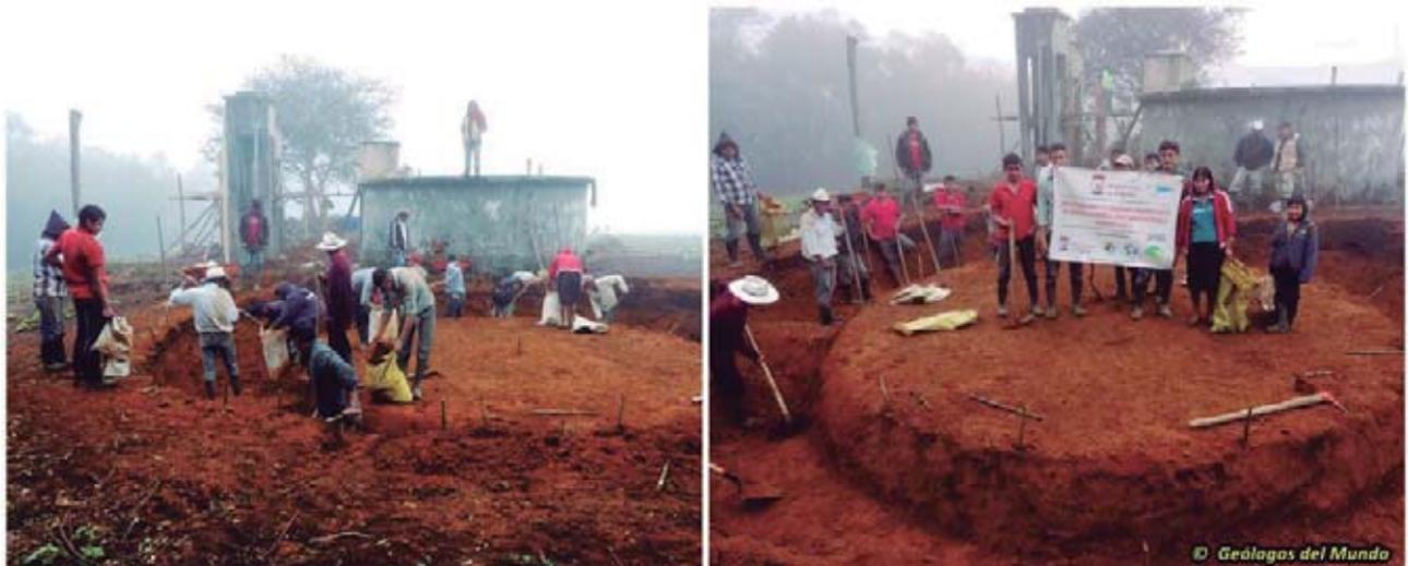
Excavación de cimentación. La rasante de excavación para el anillo perimetral alcanzó 1,10 m de profundidad, a partir de la cual se realizaron los pozos de cimentación de los pilares de 0,60x0,60x0,80 metros..
