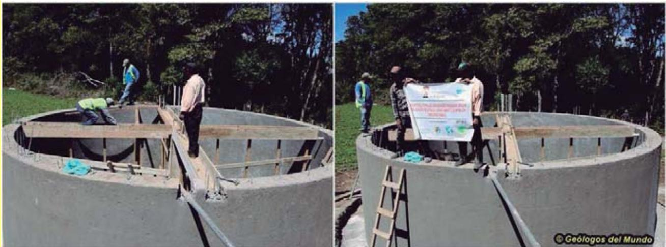
Encofrado de las vigas y de la losa superior de cierre.
