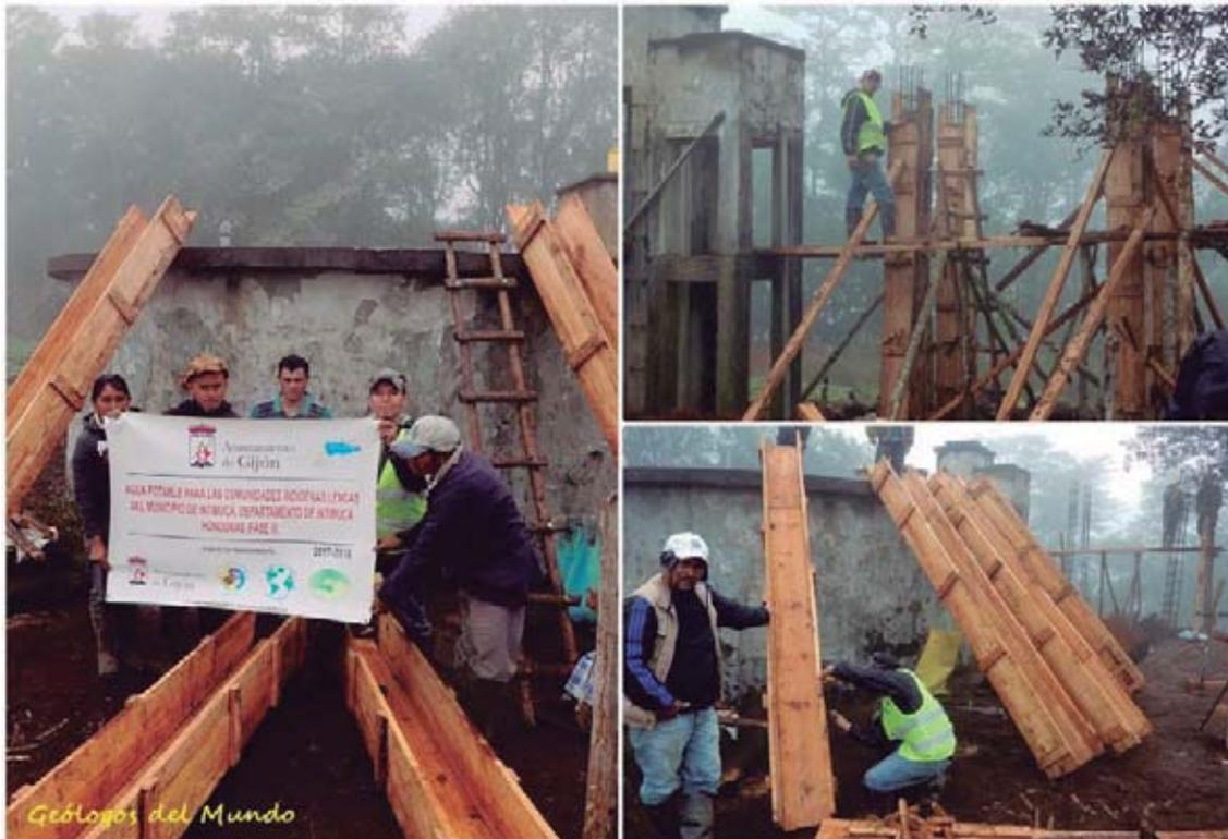
Después de fraguar varios días, se desencofran los pilares y se pica su superficie para que el repello tenga una mejor adherencia. Se colocan 4 vigas de atado superior con un voladizo de 50 cm que constituirán el forjado sobre el que se colocará la caja derivadora. Sobre ese voladizo se construirá una acera para las operaciones de funcionamiento y mantenimiento de la caja.
