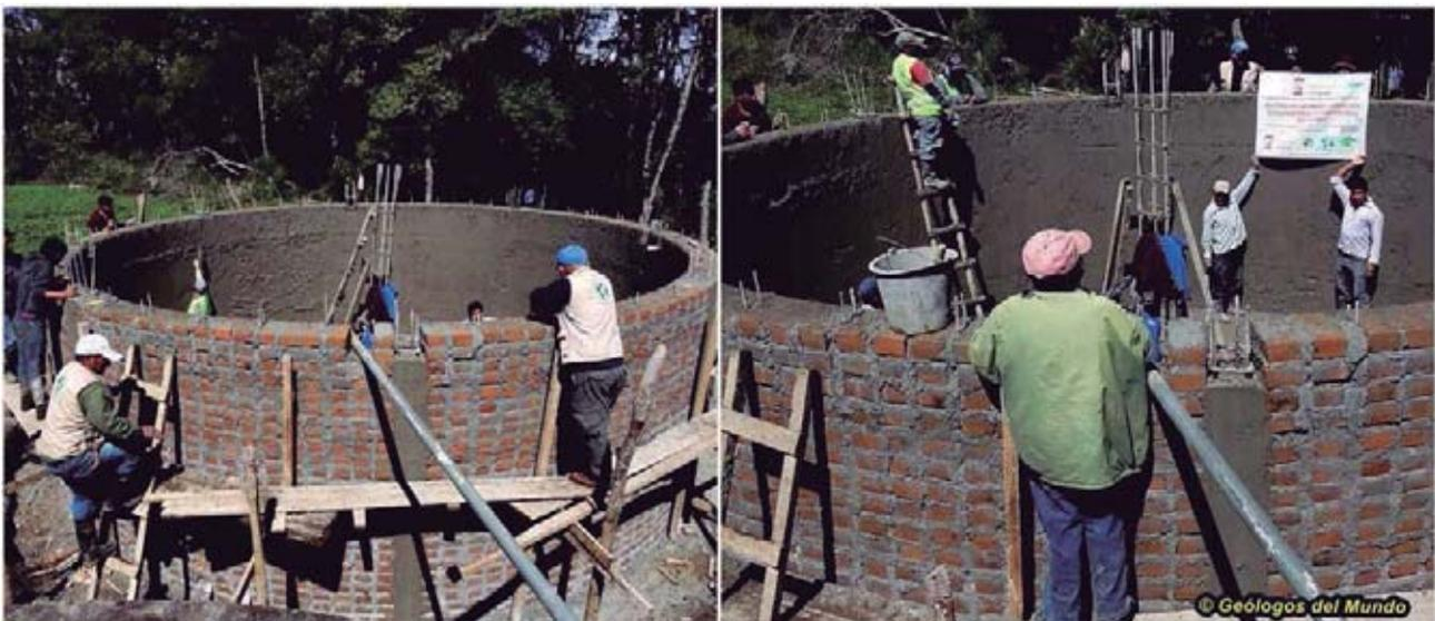
Repello interior de las paredes mediante mortero fino. Esto se realiza para proteger el ladrillo del agua, dar un refuerzo a la pared y proporcionar una mejor estanqueidad. Tanto al mortero de liga de los ladrillos, como al del repello se les incorpora un producto impermeabilizante para hacerlos hidrófugos. Igualmente, a la solera e incluso a la cimentación. En el interior el repello se remata con un pulido fino para tapan poros y mejorar las labores de limpieza en el mantenimiento
