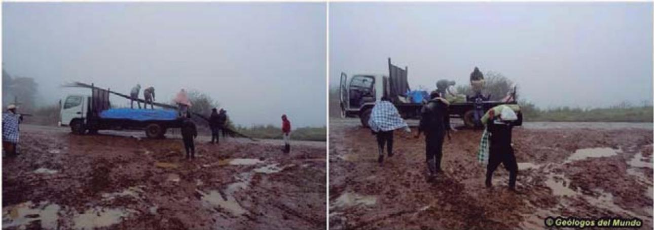
De forma paralela a la excavación de la cimentación se llevó a cabo el acarreo de materiales que tuvieron que ser transportados a hombros en el mejor de los casos 800 metros y no siempre en las mejores condiciones meteorológicas.
