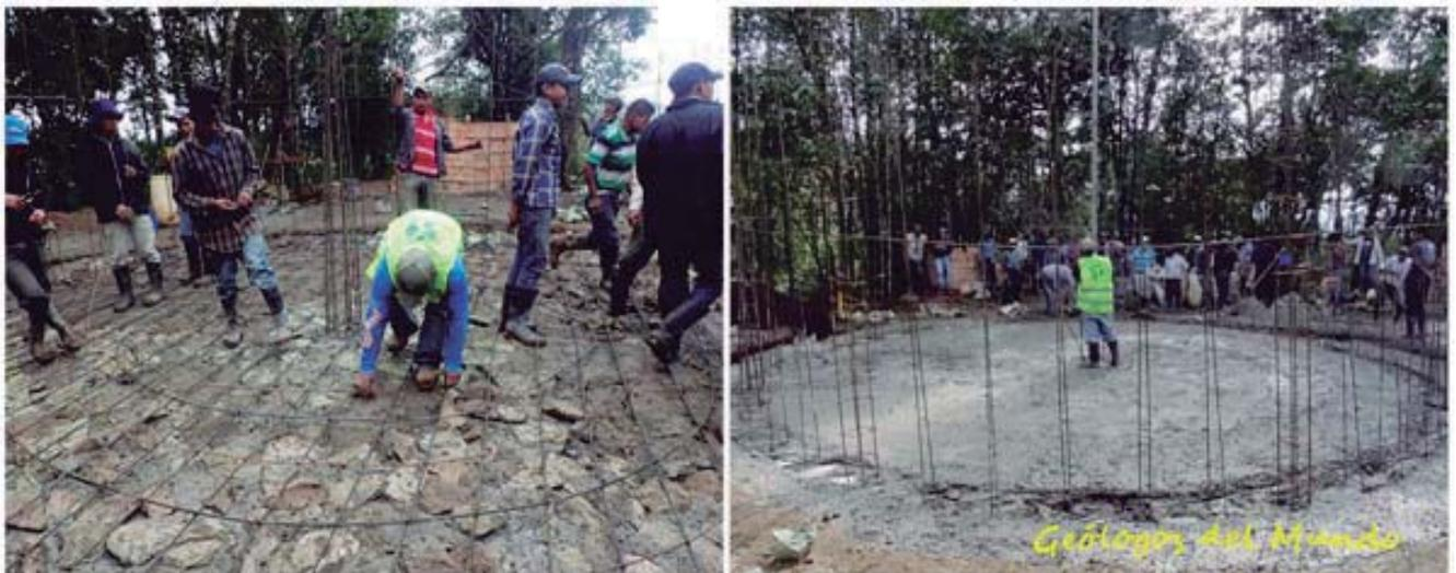
En la foto derecha se puede ver el armado vertical de varilla de hierro (bastones) que reforzará las paredes de ladrillo. Estas se disponen con espaciado de tres ladrillos
