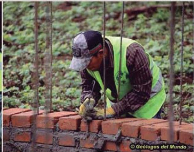
Arranque con la primera hilada la construcción de las paredes de ladrillo rafón y levantamiento de las mismas.
