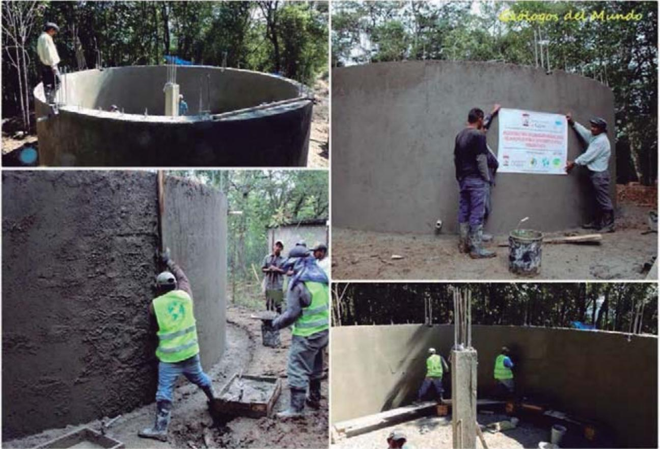
Repello interior y exterior de las paredes mediante mortero fino. Esto se realiza para proteger el ladrillo del agua, dar un refuerzo a la pared y proporcionar una mejor estanqueidad. Tanto al mortero de liga de los ladrillos, como al del repello se les incorpora un producto impermeabilizante para hacerlos hidrófugos. Igualmente a la solera e incluso a la cimentación. En el interior el repello se remata con un pulido fino para tapar poros y mejorar las labores de limpieza en el mantenimiento.
