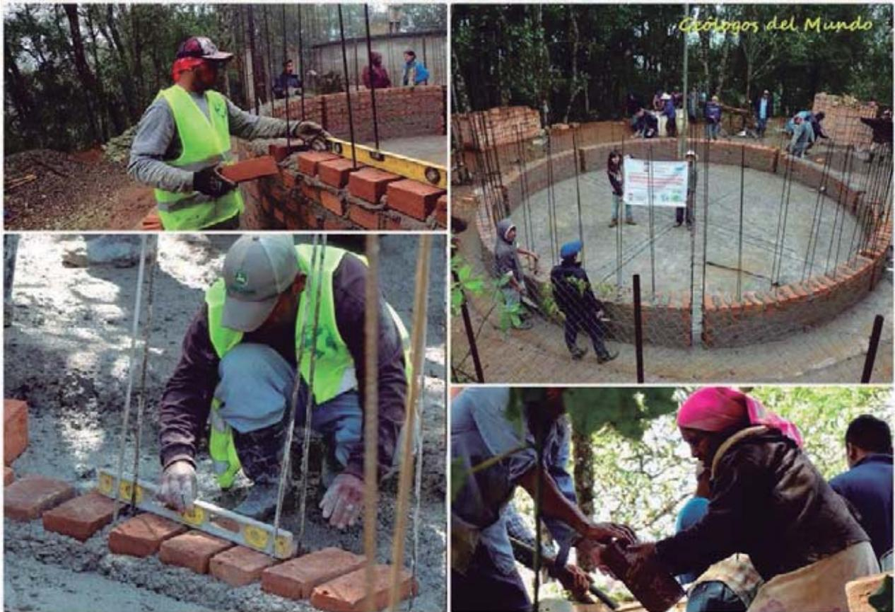
Arranque con la primera hilada la construcción de las paredes de ladrillo rañón y levantamiento de las mismas.
