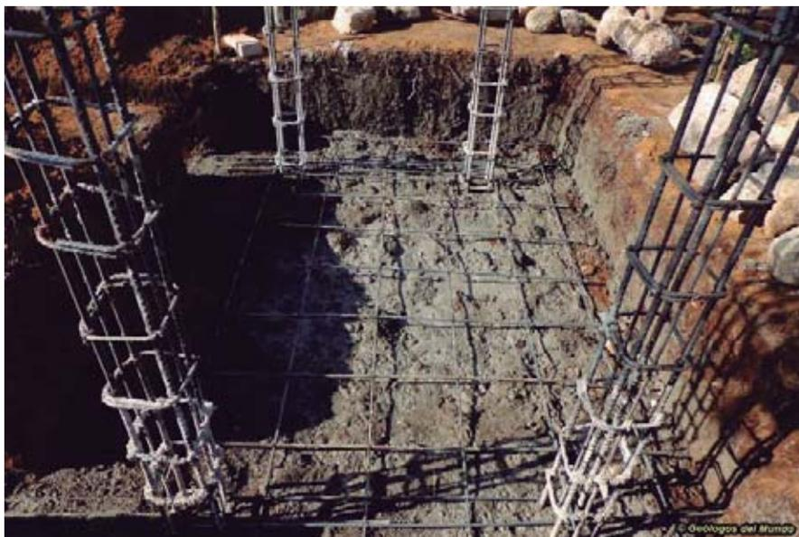
Se colocan andamios y se encofran mediante madera los pilares. Posteriormente se funden con hormigón y se dejan fraguar durante unos días.
