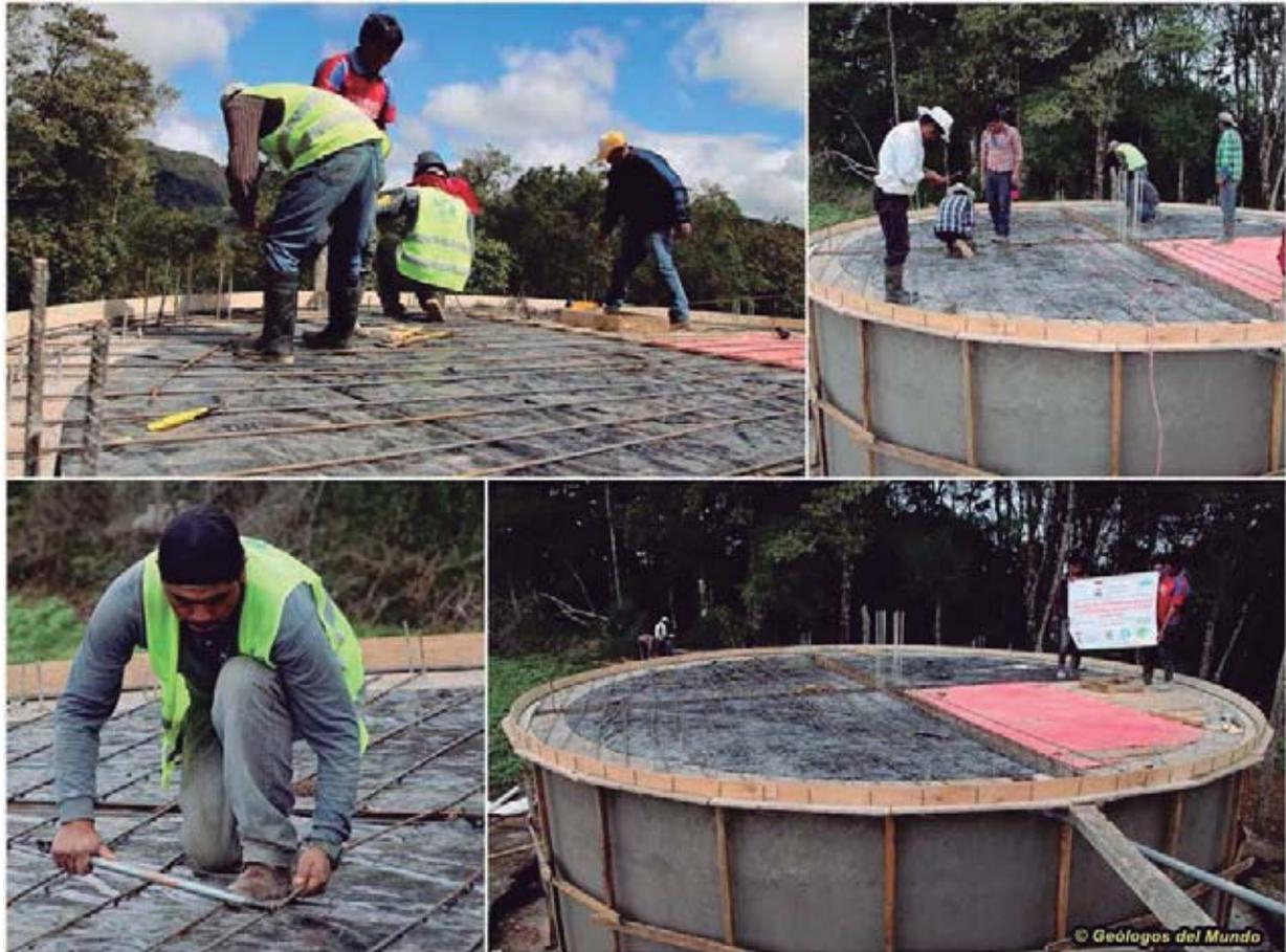
Colocación del armado de hierro de la losa para el posterior fundido con hormigón en masa.
