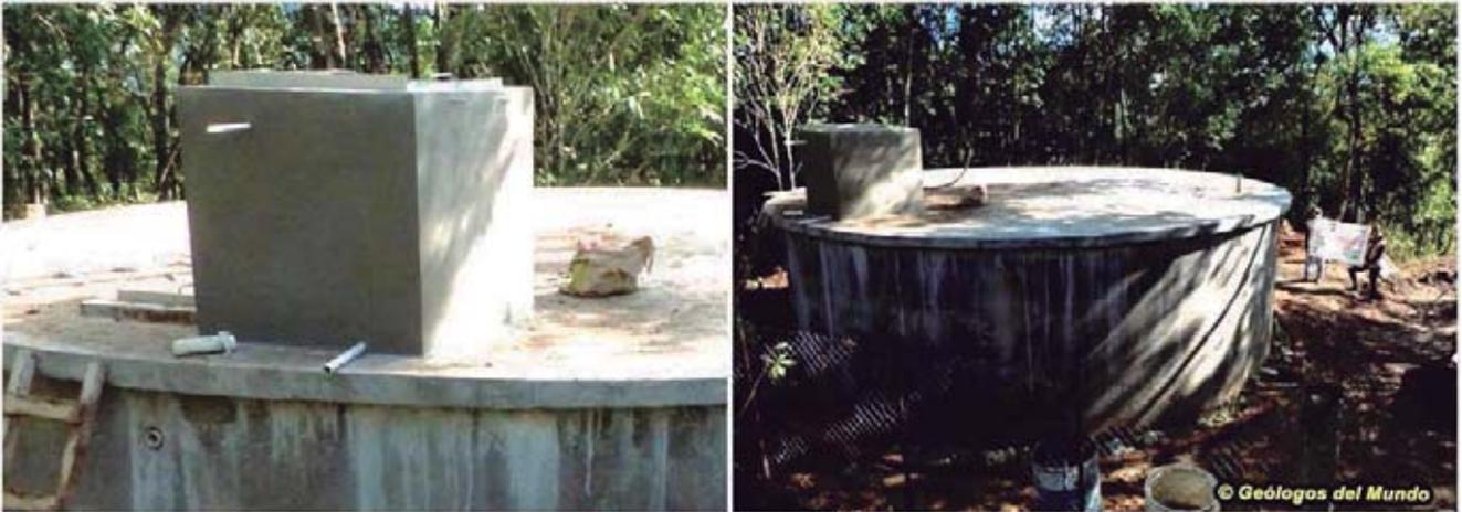
.Hipoclorador para la desinfección del agua mediante goteo de una disolución de cloro
