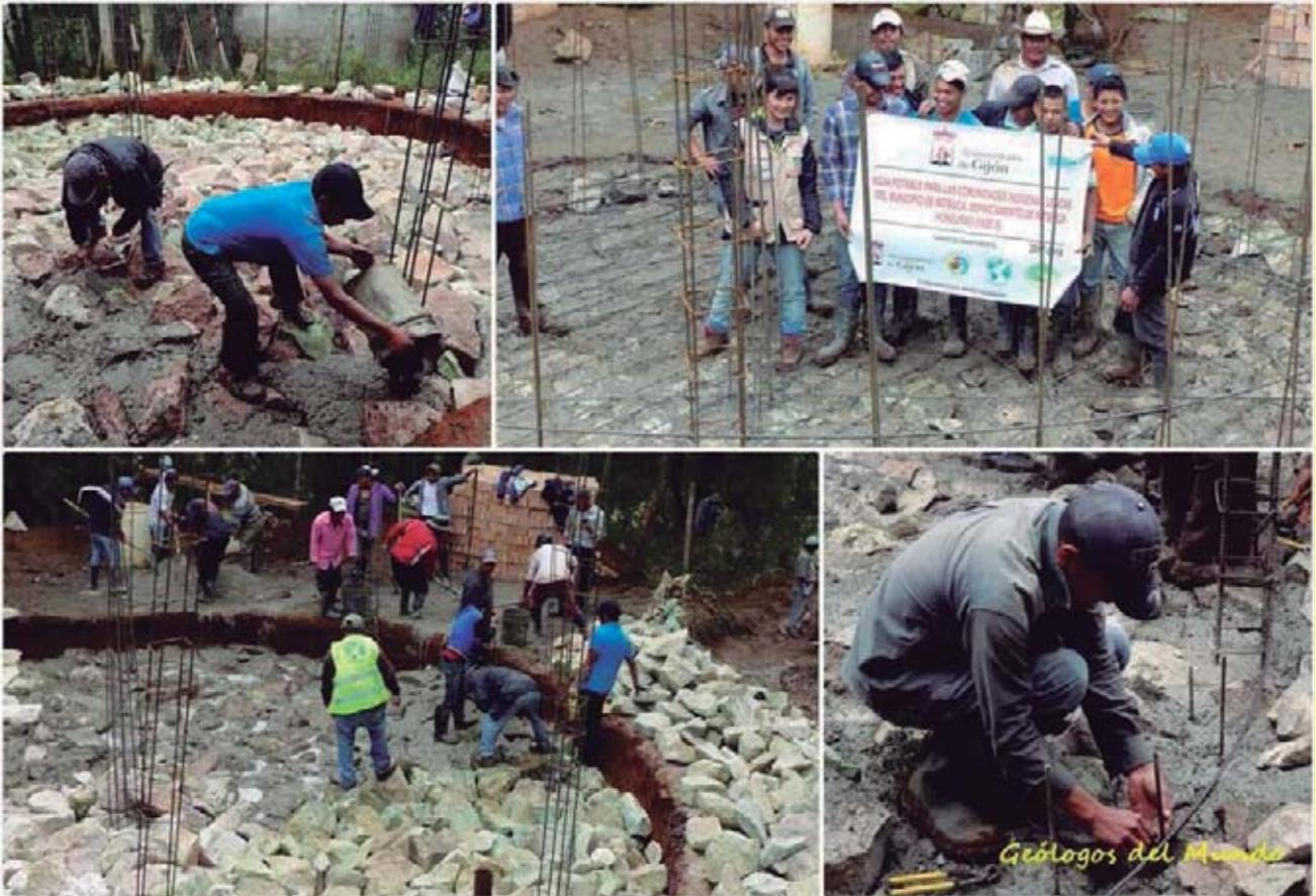
Construcción de la losa de reparto de cimentación realizada con hormigón ciclópeo. Sobre ella se construirá una solera de hormigón en masa armado desde la que arrancarán las paredes.
