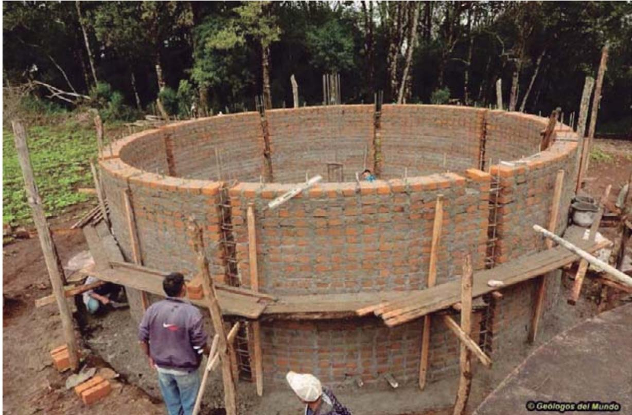
Cerramiento de ladrillo ya finalizado. A continuación, se fundirán los pilares y todo ello se recubrirá con un repello.
