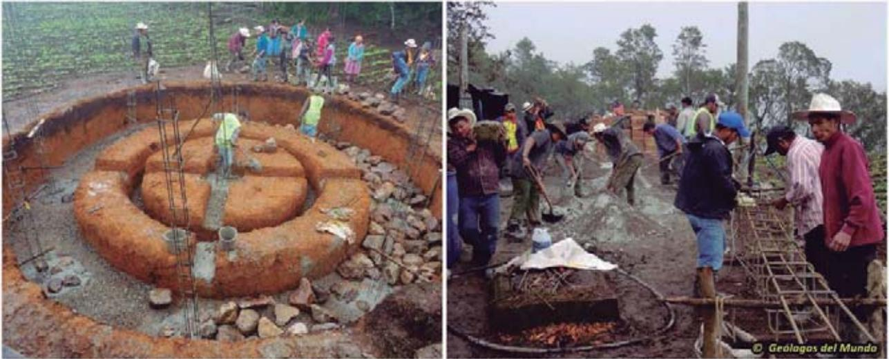
Inicio de la cimentación. Se puede observar los armados de los pilares perimetrales y central ya instalados. En la foto superior derecha montando el armado de varillas de hierro de la viga perimetral de atado.
