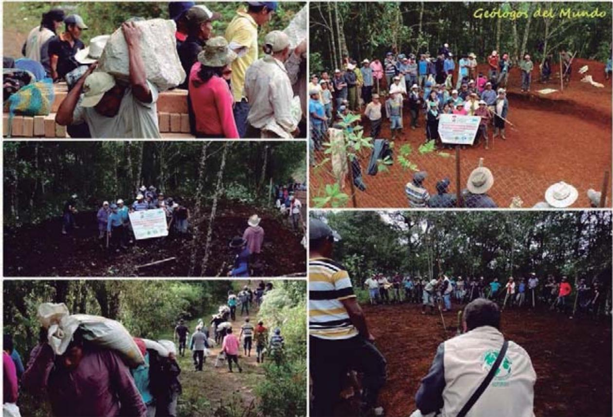
Labores de acarreo de materiales, limpieza y desbroce, replanteo y excavación de cimentación.
