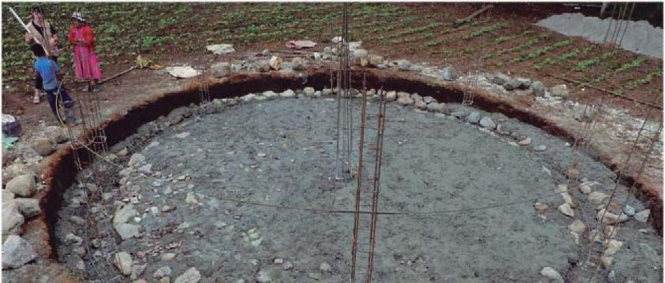
Diferentes etapas de la cimentación. En la foto inferior la losa de reparto ya finalizada; sobre ella se construirá una solera de hormigón en masa armado desde la que arrancarán las paredes.
