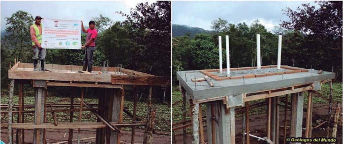
Se levantan los cerramientos de la caja mediante ladrillo rafón dispuesto al hilo, procediéndose a su repello o enfoscado. Posteriormente se realizaron las divisiones interiores correspondientes a las dos cámaras de filtro primario con el repello correspondiente.
