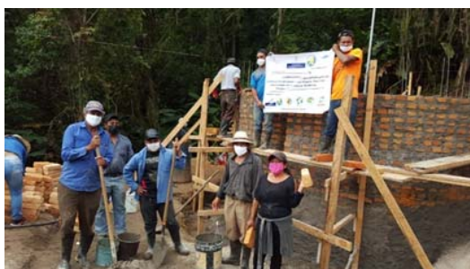
Construyendo cisterna de bombeo
