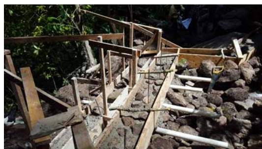
Construyendo obra toma
