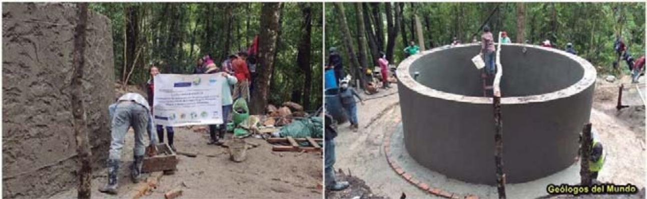
Figura 78.- Refuerzo y acabado de las paredes mediante repello exterior e interior. En la parte interior sobre el repello se remata con un enlucido y afinado con lechada de cemento.
