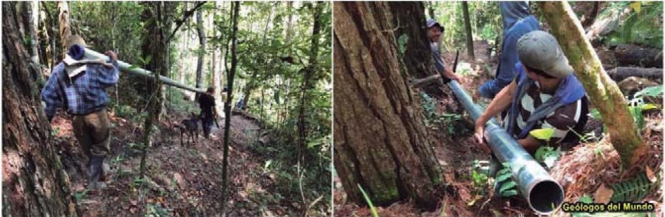
Figura 87.- Transporte de tubería de hierro galvanizado (HG) a los puestos de trabajo. Se trata de tubería pesada que conllevó algunas complicaciones de transporte a los puestos y de colocación.
