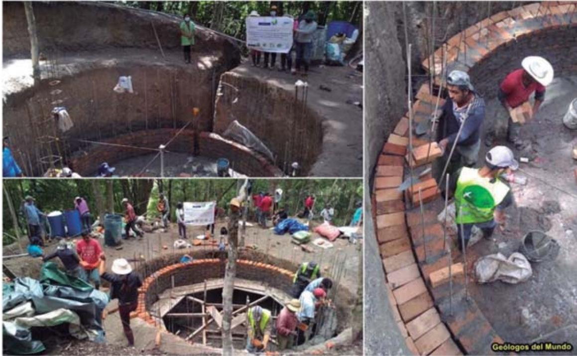
Figura 77.- Construcción de los parámetros de cierre (paredes) mediante paneles de ladrillo rafón a testa, con su correspondiente armadura vertical y horizontal, y los castillos perimetrales.
