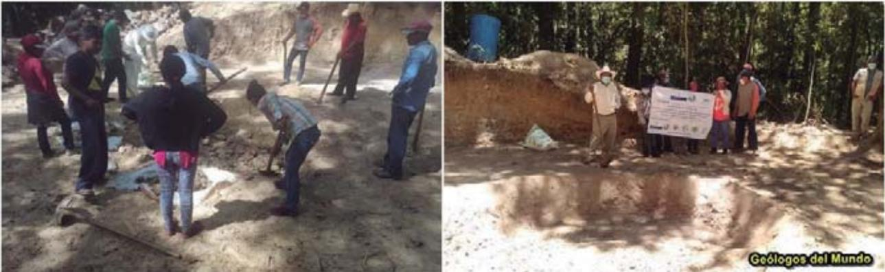
Figura 73.- Etapa de limpieza y nivelación del emplazamiento. Se procede a un desmote de nivelación del terreno creando un plantel de las dimensiones adecuadas a partir del cual se arranca con la excavación para el encaje de la estructura. En este desmote se elimina el nivel de suelos y la parte más meteorizada de los materiales geológicos soporte (tobas líticas volcánicas).
