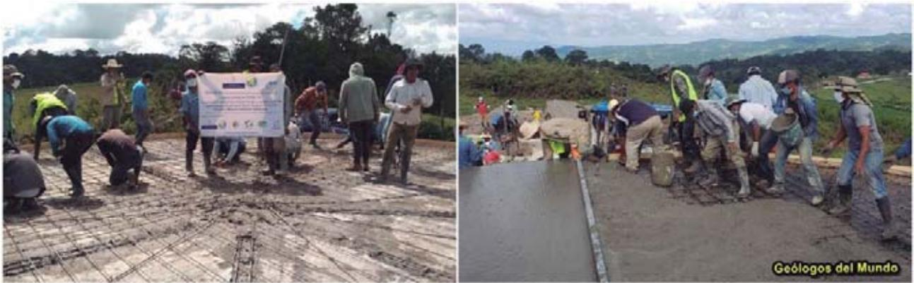
Figura 103.- Fundido de hormigón de la losa superior de cierre del depósito. Todas las operaciones se realiza totalmente a mano, con lo que la participación de trabajo comunitario es fundamental, ya que hay que fundir lo más rápido que se pueda.
