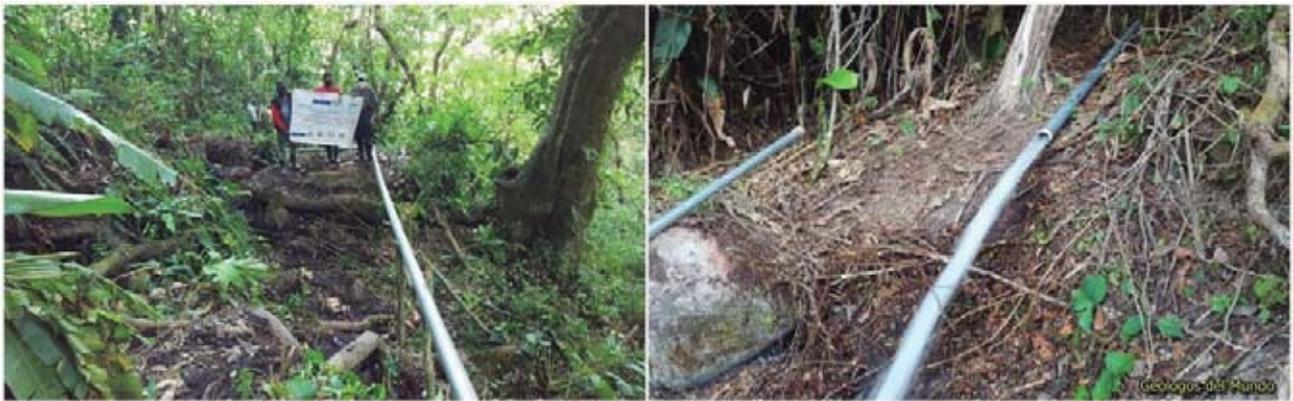
Figura 70.- Tubería instalada. A la derecha se observa el agua captada saliendo por la tubería de conducción en su tramo final. Longitud total de la línea 52 m.
