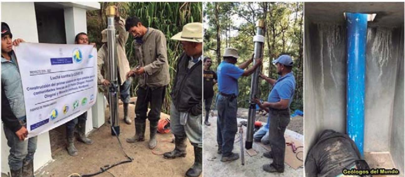
Figura 107.- Bombas de agua dispuestas para ser instaladas. A la izquierda, bomba sumergible de 10 Hp de potencia para la cisterna nº1; en el centro, bomba sumergible de 15 HP de potencia instalada en la cisterna nº2; a la derecha, tubo de 8" para encapsulación de las bombas.
