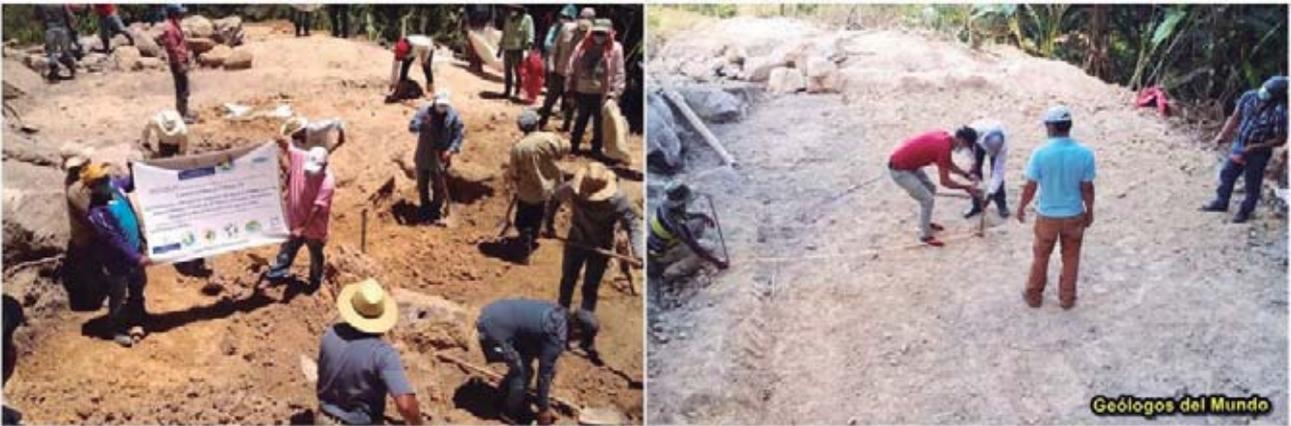
Figura 59.- Etapa de desmonte de nivelación. Todas las operaciones fueron realizadas a mano. A la izquierda, realizando labores de desmonte de nivelación; a la derecha el plantel de nivelación a partir del cual se procede al marcado del perímetro de excavación para la cimentación.
