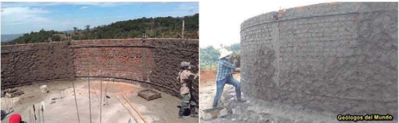
Figura 100.- Acabado de las paredes mediante repello interno y externo con mortero.
