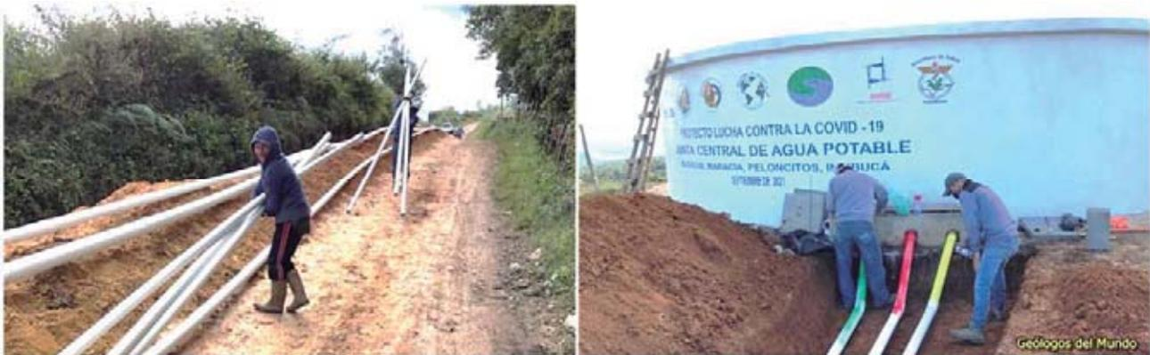
Figura 91.- Instalación de tubería de PVC. En la foto de la derecha, iniciando ya la instalación de las tuberías de salida a distribución para cada una de las tres comunidades; se identifica con pintura de color.
