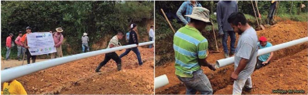
Figura 90.- Proceso de instalación de tubería de PVC.
