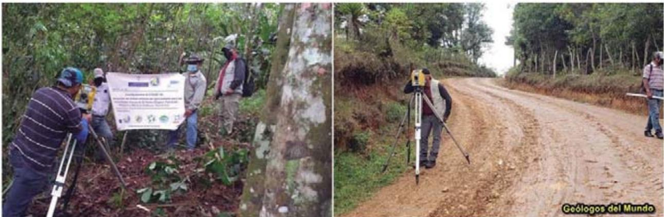
Figura 41.- Trabajos de topografía de línea de impulsión.
