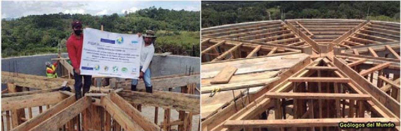
Figura 102.-Encofrado de las vigas y losa de cierre del depósito.
