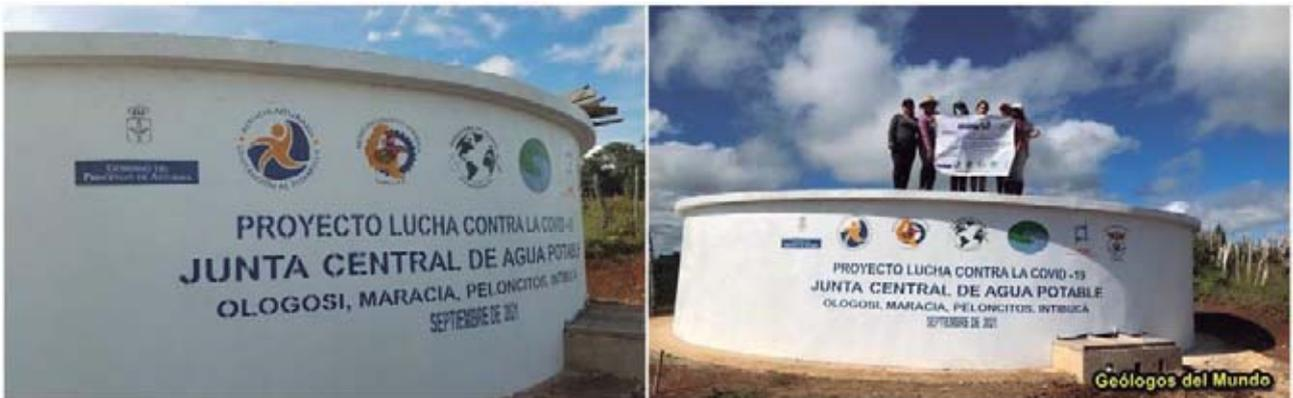
Figura 104.- Depósito de almacenamiento y distribución de agua potable de 42.330 galones de capacidad ya finalizado, pintado y con rotulado identificativo en el que figuran los diferentes participantes en el proyecto.
