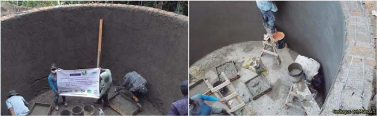
Figura 64.- Protección y refuerzo de las paredes mediante repello con mortero. El repello se aplica tanto en la cara exterior como en la interior, en esta última se remata además con un afinado con lechada de cemento y pulido para cerrar poros.
