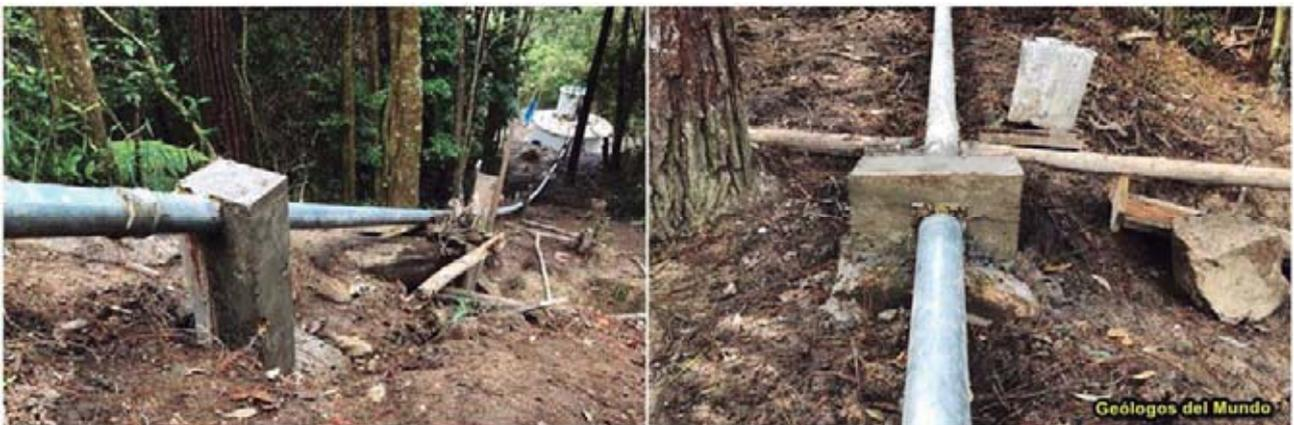
Figura 89.- Construcción de soportes y anclajes de la tubería de HG que se instala superficialmente.
