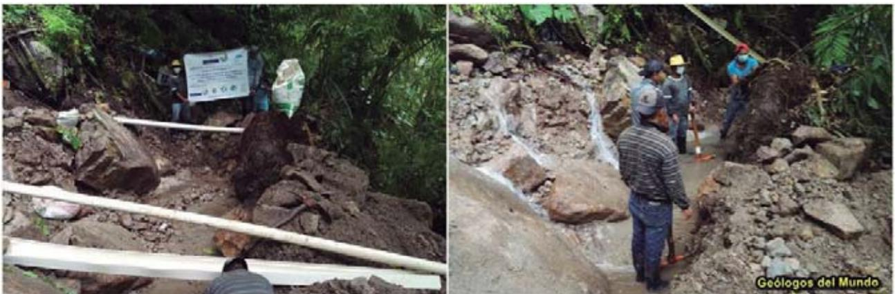
Figura 49.- Excavación para la cimentación de la cortina frontal y caja recolectora/filtro. En la imagen de la izquierda se observan los tubos para evacuar el agua de la fuente del puesto de trabajo.
