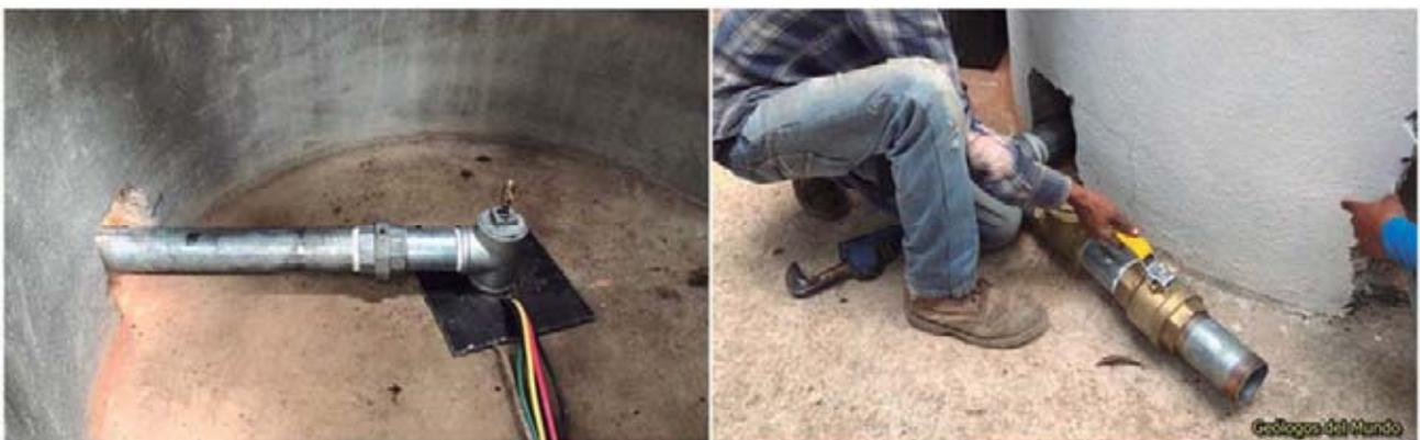
Figura 109.- Instalación de tren de descarga
