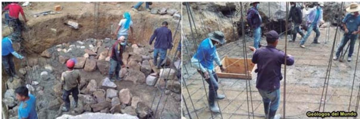
Figura 62.- Construcción de la cimentación de la cisterna. A la izquierda tarea de construcción de la losa ciclópea; En la foto de la derecha se puede observar el cajón de encofrado del pozo en el que va a ir alojada la cabeza de la bomba sumergible; y también a los beneficiarios participando en la colocación del armado de la solera sobre la losa. Para todas las operaciones constructivas, tanto el hormigón como el mortero fueron elaborados in situ de forma manual.
