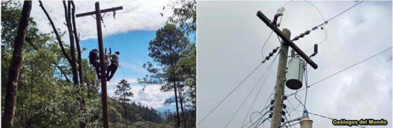
Figura 106.- Instalación del tendido eléctrico y su correspondiente unidad de transformación y estabilización eléctrica. Proceso de instalación.
