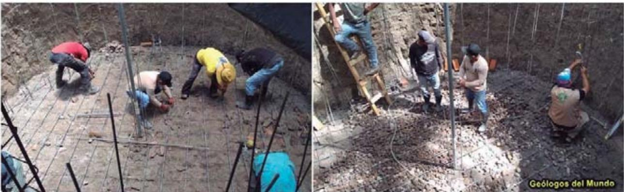
Figura 76.- Construcción de la solera armada sobre losa y arranque de las paredes.
