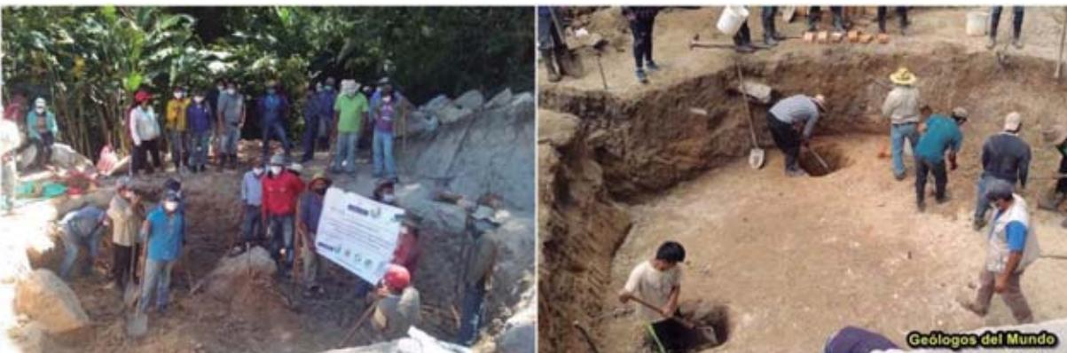
Figura 60.- Excavación de cimentación. A partir del fondo de esa excavación se llevó a cabo la ejecución de los pozos para la cimentación de los castillos perimetrales y la columna central.
