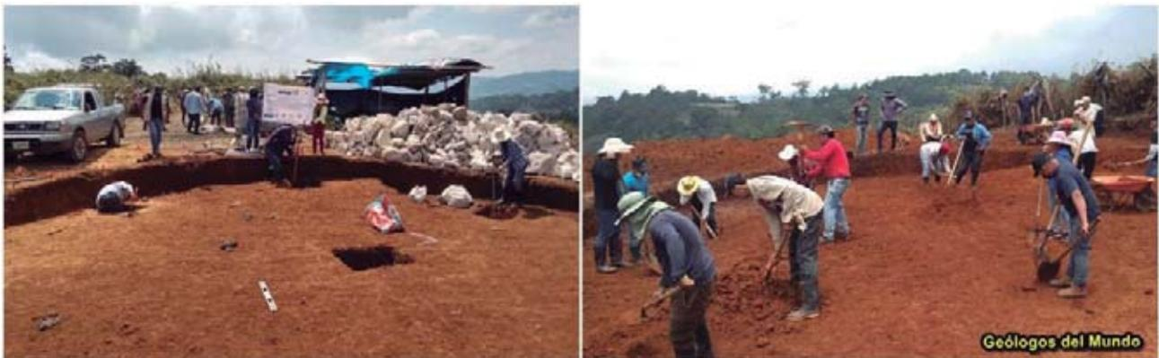
Figura 96.- Excavación de cimentación ajustada ya a la geometría circular de la losa.
