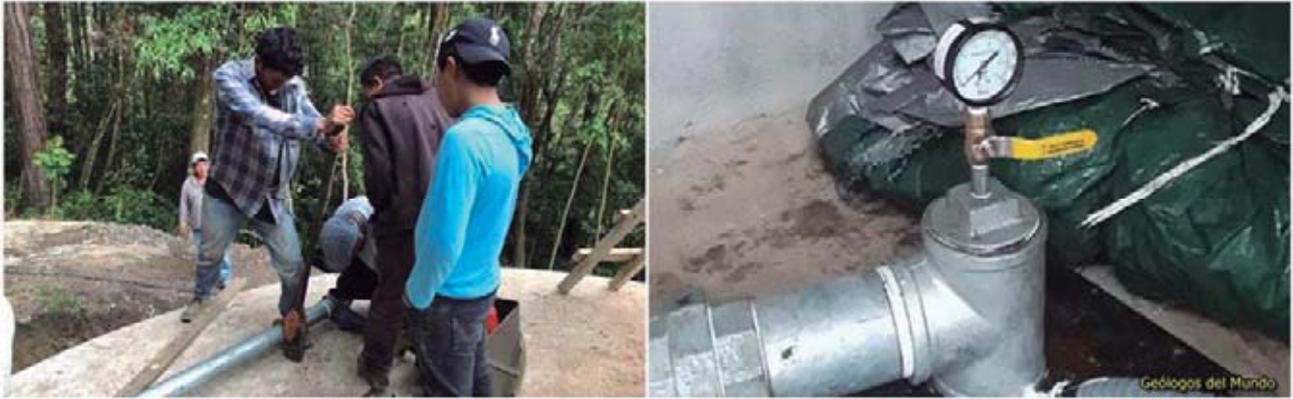
Figura 110.- Tren de descarga. Y manómetro de presión de funcionamiento de la bomba.
