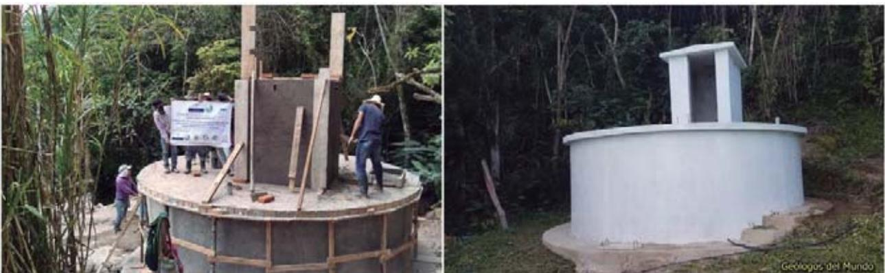
Figura 66.- Sobre la losa superior, se construye la caseta de protección de la bomba de agua y sus paneles de control. Finalmente se procede al pintado exterior de toda la estructura. En la foto de la derecha se puede observar la acera perimetral que remata a la cisterna en su parte inferior.
