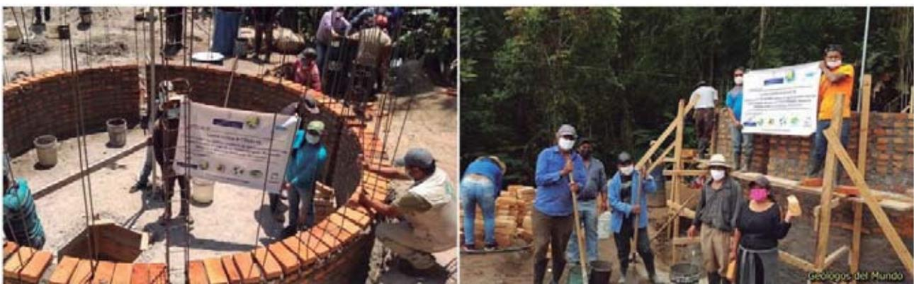
Figura 63.- Construcción de los paramentos verticales de cierre (paredes). Ladrillo rañón (macizo) dispuesto a testa, reforzado por un armado vertical y horizontal (en el exterior e interior de la pared) y por cuatro castillos perimetrales. Los ladrillos son previamente remojados en agua con un aditivo impermeabilizante para sellar su porosidad y evitar la capilaridad; el aditivo también se utiliza con el mortero de pega de ladrillos y de repello.
