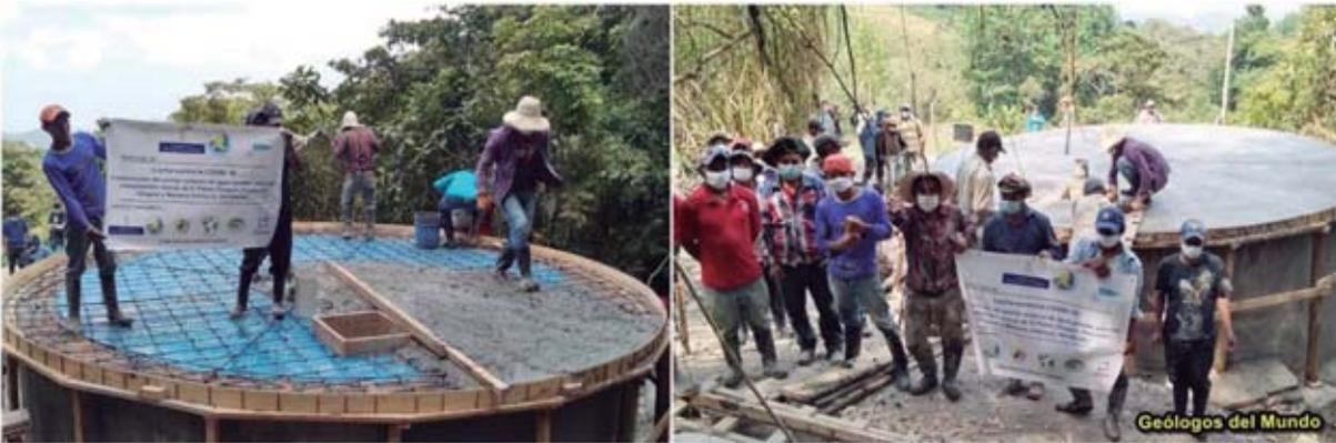
Figura 65.- Construcción losa armada superior de cierre. Después de realizar el pertinente encofrado, se procede a la colocación del armado de la losa, tras lo cual se lleva a cabo el fundido mediante el vertido de y nivelación de hormigón; esta nivelación se realiza con una ligera pendiente del centro hacia el borde para favorecer la no acumulación de agua de lluvia sobre la losa.
