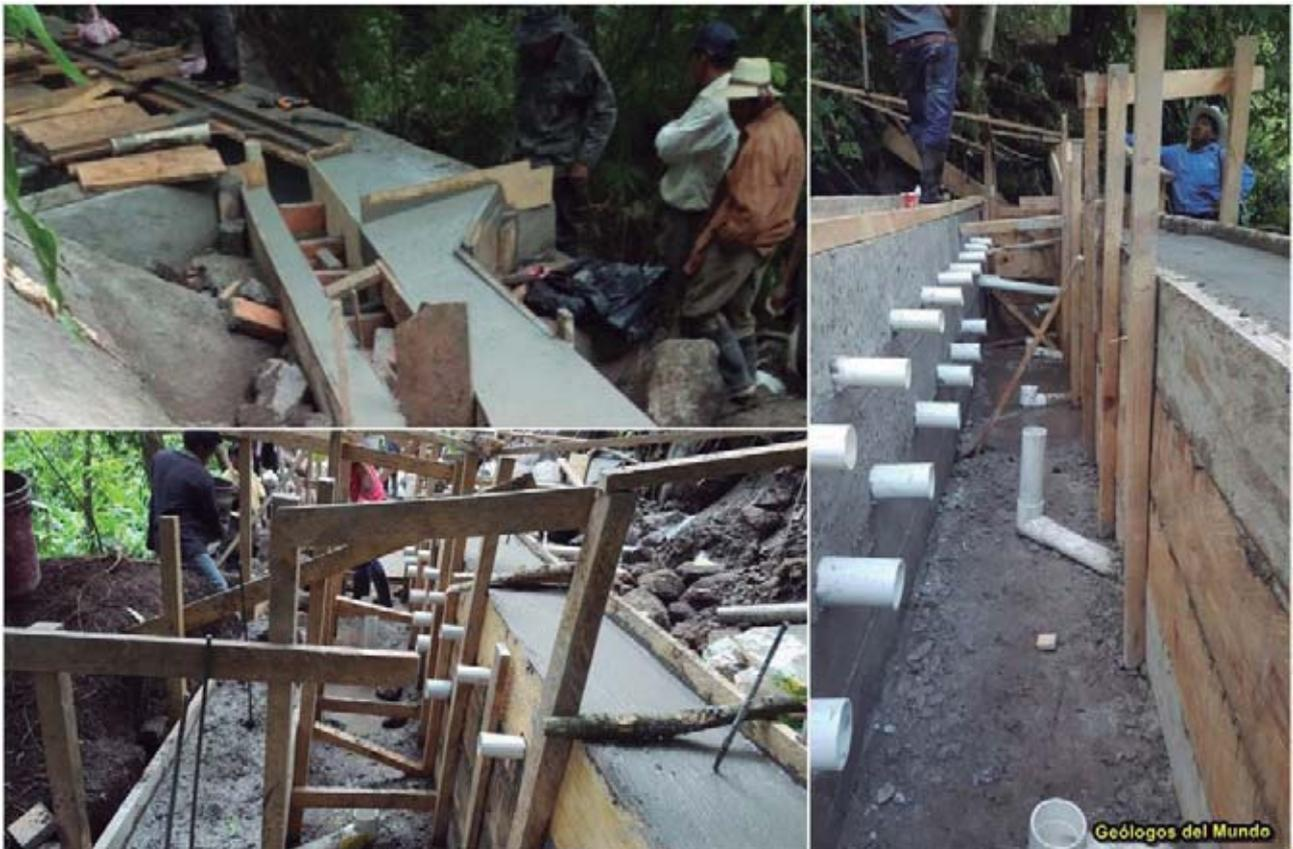
Figura 51.- Construcción de muro frontal y trasero de la estructura. Se observan los tubos transversales en interior del muro trasero que serán los encargados de hacerlo permeable al agua para que quede atrapada en los canales recolectores y en la caja concentradora/filtro. En la foto de la derecha se pueden ver en el piso los tubos para rebose y limpieza de las celdas filtro.
