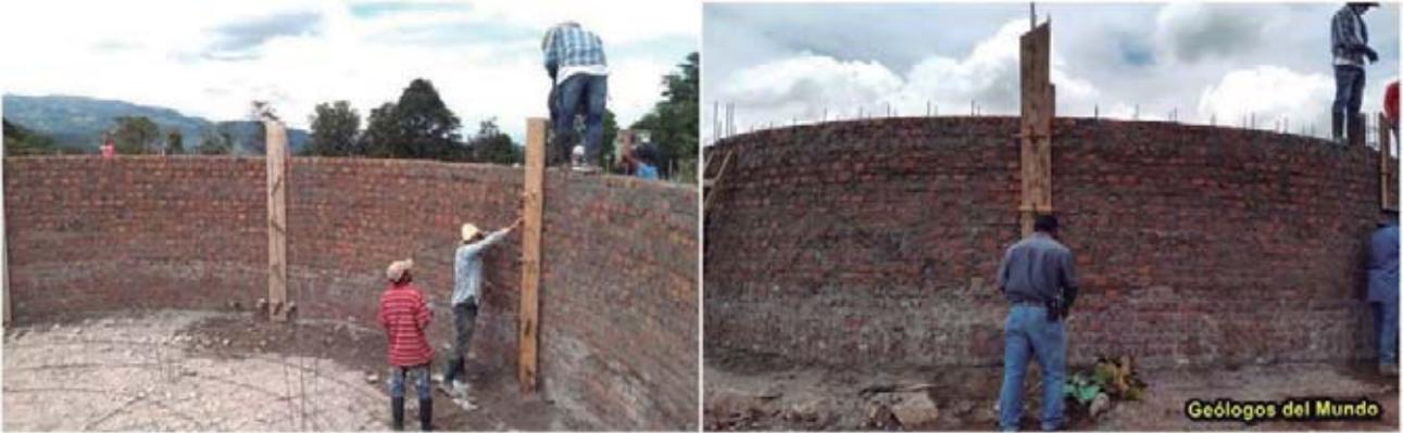
Figura 99.- Fase de construcción de las paredes. Fundido de los castillos perimetrales.
