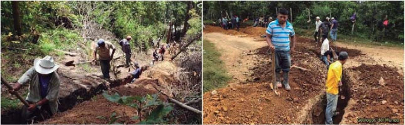
Figura 84.- Excavación de la zanja para el enterramiento de la tubería de PVC.
