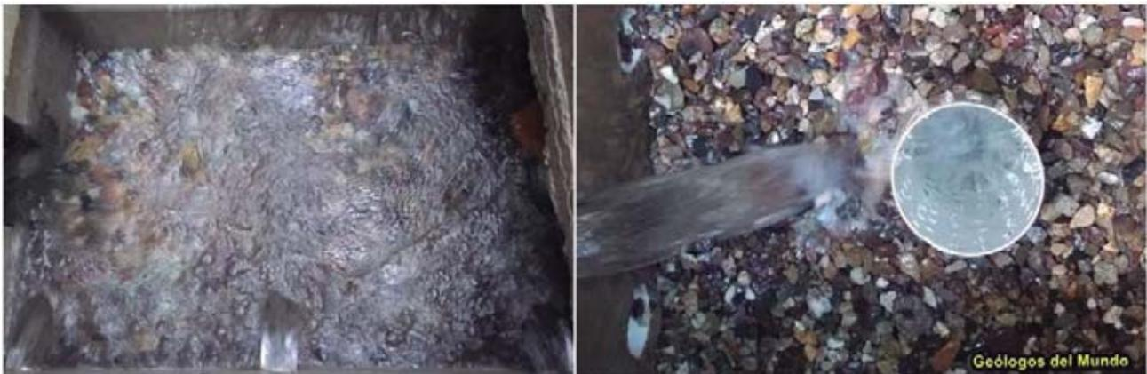
Figura 56.- Obra toma en funcionamiento. Celdas fitro de gravas.
