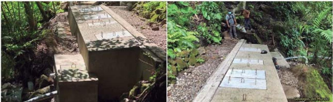
Figura 55.- Vista general de la captación finalizada. Se observa en el trasdós del muro trasero la parte superior del prefiltro de piedra, rematado por una capa de grava.
