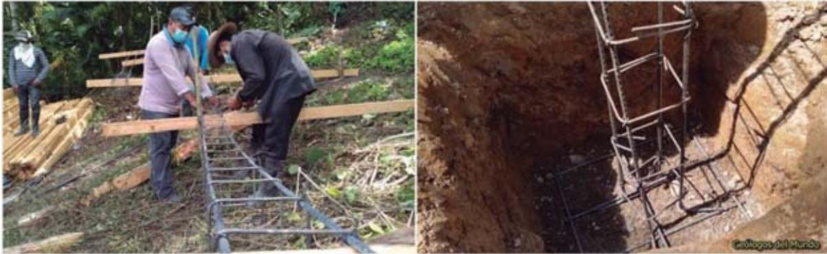
Figura 61.- Construcción de la armadura de los castillos perimetrales, y listos en sus pozos para realizar el vertidos de hormigón para su cimentación.
