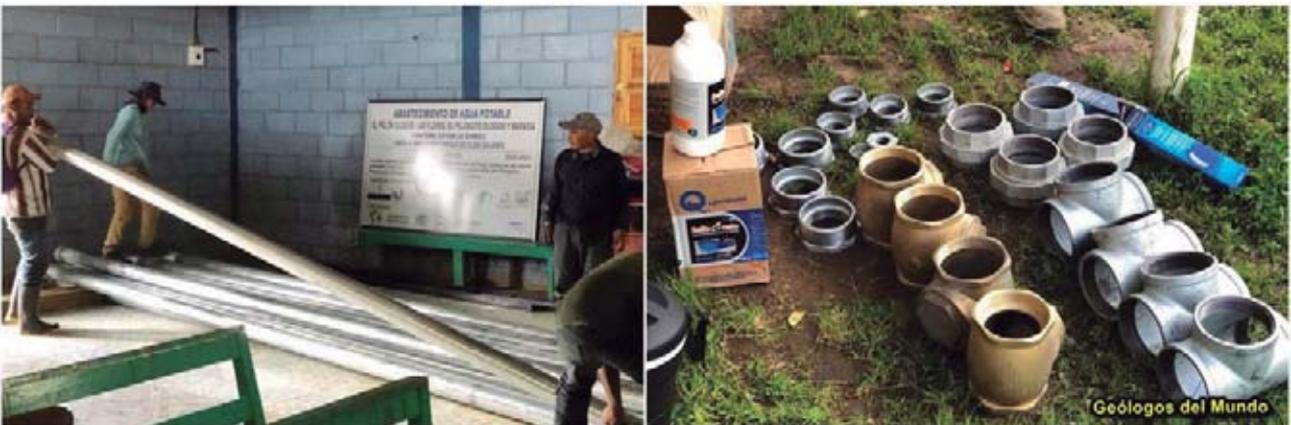
Figura 85.- Recepción de la tubería 4" de hierro galvanizado (HG) y accesorios necesarios para la instalación.
