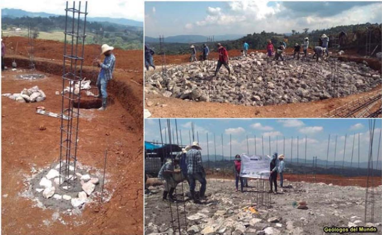
Figura 97.- Cimentación. A la izquierda, los castillos, y a la derecha, la losa de hormigón ciclópeo. Se observan las armaduras de los castillos y de la columna central ya instalada.
