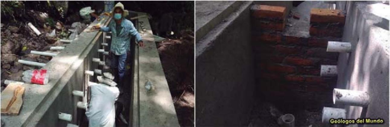
Figura 52.- Celdas de filtro de la caja concentradora.
