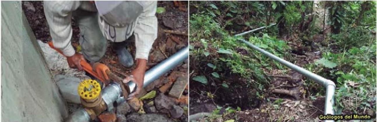
Figura 69.- Instalación de línea de conducción. Válvula de salida de obra toma y traza de tubería.
