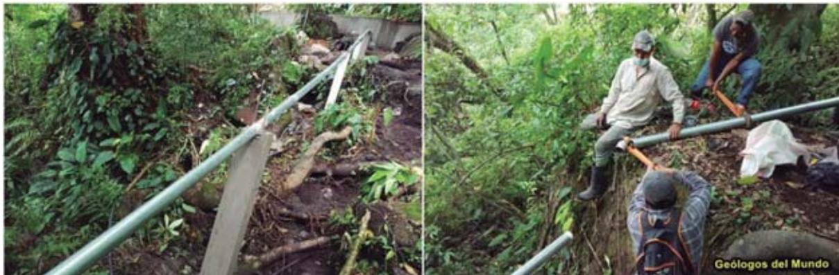
Figura 68.- Instalación de la tubería de conducción desde la obra toma (parte superior de foto izquierda).
