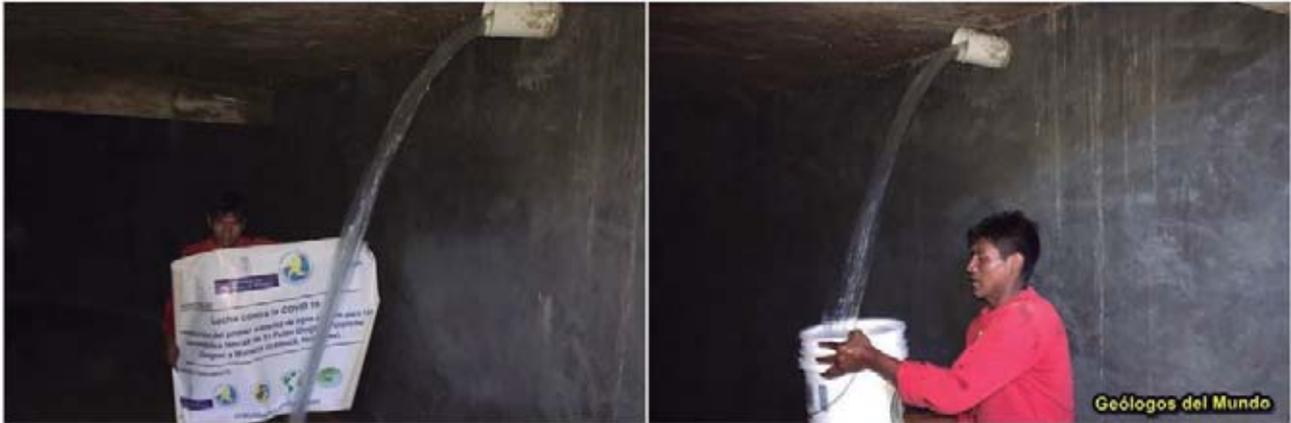
Figura 112.- Entrada del agua bombeada al depósito de almacenamiento. El aforo de entrada es de 86 Gal/min (5,4 l/s), lo que supone un bombeo continuado de 8,2 h para el llenado del depósito. que tiene una capacidad de 160,24 m<sup>3</sup>.
