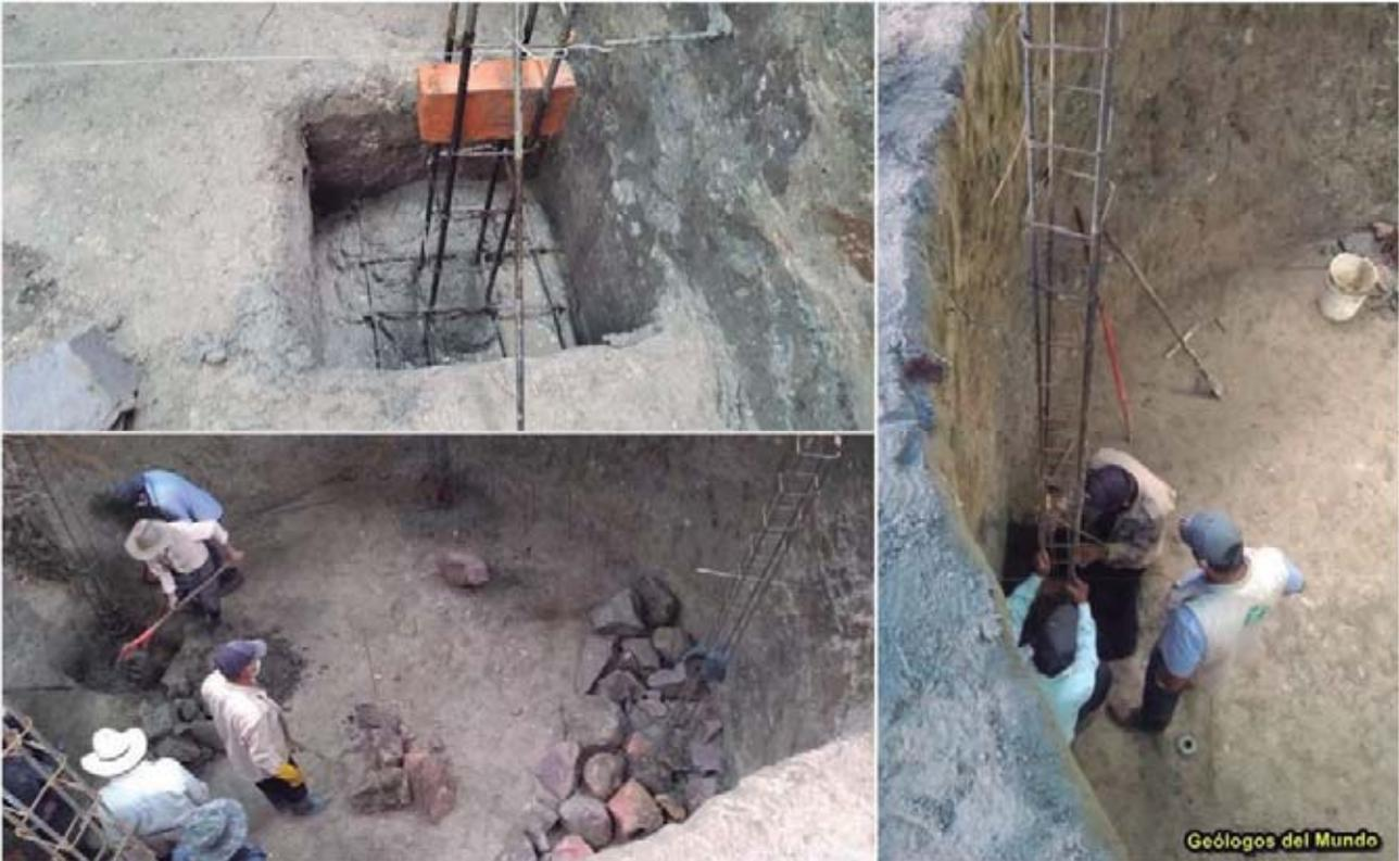
Figura 75.- Etapa de cimentación. Pozos para los castillos y losa de hormigón ciclópeo. La rasante de excavación para la cimentación está compuesta por tobas líticas con grado de meteorización II que proporcionan una tensión admisible más que suficiente para el objetivo previsto. Hay que tener en cuenta que trata de una cimentación por compensación en la que el peso instalado por la estructura y su contenido (agua) supone una ligera sobrecarga respecto a la ejercida por el terreno extraído.
