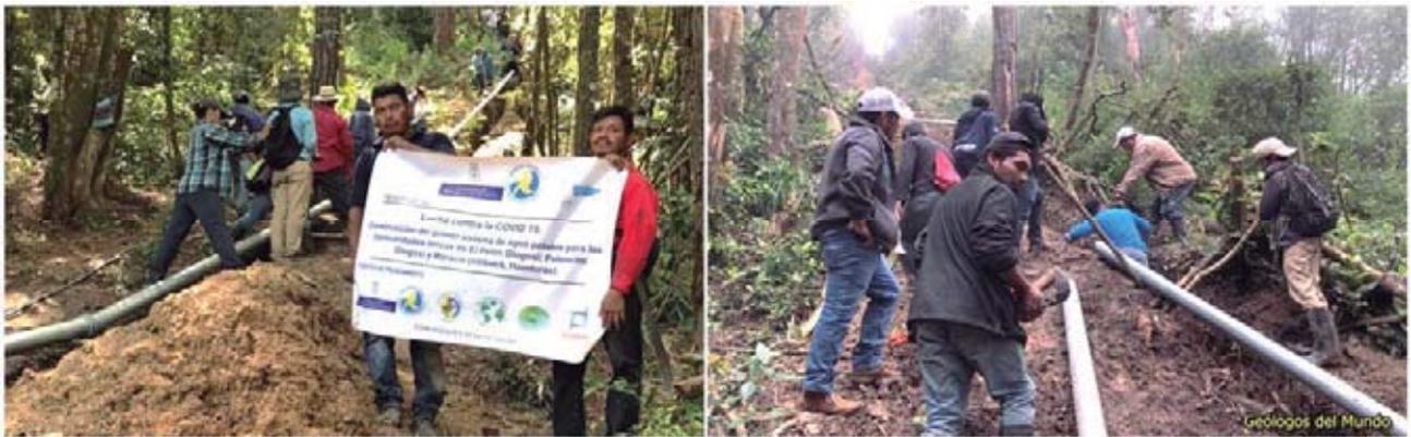
Figura 88.-Proceso de instalación de tubería de HG (hierro galvanizado).
