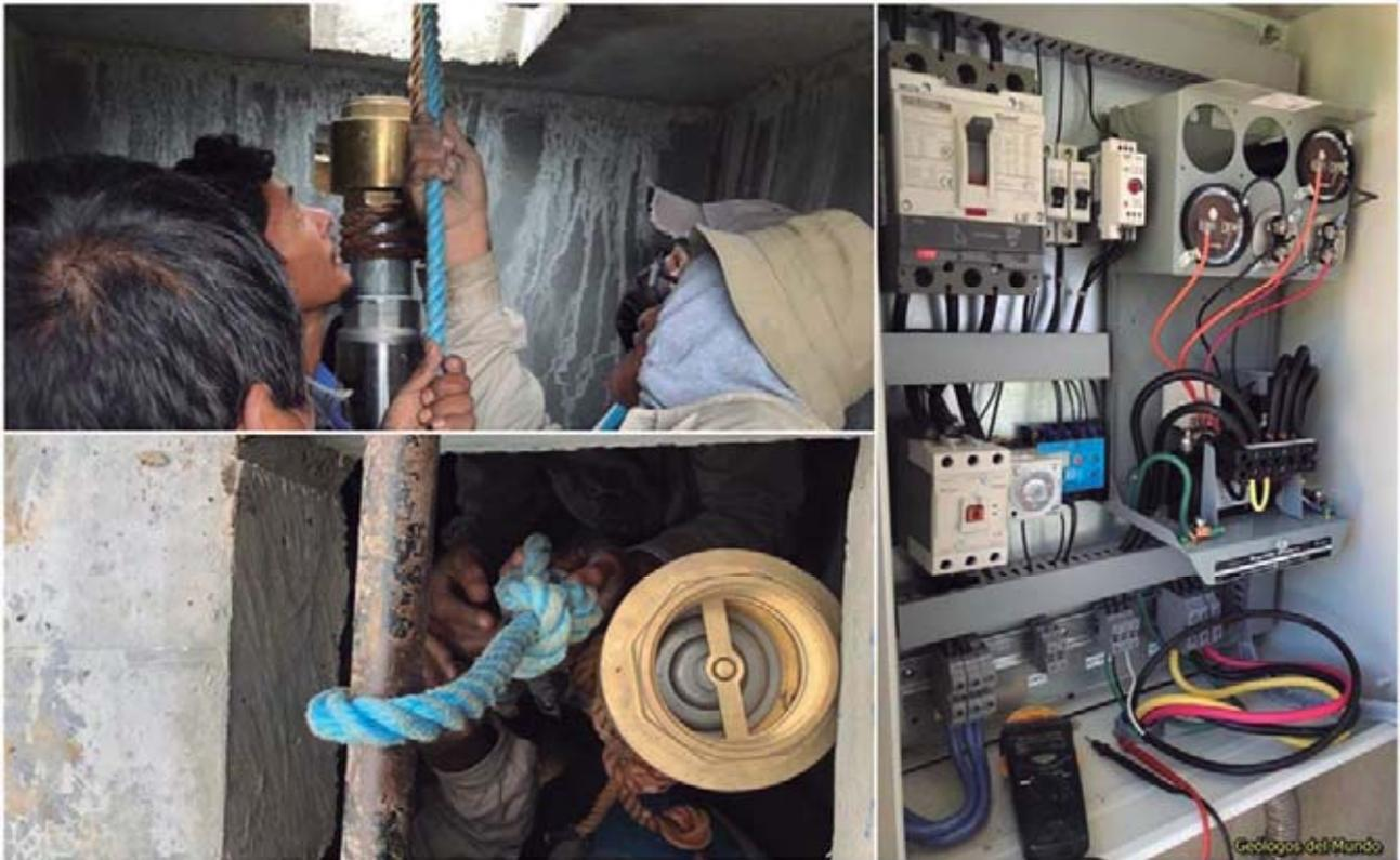
Figura 108.- Proceso de instalación de las bombas. A la derecha, el panel de control eléctrico de las bombas.
