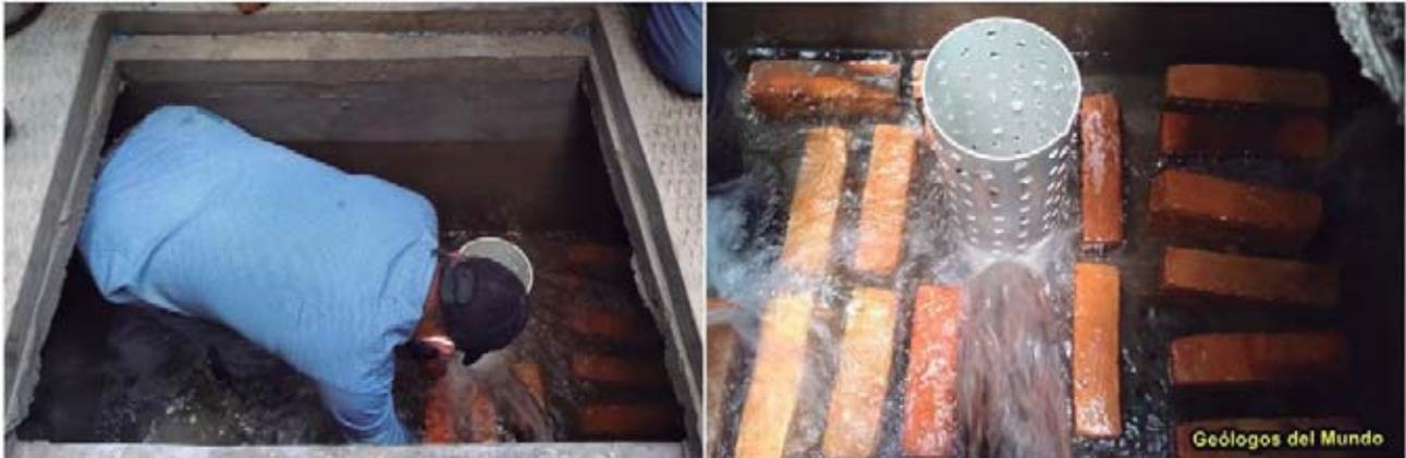
Figura 54.- Etapa de colocación del filtro primario en las celdas de la caja recolectora.
