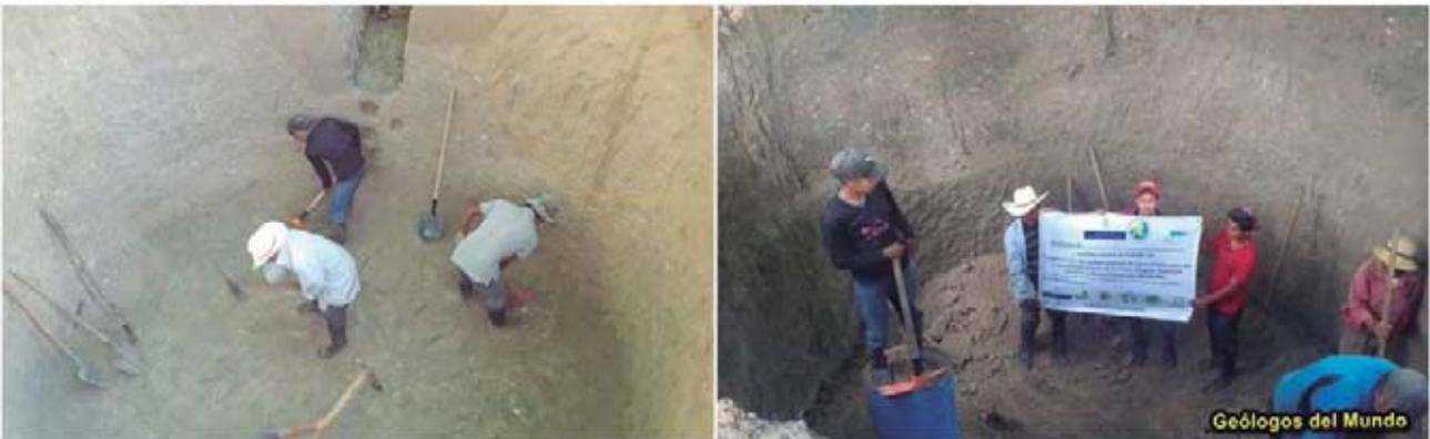
Figura 74.- Etapa de excavación. Excavación circular de profundidad 2,80 m con diámetro de 5,10 m en la que irá alojada la estructura; la excavación es más amplia que las dimensiones de la estructura ya que incluye en profundidad la excavación de cimentación, y también ha de tener una amplitud en diámetro que permita la construcción de las paredes con seguridad y la instalación del trasdosado de las mismas con un dren de piedra. Volúmen total de excavación 57,2 m<sup>3</sup>.
