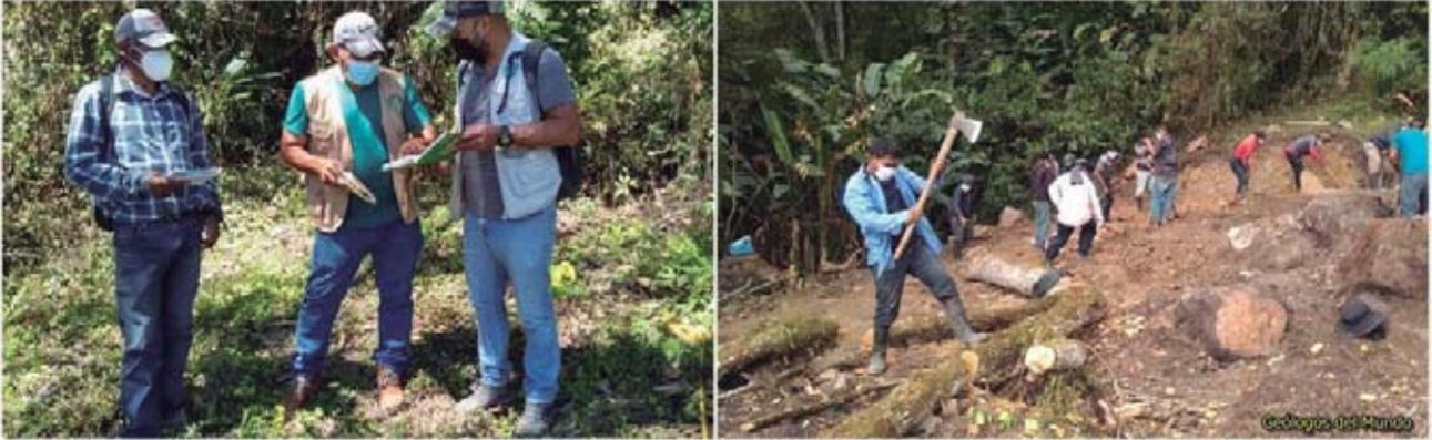
Figura 58.- Etapa de replanteo, desbroce y limpieza del emplazamiento de la estructura.
