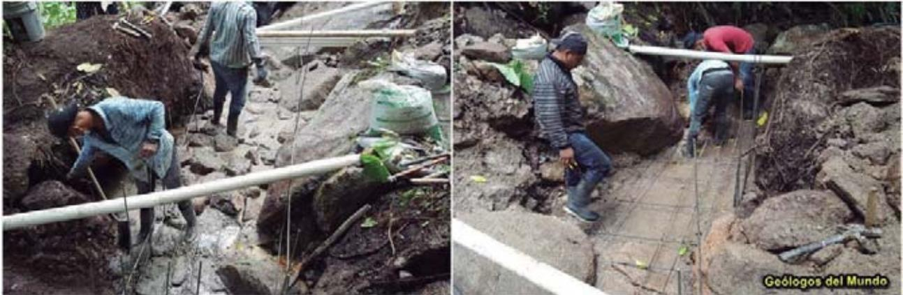
Figura 50.- Construcción de la cimentación con hormigón ciclópeo, sobre la que se dispone una solera de hormigón. Se observan los arranques del armado de los muros frontal y trasero de la estructura.
