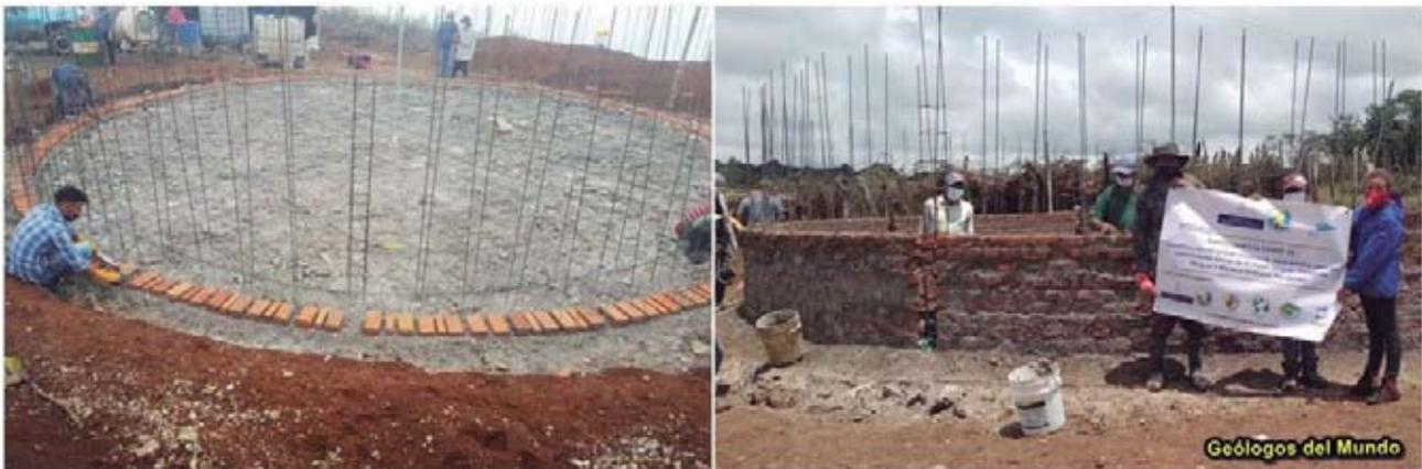
Figura 98.- Ejecución del paramento vertical mediante ladrillo rafón (macizo). A la izquierda, colocación de la primera hilada de ladrillos que quedará unida con la fundición de la solera; a la derecha a 1/3 de su construcción.
